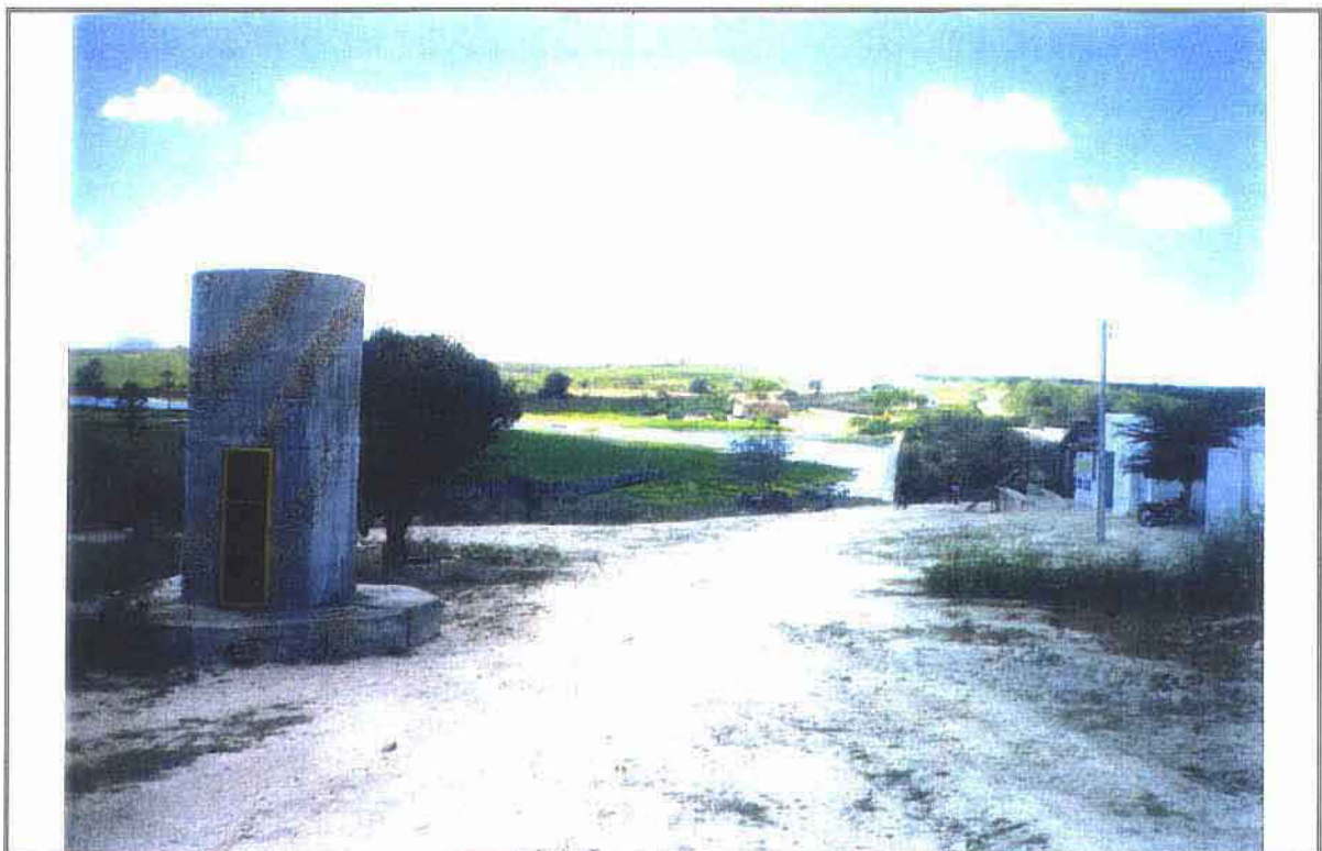
Vista panorâmica da Barragem localizada no Distrito de Belém – Quixeramobim-Ce.
