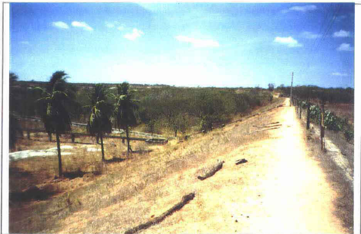
AÇUDE AMAZONAS (BARRAGEM E SIFÃO)
