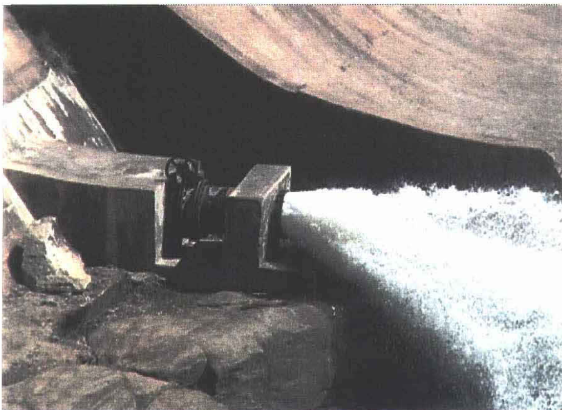
Figura 2 – Vista da Tomada D'água, local apropriado para a instalação da turbo-bomba
