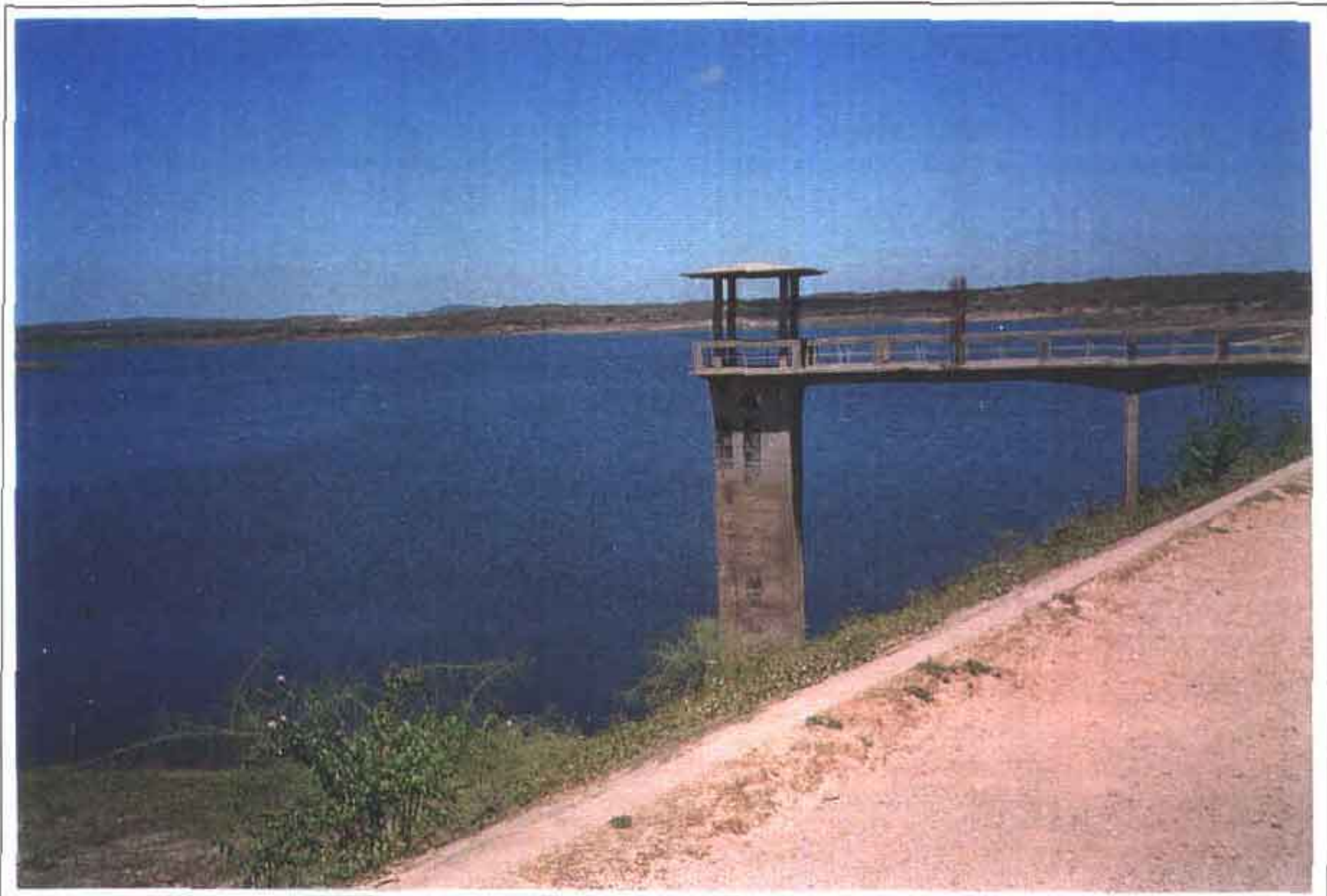
FOTO 04/17 - Vista do açude e tomada d' água.
