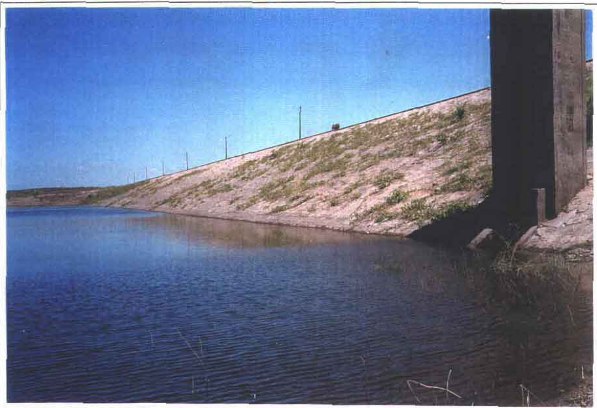
FOTO 05/17 - Mostra o estado atual de esvaziamento do açude.
