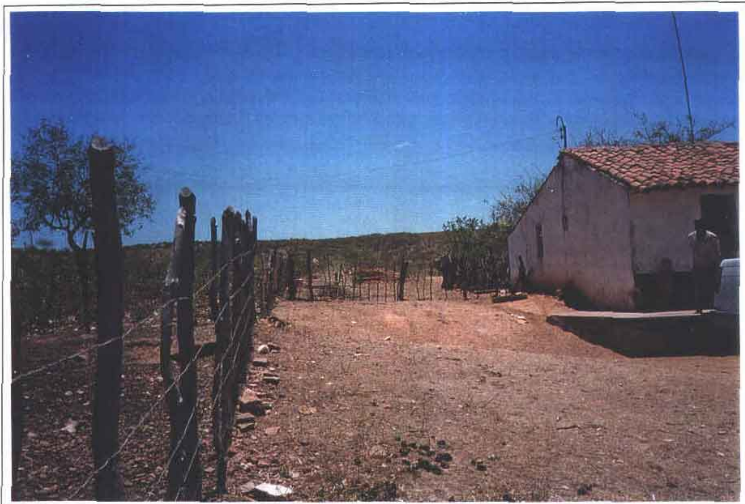
FOTO 15/17 - Continuação da adutora ao longo da cerca em direção ao local do reservatório (alto) lado direito da estrada.
