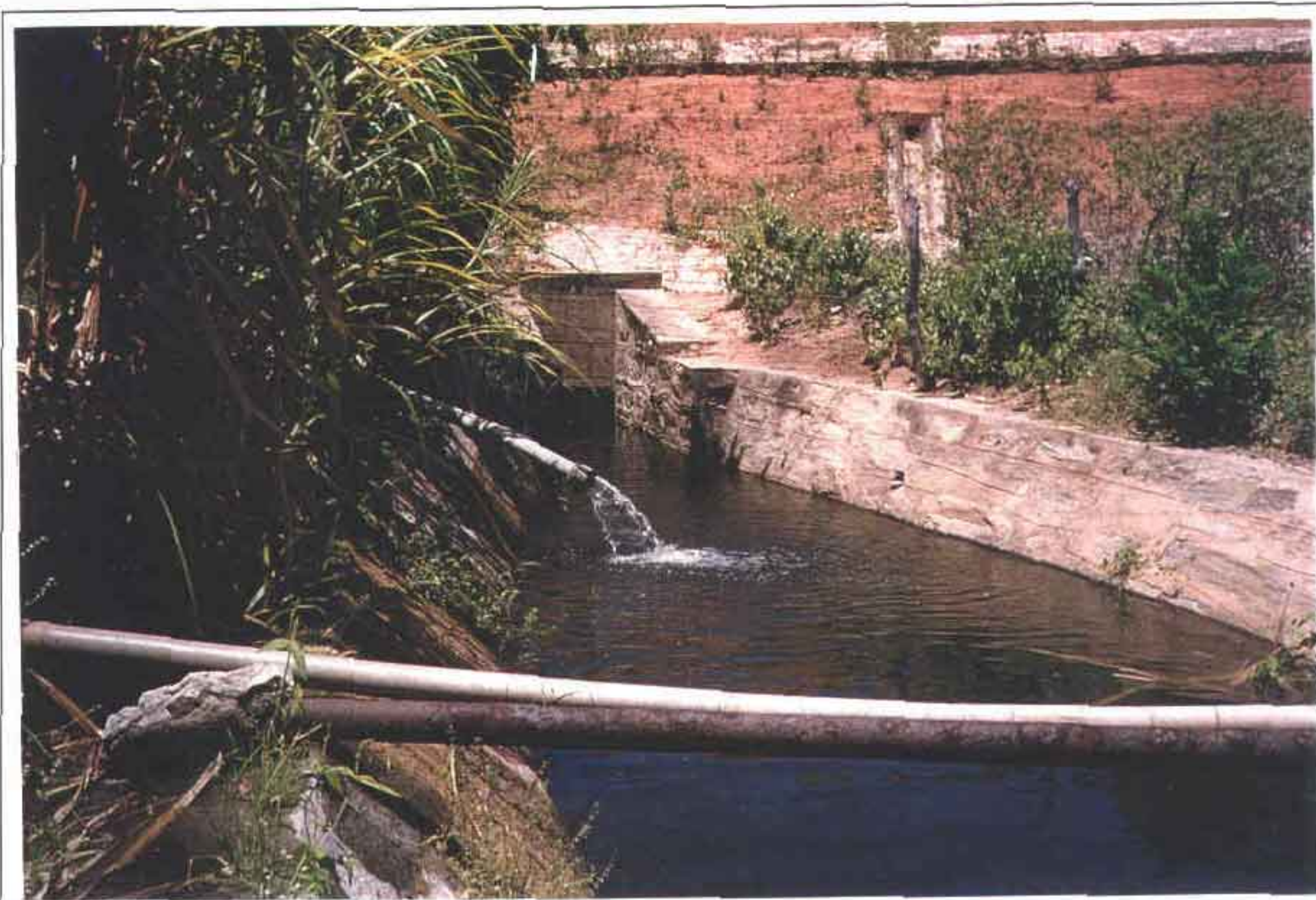
FOTO 11/17 - Canal de adução do reservatório de Feiticeiro, mostrando o retorno d'água ao canal.
