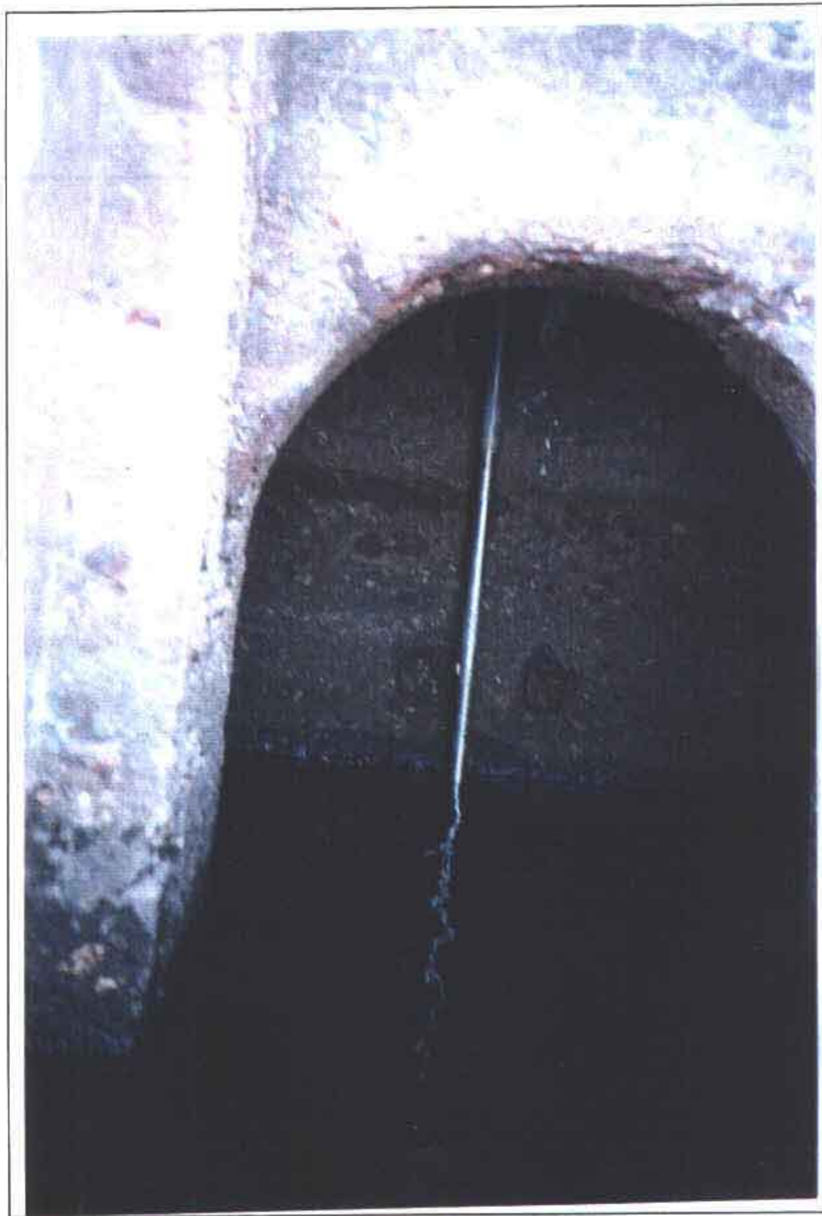
FOTO 07/17 - Mostra o porão do açude e o nível d'água disponível do reservatório.
