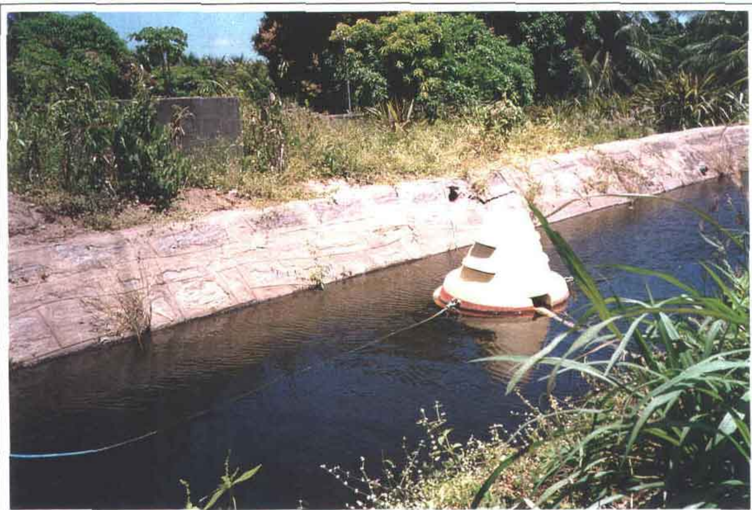
FOTO 12/17 - Vista do Canal de adução do reservatório de Feiticeiro, mostrando a bomba submersa.
