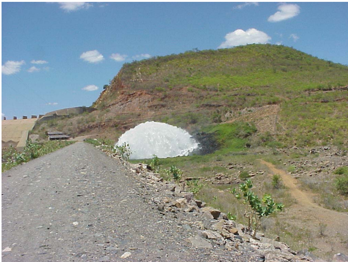
Figura 8 – Vista Invertida da Válvula Dispersora e Caminhamento Inicial da Adutora
