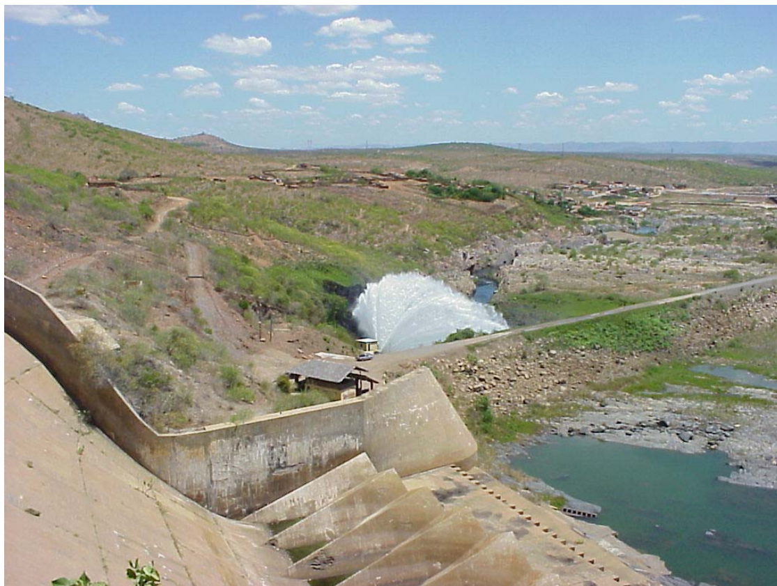
Figura 7 – Vista Geral da Válvula Dispersora e Serra do Condado ao fundo
