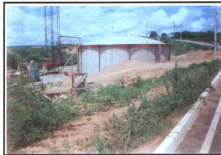
Foto 04 – Vista do reservatório de 600 m 3 .
