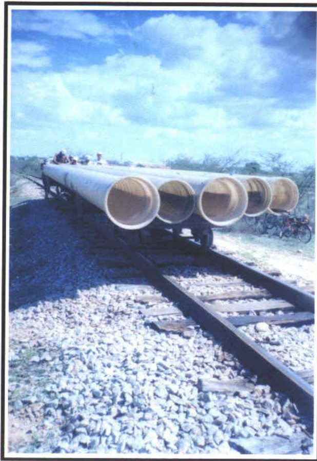
Foto 15 – Vista do transporte dos tubos no trecho que margeava a linha férrea.
