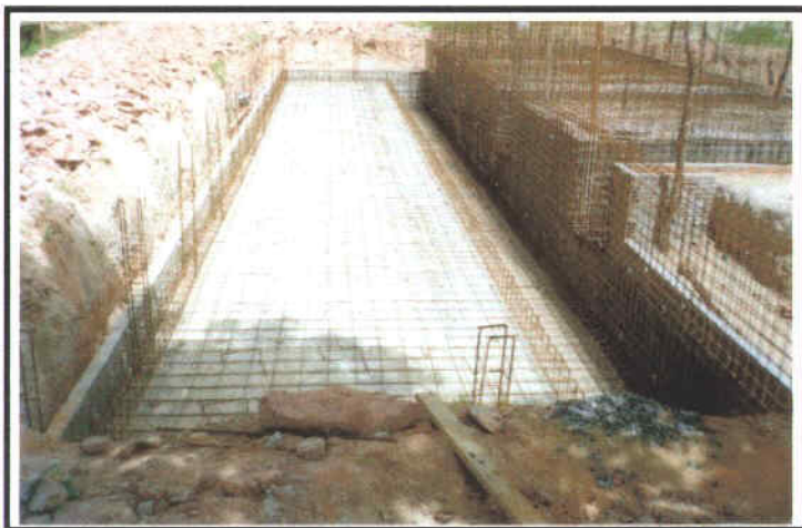
Foto 07 – Vista dos ferros de espera dos filtros na ETA de Iguatu.
