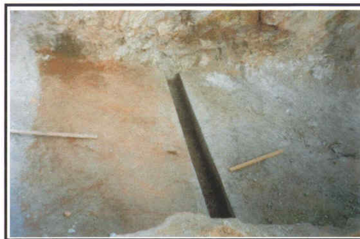
Foto 06 – Vista da drenagem da EE-02.
