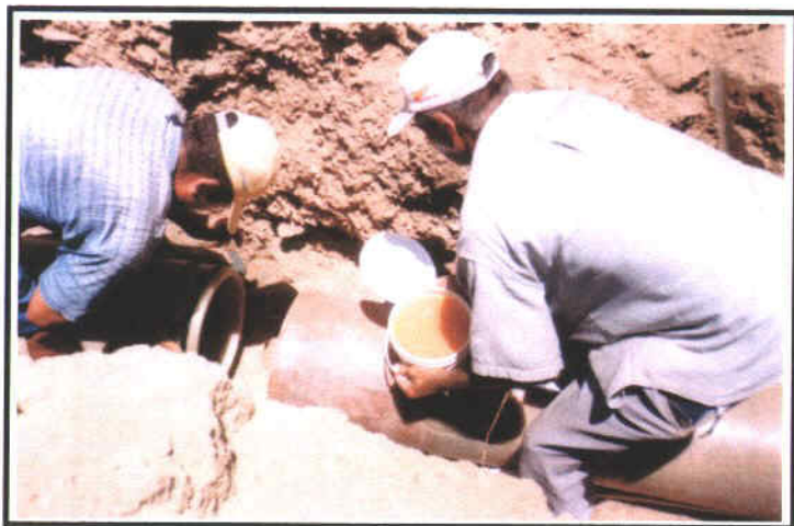
Foto 11 – Detalhe da aplicação da pasta lubrificante e colocação do anel de vedação.
