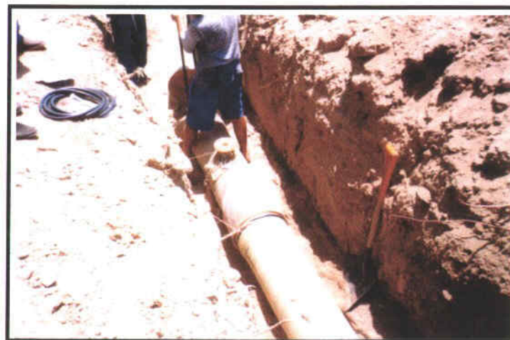
Foto 12 – Detalhe do assentamento da tubulação de PRFV.
