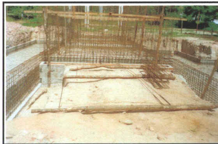
Foto 08 – Vista dos ferros de espera dos filtros na ETA de Iguatu.
