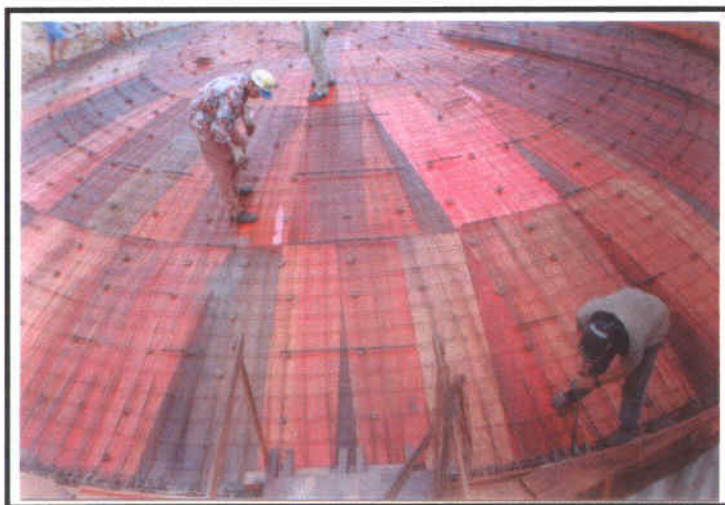
Foto 03 – Vista da armação da cúpula do reservatório de 600 m 3 .
