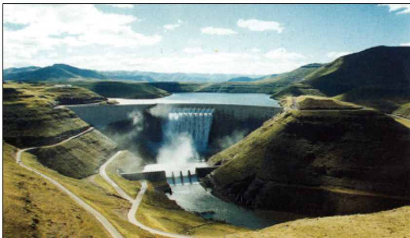
Figura 2.5. Fotos da barragem de Katse e da torre de captação
