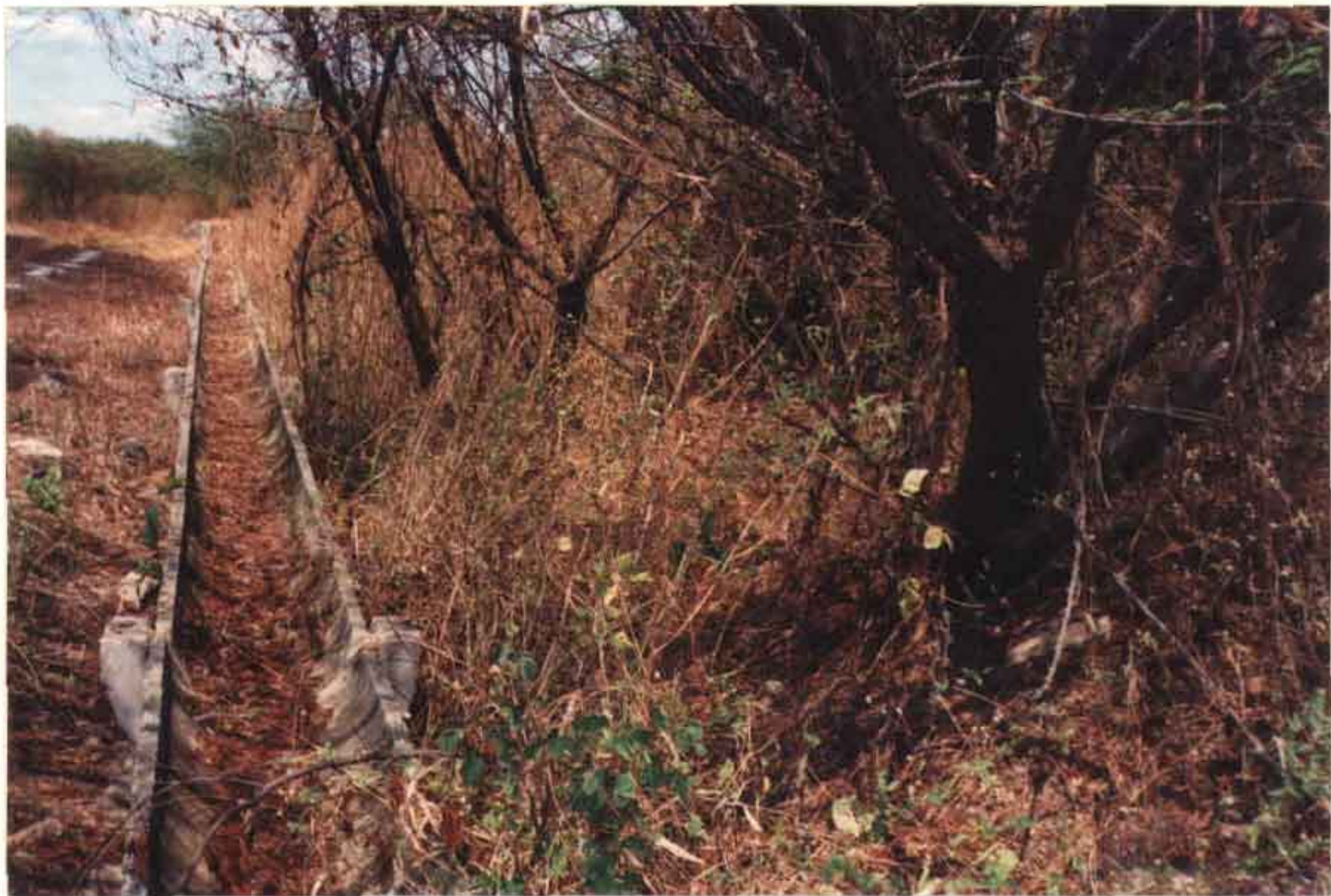
FOTO 31: Aspecto do bom estado das acéguas que saem da tomada T_{41} do canal P_3 .
