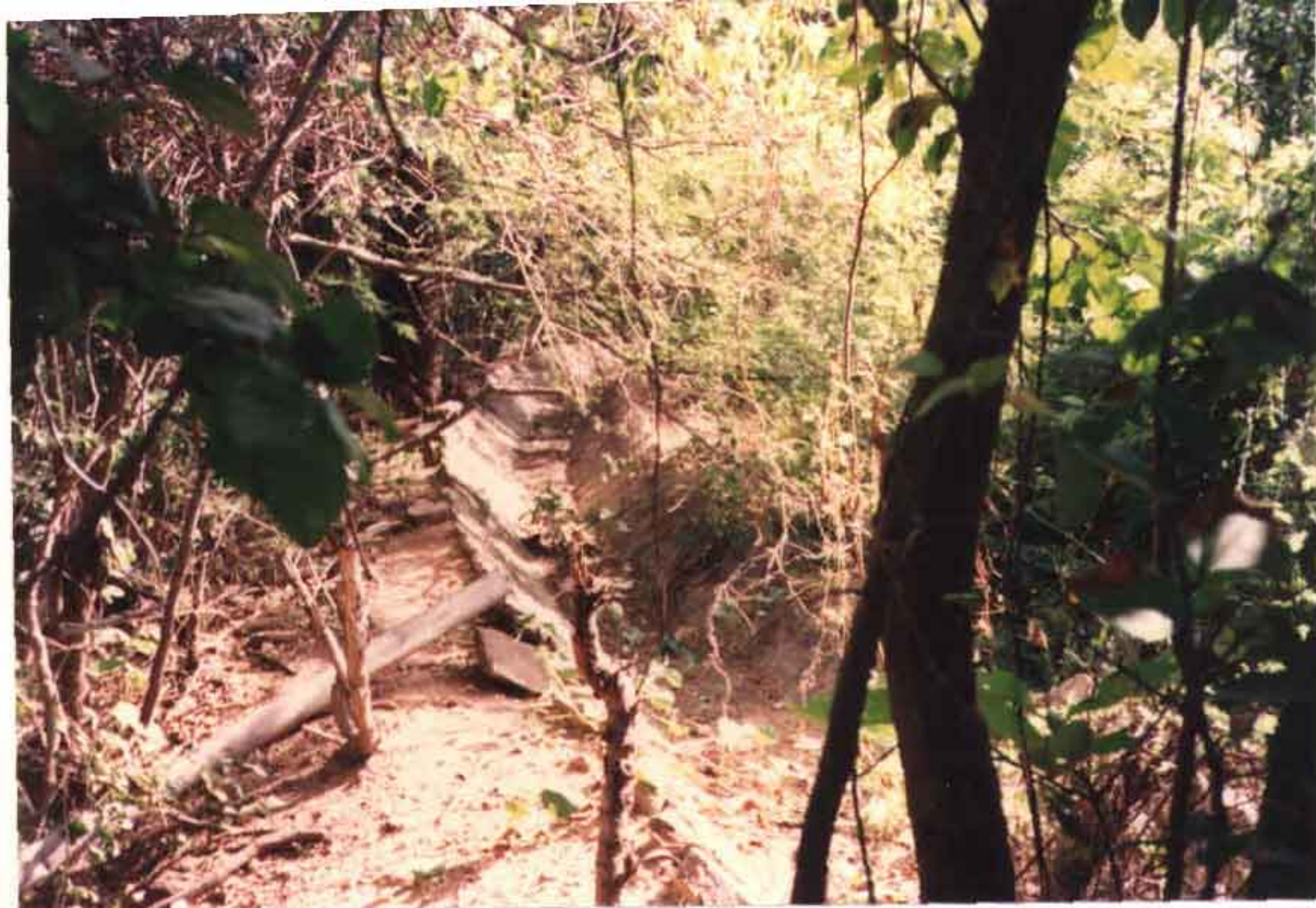
FOTO 16: Trechos finais do canal P_1 , próximo a Sobral. Observa-se que há alternância no estado do canal, com trechos revestidos seguidos de outros sem nenhum revestimento.
