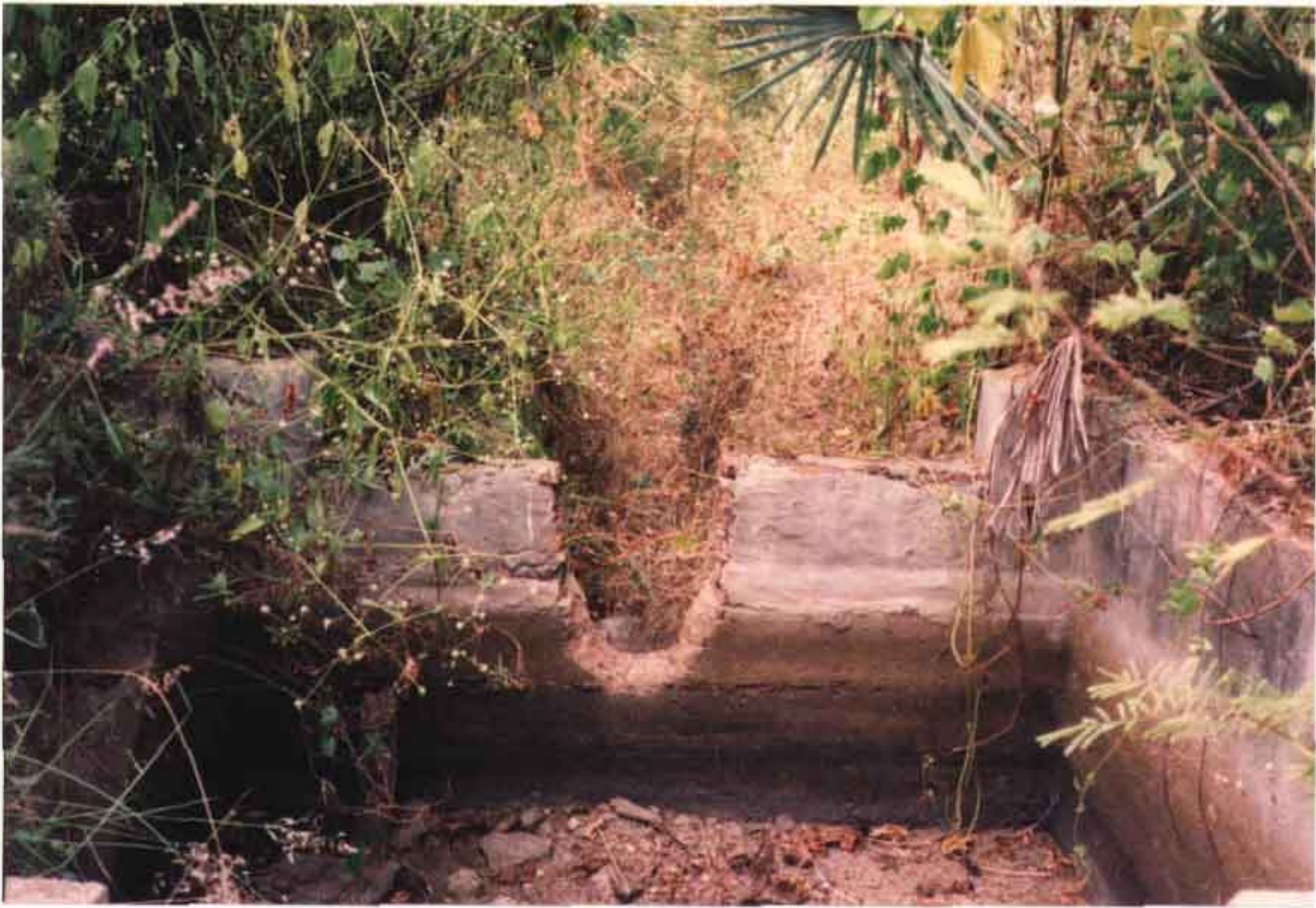
FOTO 26: Caixa de derivação do canal P_3 para o canal A_1P_3 . Vista de montante do canal P_3 . Observar que nele não existe revestimento a partir deste ponto.
