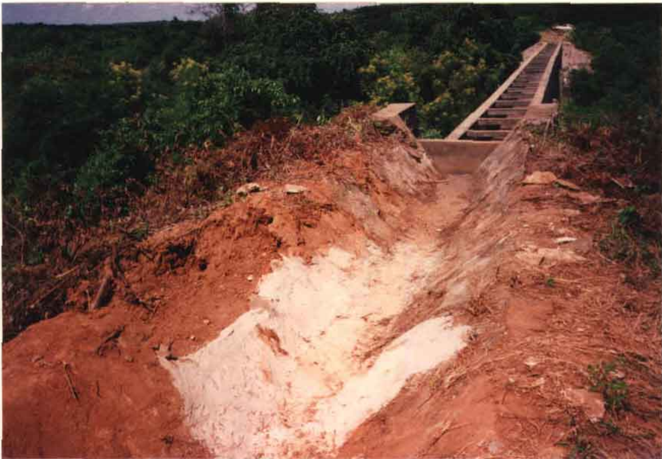
FOTO 25: Erosão em pequeno trecho do canal principal P_3 , antes da ponte canal sob o Rio Jaibaras.
