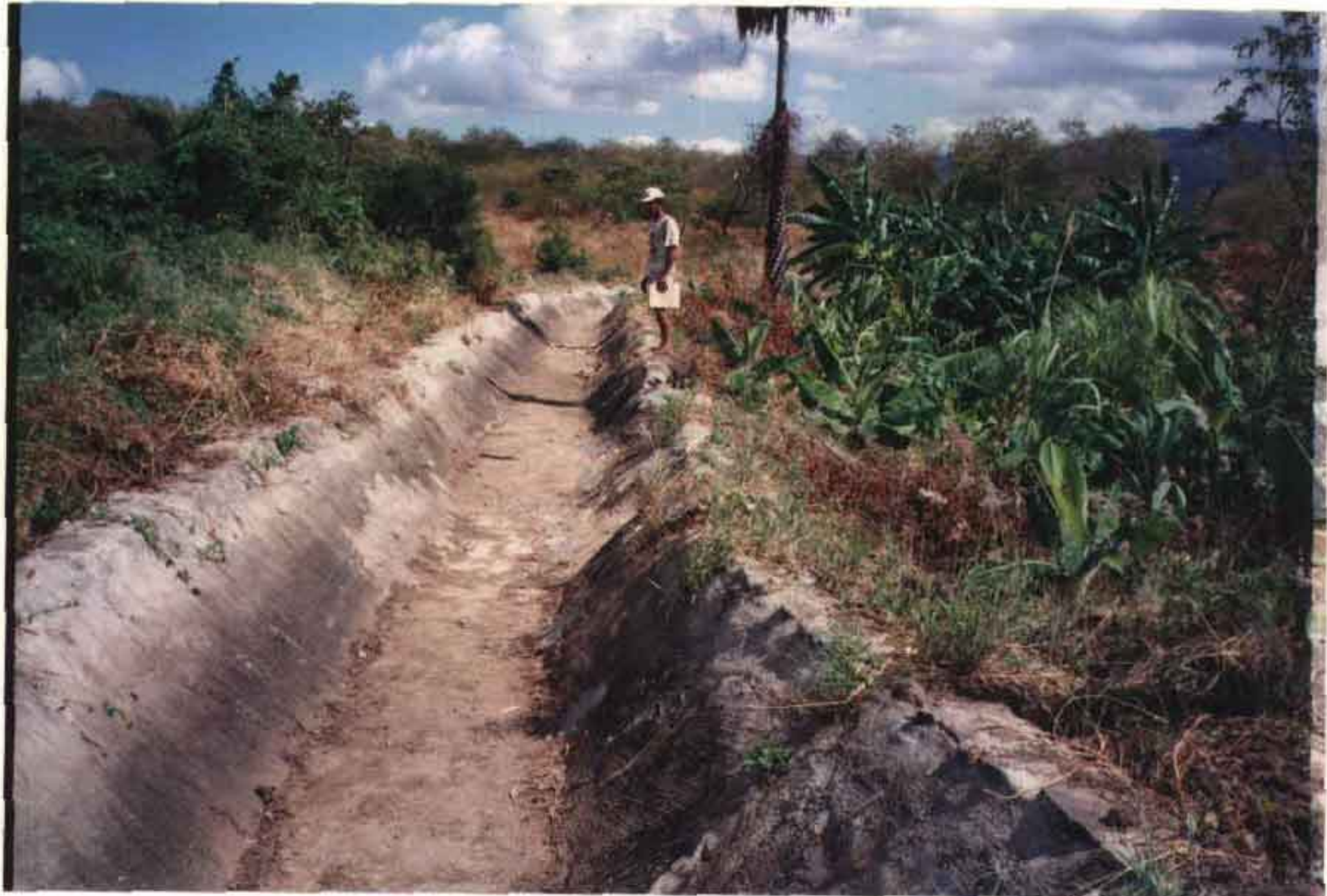
FOTO 33: Trecho logo após o início do canal A_1P_3 . Observa-se na foto o bom estado do revestimento, um estrangulamento da secção do canal e à direita, no centro, trecho onde o canal transbordou destruindo parte dele. Atentar para o péssimo acabamento no local recuperado.
