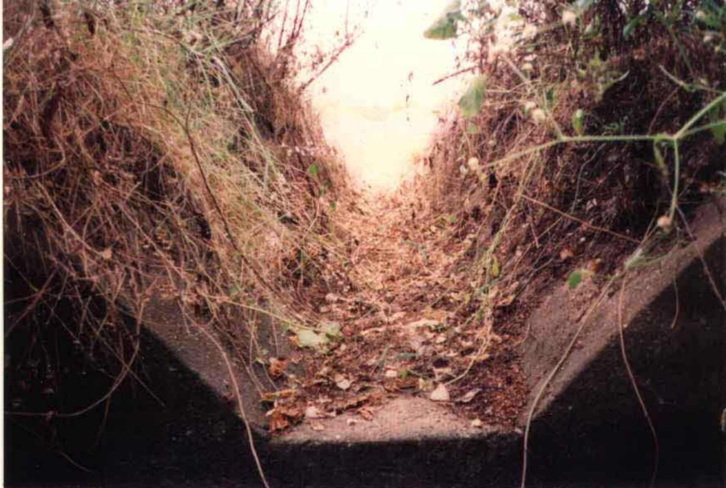
FOTO 28: Caixa de derivação do canal P_3 para o canal A_1P_3 . Vista de jusante (do interior da caixa de derivação) do canal P_3 . Observar o bom nível do revestimento.
