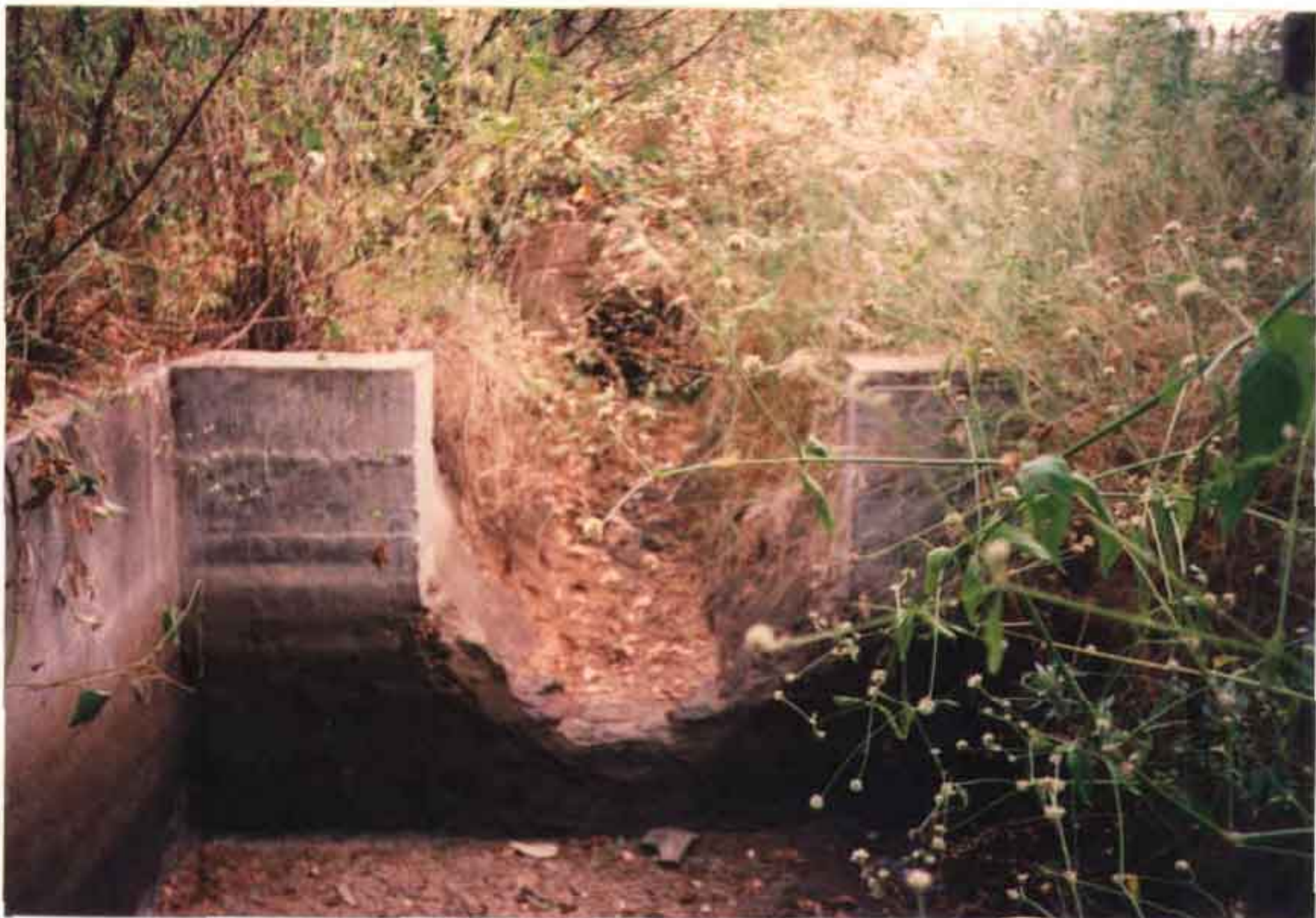
FOTO 27: Caixa de derivação do canal P_3 para o canal A_1P_3 . Vista de montante do canal A_1P_3 .
