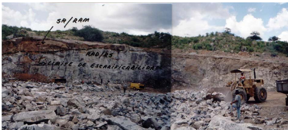
Foto 7.1 – Aspecto da frente de lavra da pedreira em Sertânia
