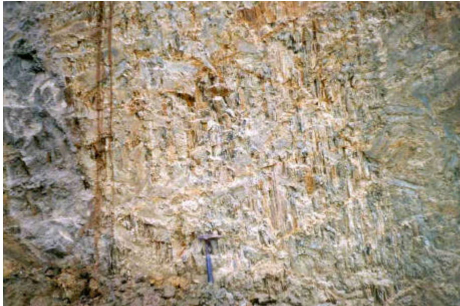
Foto 6 – Observar pequena rugosidade da parede.
