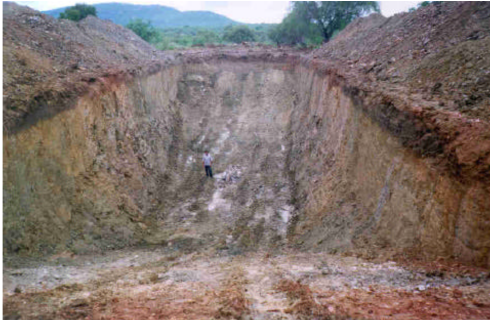
Foto 4 – Notar inclinação dos taludes e profundidade da escavação.
