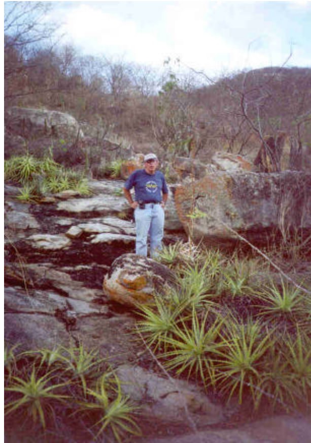
FOTO 22: Barragem Negreiros - Vista da ombreira esquerda da barragem.
