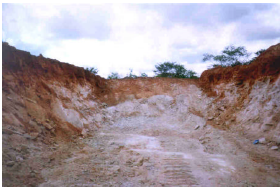
Foto 8 – Aspecto Final da Trincheira, vista da rampa de acesso.
