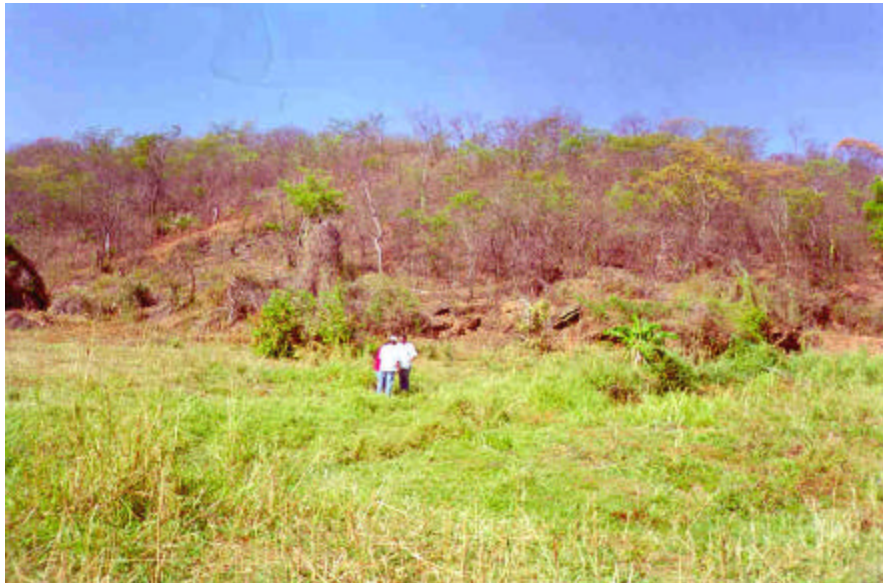
FOTO 26: Barragem Milagres - Vista parcial da ombreira esquerda.
