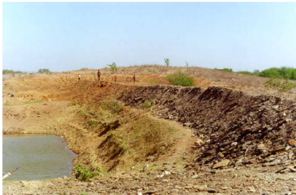
PTR5-01 - Foto 2: Elevação de barragem com material retirado da trincheira 5.
