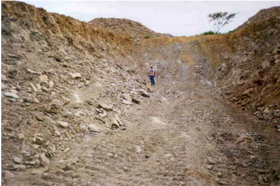
Foto 9 – Observar material lamelar resultante da escarificação.
