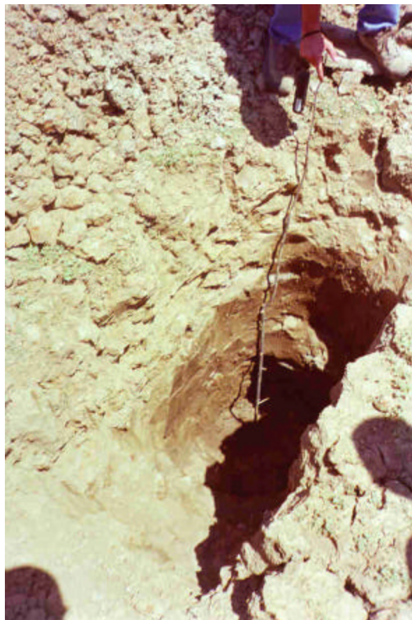
FOTO 32: Barragem Jatí – Detalhe de poço com aproximadamente 2,20 m de profundidade, em aluvião, sem presença de água.
