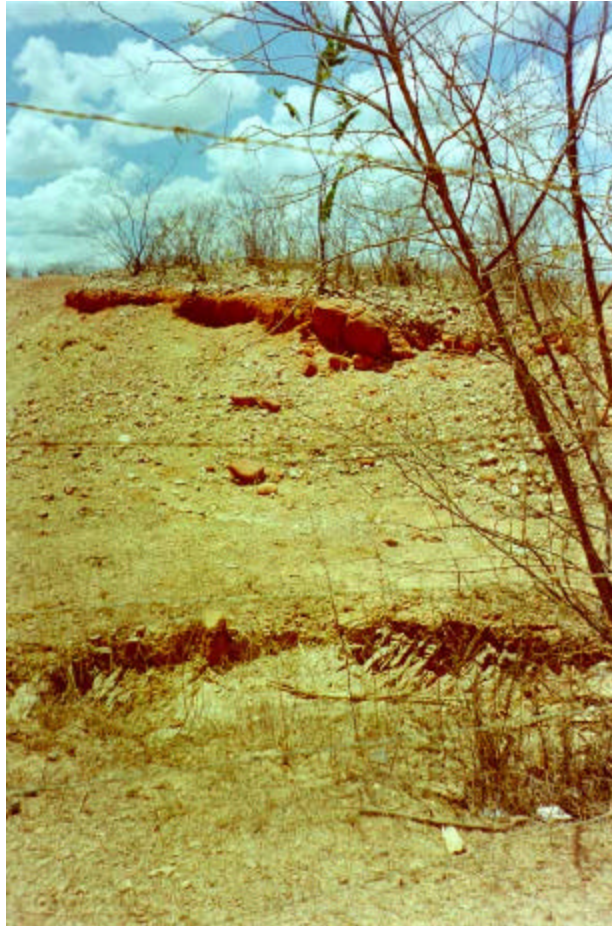
FOTO 33: Túnel Milagres-Jatí – Afloramento de arenito sobreposto a filito fino de coloração cinza esverdeada. Observam-se minerais cúbicos de 1mm, aparentemente metamórficos, dispersos na rocha. Região próxima ao emboque de jusante do túnel.
