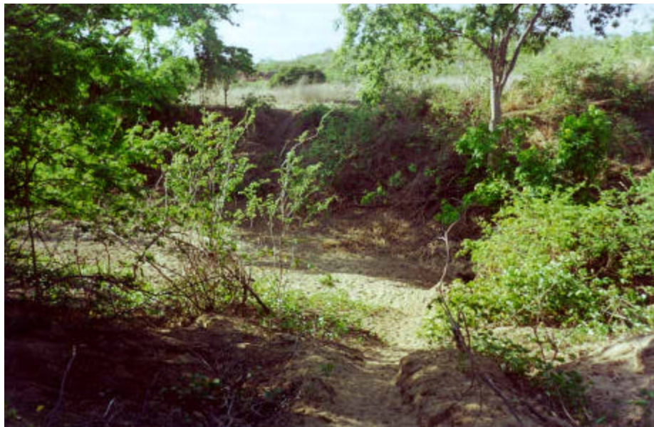
FOTO 38: Aqueduto Terra Nova - Não existem afloramentos rochosos. Foto do local de implantação do aqueduto.
