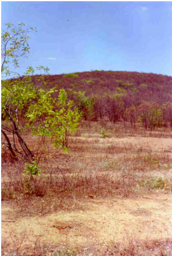
FOTO 28: Barragem Jatí - Vista da ombreira esquerda da barragem.
