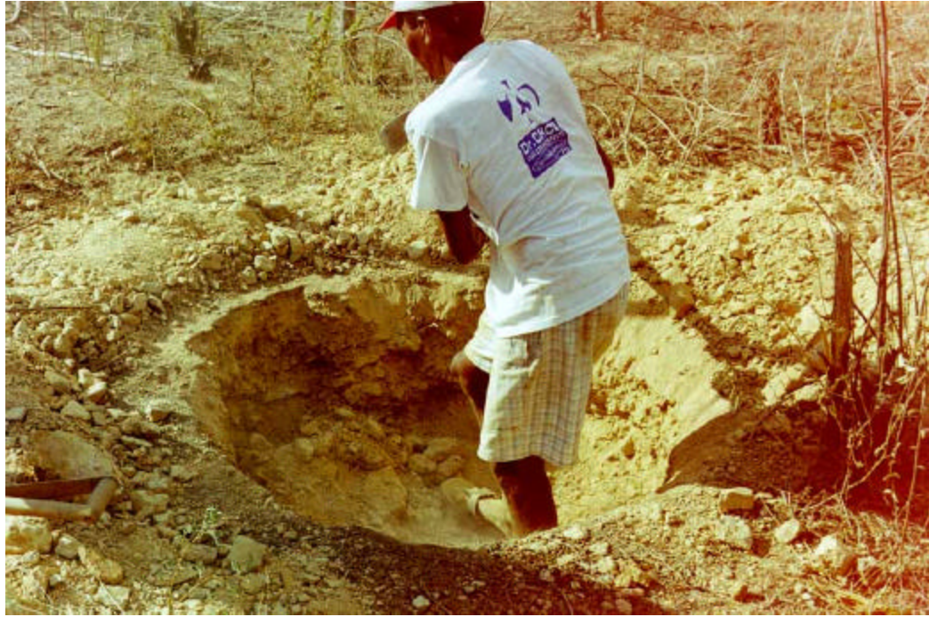
PJ-02 - Foto 1: Vista geral do poço.
