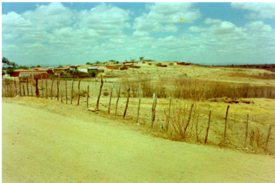
FOTO 35: Túnel Milagres-Jatí – Região próxima ao emboque de jusante do túnel, em Pena-Forte.
