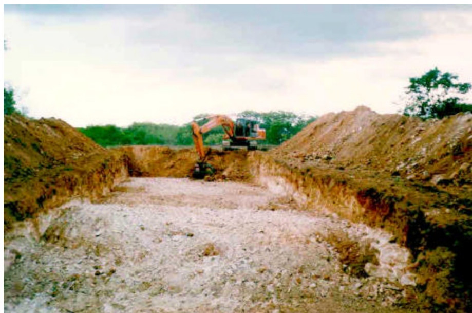
Foto 7 – Detalhe da penetração rasa da escavadeira (1,0 a 1,5 m) .
