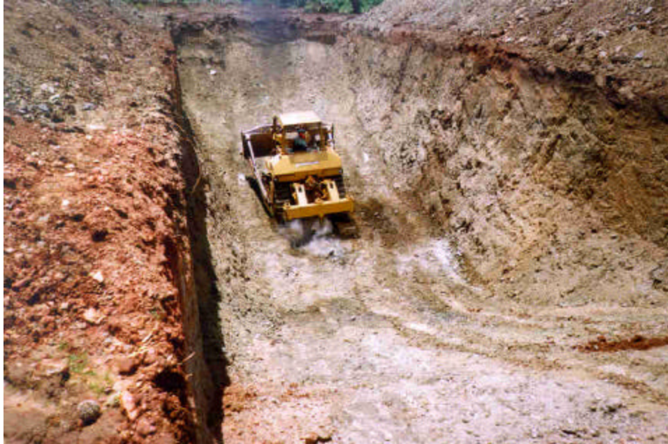
Foto 5 – Vista geral da escavação.
