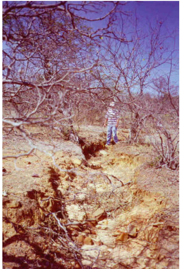
FOTO 14: Barragem Serra do Livramento - Drenagem na área do reservatório.
