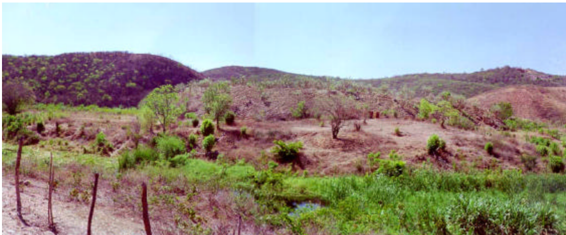
Bota Fora de Atalhos - Foto 1: Vista geral do local.
