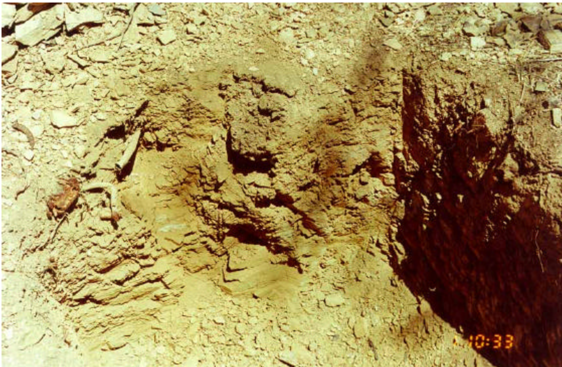
PMI-02 - Foto 1: Visão geral do poço.
