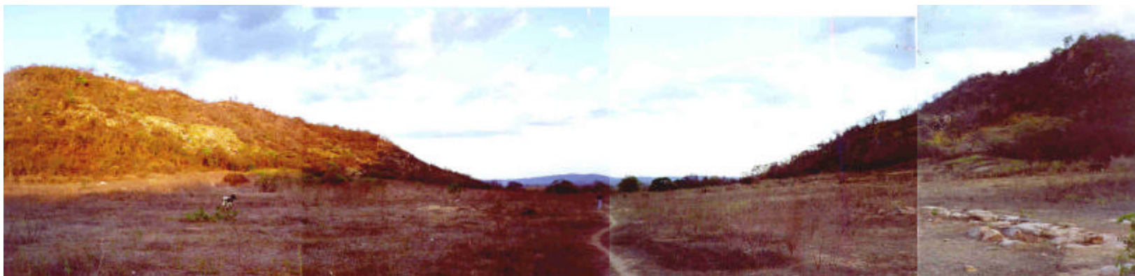
FOTO 24: Barragem Negreiros - Vista para jusante do dique da margem esquerda da barragem.
