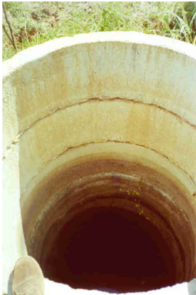
FOTO 27: Barragem Milagres - Poço Amazonas à montante da barragem.
