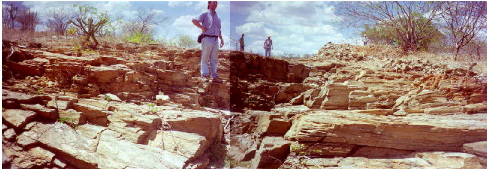
FOTO 18: Barragem Mangueira - Vista mais a jusante do canal do sangradouro do açude Mulungu no reservatório, escavado em filitos subhorizontais (material de 2ª categoria).
