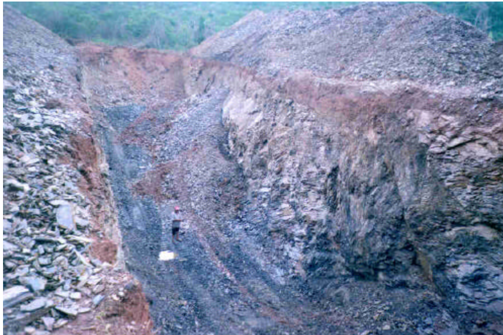
Foto 1 – Vista geral do escorregamento da parede D.
