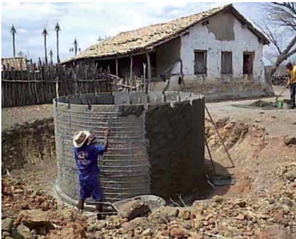
**Foto 16 – Aspectos do Reboco Externo da Cisterna de Placas**
