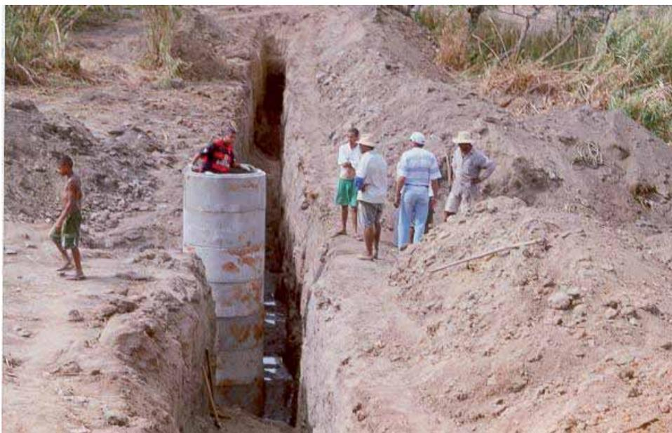
**Foto 6 - Aspecto de uma Barragem Subterrânea em Fase de Construção**
