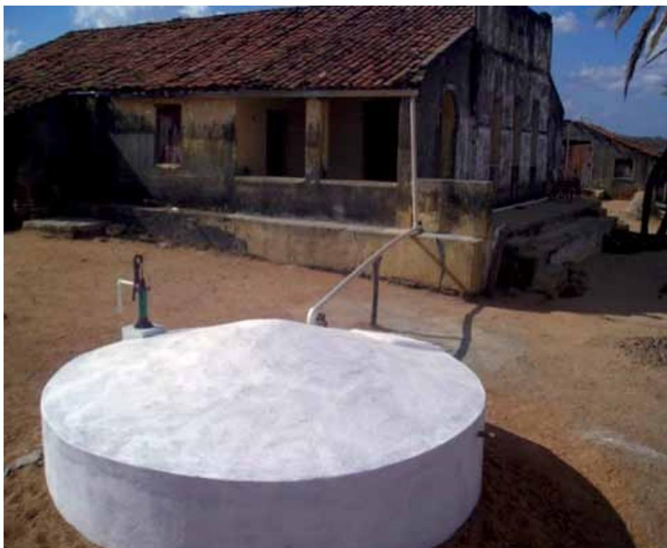
**Foto 17 - Cisterna de Placas Construída pelo PRODHAM**
