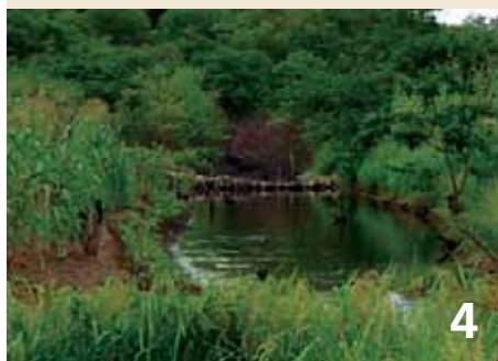
Figura 4. Efeito da sequência de barramentos após as primeiras chuvas, observando a acumulação de água em todo leito do riacho. Foto: Equipe técnica do PRODHAM
