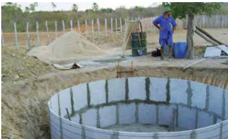
Foto 8 – Vista do Piso e Montagem das Placas
