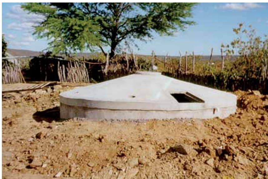
Foto 12 – Vista da Cisterna na Fase Final da Construção
