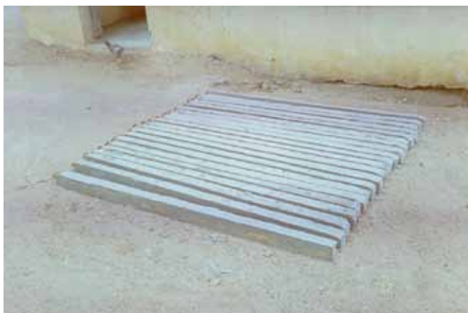
Foto 5 – Trilhos de cimento da tampa da cisterna Fonte: Equipe técnica do PRODHAM.
