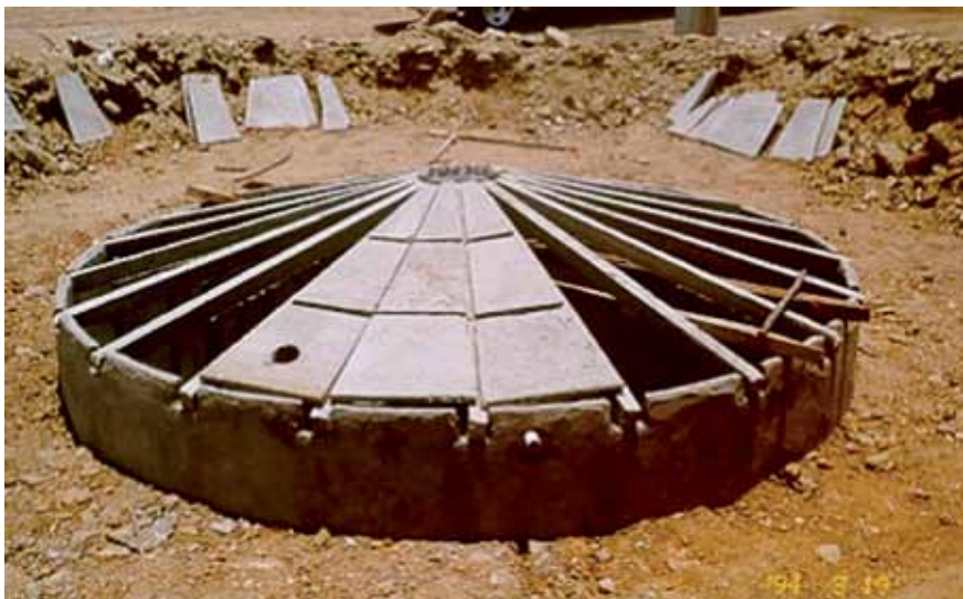
Foto 11 – Montagem da Tampa
