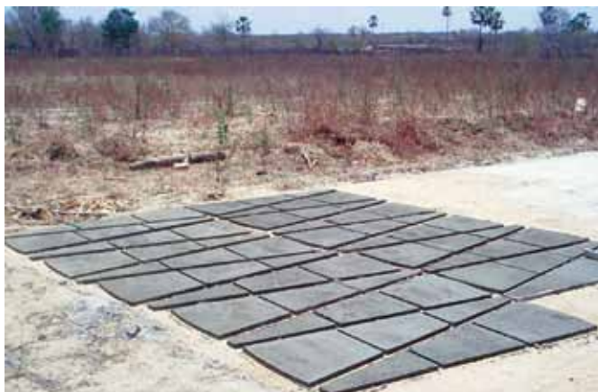
Foto 6 – Placas da tampa da cisterna Fonte: Equipe técnica do PRODHAM.
