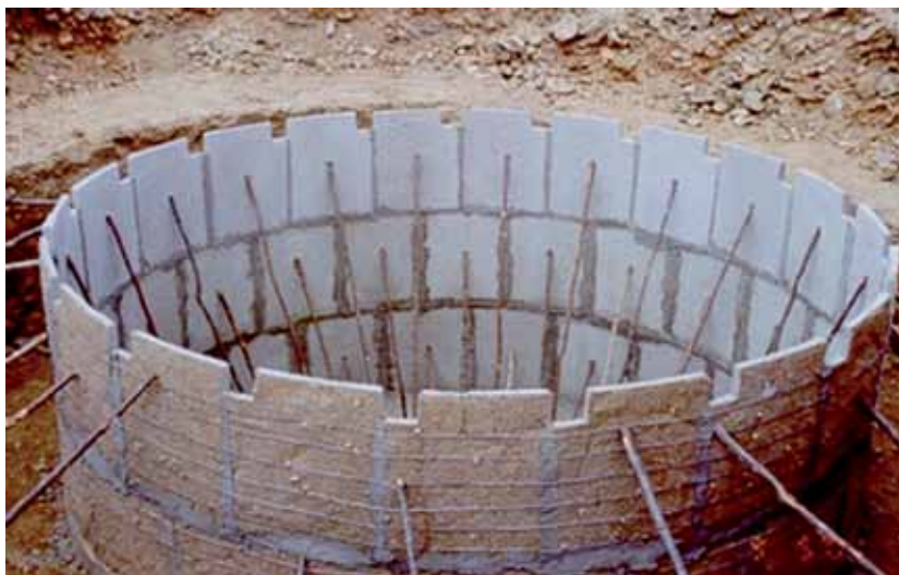
Foto 9 – Montagem das Placas
