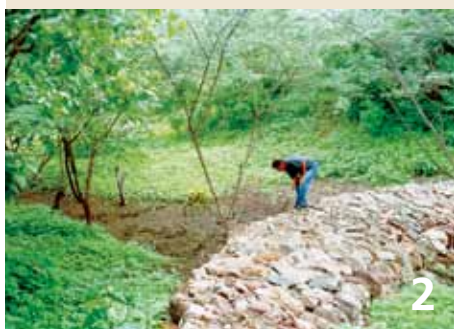
Figura 2. Detalhamento da construção dos barramentos observando a forma de arrumação das pedras em "cunha" objetivando dar maior sustentação à estrutura construída; Foto: Equipe técnica do PRODHAM
