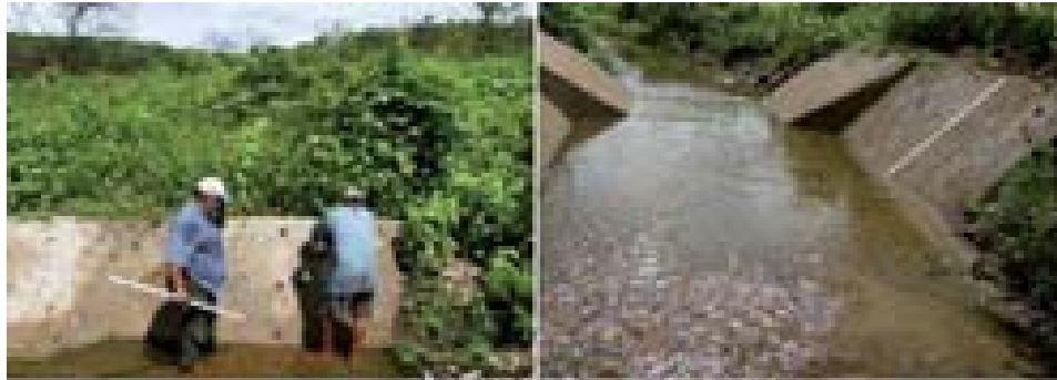
FOTO 2.08 – Instalação de régua limnimétrica na calha 02
