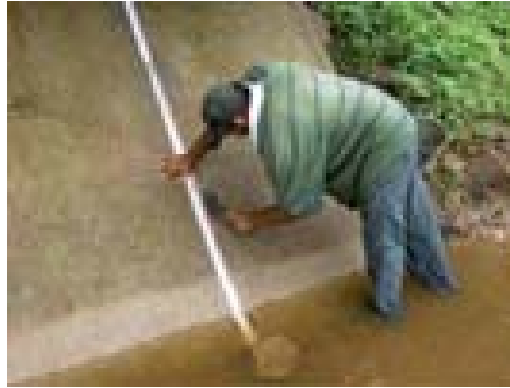
FOTO 2.07 – Instalação de régua limnimétrica na calha 01
