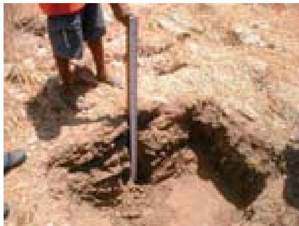
FOTO 3.09 – Instalação da régua.
