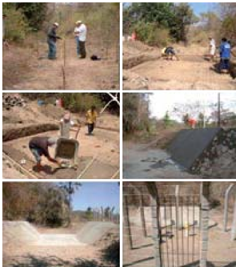
FOTO 2.03 – Fases construtivas da calha 01: marcação, ferragem, concretagem, acabamento e finalização.
