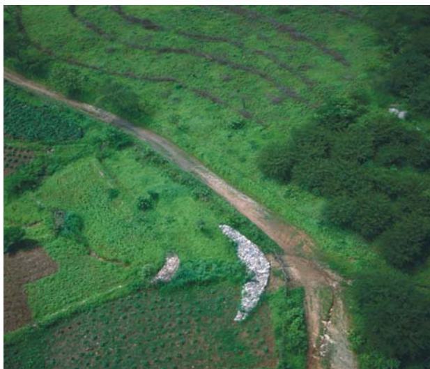
Foto 2 – Visão Aérea de Barragens Sucessivas de Contenção de Sedimentos- Canindé – CE
