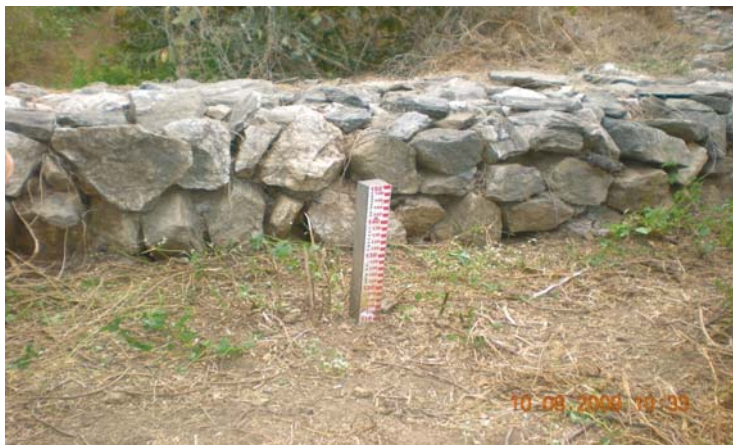
Foto 4 – Barragem com Sedimentos Acumulados em mais de 1,10 m em 8 Anos – Rio Cangati em Canindé
