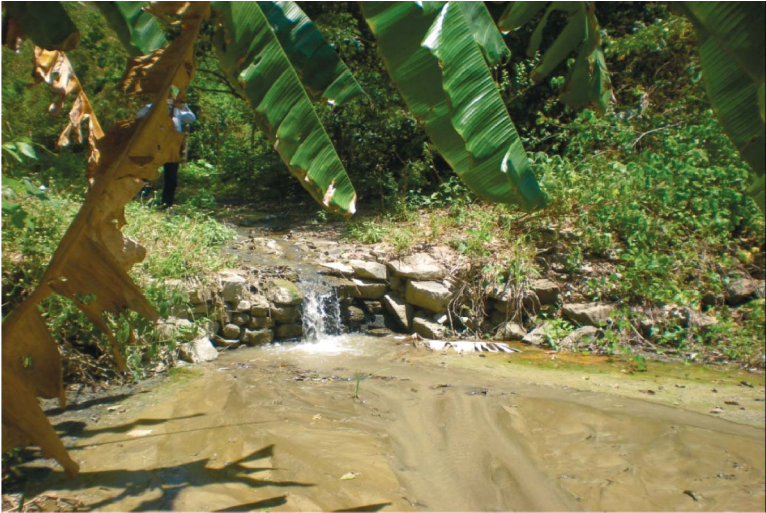
Foto 3 – Barragem com Sedimentos Acumulados Vertendo Água por Cima – Bacia do Rio Pesqueiro – Aratuba-CE
