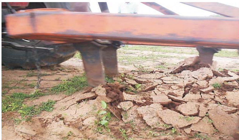
Foto 1 – Escarificação/Descompactação de Área
