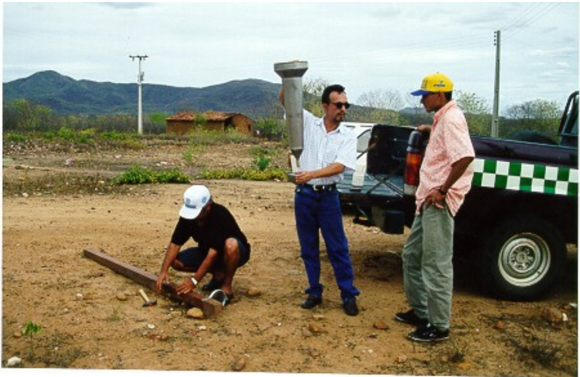
Figura 2: Equipe descarregando e preparando o material para montagem do pluviômetro.
