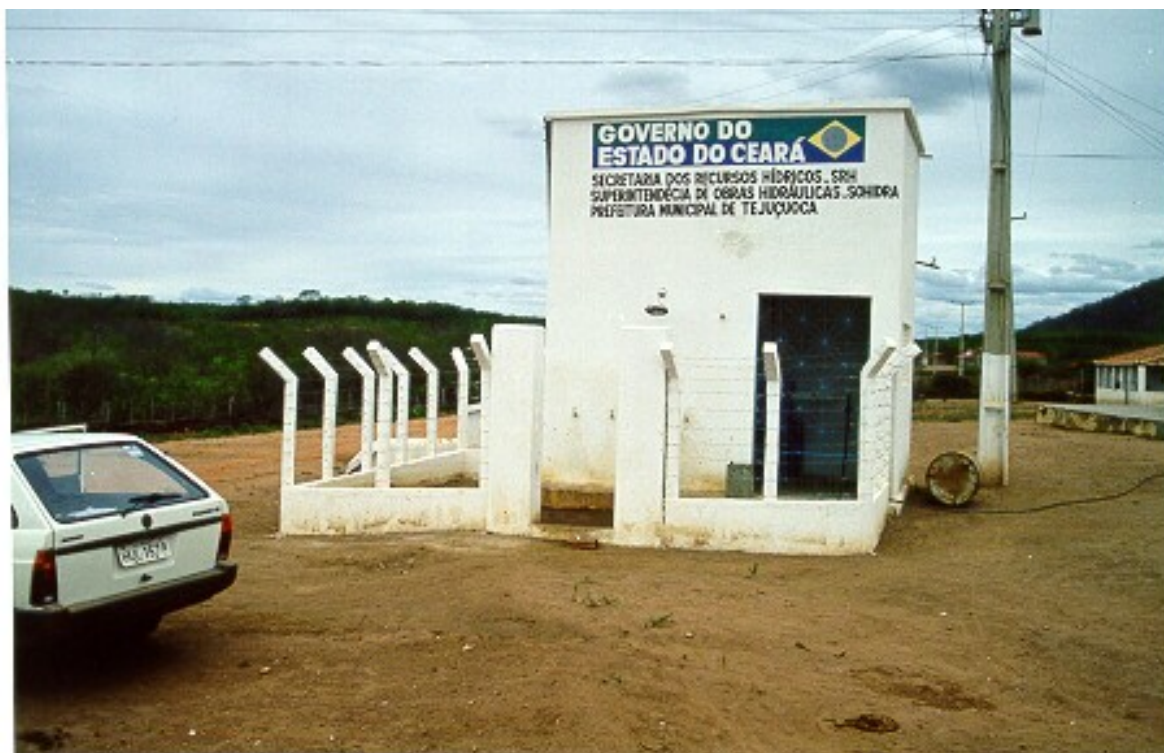
Figura 24: Estrutura de proteção do dessalinizador.
