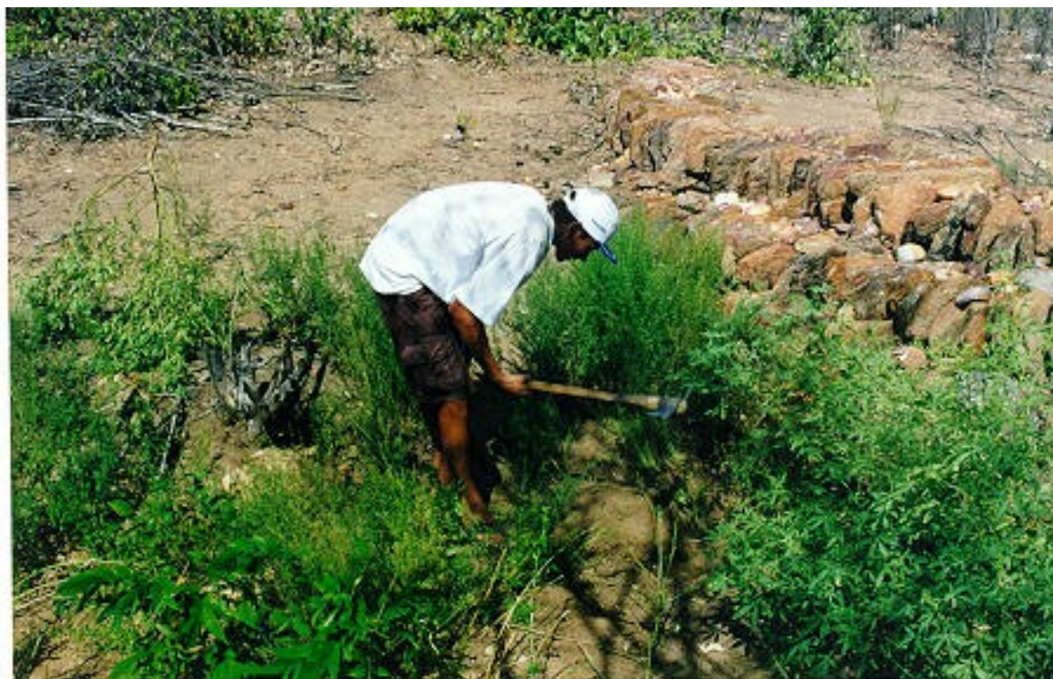
Figura 8: Perfuração do local de instalação da régua.
