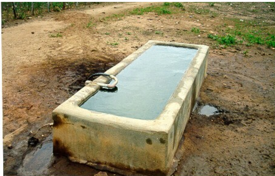
Foto 26: Tanque para armazenamento da água retida no Dessalinizador
