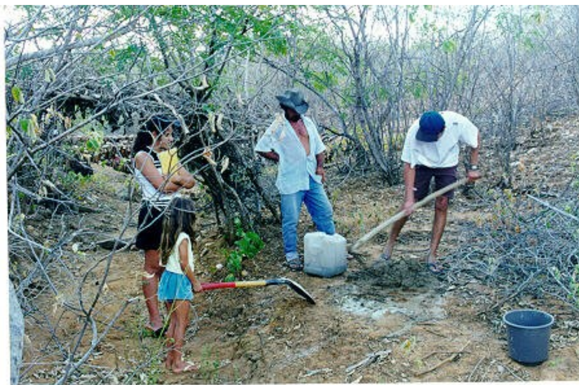
Figura 9: Preparação do concreto para fixação da régua.
