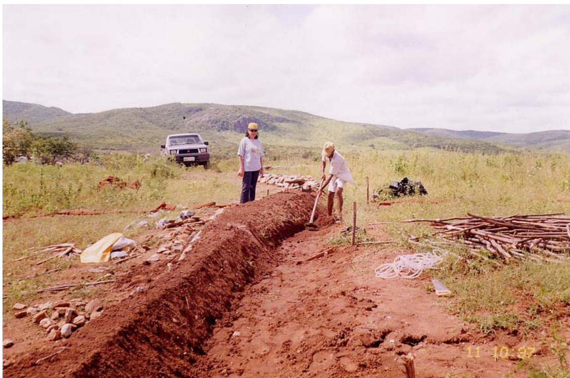
FIGURA 4.6 - Nivelamento do terreno para construção dos cordões de pedra em contorno na área em estudo, 2002.
