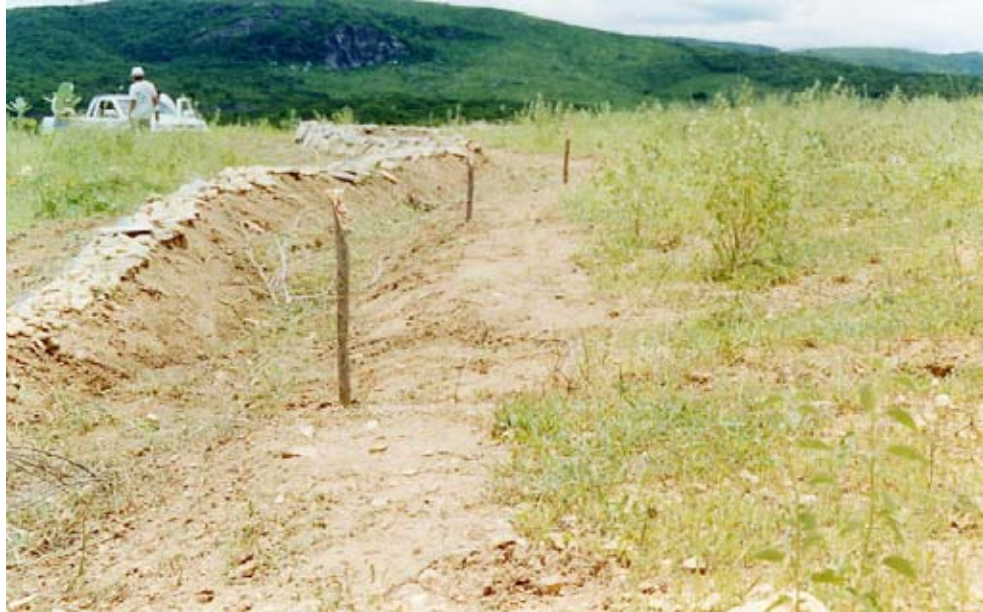
Figura 4.7- Construção dos cordões de pedra em contorno, 2002.
