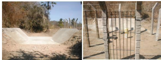
Foto 1: Calha medidora de vazão e obra de proteção de limnígrafos.
