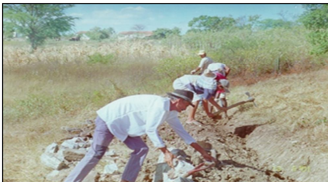
Figura 4 – Agricultores de Iguaçu construindo um cordão de pedra
