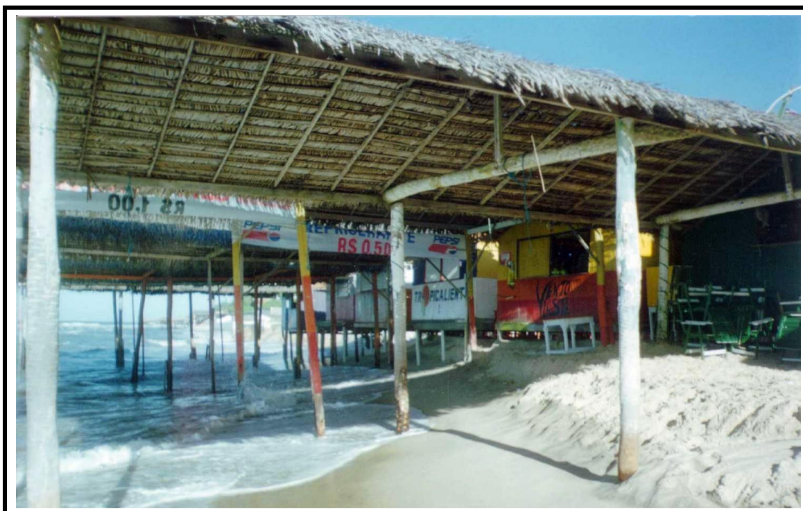
Foto 18.8 – Construção de obra costeira na Zona de domínio da maré – Caponga – Cascavel - CE
