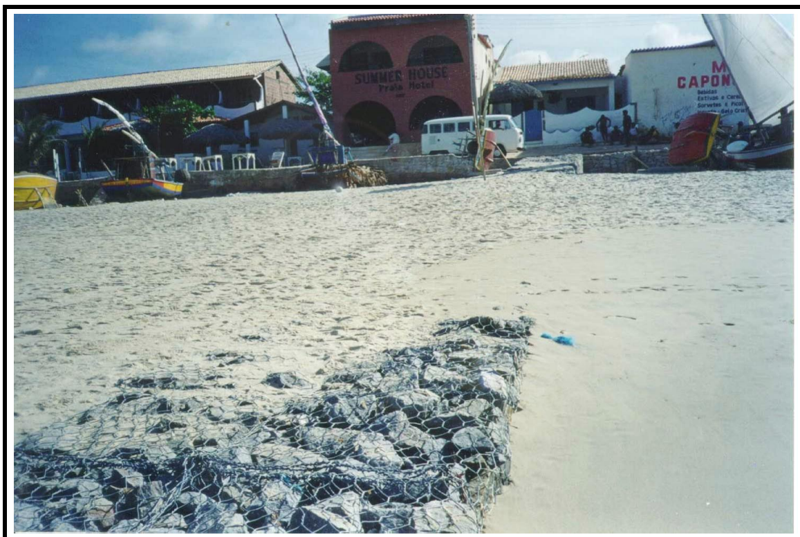
Foto 18.6 – Mesma área anterior após intervenção defensiva e reparadora – Caponga – Cascavel - CE
