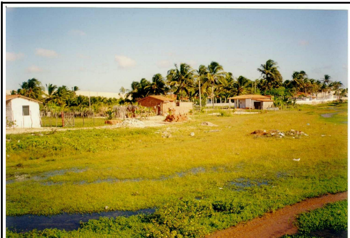
Foto 18.15 – Local ao longo do exutório lagamar onde foram destruídas 04 casas quando do arrombamento da lagoa dos Tocos.
