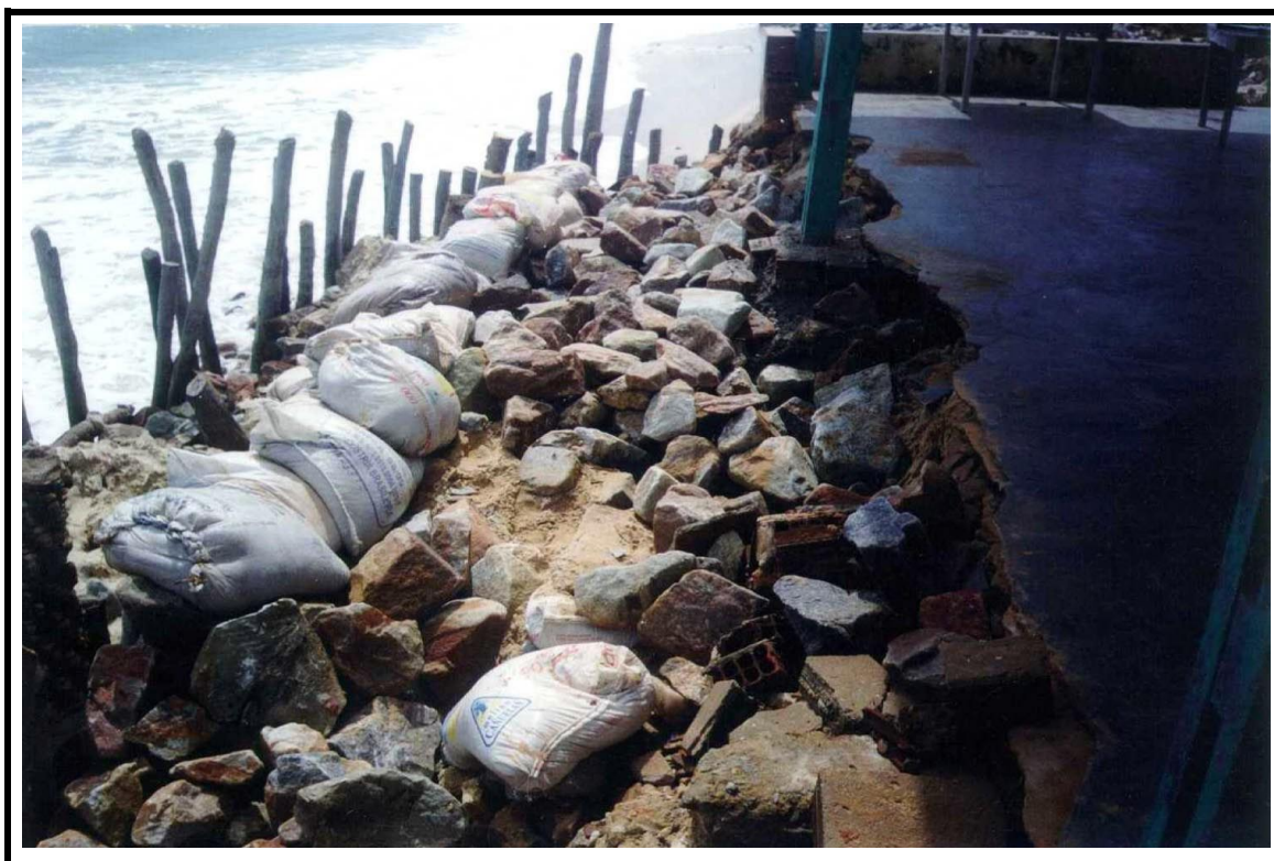
Foto 18.12 – Construção costeira do Pecém, apresentando precária defesa contra as ondas – Pecém – CE.
