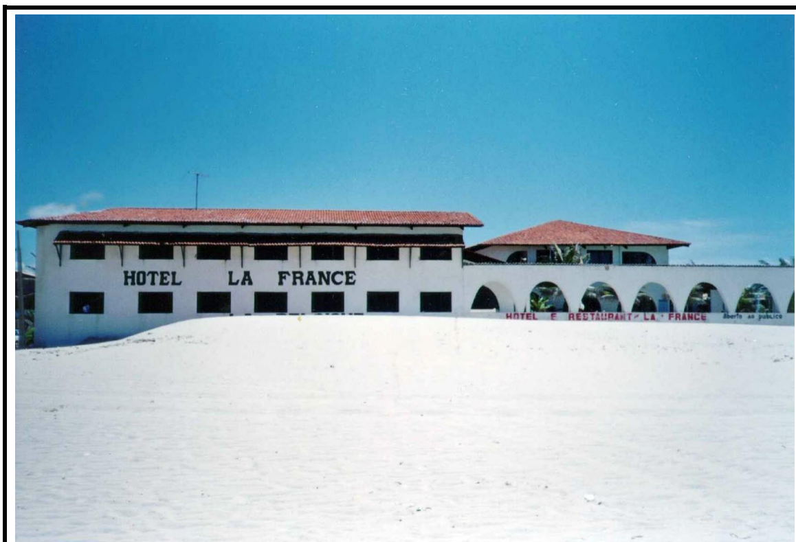
Foto 18.7 – Construção de obra costeira barrando o transporte sedimentar eólico – Caponga – CE
