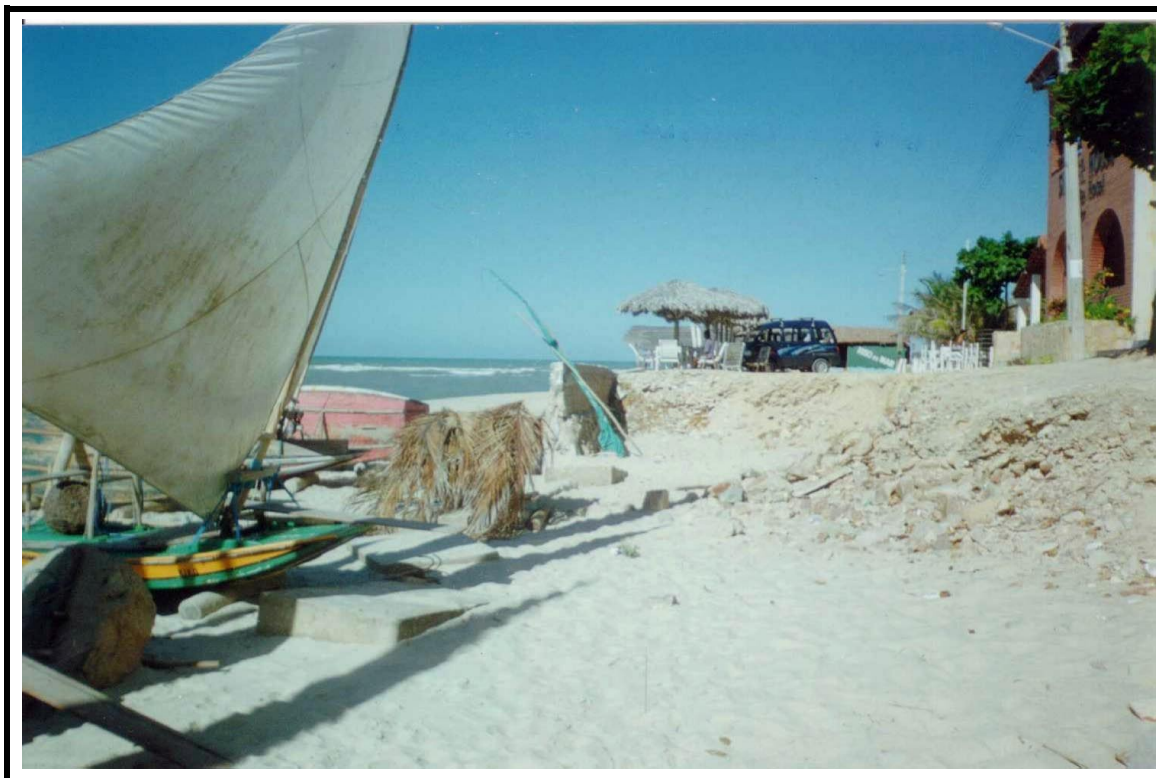
Foto 18.5 – Praia em franco processo erosivo – Caponga – Cascavel - CE
