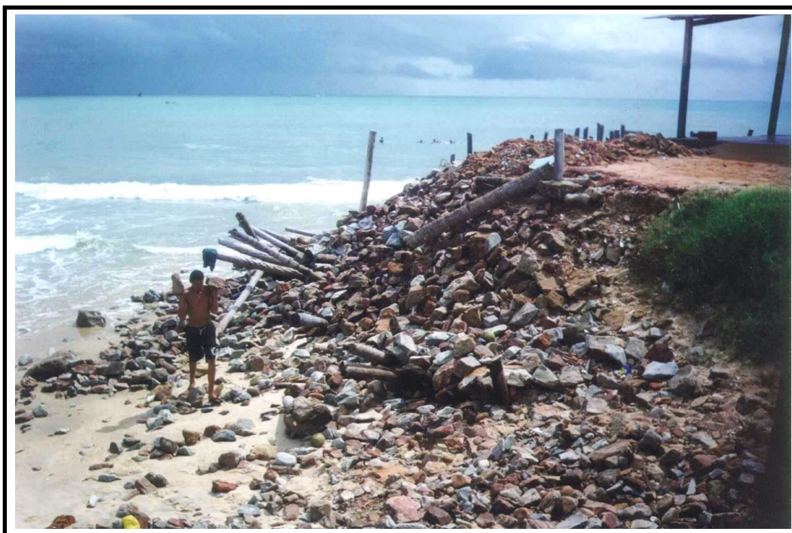
Foto 18.13 – Mesma construção arrasada após regimes ondulatório e de marés de grande magnitude.
