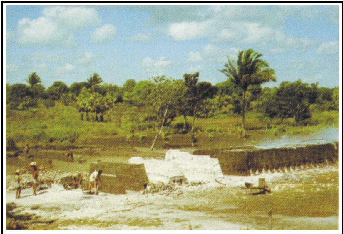
Foto 18.1 – Confeção de tijolos a partir de argila retirada do fundo das lagoas.
