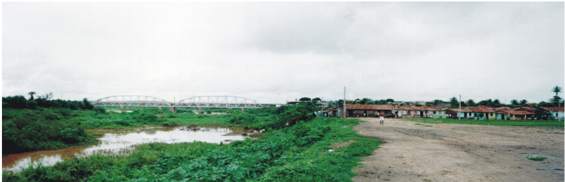
Foto 2.2.1.3 - Vista da área crítica a jusante da ponte de acesso a Iguatu. Coordenadas ( E=467.8261; N=9.295.567)
