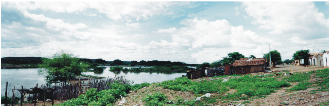
Foto 2.2.12.3 - Rio Jaguaribe - Margem direita - Detalhe das construções dentro da calha do Rio ( Todas inundam). Coordenadas ( E=542.084; N=9.373.850).
