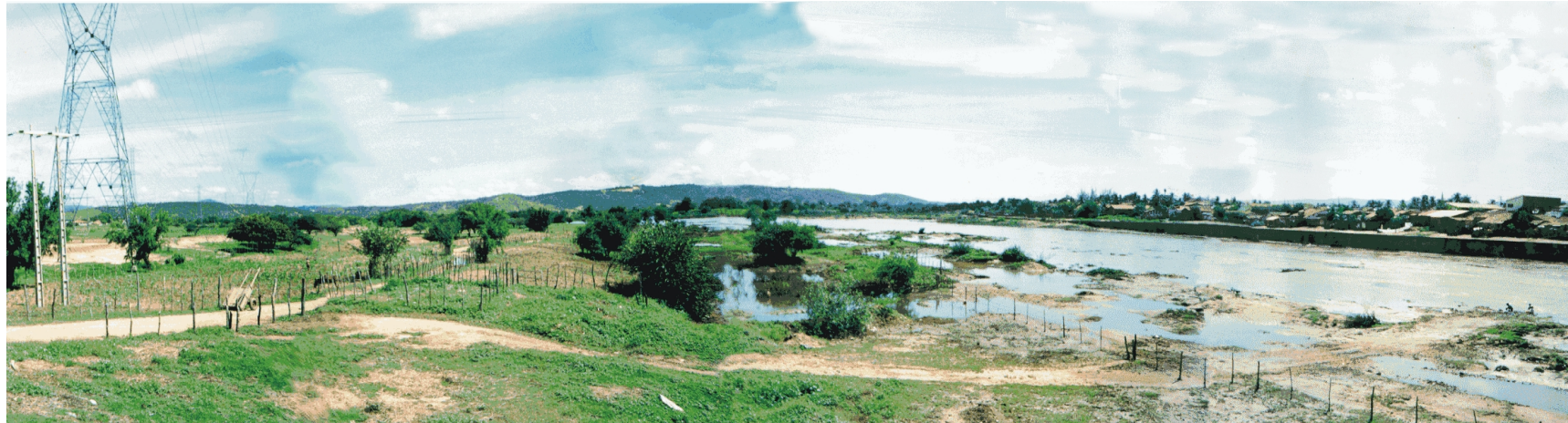
Foto 2.2.2.2 - Vista do Rio Salgado. Na margem direita muro de arrimo e na margem esquerda dique de proteção do Projeto de Irrigação do DNOCS.
