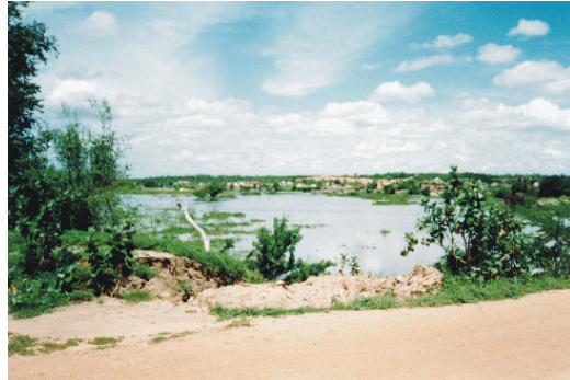
Foto 2.2.9.2 - Rio Jaguaribe a montante da Passagem Molhada em Flores - Russas. Coordenadas (E=603.625; N=9.440.208)
