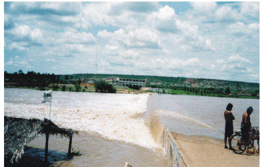
Foto 2.2.5.2 - Rio Jaguaribe - Passagem Molhada. (Coordenadas - E=602.938; N=9.426.457)
