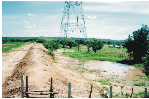
Foto 2.2.2.3 - Dique de Proteção na margem esquerda do Rio Salgado. Coordenadas (E=514.963; N=9.291.552)
