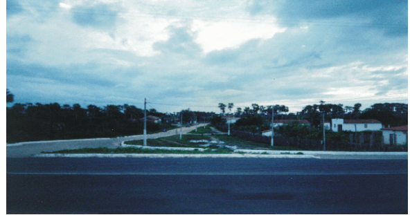
Foto 2.2.8.2 - Vila não protegida pelo Dique. (Coordenadas - E=636.171;N=9.493.213)
