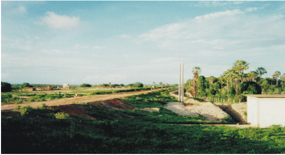
Foto 2.2.8.1 - Dique de Proteção da cidade de Aracati. (Coordenadas - E=635.274; N=9.493.505)
