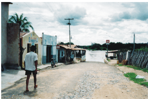
Foto 2.2.12.4 - Vista da passagem molhada no final da Travessa Peixoto. ( Coordenadas -E=542.328; N=9.374.308)
