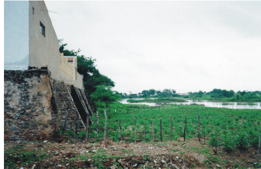
Foto 2.2.1.2 - Detalhe da confluência do Rio Jaguaribe com a Rua Santos Dumont. Coordenadas ( E=467.851; N=9.296.341)
