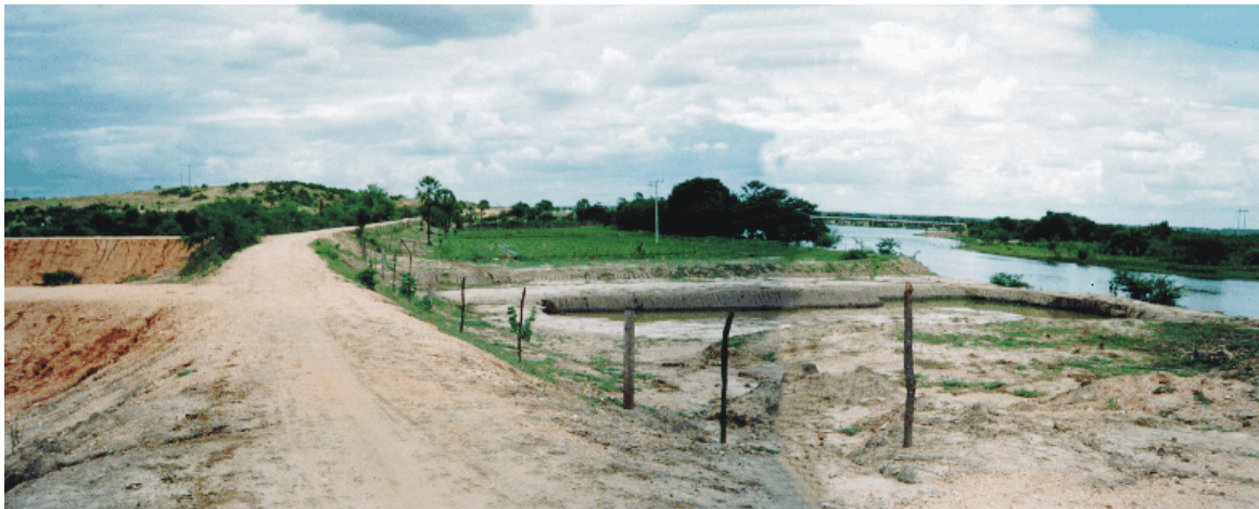
Foto 2.2.4.3 - Dique de Proteção da Cidade na margem esquerda do Rio Banabuiú a jusante da cidade. Coordenadas (E=570.502; N=9.433.940)
