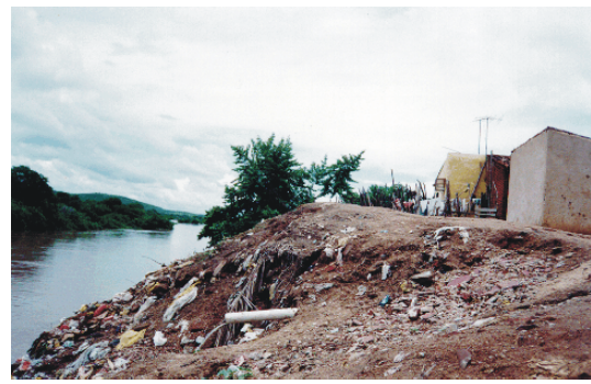
Foto 2.2.2.4 - margem direita do Rio Salgado, ponto onde na cheia de 1974 atingiu a rua Dr. Inácio Dias Coordenadas (E=515.916; N=9.292.548)
