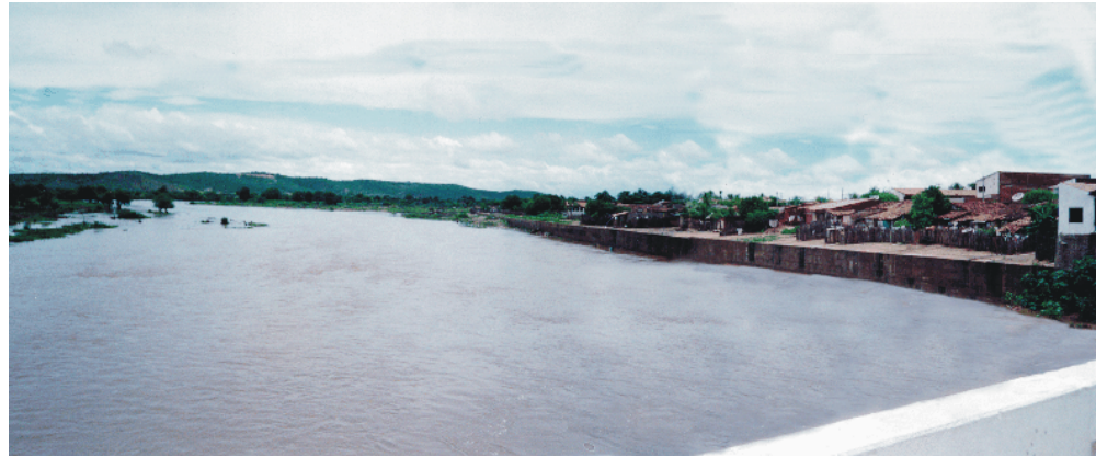
Foto 2.2.2.1 - Muro de arrimo na margem direita do Rio Salgado e residências que são sempre inundadas nas maiores cheias. Coordenadas ( E=514.963; N=9.291.552)
