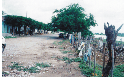
Foto 2.2.3.4 - Final da Avenida Beira Rio. Ao fundo o Rio Jaguaribe praticamente na mesma cota do pavimento da Avenida. Coordenadas (E=542.192; N=9.349.474)
