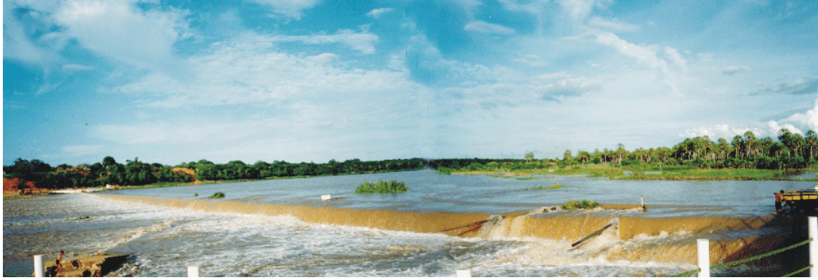
Foto 2.2.7.1 - Rio Jaguaribe . Passagem Molhada e Barragem do Canal do Trabalhador Coordenadas (E=631.260; N=9.482.947)
