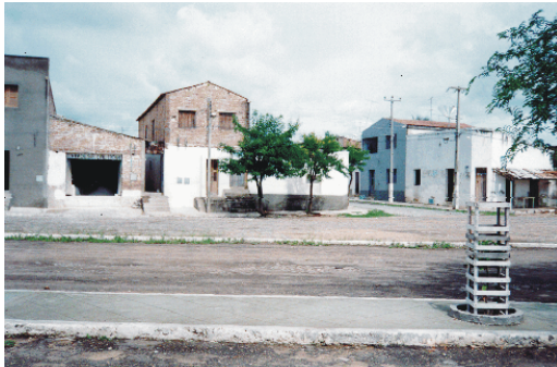
Foto 2.2.3.3 - Residências na Avenida Beira Rio. Detalhe dos degraus na frente das casas. Proteção contra as cheias do Rio. Coordenadas (E=541.903; N=9.348.517)
