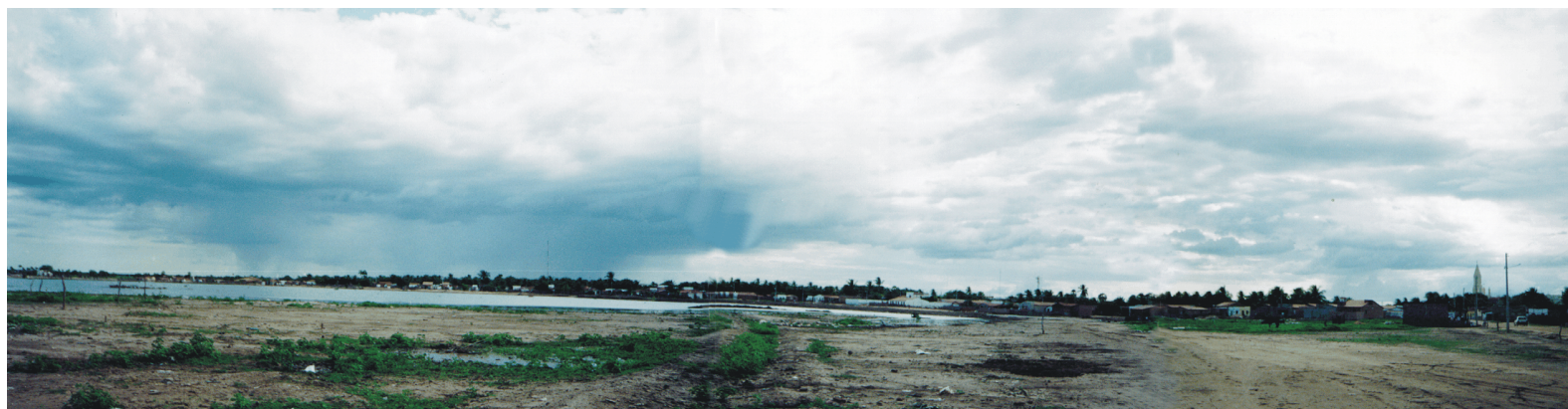
Foto 2.2.11.2 - Inicia-ce as inundações por essa área. Coordenadas (E=635.572; N=9.464.974).
