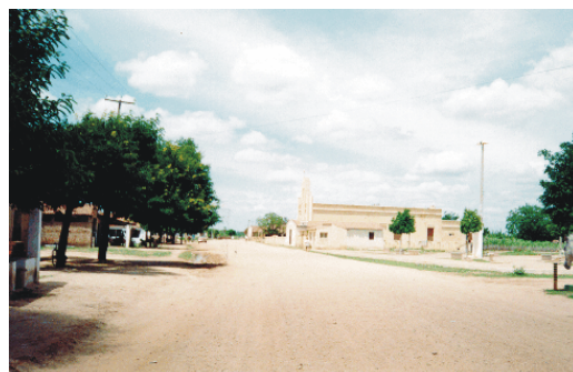
Foto 2.2.5.6 - Povoado de São Raimundo e Arraial de Cima. Também inunda expulsando todos da região. (Coordenadas - E=601.906; N=9.434.846)
