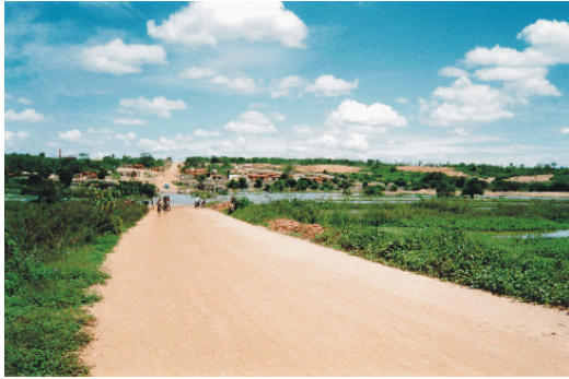
Foto 2.2.9.1 - Passagem Molhada no Rio Jaguaribe no Distrito de Flores - Russas. Coordenadas (E=603.625; N=9.440.208)
