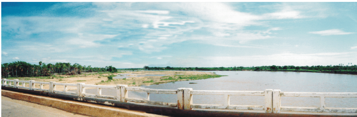
Foto 2.2.6.1 - Rio Jaguaribe, a jusante da ponte na estrada que liga Limoeiro do Norte a Quixeré . Coordenadas (E=611.316;N=9.437.614)
