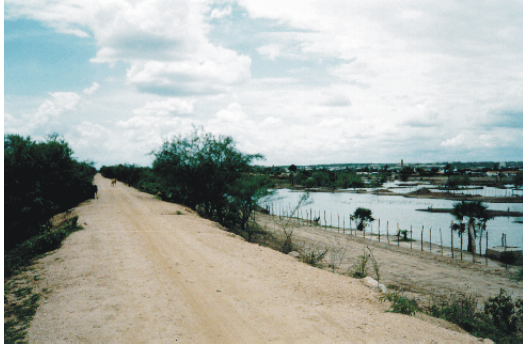
Foto 2.2.4.1 - Dique de Proteção da Cidade de Morada Nova. Coordenadas (E=570.502; N=9.433.940)
