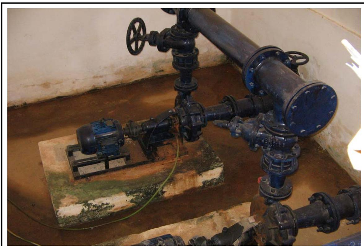
**Foto 18** - Sistema de abastecimento de São Gonçalo do Amarante: Equipamento de Bombeamento do sistema de Reservação de Umarituba, necessitando de manutenção.
