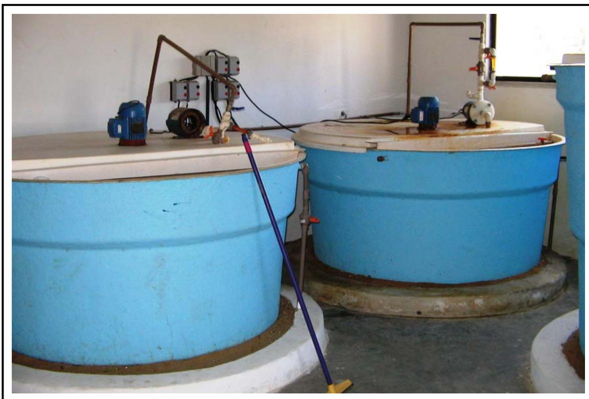
**Foto 10** - Sistema de Abastecimento de São Gonçalo: Tanques dosadores cujo funcionamento não tem se mostrado satisfatório.
