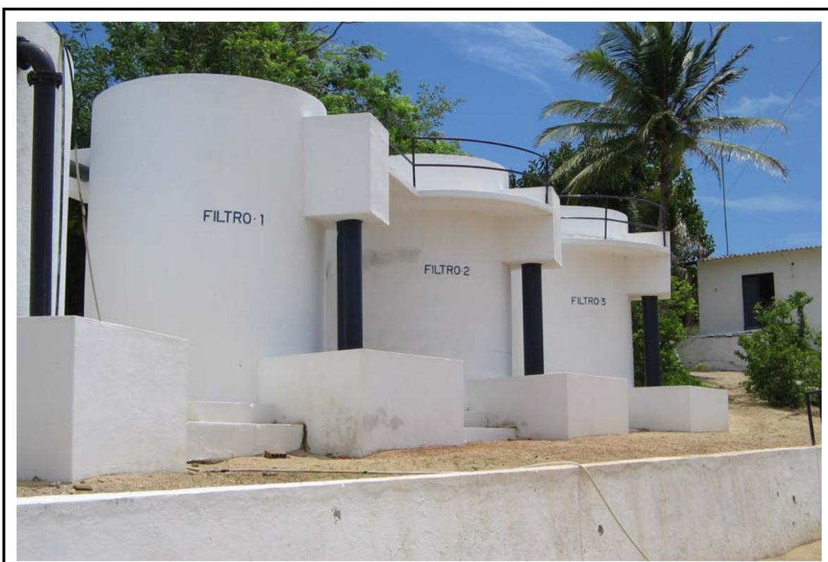
**Foto 32** - Sistema de Abastecimento de São Gonçalo: Bateria de Filtros na ETA de Suipé.
