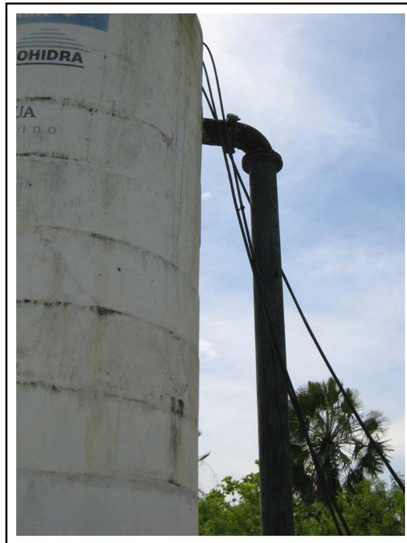
**Foto 16** - ETA de Catuana: Outra vista da retirada de irregular de água por meio de tubulação plástica de pequenos diâmetros.
