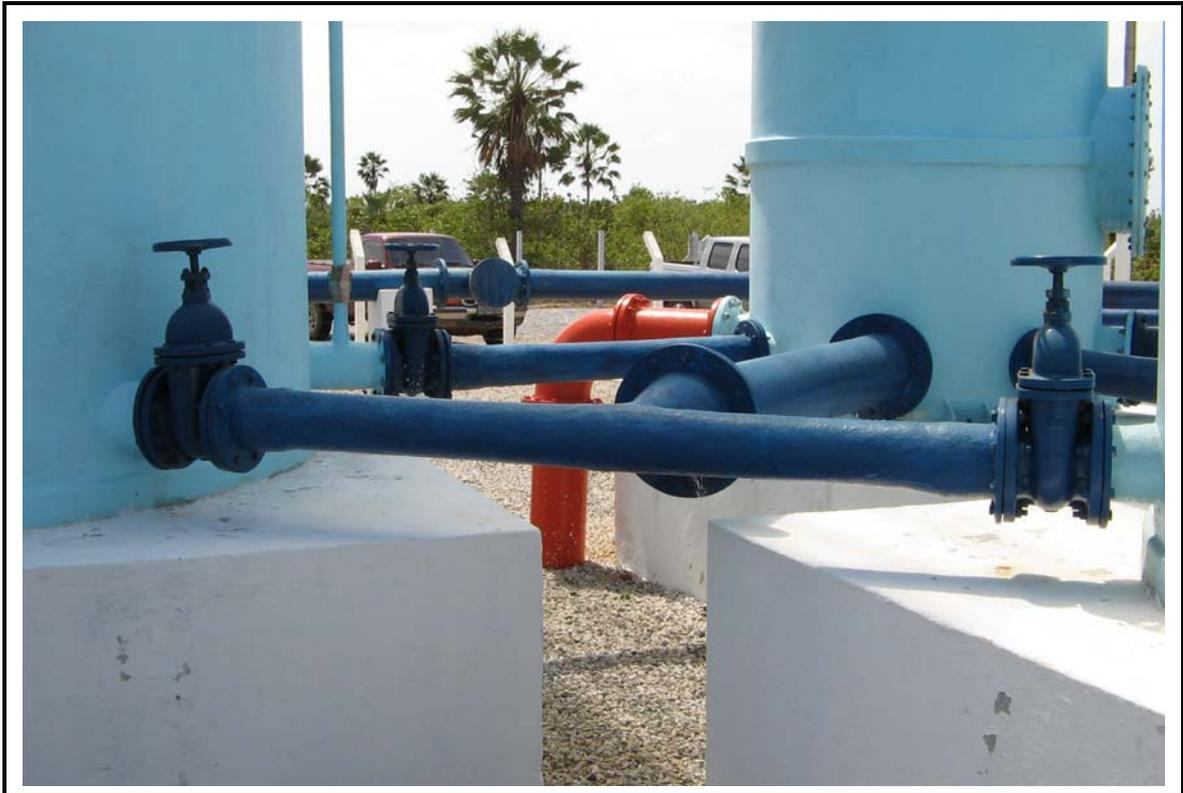
**Foto 05** - Tubulação de ligação dos filtros a Câmara de Carga.
