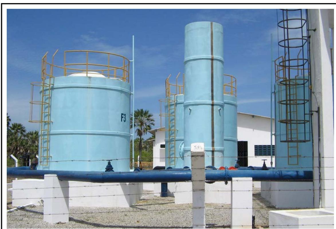
**Foto 08** - Vista da ETA de Catuana : Câmara de Carga e Filtros.
