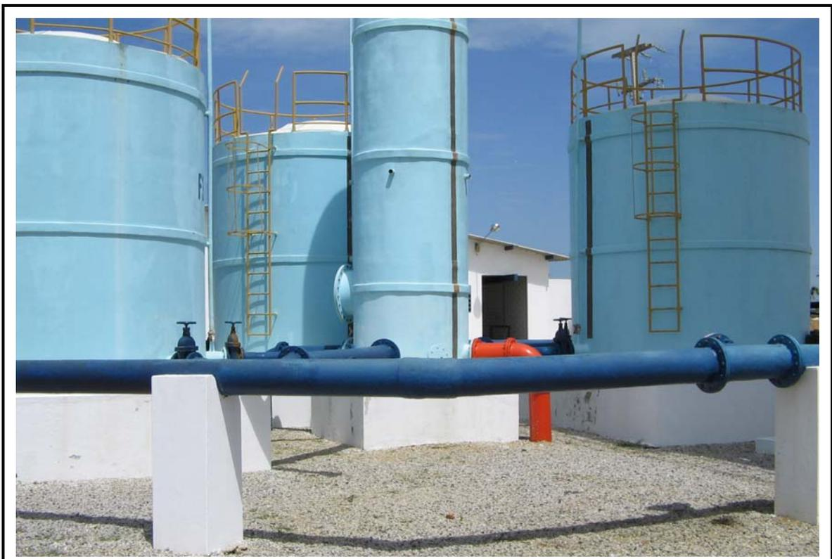
**Foto 06** - Sistema de Abastecimento de São Gonçalo: Câmara de Carga e Filtros.
