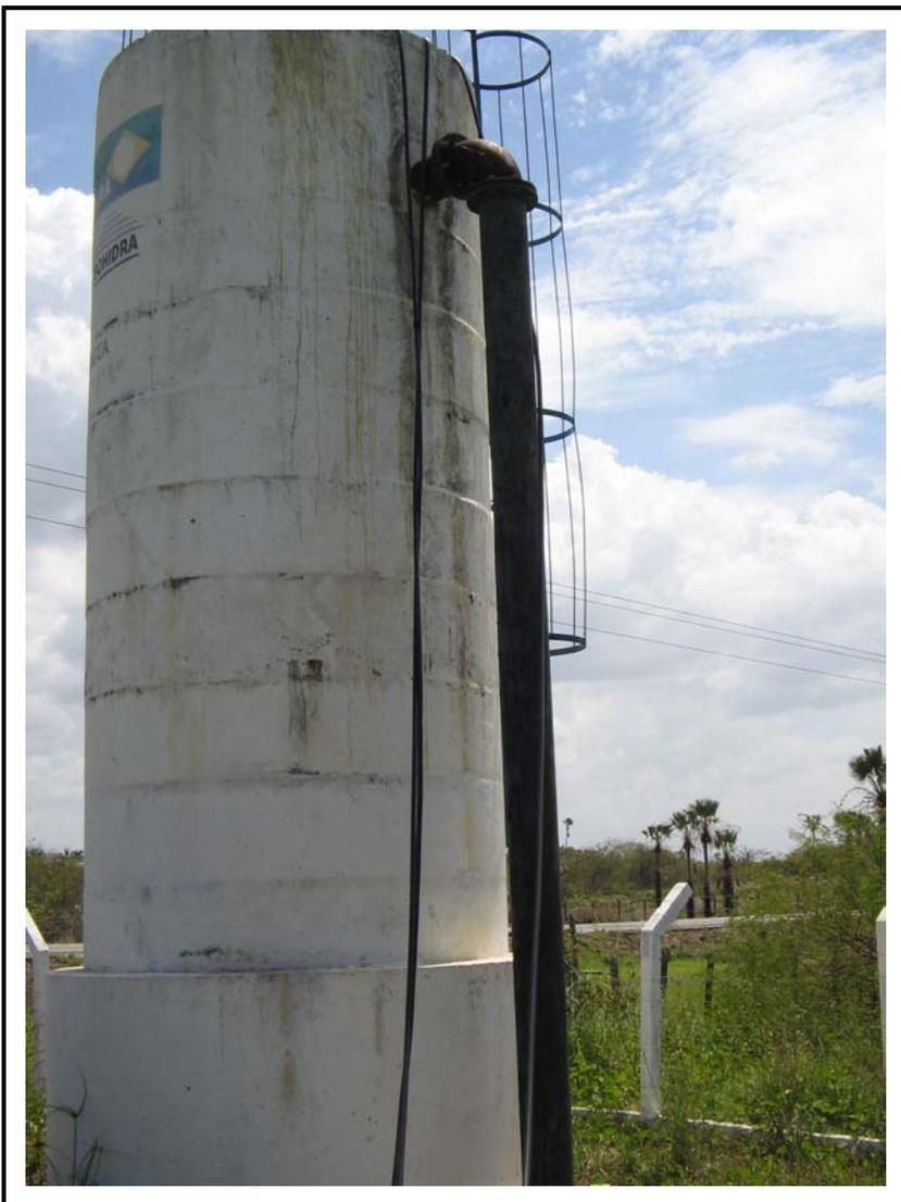
**Foto 15** - ETA de Catuana: Retirada de água irregular por meio de tubulação plástica de pequenos diâmetros.
