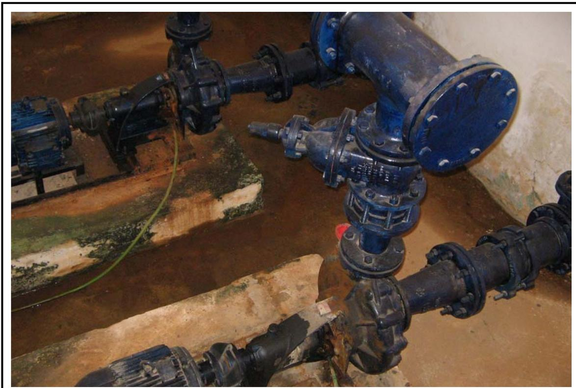
**Foto 19** - Sistema de abastecimento de São Gonçalo do Amarante: Outra vista Equipamento de Bombeamento do sistema de Reservação de Umarituba, necessitando de manutenção.
