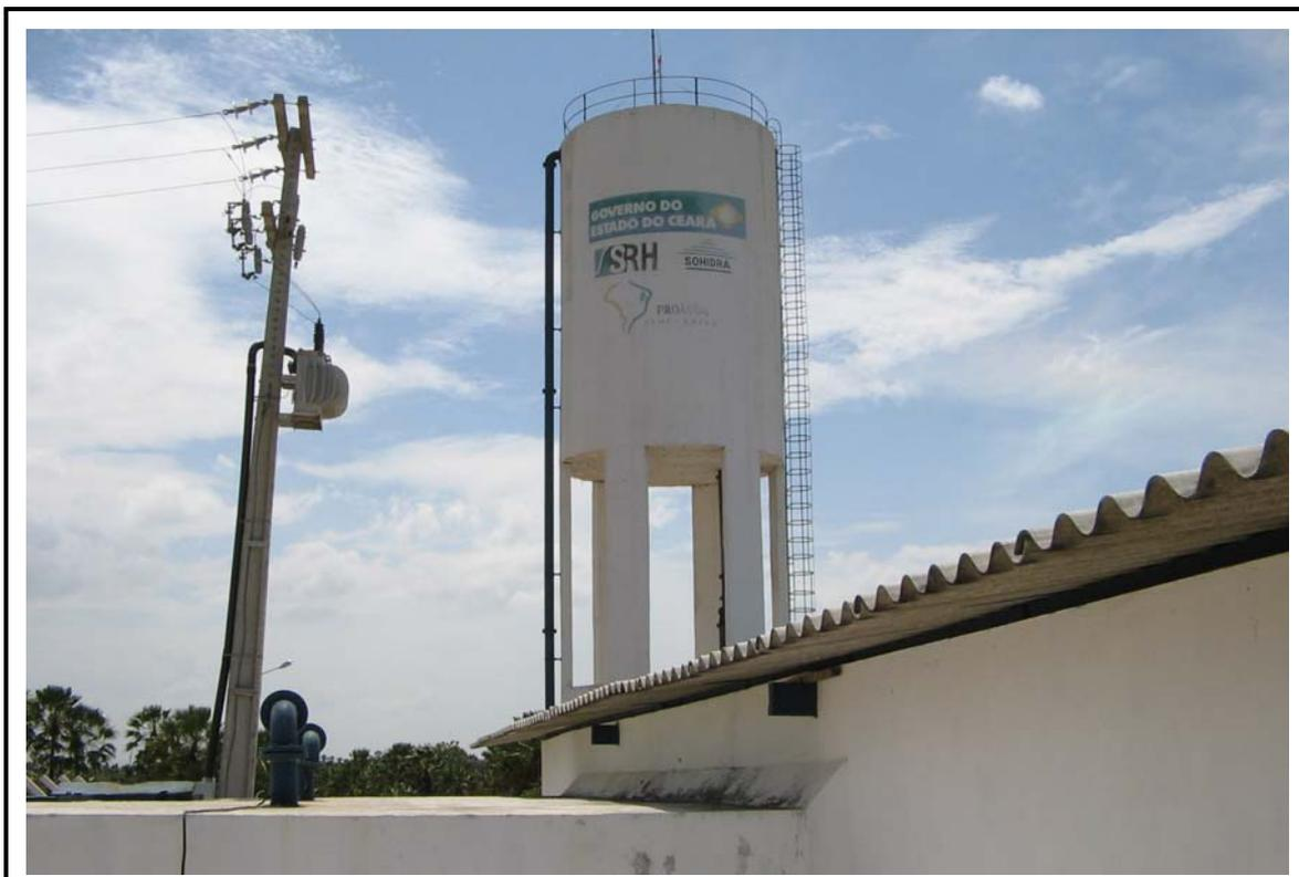
**Foto 13** - Sistema de Abastecimento de São Gonçalo: Em primeiro Plano o reservatório de água tratada e reservatório para água de lavagem dos filtros.
