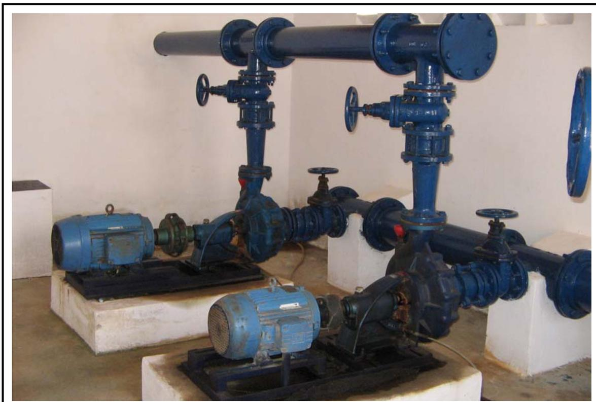
**Foto 35** - Sistema de Abastecimento de São Gonçalo: Bombas para lavagem dos filtros na ETA de Suipé.
