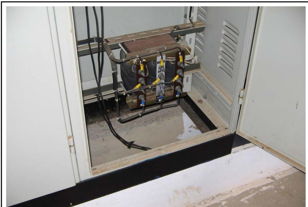
**Foto 29** - Sistema de abastecimento de São Gonçalo do Amarante: Equipamento Elétrico. Note-se a falta de vedação, com cinta de borracha, da porta do armário.
