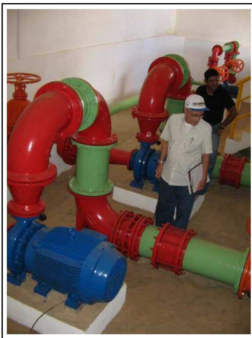
Foto 28 - EE4 - não há recalque de água para Baturité.
