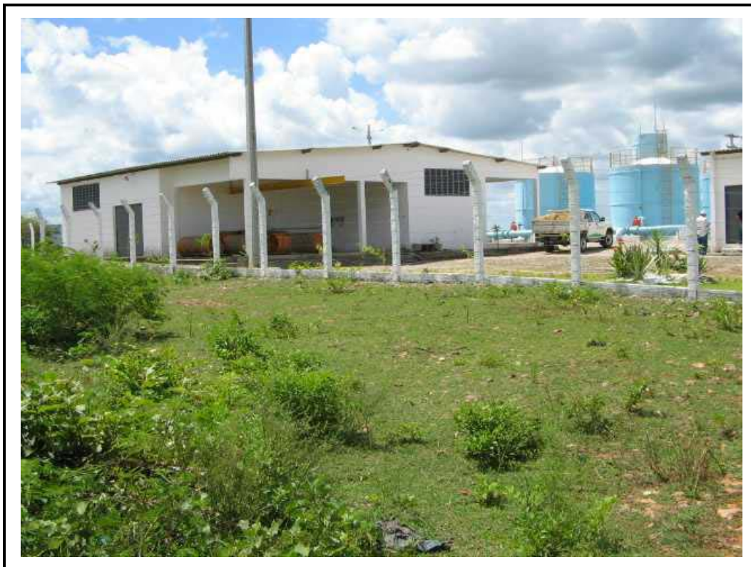
Foto 03 - ETA - área de cloração.
