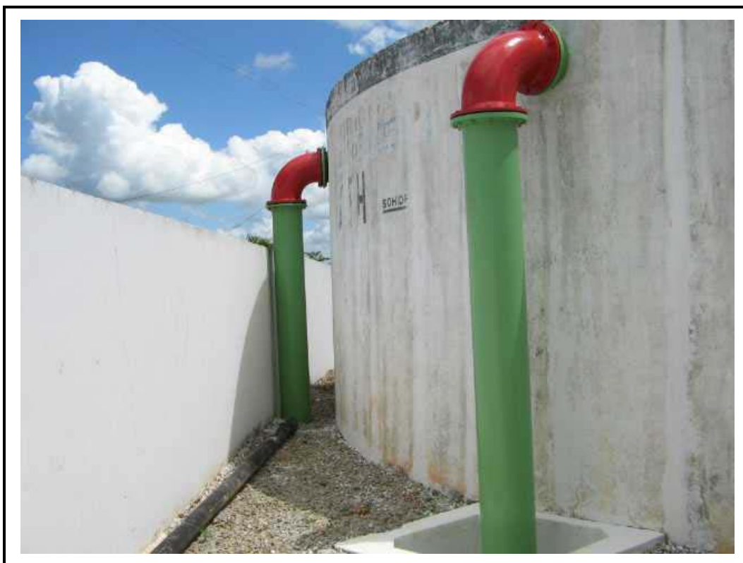
Foto 07 - Reservatório apoiado da ETA - tomada d'água da EE2.
