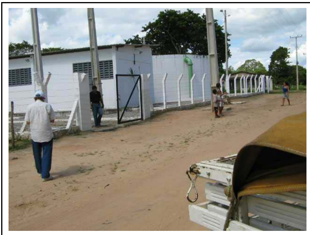
Foto 18 - Vista geral da EE3.
