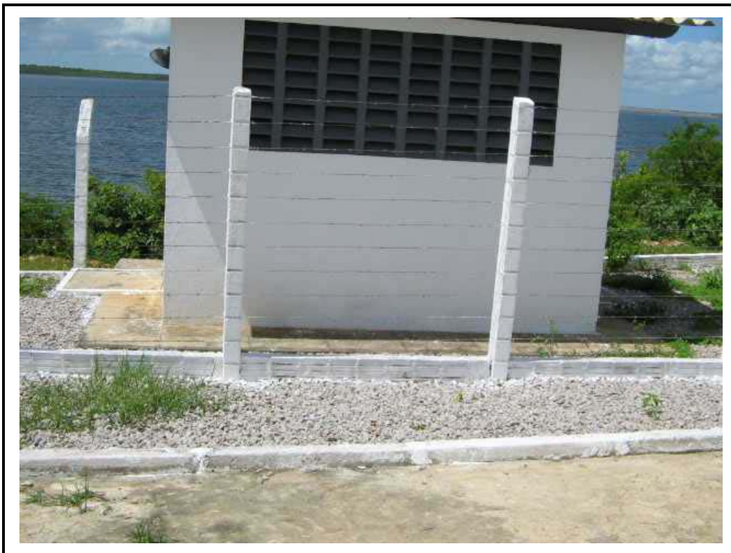
Foto 12B - Casa de comando com painel de controle do flutuante.
