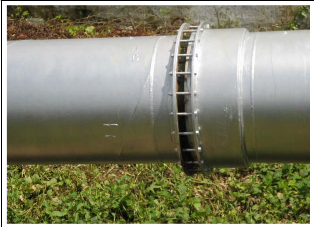
Foto 05 - Detalhe da junta de dilatação da adutora.
