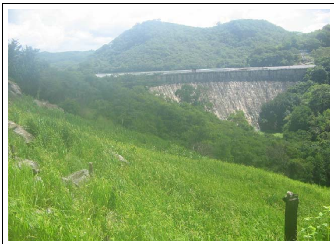
Foto 11 - Vista geral da barragem Acarape do Meio.
