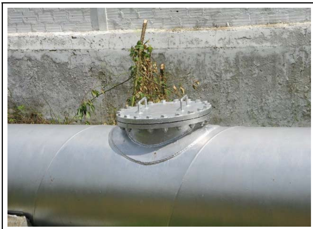
Foto 04 - Flange em um acesso ao interior do tubo.
