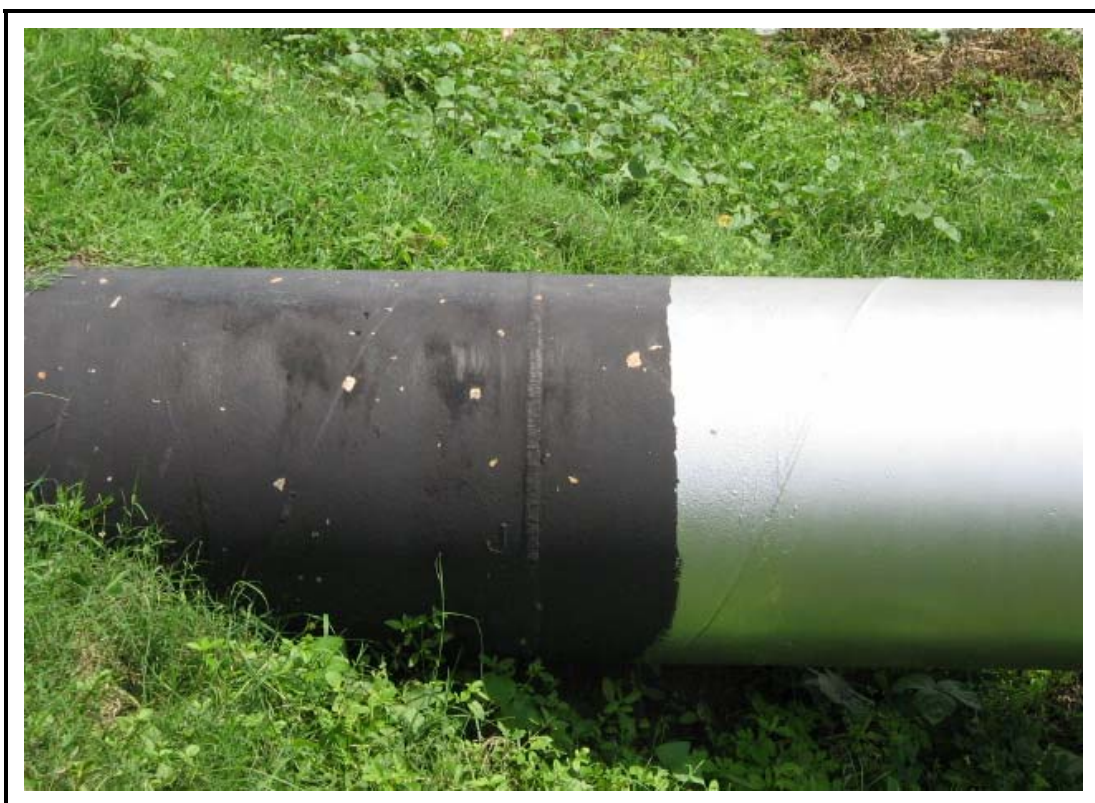
Foto 07 - Limite dos trechos aéreos e subterrâneos da adutora.
