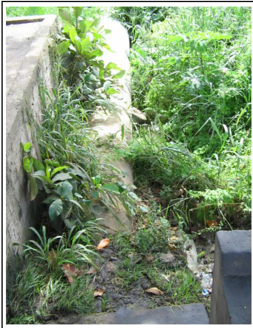
Foto 08 - Linha adutora: trecho aéreo sempre coberto por vegetação.
