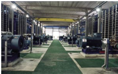
Desaladora de Adeje-Arona en fase de construcción
