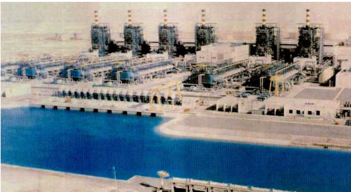
Figura a1.6. Fotografía de la planta Al Taweelah B (Abu Dhabi, Emiratos Arabes Unidos). Fuente: Italimpianti (1996).
