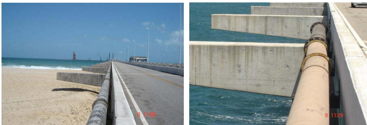
Figura 3.2 – Fotos da Tubulação do Emissário da Termelétrica, onde será Ancorada a Adutora de Alimentação da Usina de Dessalinização.
