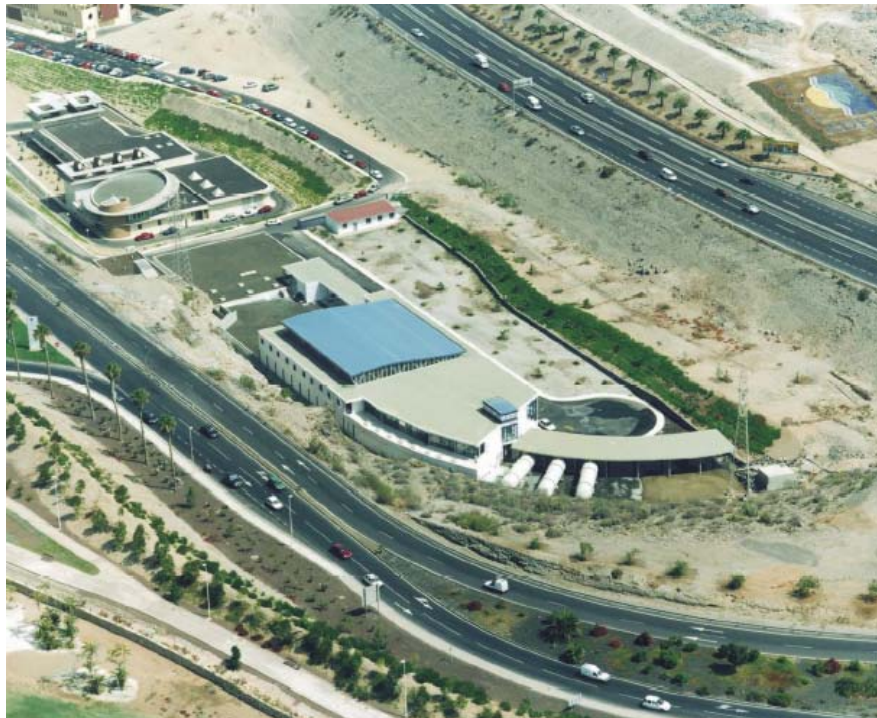
Figura 2.19 - Foto da Usina de Dessalinização ADEJE-ARONA, nas Canárias.
