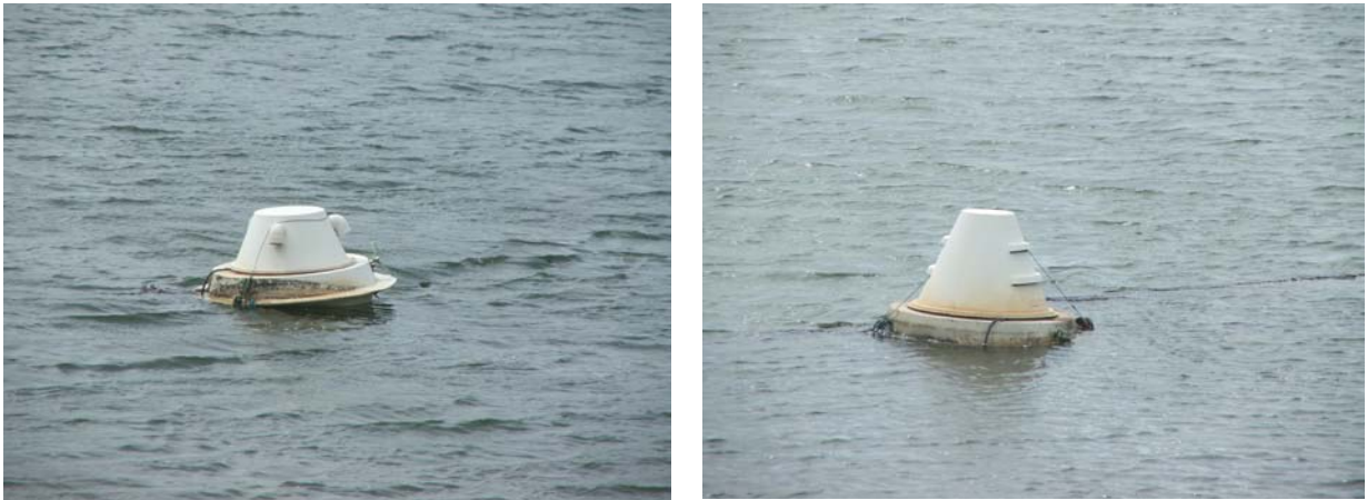
Figura 7.2 - Flutuadores da captação do Sistema de Abastecimento do Pecém.
