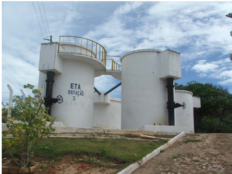
Figura 7.4 - Vista Parcial da ETA do Pecém.
