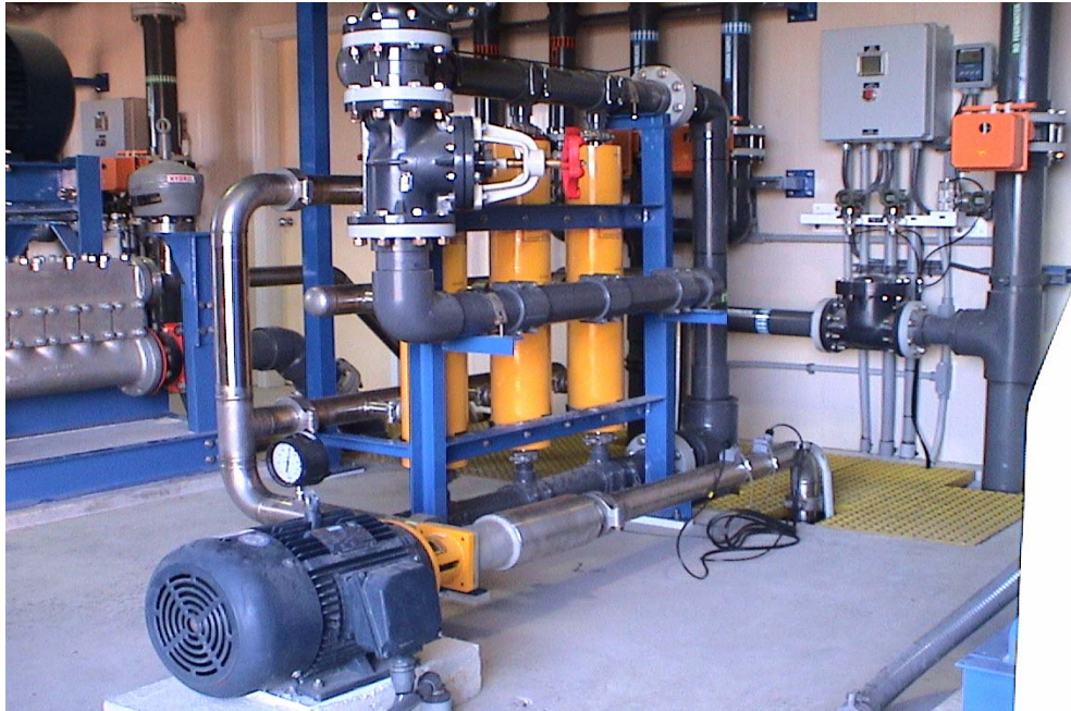
Figura 2.17 – Representação Esquemática do Sistema de Trocadores de Pressão
