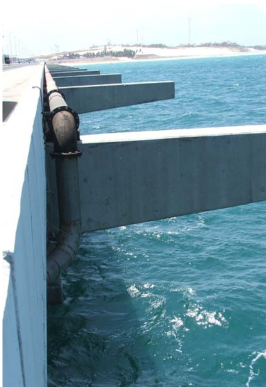
Figura 8.10 - Vista Parcial da Ponte de Acesso ao Pier, com a Tubulação do Emissário da Termelétrica
