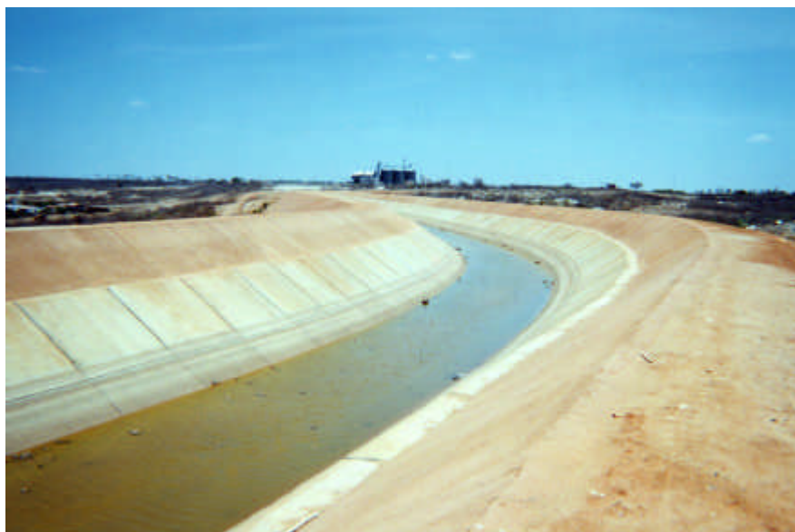
Foto 14.1 - Aspetto geral do canal adutor I de Tabuleiro de Russas (local de interseção com o canal adutor do eixo de integração)
