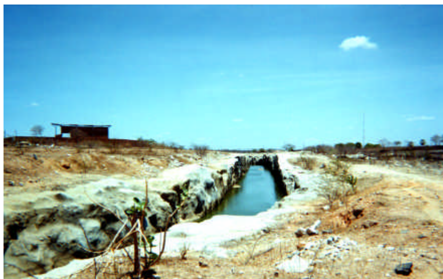
Foto 14.3 - Vista geral do canal adutor I de Tabuleiro de Russas (seção retangular-corte em rocha)
