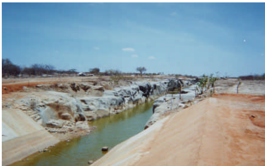
Foto 14.2 - Aspeto da transição seção trapezoidal-retangular do canal adutor I de Tabuleiro de Russas
