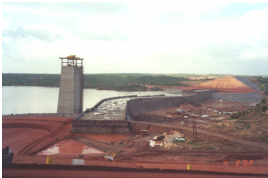
Foto 2.1– Vista da Barragem do Castanhão em fase de construção
