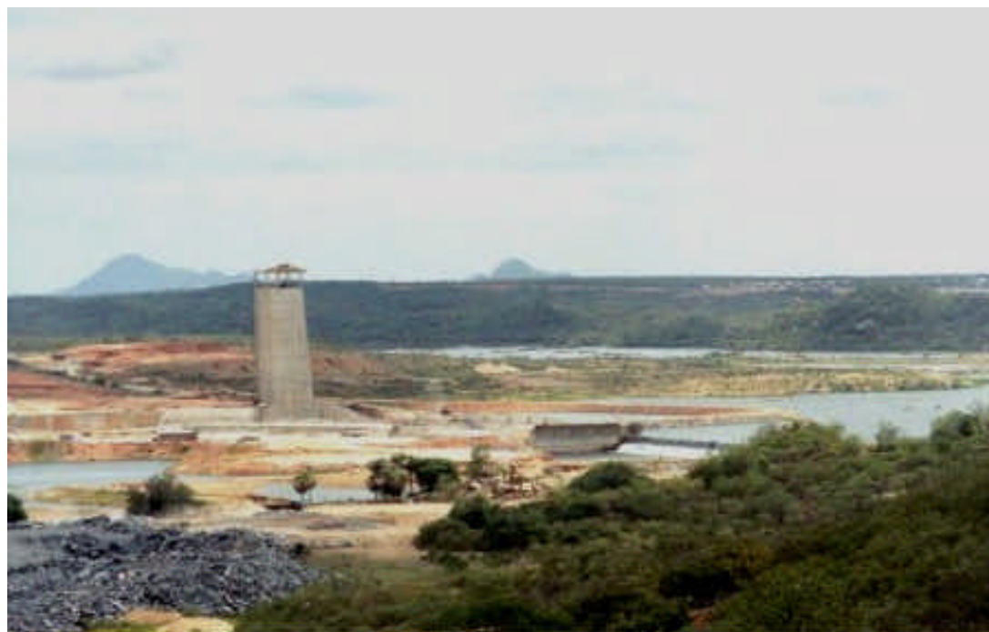
Foto 3.3 – Vista geral da área de captação na calha do Rio Jaguaribe, e da elevação onde será implantada a estação de bombeamento. Em segundo plano as obras do Açude Castanhão, vendo-se a torre da tomada d'água.
