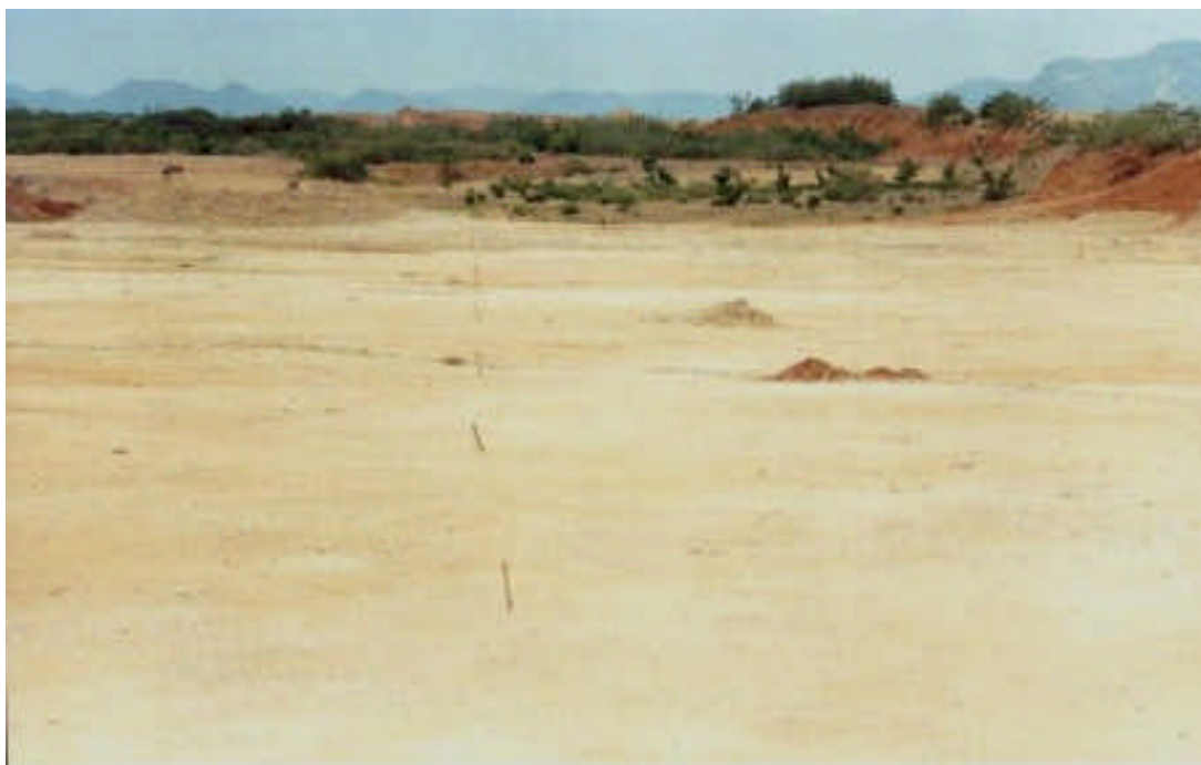
Foto 3.5 – Eixo da adutora no terreno plano escavado, formado por sedimentos da Formação Faceira, à jusante do dique fusível do Açude Castanhão.
