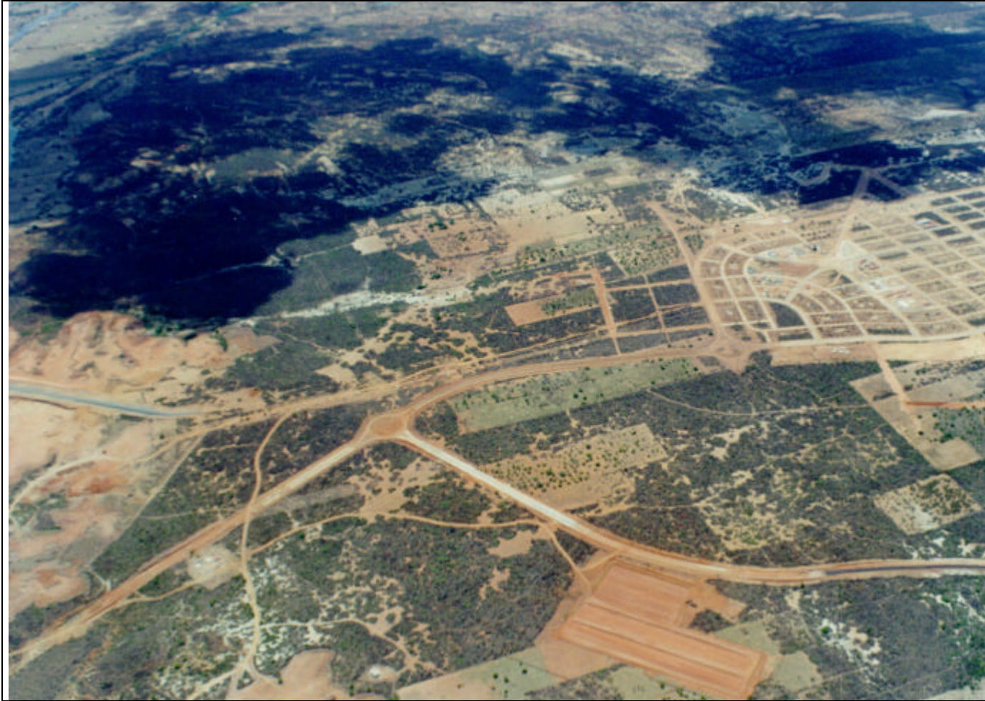
Foto 09/51 - Área onde se desenvolverá o trecho inicial do canal adutor, nas imediações da cidade de Nova Jaguaribara, que já encontra-se praticamente construída. O canal adutor interceptará a rodovia CE-269 na altura da rótula que permite o acesso à cidade, desenvolvendo-se paralelo a rodovia de contorno permitindo a integração com o futuro Projeto Chapadão do Castanhão.
