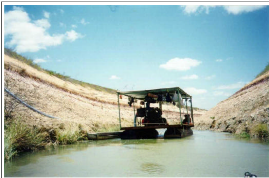
Foto 47/51 - Operação de dragagem do Canal do Trabalhador em trecho onde este apresenta sérios problemas de assoreamento na altura do km 88.
