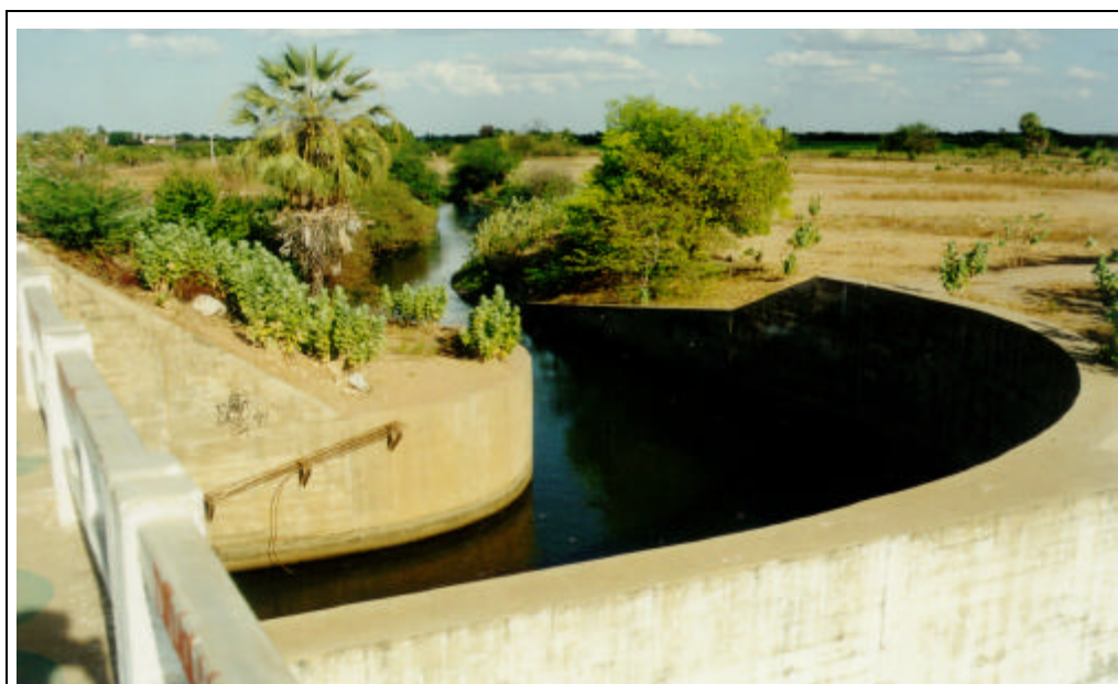
Foto 25/51 - Detalhe do trecho inicial do canal principal do Perímetro Irrigado de Morada Nova, na margem esquerda do rio Banabuiú, o qual será interceptado pelo sifão previsto para a travessia do referido rio.
