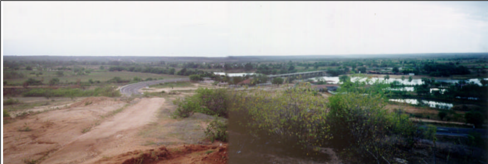
Foto 26/51 - Vista parcial do vale do rio Banabuiú, a ser transposto pelo sistema adutor em tubulação sob pressão, nas imediações da cidade de Morada Nova. Observa-se, ainda o aspecto da mata ciliar do Banabuiú, praticamente degradada, com alguns remanescentes arbóreos.
