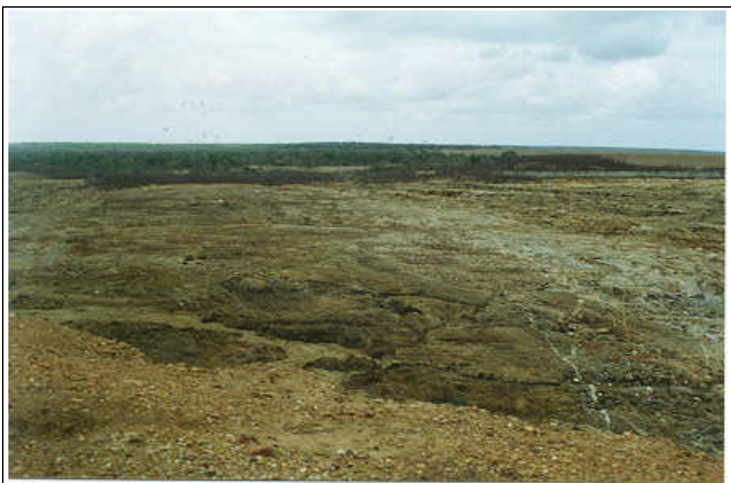
Foto 50/51 - Travessia do rio Choró/açude Pacajus: vista a jusante do vertedouro/barragem.
