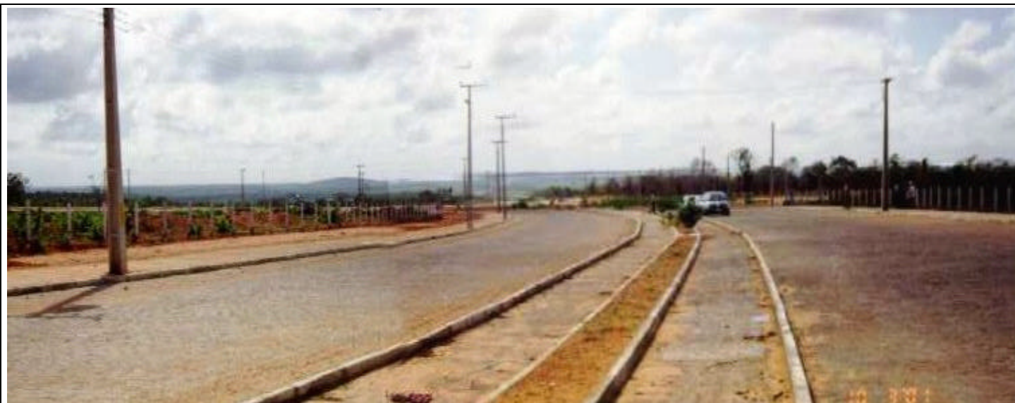
Foto 10/51 - Trecho 1 (Castanhão/Curral Velho): observa-se em segundo plano o local onde o sistema adutor intercepta a CE-269, via de acesso a Nova Jaguaribara.
