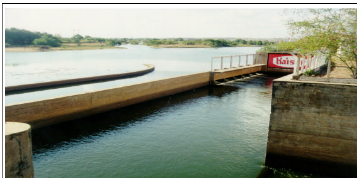
Foto 23/51 - Detalhe da tomada d'água do Perímetro Irrigado de Morada Nova e do sistema de abastecimento da cidade, localizada na margem esquerda do reservatório da barragem de derivação do Banabuiú.
