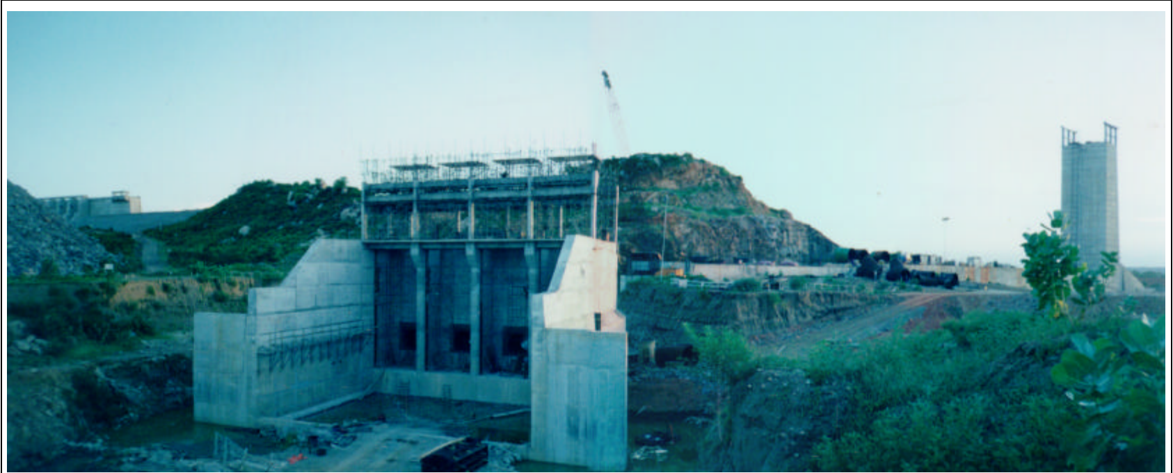
Foto 02/51 - Estrutura da tomada d'água do Açude Castanhão, situada na ombreira direita da barragem, a qual servirá simultaneamente ao projeto ora em análise e as demandas do vale do Jaguaribe.
