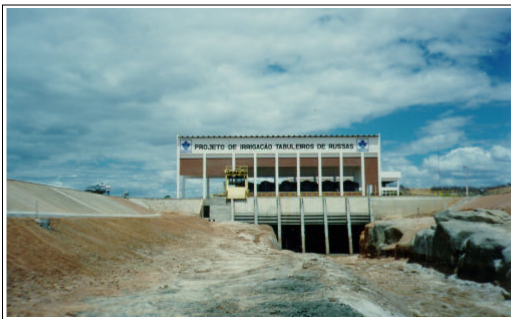
Foto 29/51 - Vista frontal da estação de bombeamento do Projeto de Irrigação Tabuleiros de Russas.
