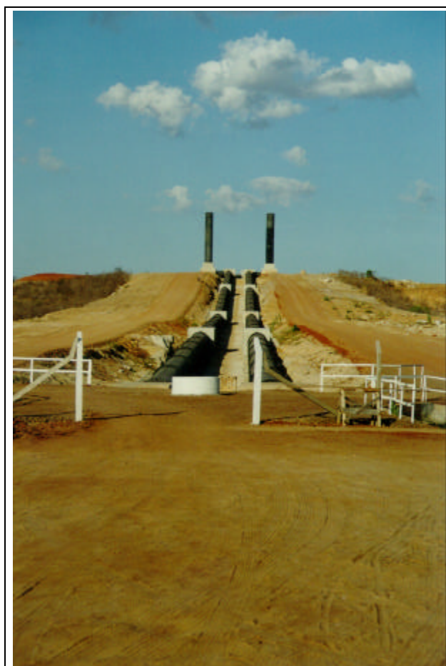
Foto 30/51 - Tubulações de recalque que irão transportar as vazões captadas pela estação de bombeamento do Projeto Tabuleiros de Russas para o Açude Curral Velho.
