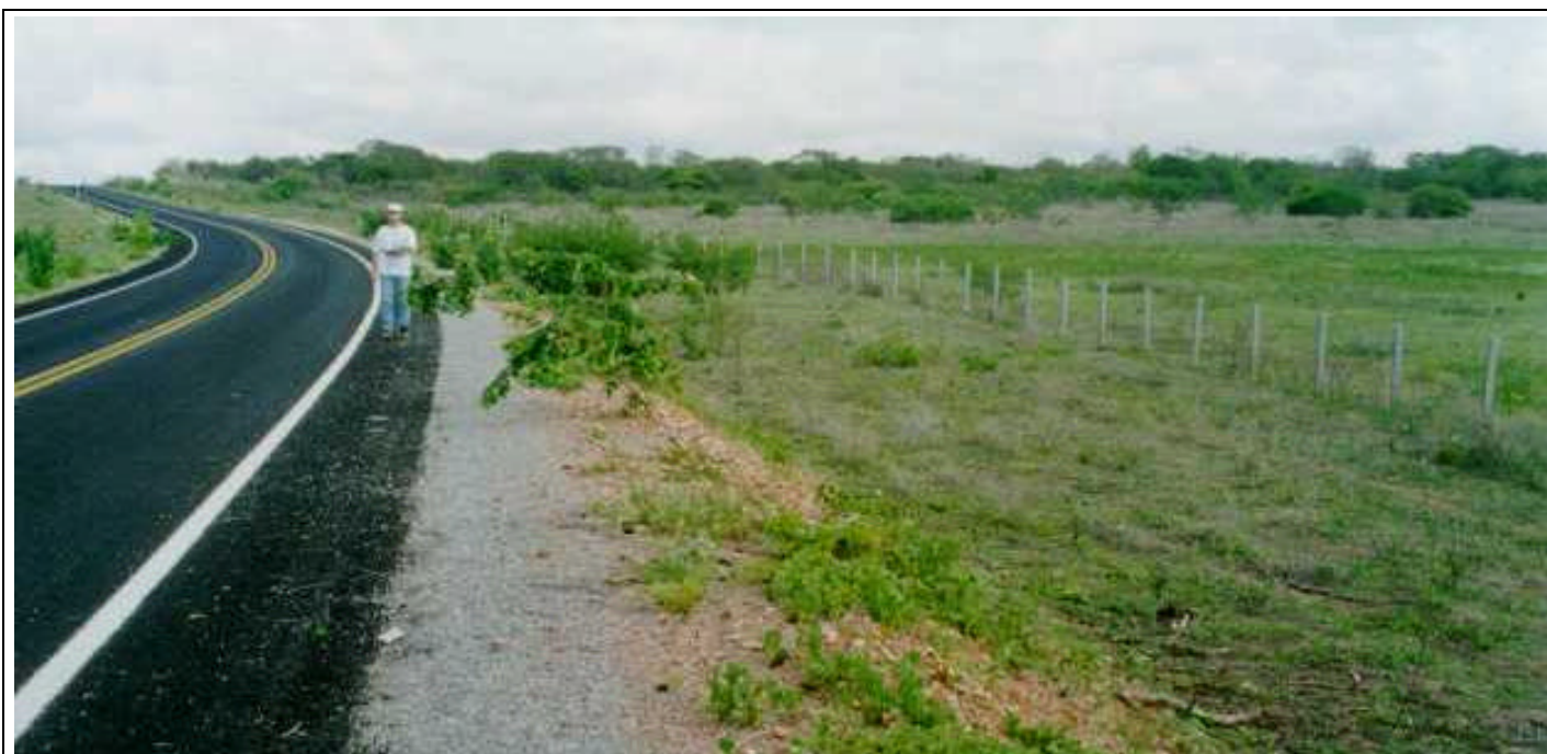
Foto 12/51 - Trecho 1 (Castanhão/Curral Velho): local onde o sistema adutor intercepta a alça de contorno da cidade de Jaguaribara (CE-269).
