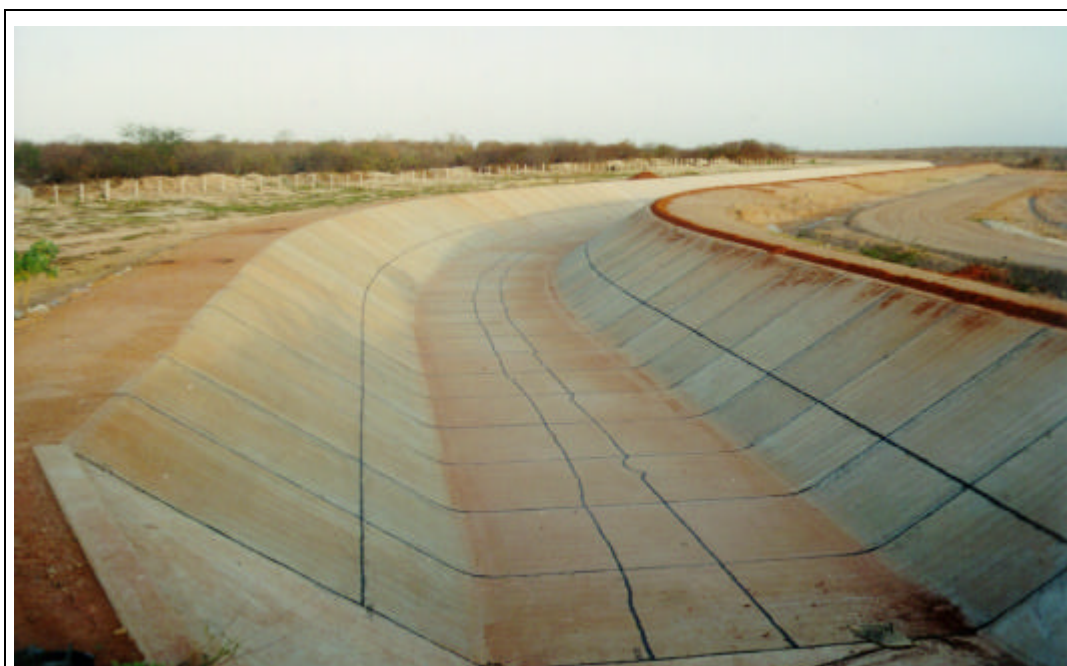
Foto 31/51 - Projeto Tabuleiros de Russas: trecho do canal que irá aduzir as vazões recalçadas até o Açude Curral Velho.
