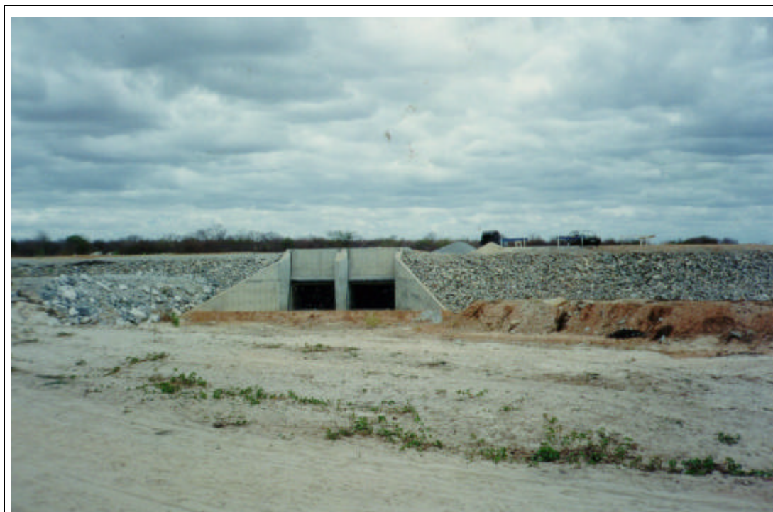
Foto 33/51 - Vista parcial do barramento do Açude Curral Velho, mostrando à esquerda da foto, a tomada d'água do canal principal do Projeto Tabuleiros de Russas.
