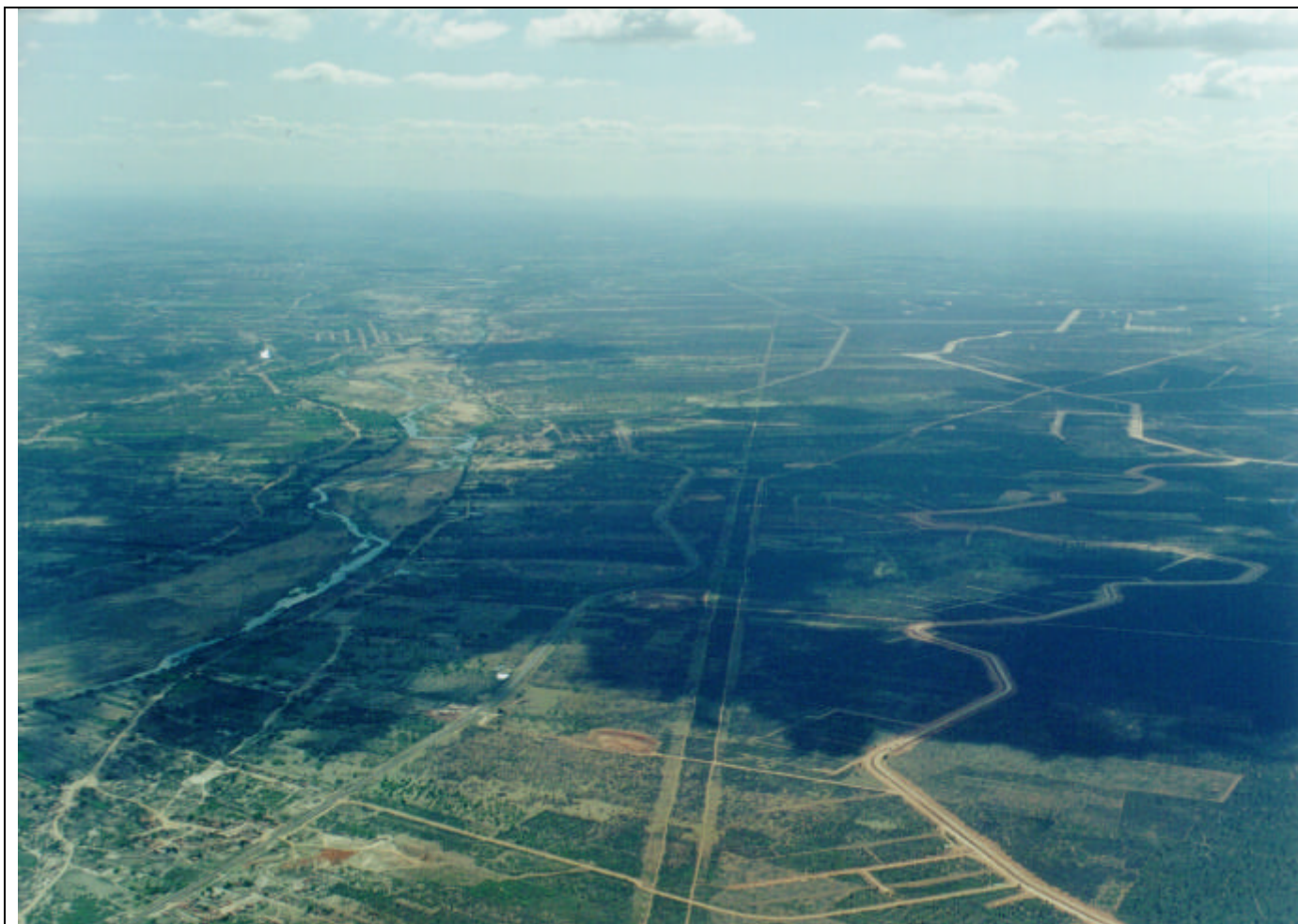
Foto 34/51 - Vista aérea do vale do rio Jaguaribe (esquerda) e da área do Projeto de Irrigação Tabuleiros de Russas (direita), com implantação da infra-estrutura de uso comum (canal principal) praticamente concluída.
