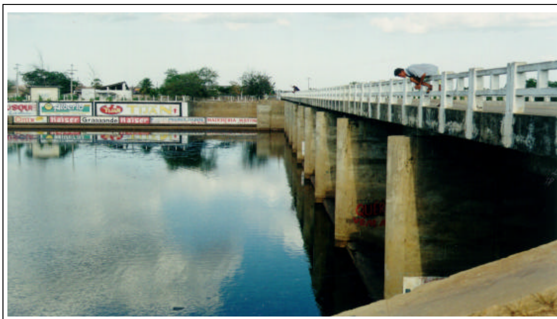
Foto 22/51 - Barragem de derivação no rio Banabuiú sob a ponte da CE-371. Junto à margem esquerda (ao fundo) situa-se a tomada d'água do Perímetro Irrigado e do sistema de abastecimento d'água da cidade de Morada Nova. No reservatório dessa barragem, cerca de 280 m a montante, foi construída a tomada d'água do Projeto de Irrigação Tabuleiros de Russas.
