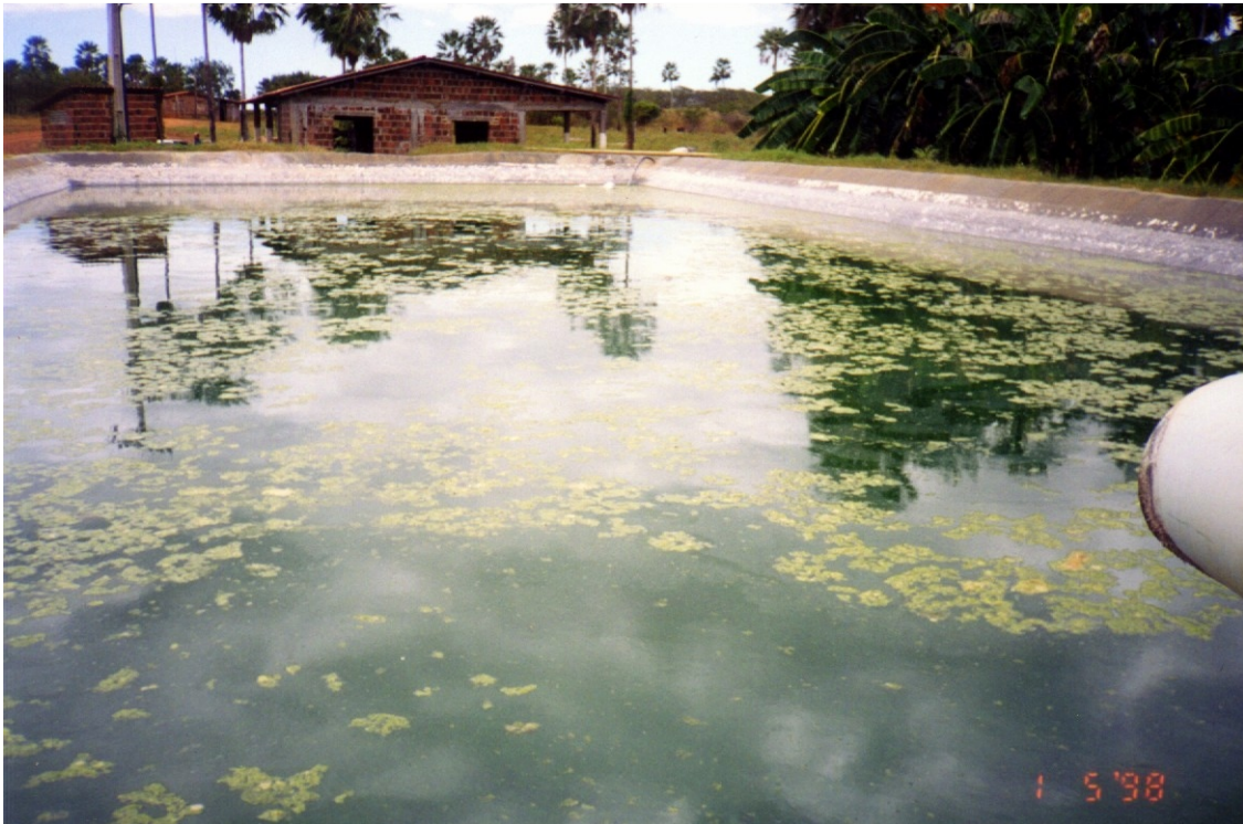
Foto 2.2 - RESERVATÓRIO PARA TRATAMENTO DE ÁGUA NA AGRÍCOLA CAJAZEIRAS
