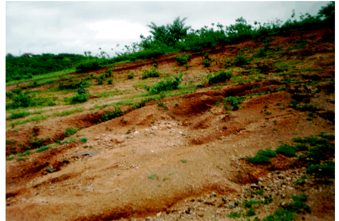
FOTO 04: Açude Fronteiras: Detalhe da área do empréstimo E-03, já parcialmente explorada, onde ocorrem solos areno argilosos com cascalho, que possuem excelentes características geotécnicas.
