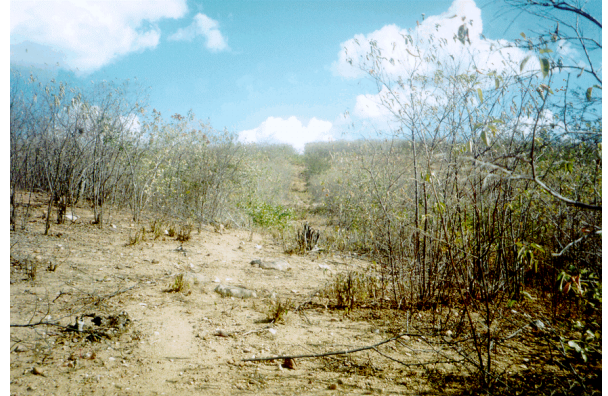
FOTO 02: Açude Fronteiras: Vista do local do sangradouro, junto a ombreira esquerda, onde verificam-se na superfície do terreno pequenos blocos de rocha aflorantes.
