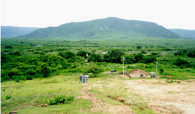
FOTO 01: Açude Fronteiras: Vista geral do eixo locado a partir da ombreira esquerda. Observa-se um pequeno recobrimento de solo na ombreira.
