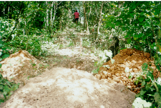
FOTO 03: Açude Jurema: Detalhe do material escavado no furo de sondagem do empréstimo E-1, classificado como areia silto argilosa com pedregulho
