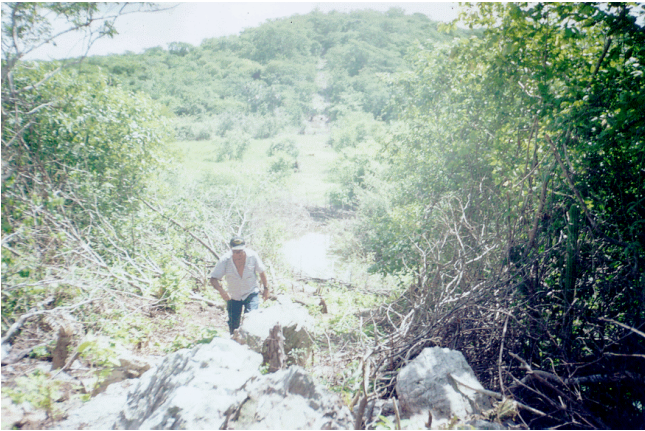
FOTO 01: Açude Jurema: Vista geral do eixo, onde observa-se uma zona aluvionar sem afloramentos e rochas expostas na ombreira esquerda. No fundo a ombreira direita onde os afloramentos rochoso no eixo são mais raros.
