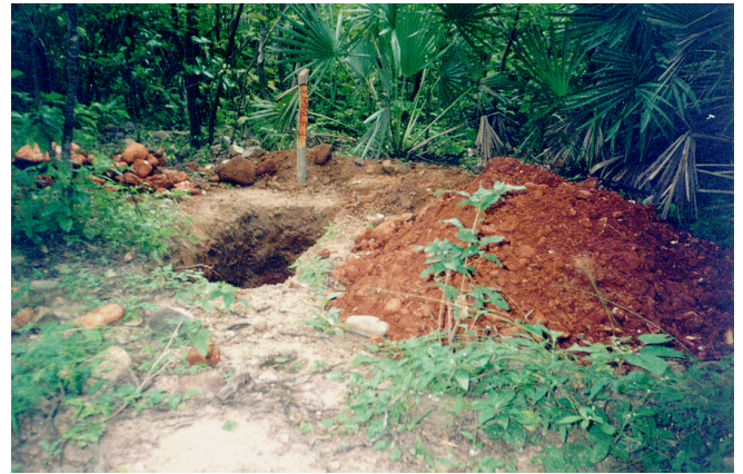
FOTO 02: Açude Ibuguaçu: Foto do furo de sondagem realizado no empréstimo E-2, onde observa-se o solo formado por pedregulho areno argiloso, vermelho.
