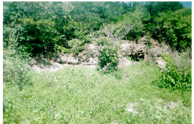
FOTO 04: Açude Lontras: Local escolhido na ombreira direita para funcionar como pedreira, caso as escavações obrigatórias não sejam suficientes para as demandas das obras.
