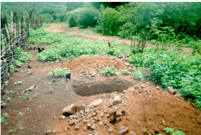
FOTO 05: Açude Lontras: Vista de um poço aberto a pá e picareta na área do empréstimo E-2, onde ocorre um estrato de solo silto argiloso com pedregulho.
