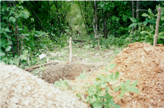
FOTO 01: Açude Ibuguaçu: Foto da sondagem com pá e picareta realizado na área de empréstimo E-1, onde observa-se o material pedregulhoso areno siltoso.
