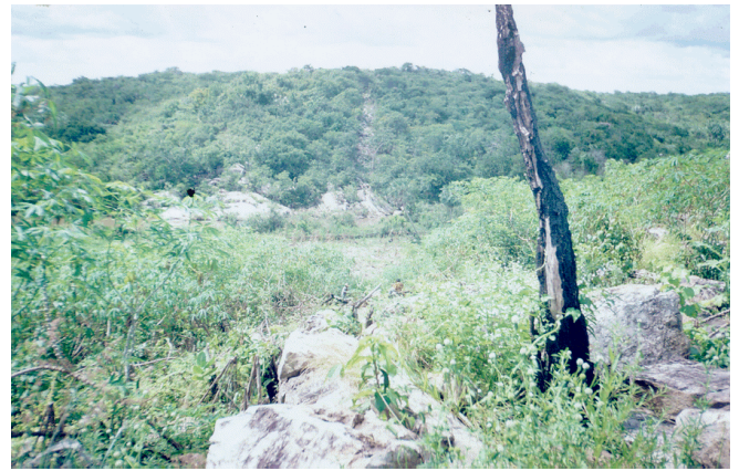
FOTO 02: Açude Cajueirinho: Vista geral do eixo locado, onde observa-se a continuidade dos afloramentos rochosos em toda a sua extensão.
