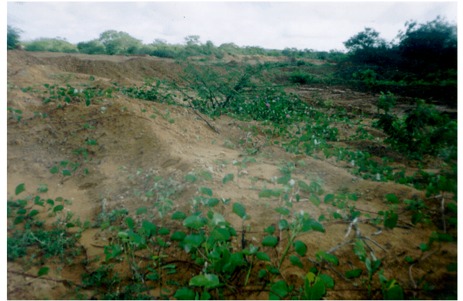
FOTO 02: Açu de Inhuçu: Vista da área já explorada da caixa de empréstimo E-01, indicada para a construção do maciço.
