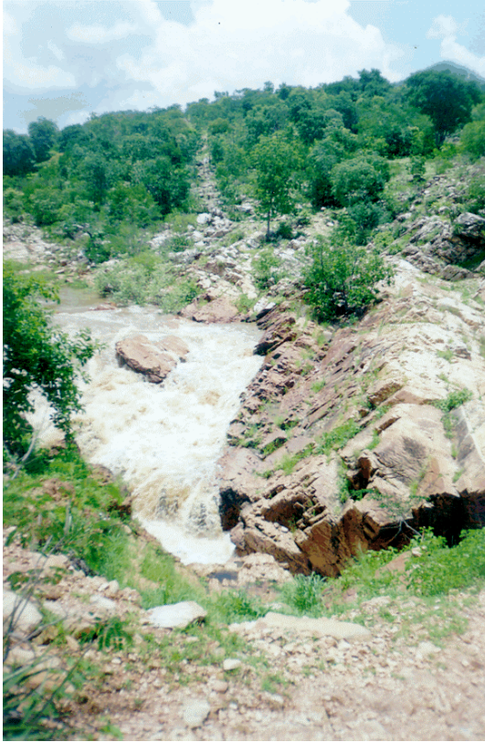
FOTO 01: Açude Paula Pessoa: Detalhe dos afloramentos na calha do rio Itacolomi e, no fundo, a ombreira direita desprovida de solo de cobertura.
