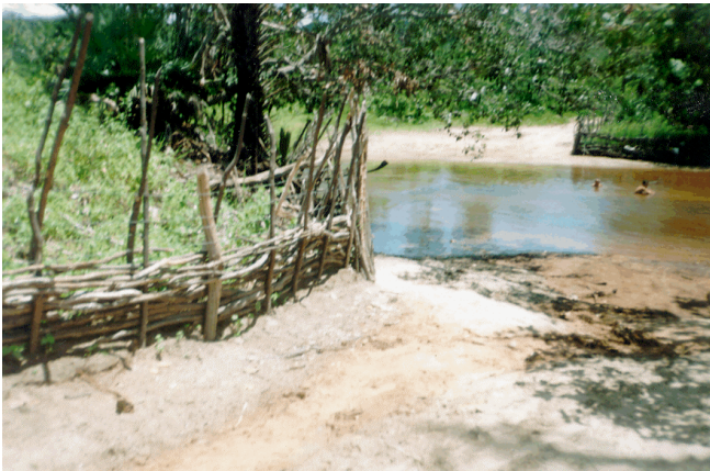
FOTO 03: Açude Lontras: Rio Inhuçu no local do eixo do barramento, com bancos de areia delgados sobrepostos à rocha de fundação.
