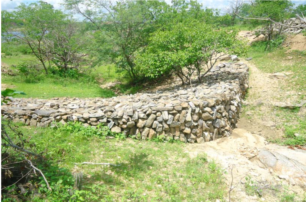
Figura-2- Barragens sucessiva de pedras
