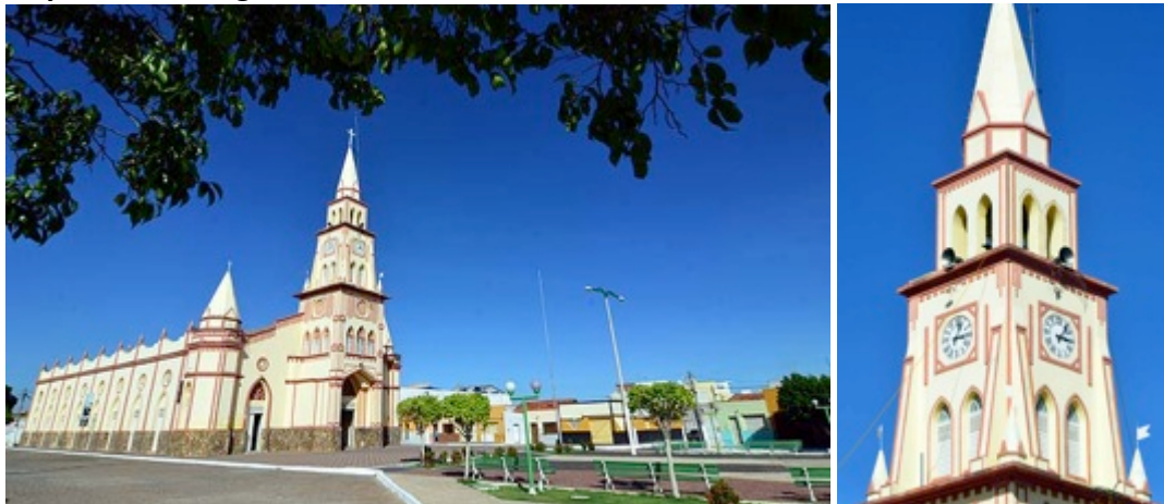
Figure 64: A Igreja Matriz está erguida no centro de uma grande praça, de onde se originou a cidade.
