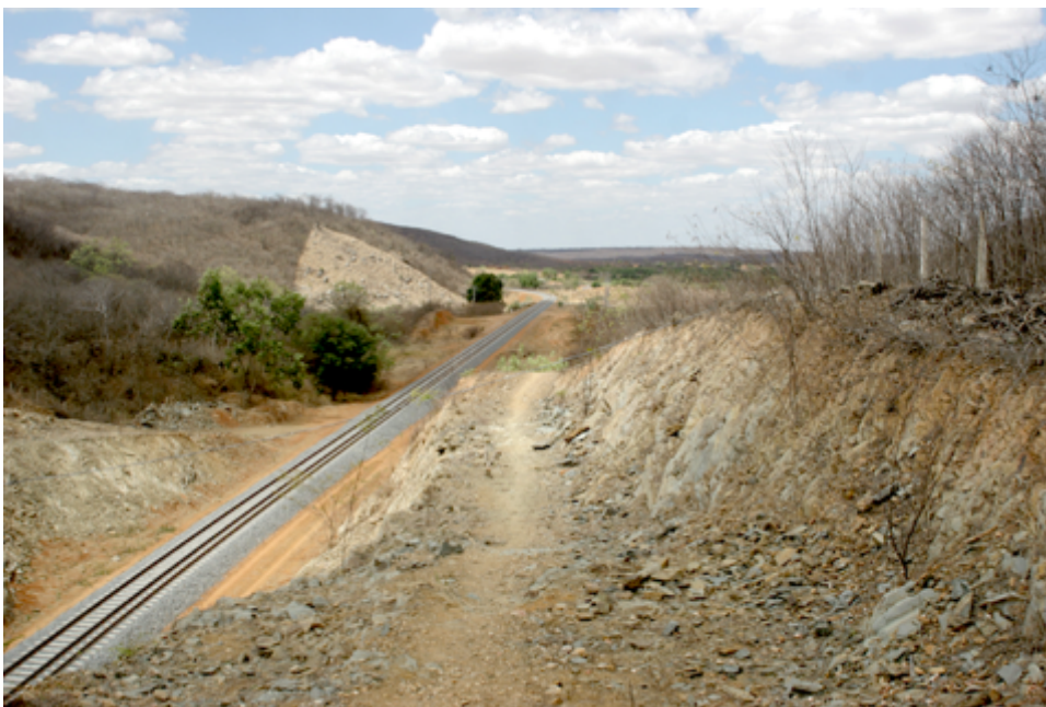
Figure 84: Ferrovia Transnordestina, Jati,Ce. Ponto 29.
