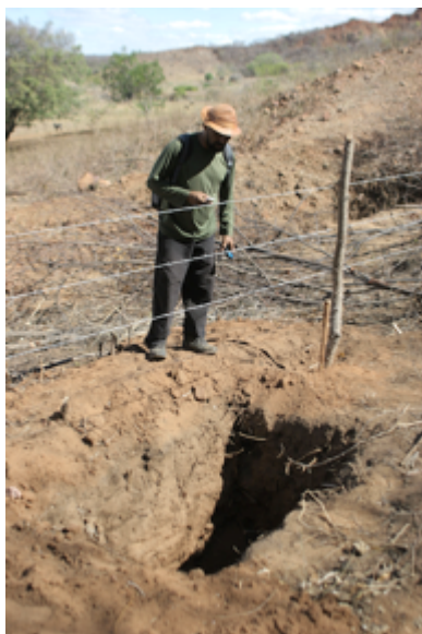
Figure 94: Sondagem de Solo de da VBA.
