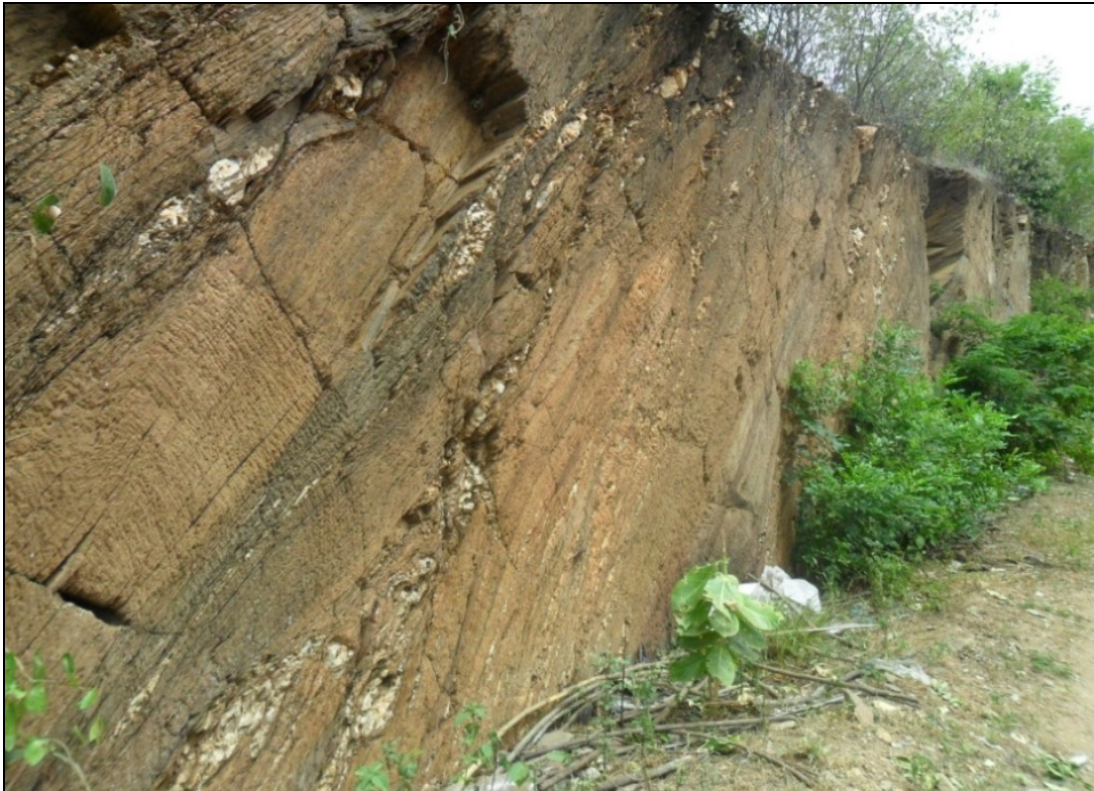
Foto 1 - Corte em micaxisto e filito situado próximo ao estaqueamento 1+200
