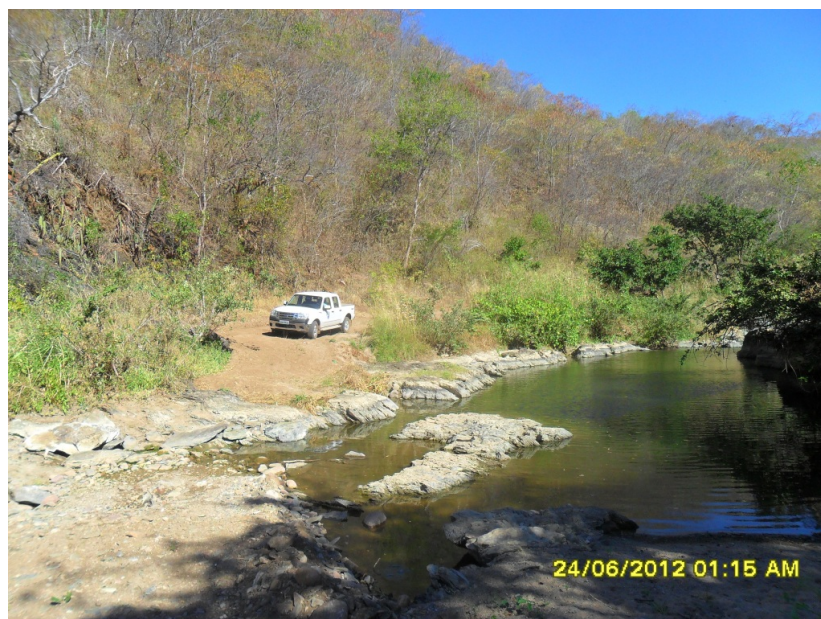
Foto 21 – Afloramento de rocha sã no fundo do rio Cariús
