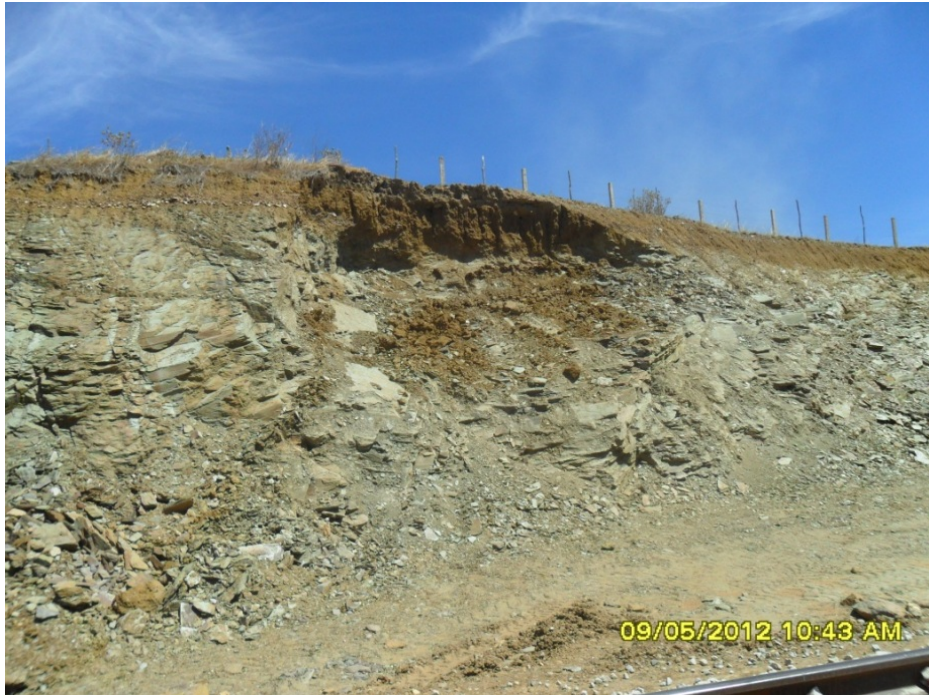
Foto 3 - Escorregamento de solo residual e rocha extremadamente alterada na Transnordestina
