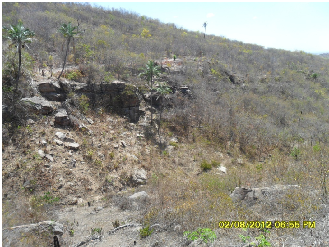
Foto 12 – Encosta de muita inclinação próxima na estaca 16+500
