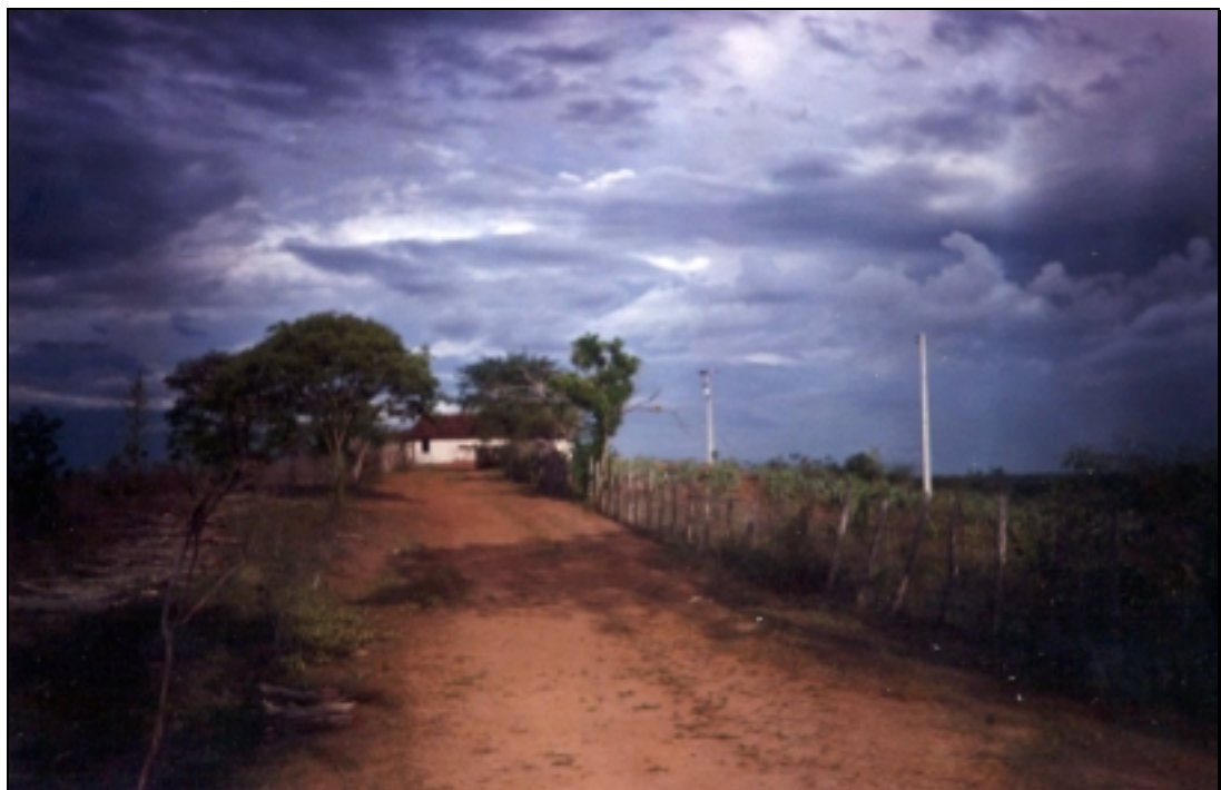
Foto 08 - Açude Treme - Identificação de Rede Trifásica no Local do Eixo 2 (A Rede Vem do Eixo 1).
