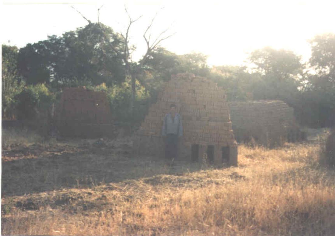
FOTO 14/17 - Área de inundação: olaria.
