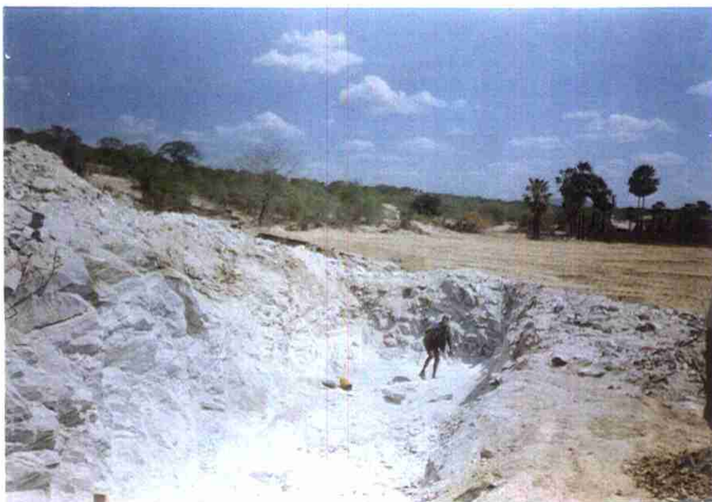
Escavação da galeria de tomada d'água montante.
