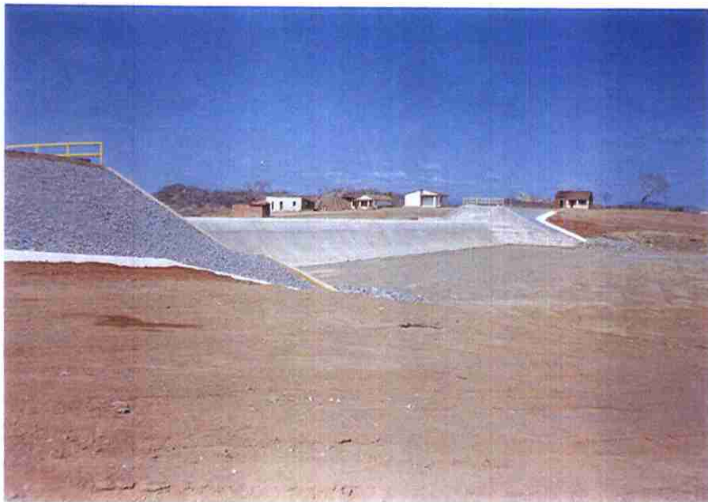
Vista do "PERFIL CREAGER" do Sangradouro Jusante.
