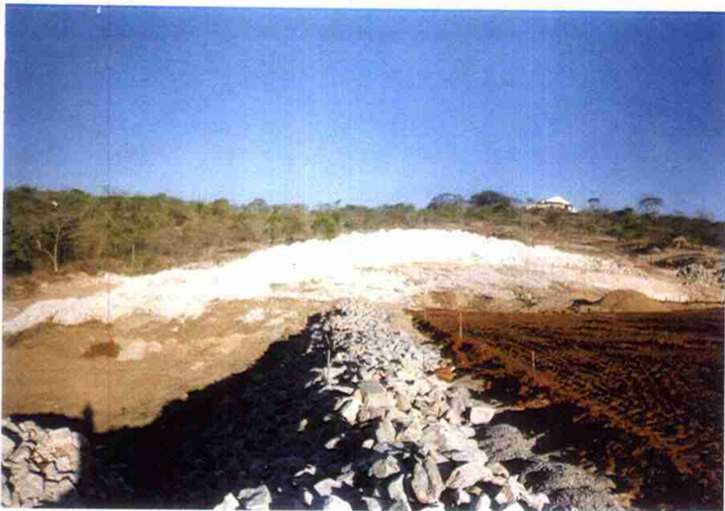
Vista do "Rock-Fill" concluído na calha do rio.
