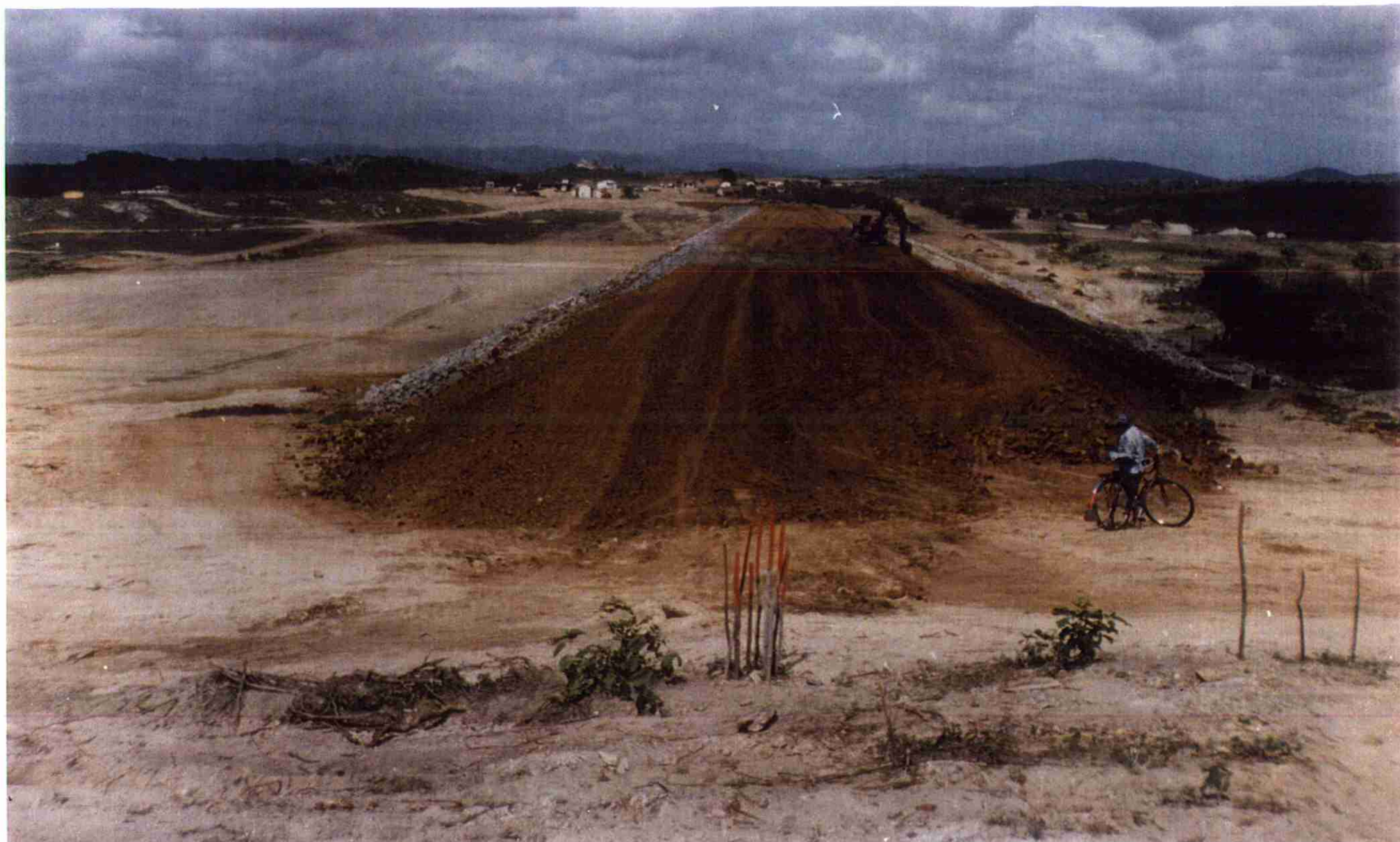
Vista geral do Maciço Sílico Argiloso a partir da estaca 1+0,00 e a esquerda o Tapete Impermeável.
