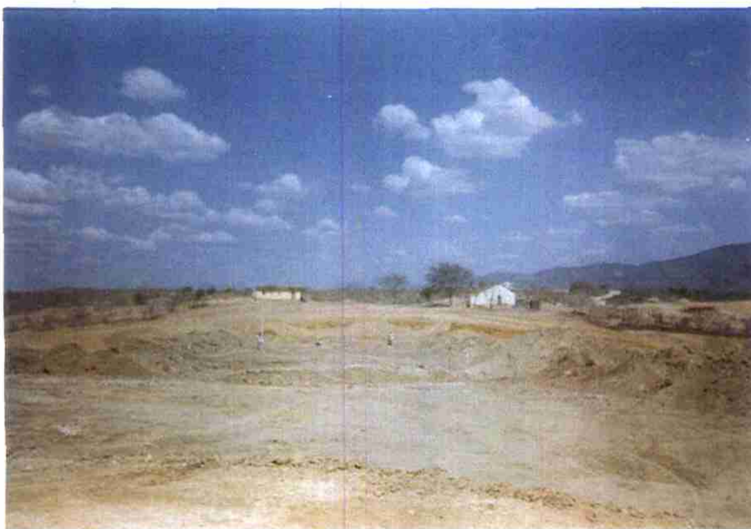
Preparo da fundação em rocha ombreira esquerda
