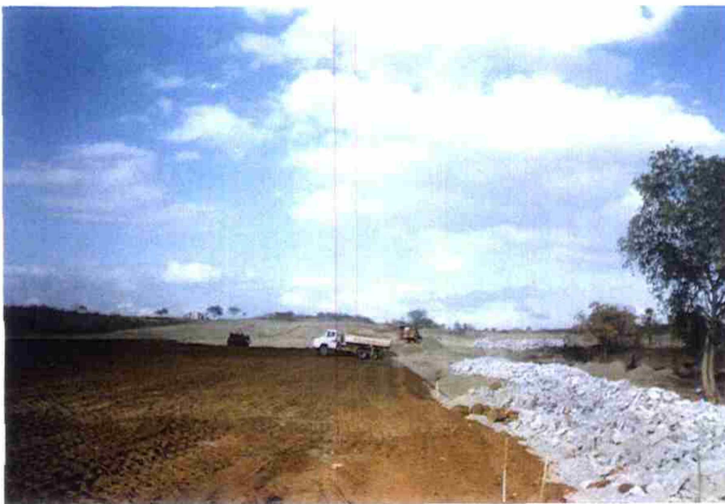
Vista de parte do "Rock-Fill" em continuidade para atingir a cota 155.
