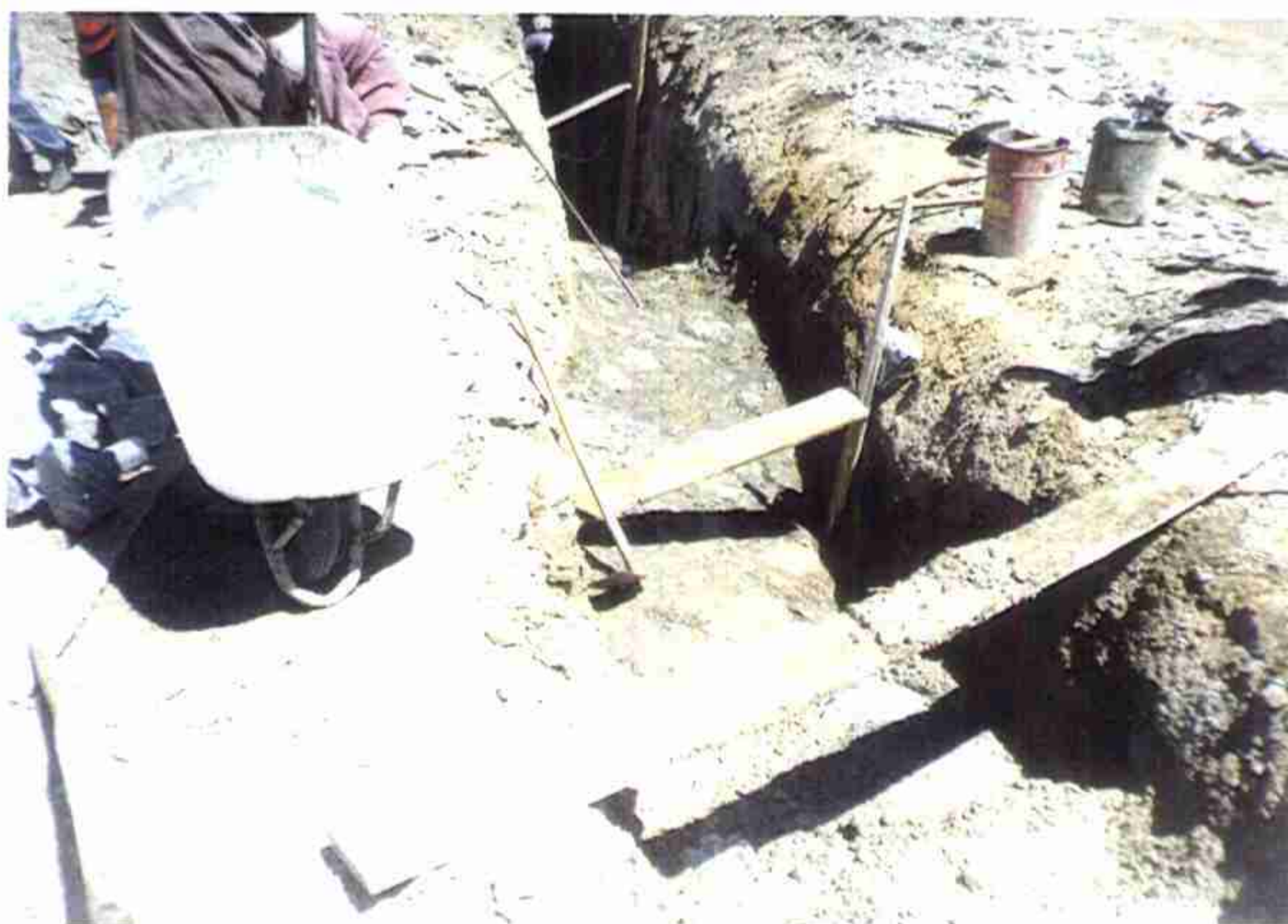
Vista de fase de concretagem do Cordão de Fixação do Sangradouro.
