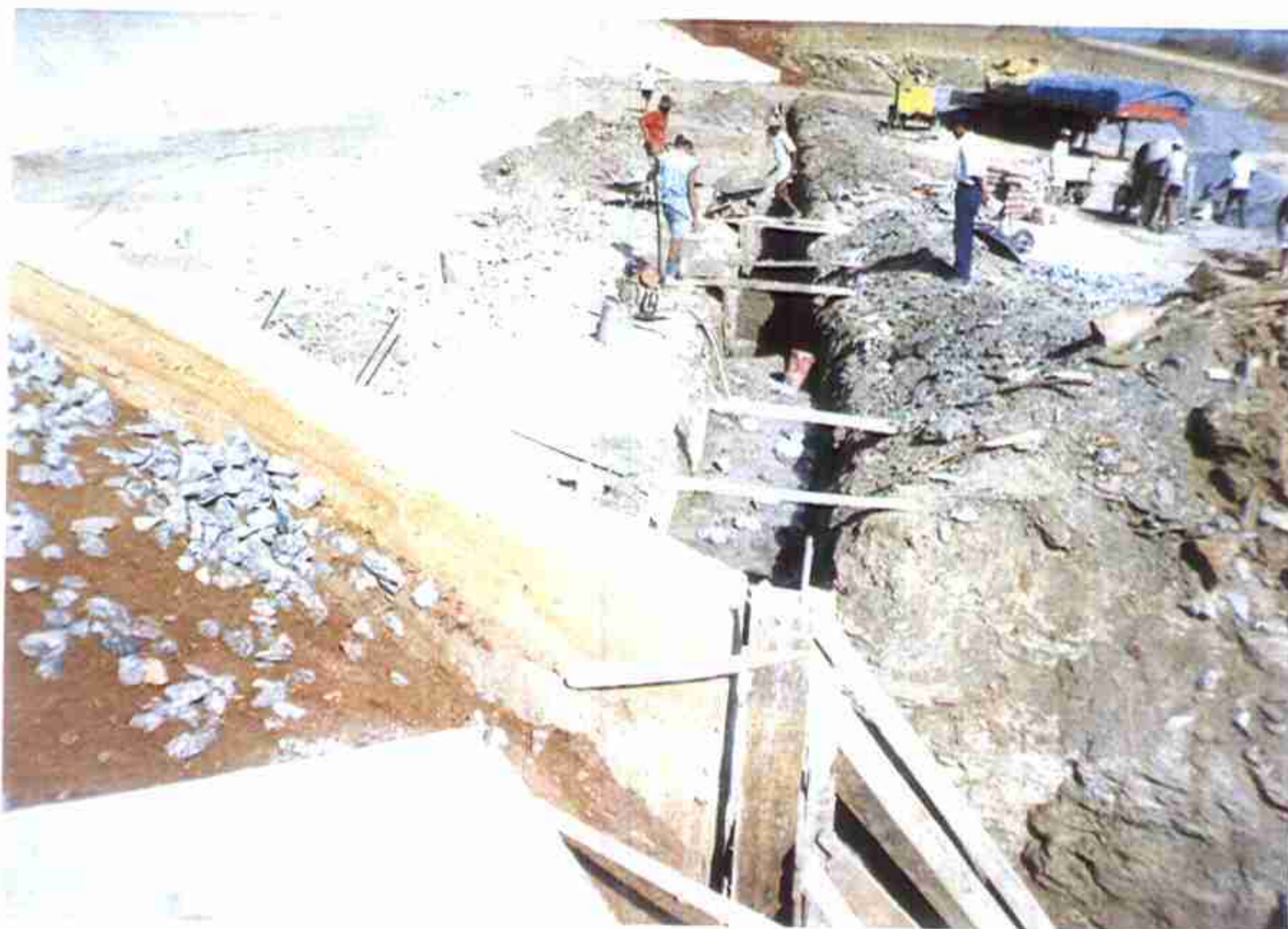
Vista de fase da concretagem do Cordão de Fixação.
