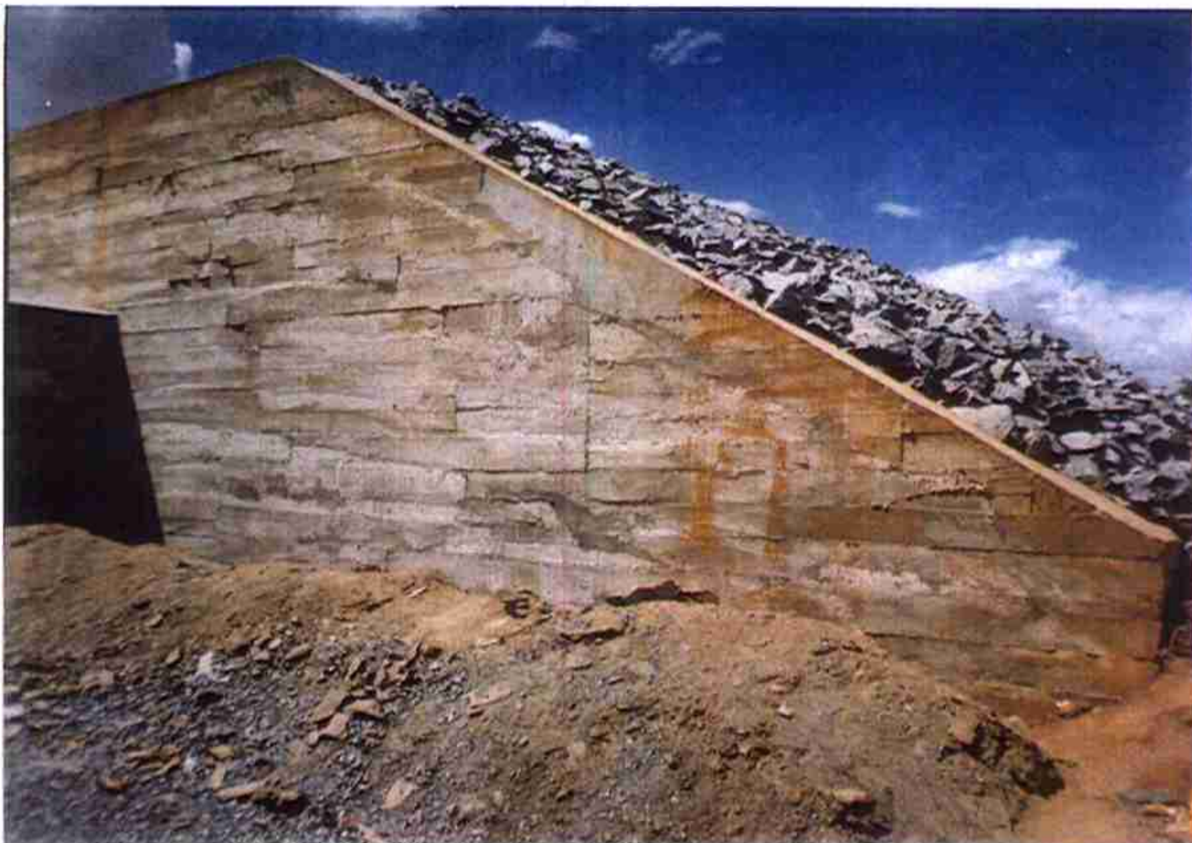
Vista do Muro Direito e RIP-RAP talude Montante.
