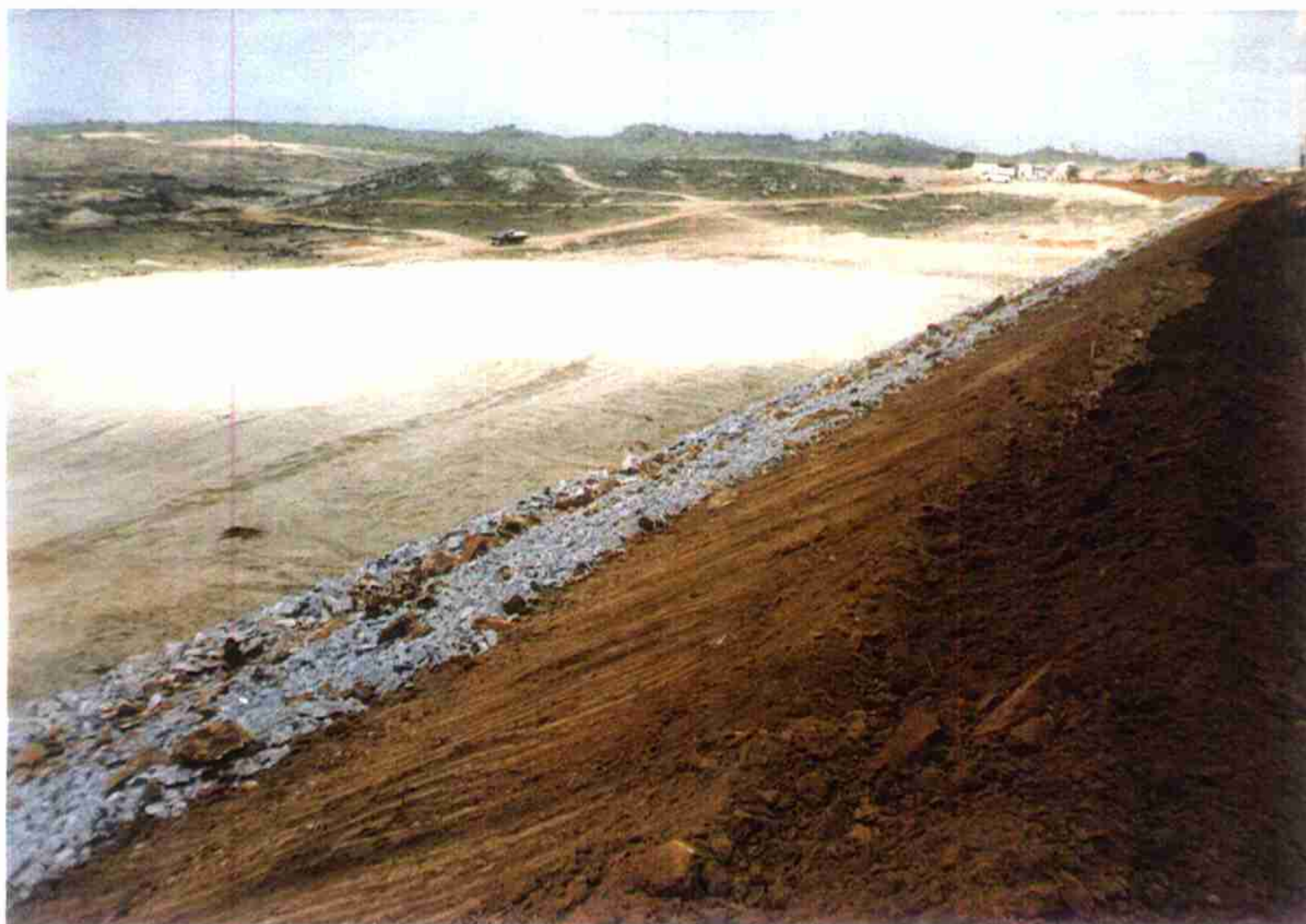
Vista do talude montante do maciço com fase de Rip-Rap concluído, fase só com brita corrida de transição e fase de acabamento de talude.
