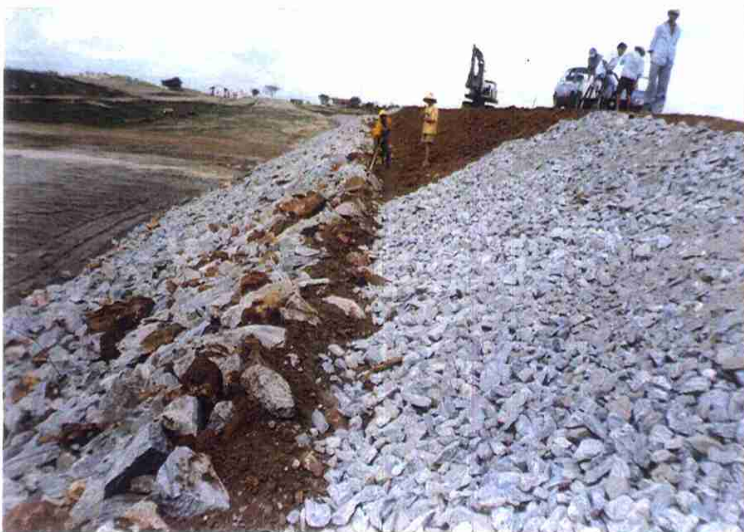
Vista de Rip-Rap talude montante onde se vê área já concluída com camada de rocha e área com camada de transição com brita corrida.
