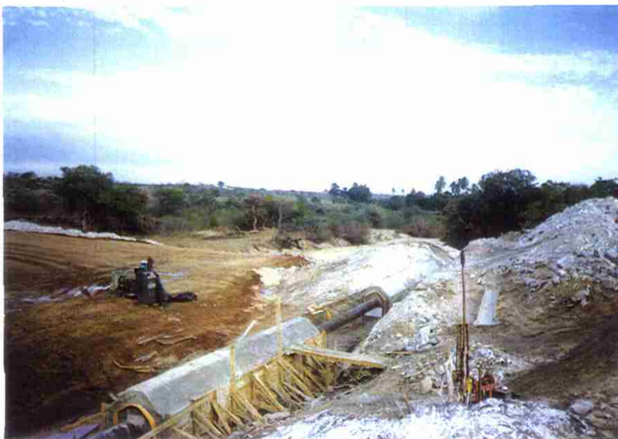
Vista de módulos concretados da galeria de tomada d'água onde se vê detalhe da tubulação de \varnothing = 500\text{mm} .
