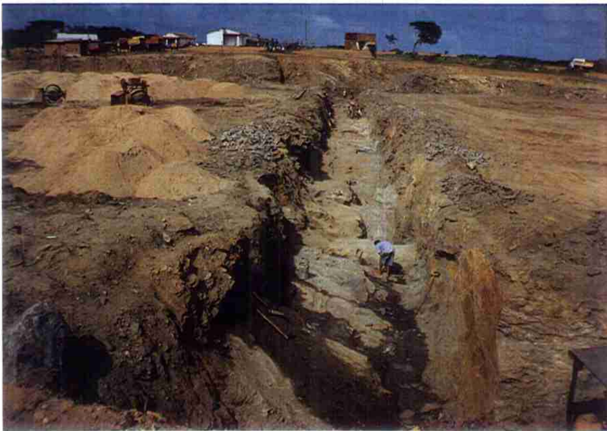
Vista geral da escavação para implantação do PERFIL CREAGER.
