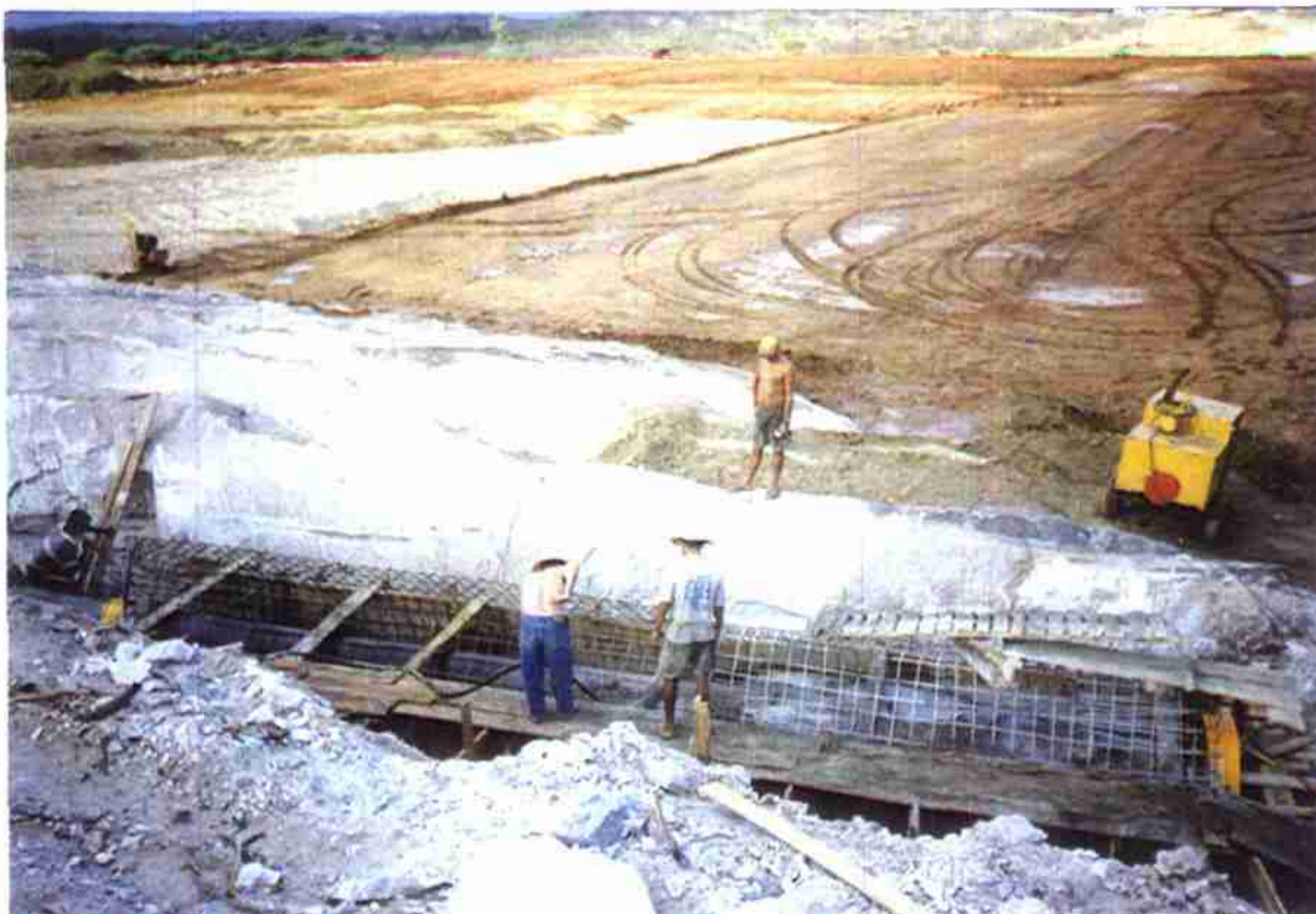
Vista de detalhe de armação, junta Fungeband O-22, concretagem em execução de módulo da galeria de tomada d'água, maciço sílico-argiloso e tapete impermeável a esquerda.
