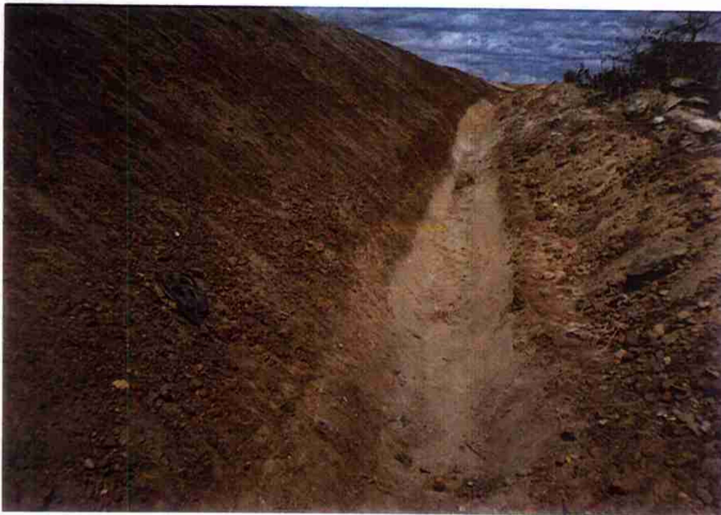
Vista de escavação da Sarjeta de Ombreira Esquerda sub-trecho estaca 26 a 29.
