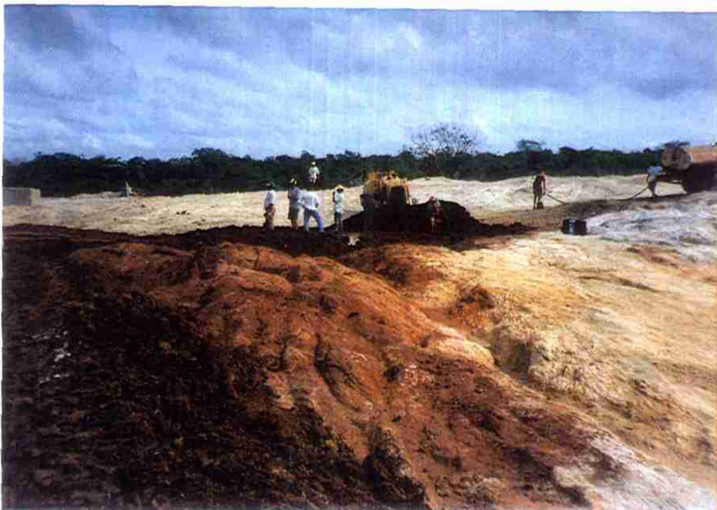
Vista da operação do avanço do maciço sílico argiloso na ombreira direita.
