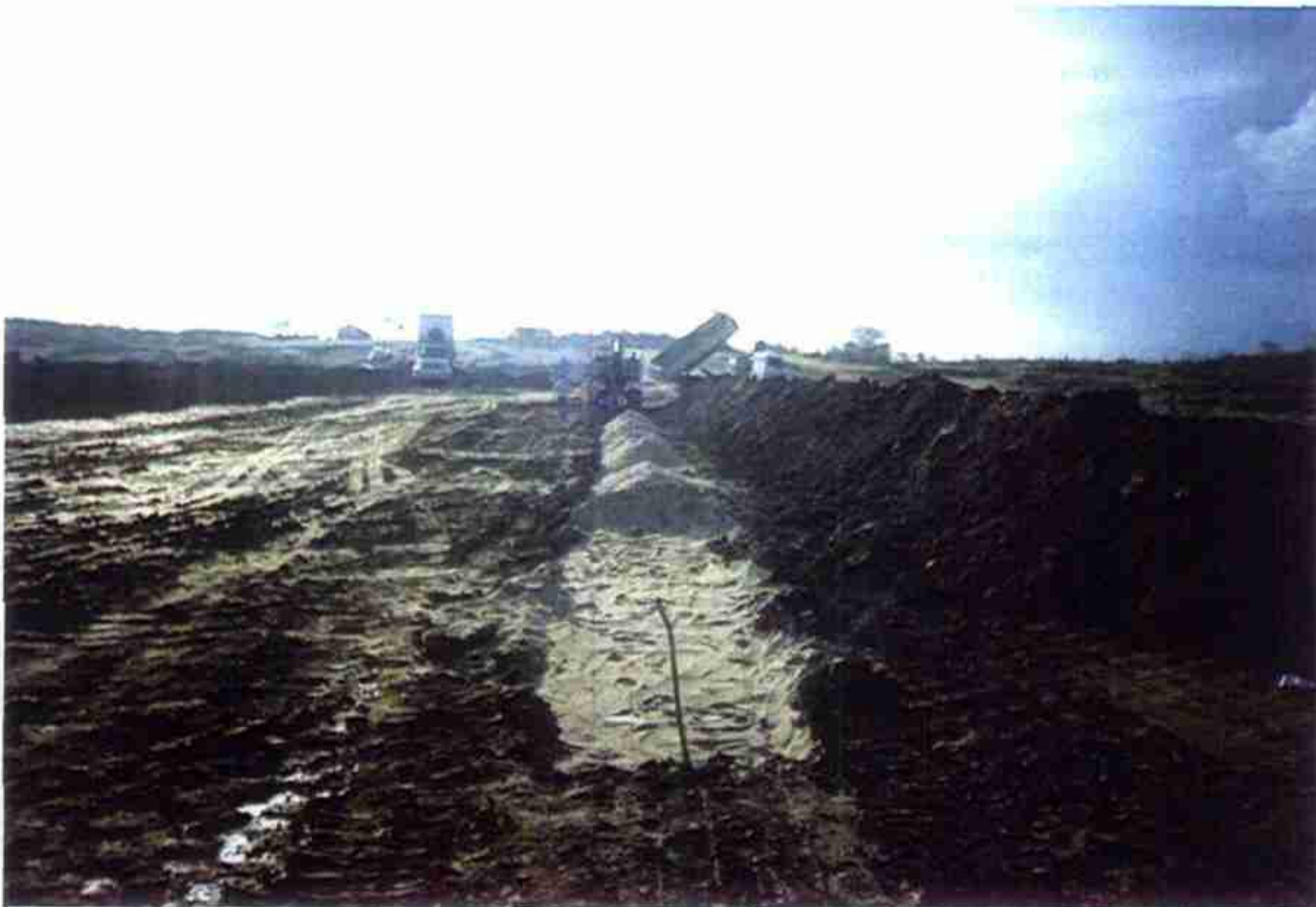
Detalhe da execução do dreno vertical a 3,0m do eixo - jusante
