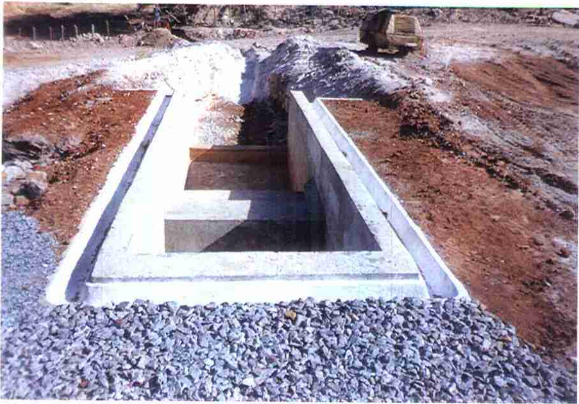
Vista da Caixa de Saída da Galeria de Tomada D'água.
