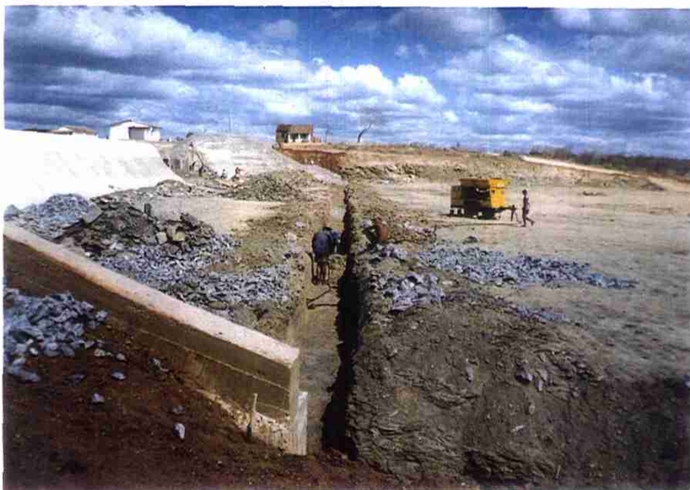
Vista de fase da escavação do Cordão de Fixação ligando as extremidades dos Muros Direito e Esquerdo do Sangradouro.
