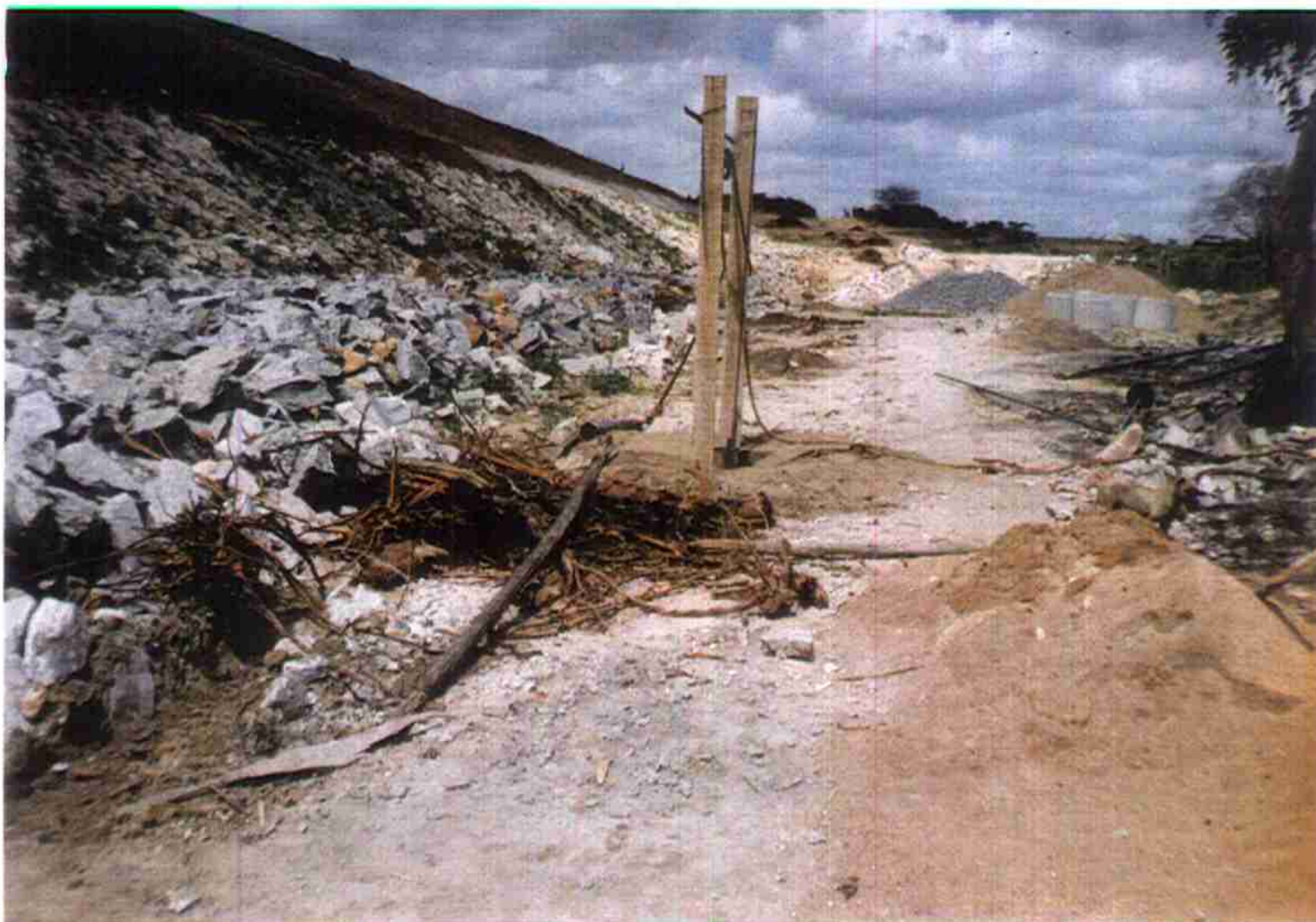
Vista de Poço de Alívio em execução estaca 10+00 a jusante.
