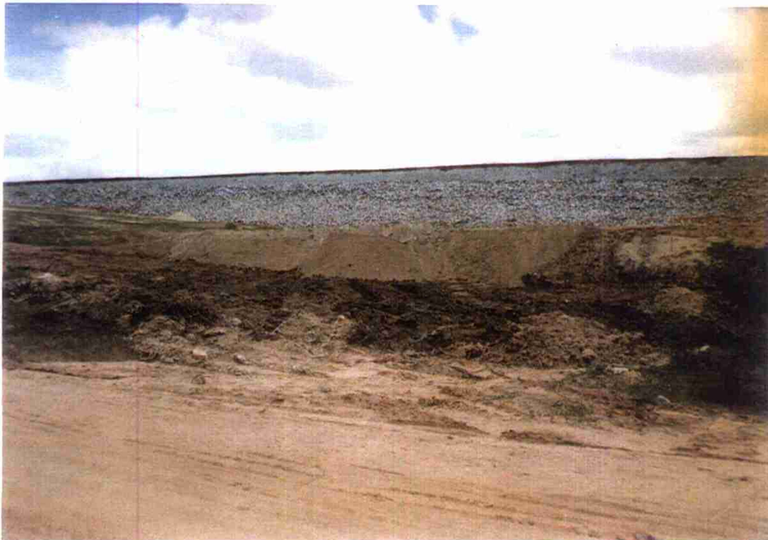
Vista do complemento do Tapete Impermeável estaca 19+6,00m a 20+6,00m e no fundo o Rip-Rap do Talude Montante.
