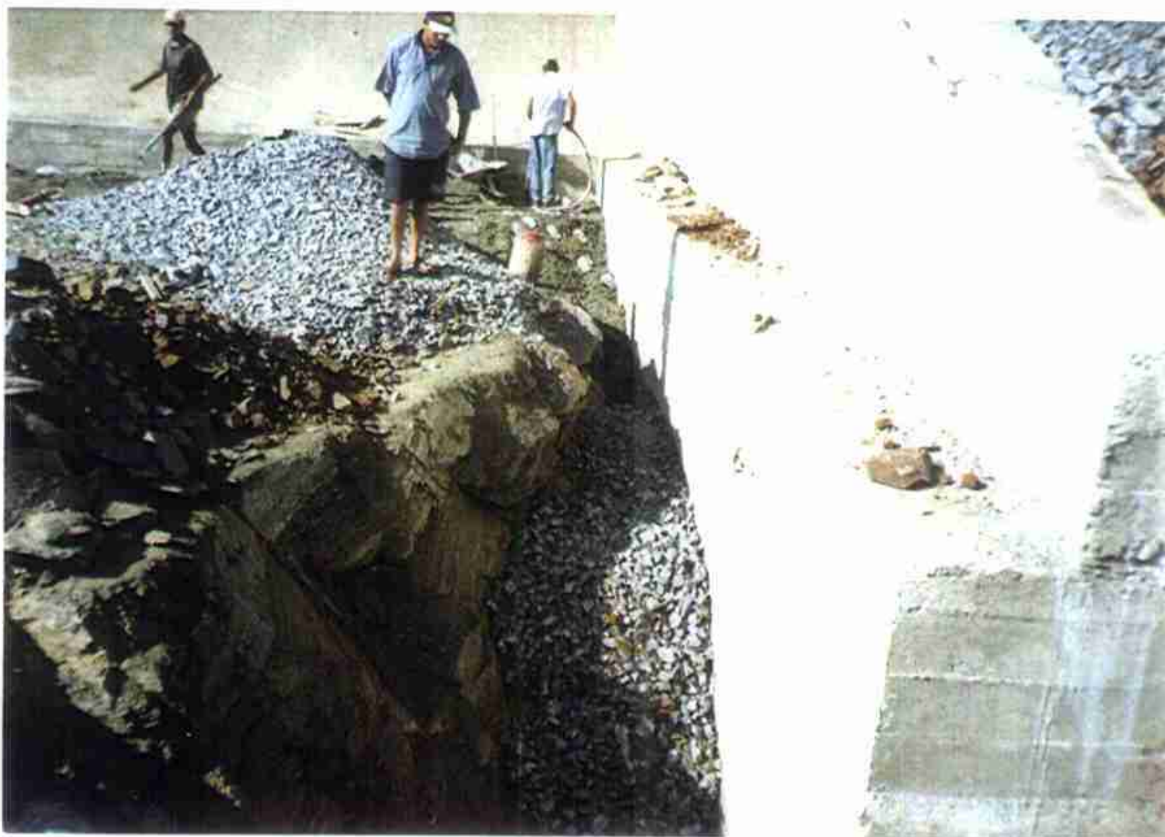
Vista de preenchimento com brita de 1 a 3" no excesso da escavação na jusante do Muro Esquerdo até a cota 157,700m.
