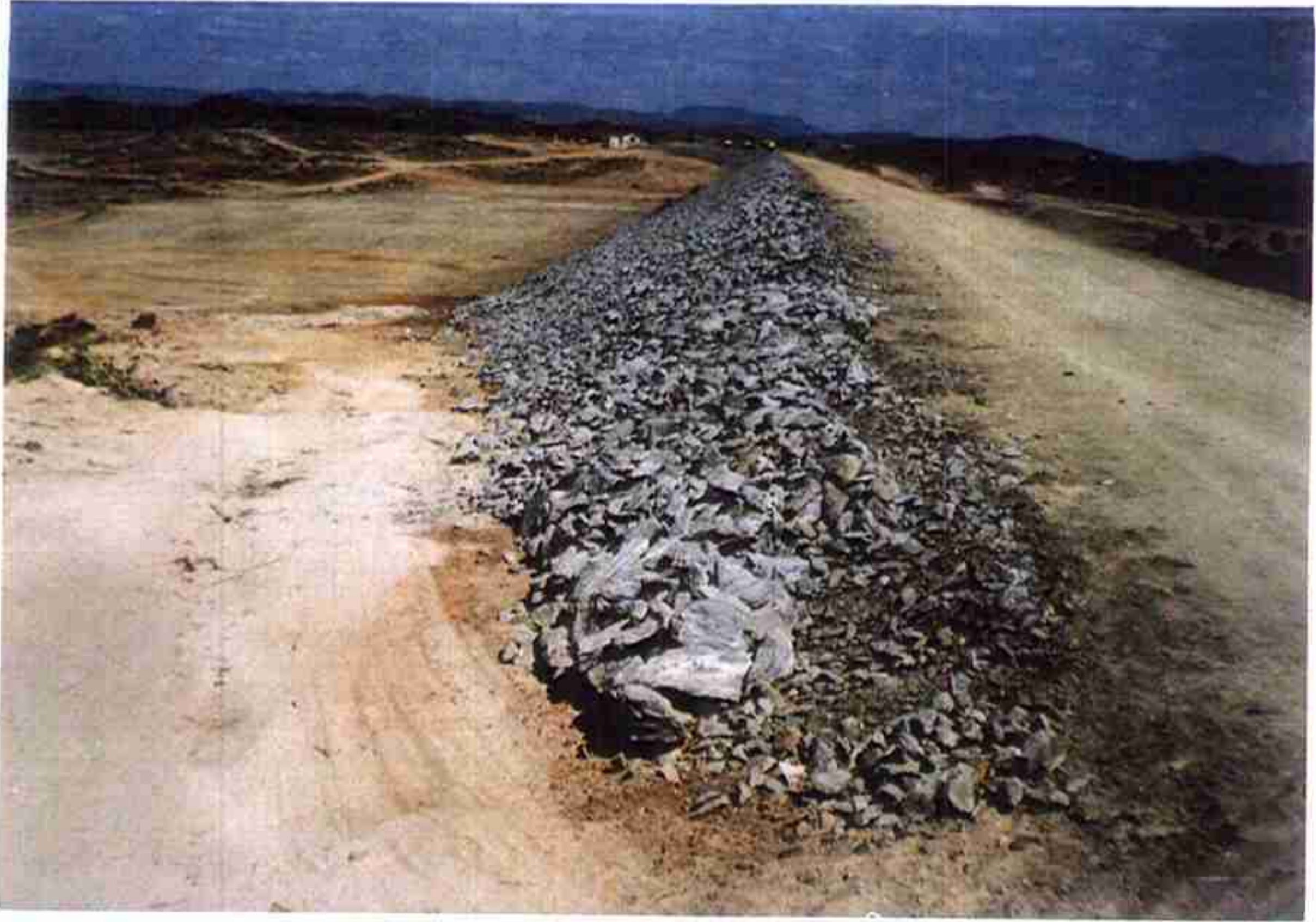
Vista do "Rip-Rap" Talude Montante.
