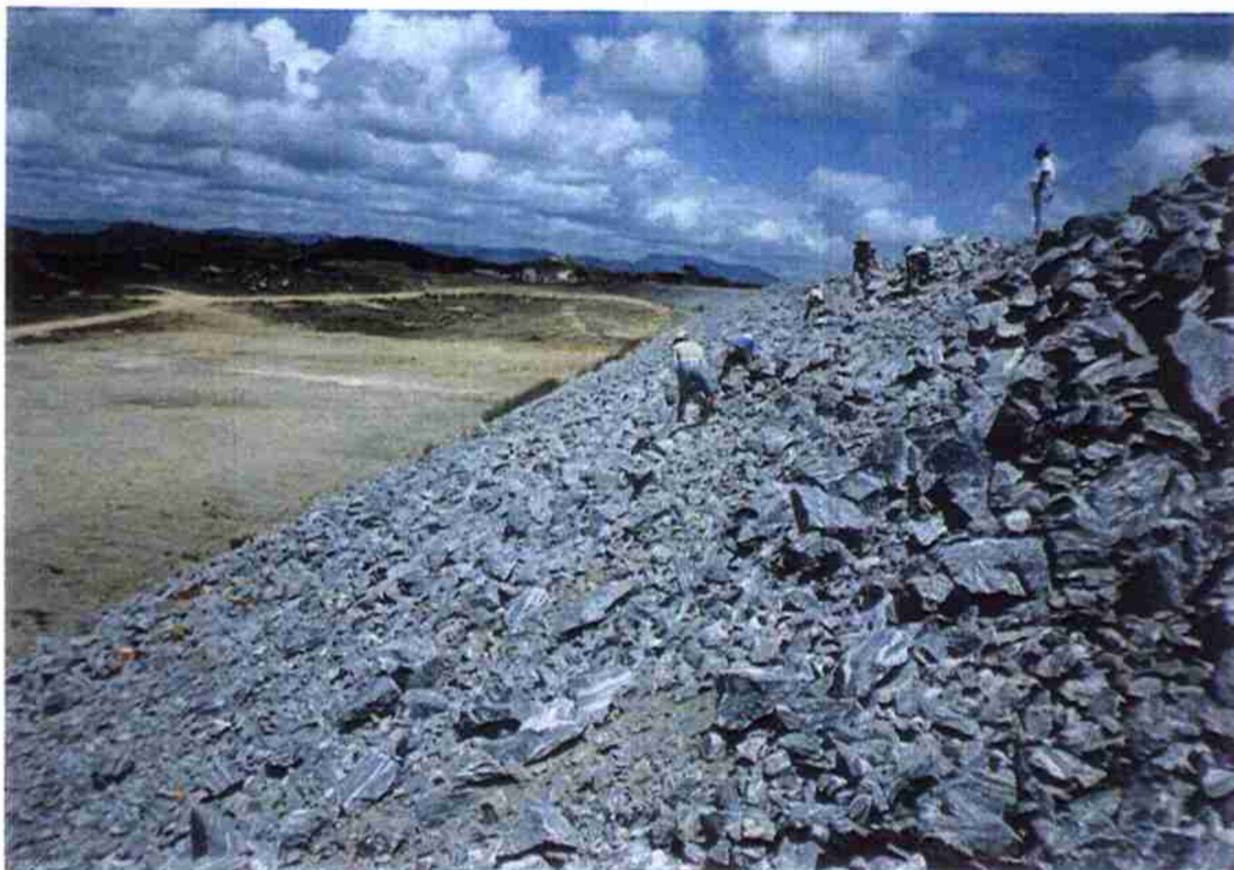
Vista do Talude Montante em fase de execução manual do Rip-Rap.
