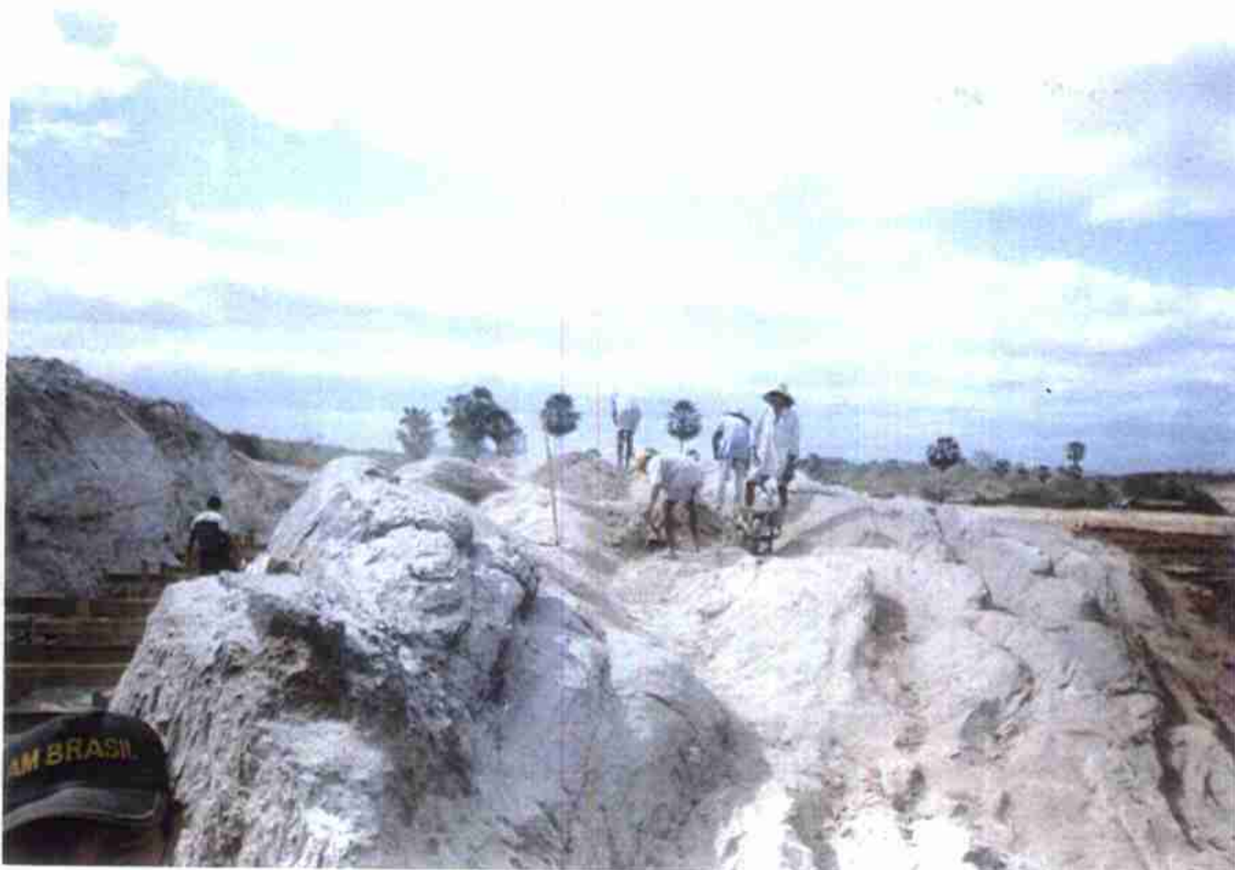
Preparo da fundação em rocha da ombreira direita
