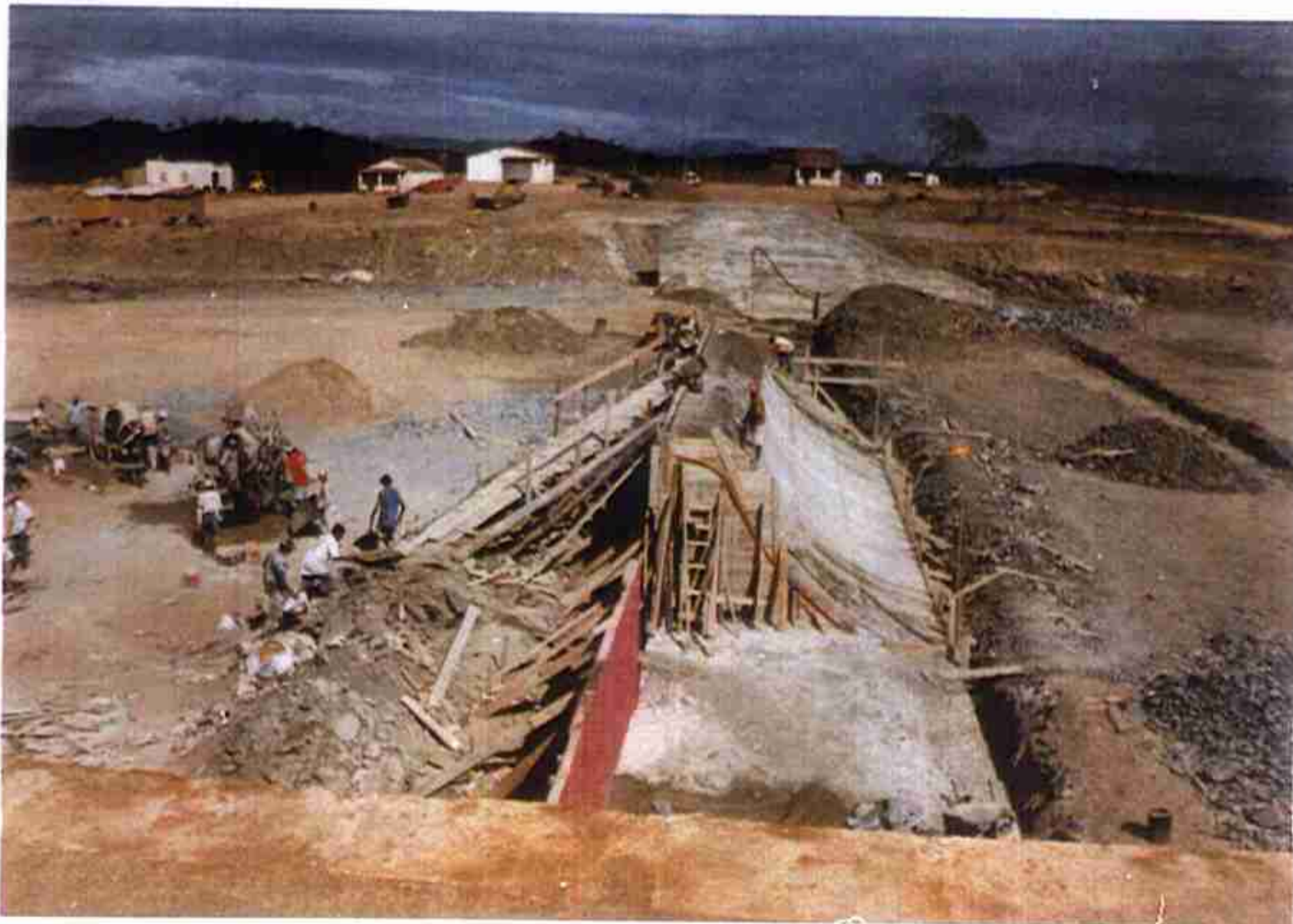
Vista Geral do PERFIL CREAGER do Sangradouro Blocos 1 e 2.
