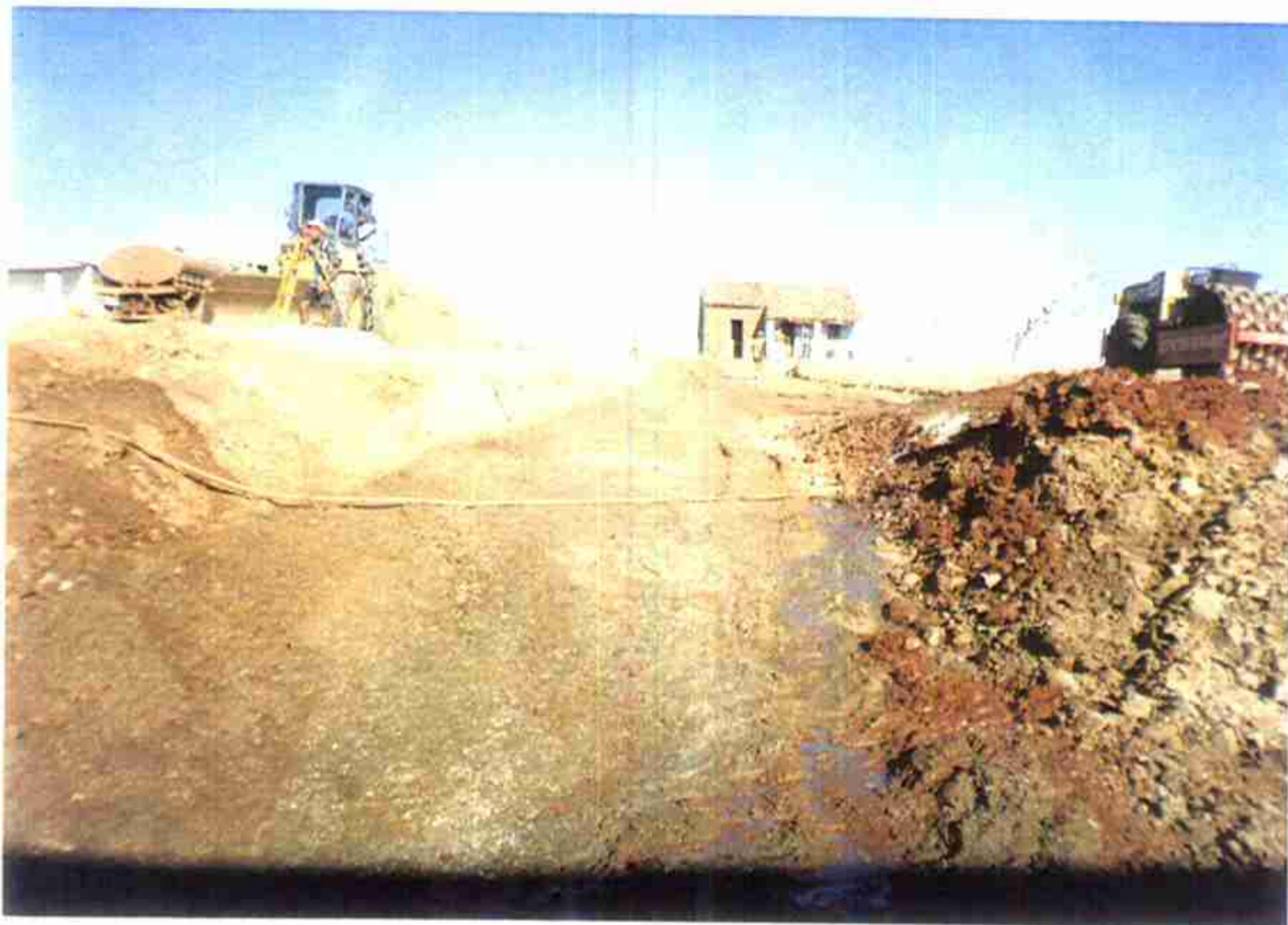
Vista do rebaixamento Montante para encaixe do maciço sílico argiloso estaca 33 a 40+13,00m.
