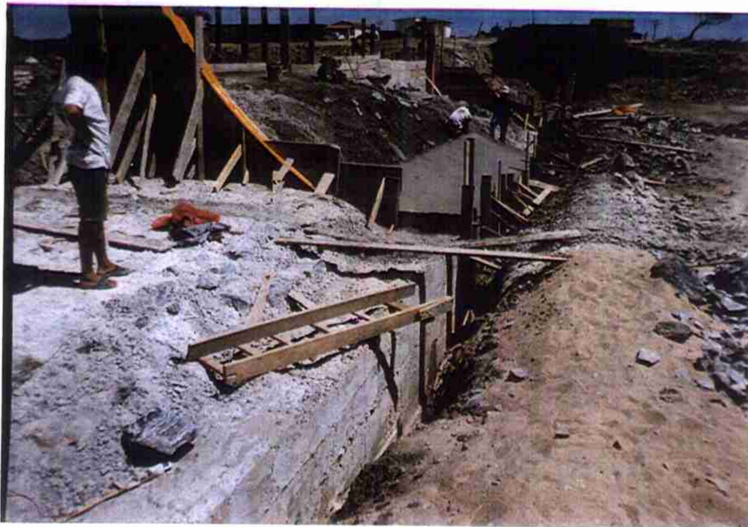
Vista de fase da concretagem do PERFIL CREAGER do Sangradouro a partir da cota 159,000.
