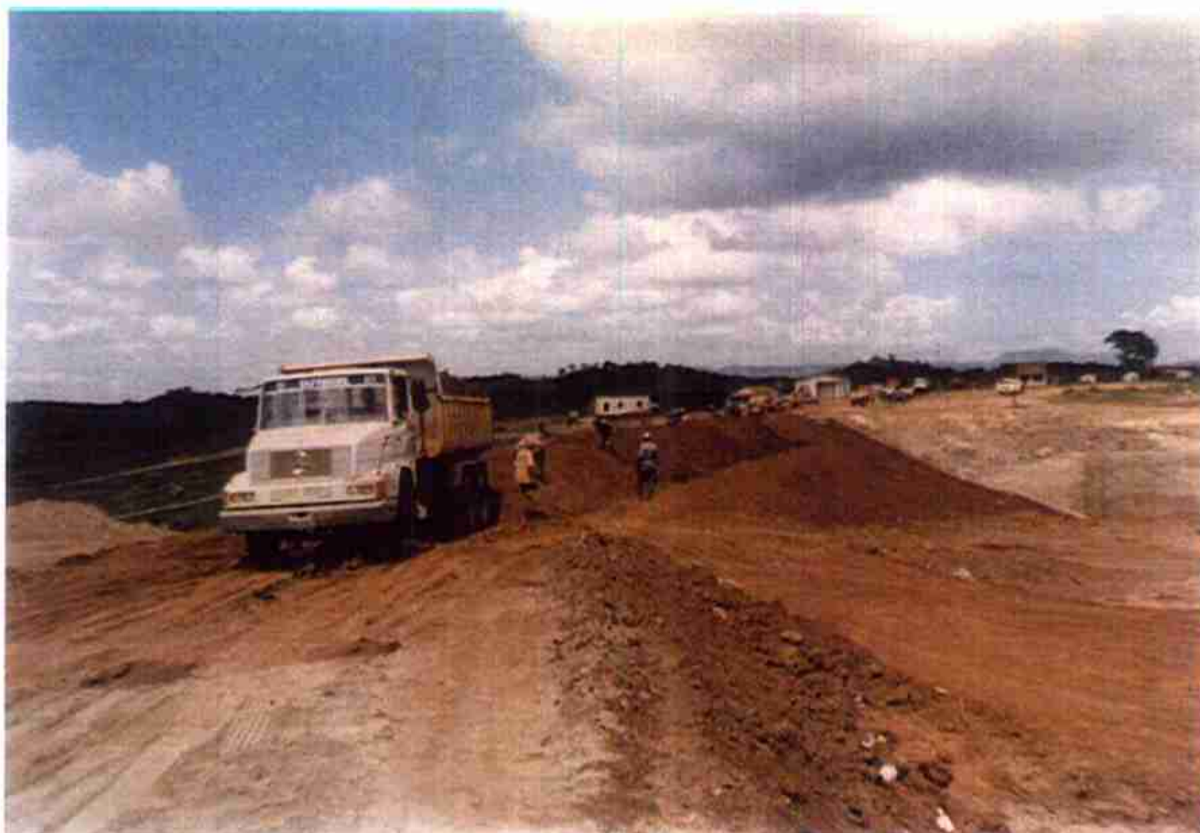
Vista do maciço sílico argiloso em fase de conclusão para atingir a cota 165,100 – estaca 29 a 33.
