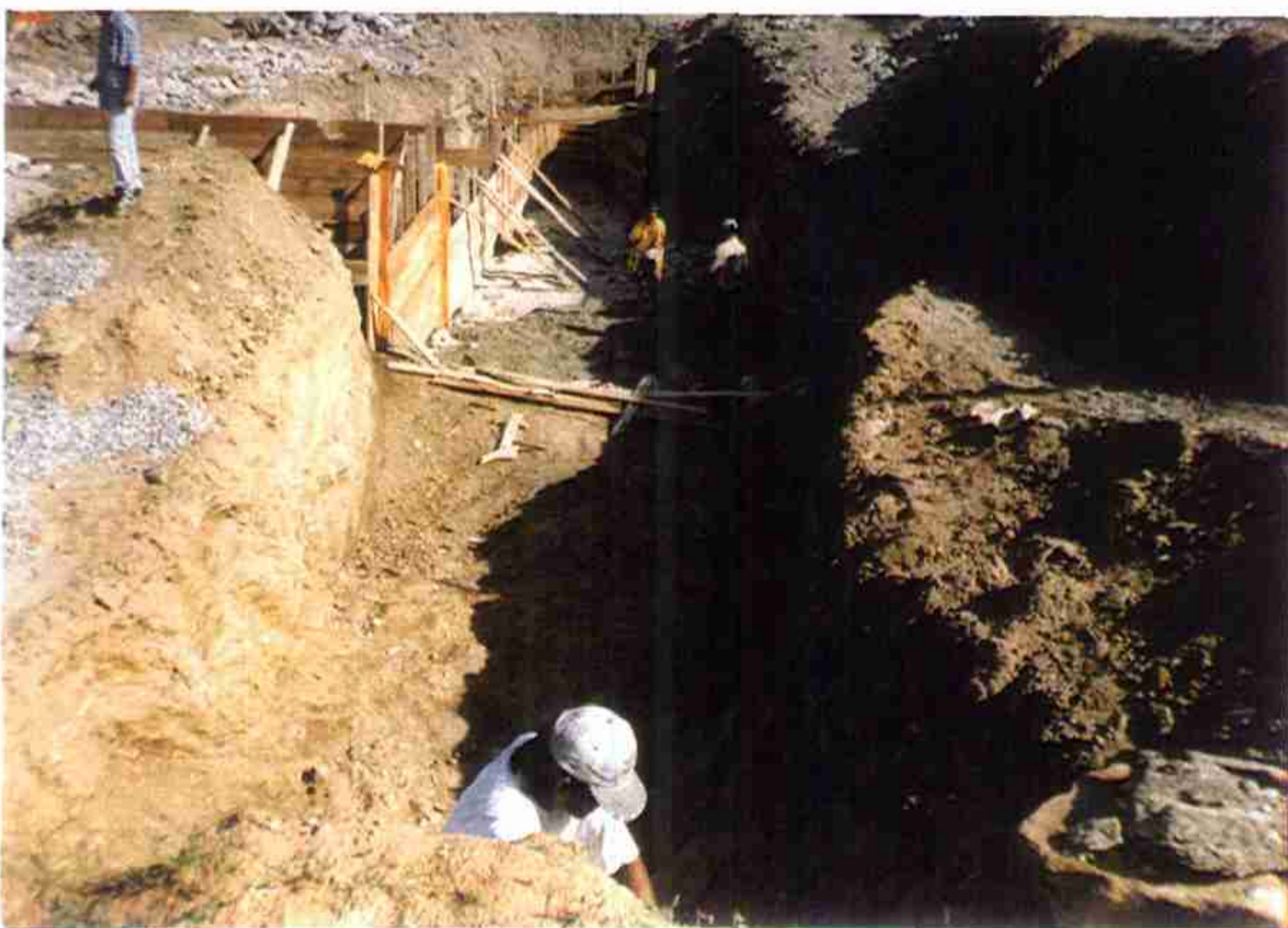
Vista de operação da concretagem do Muro Direito jusante.
