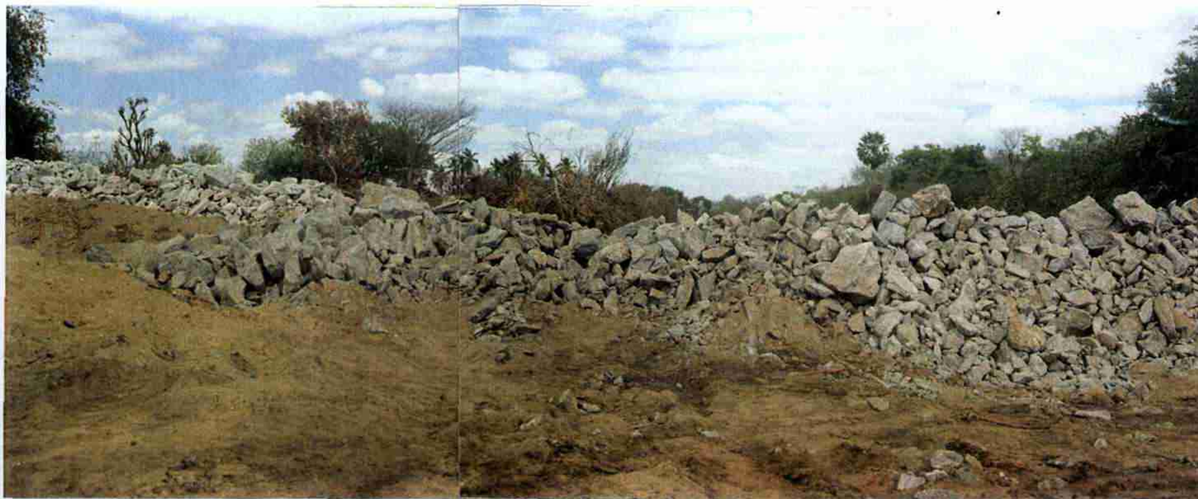
Preparação do Rock-Fill, lado da ombreira esquerda a jusante – Estaca 11.
