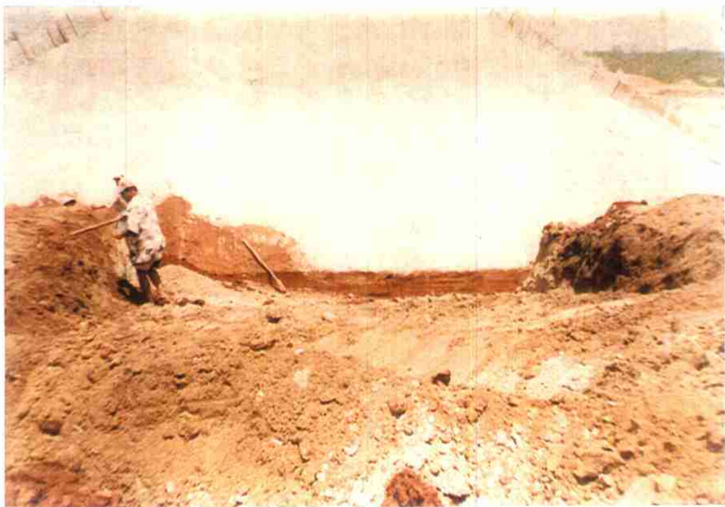
Vista do Cut-Off em fase de limpeza – Estaca 32 montante do eixo. Ao fundo, paredão do muro direito do Sangradouro.
