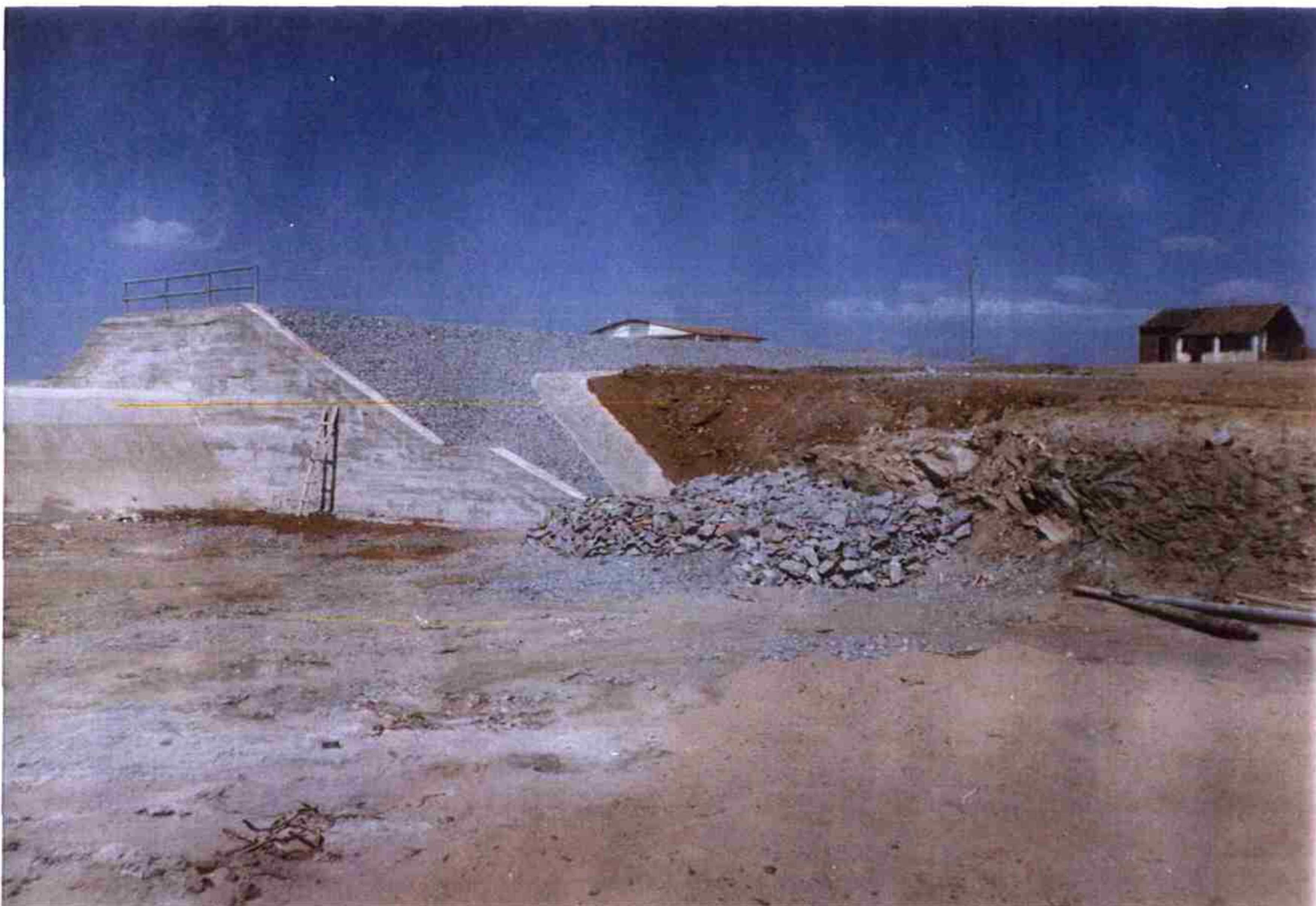
Vista do Muro Direito com seu enrocamento no sopé, guarda-corpo na cirsta e maciço da estaca 38+0,50m a 40+13,00m com seu talude jusante revestido com brita de 1 a 3".
