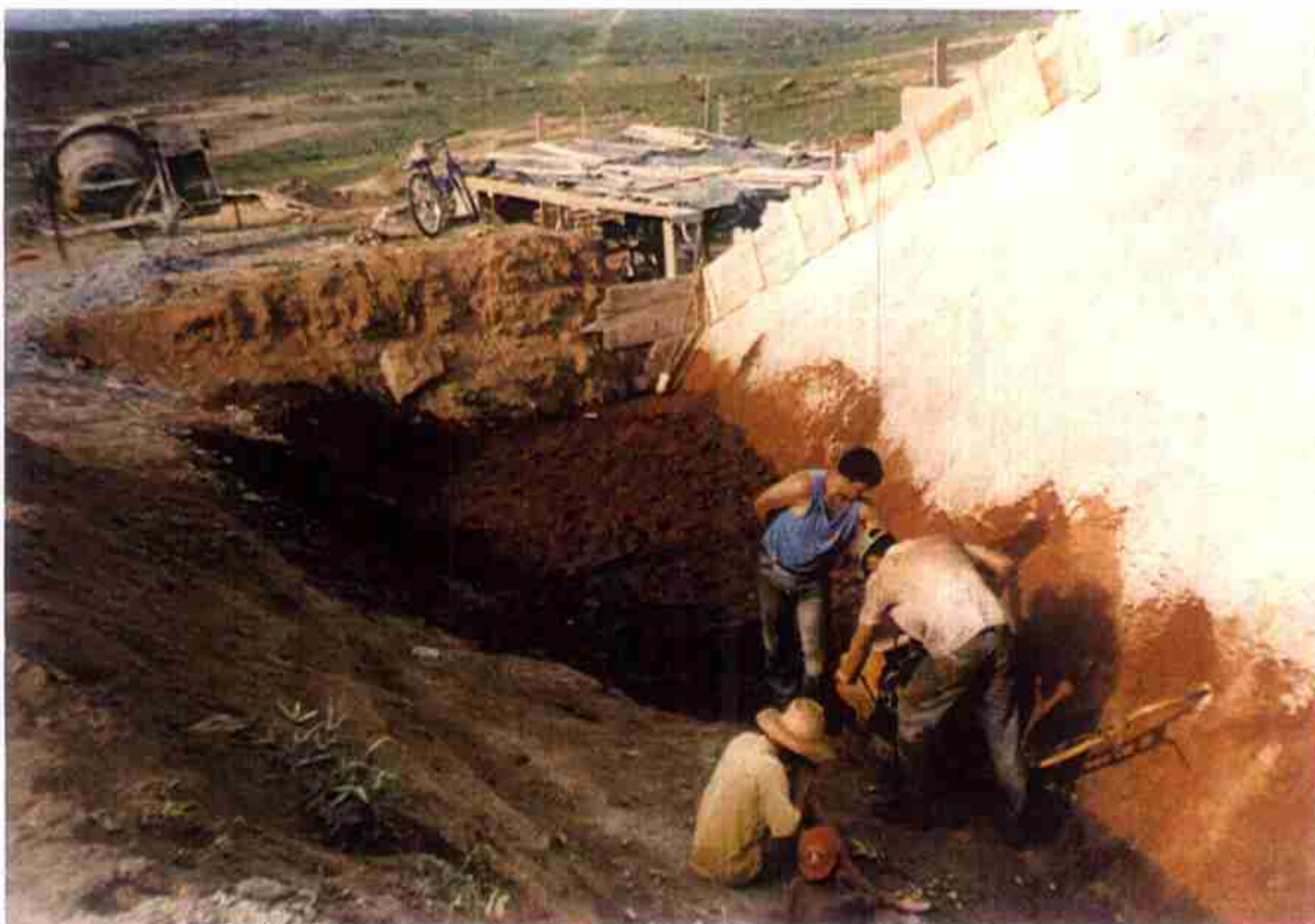
Vista do pé do muro direito do Sangradouro em fase de reaterro – Lado montante.
