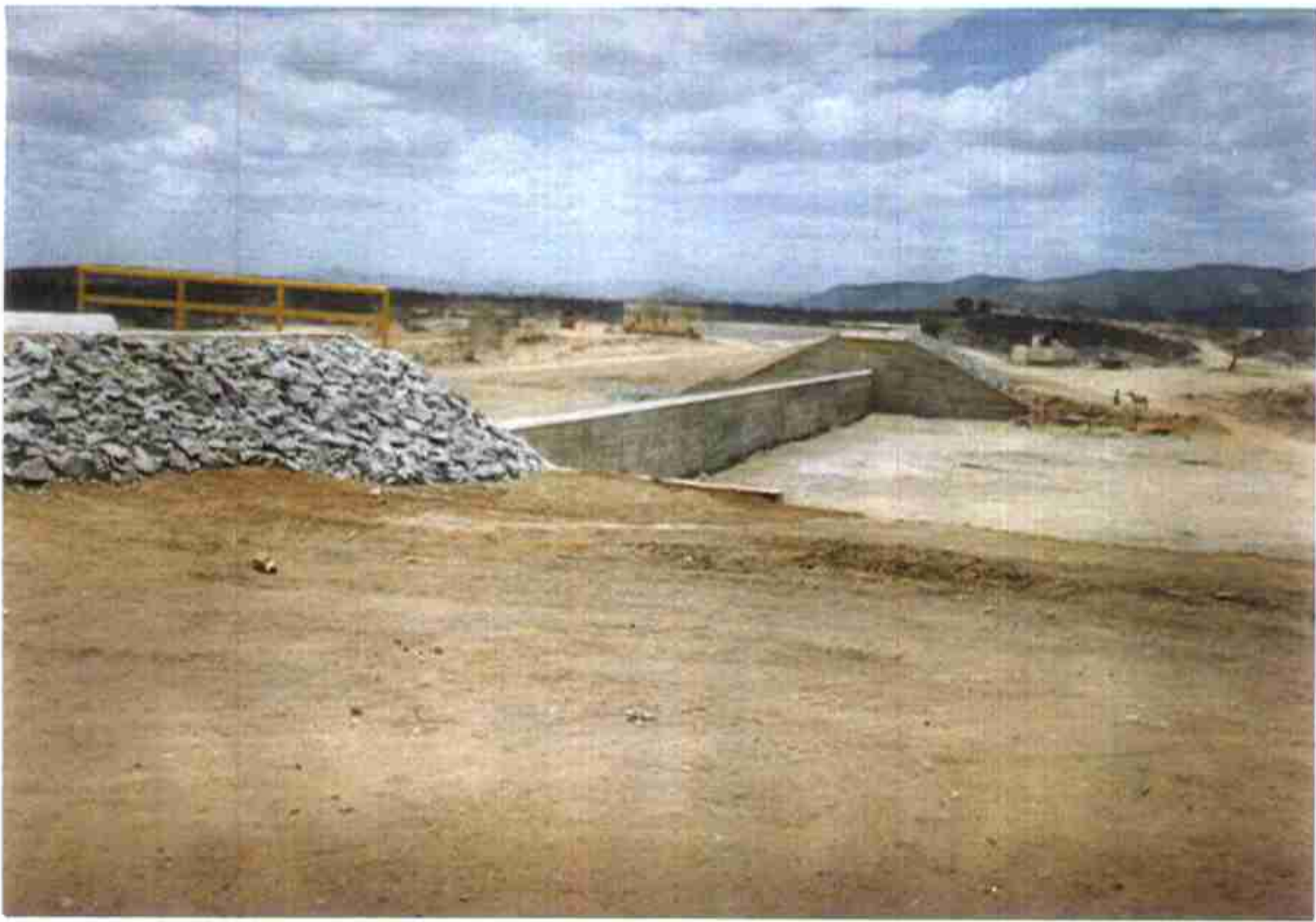
Vista do "PERFIL CREAGER" do Sangradouro - Montante.
