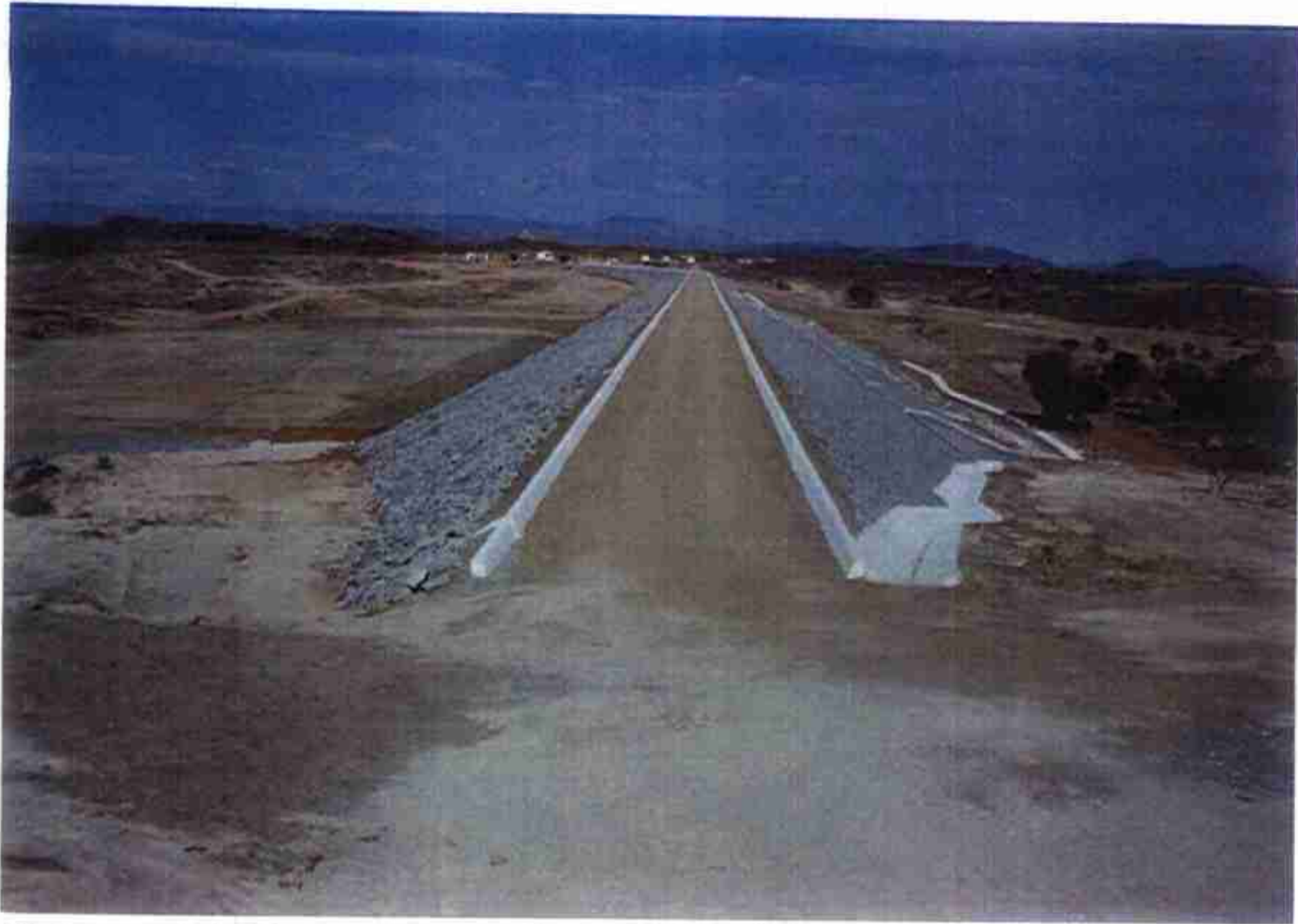
Vista geral da Barragem a partir da estaca "0".
