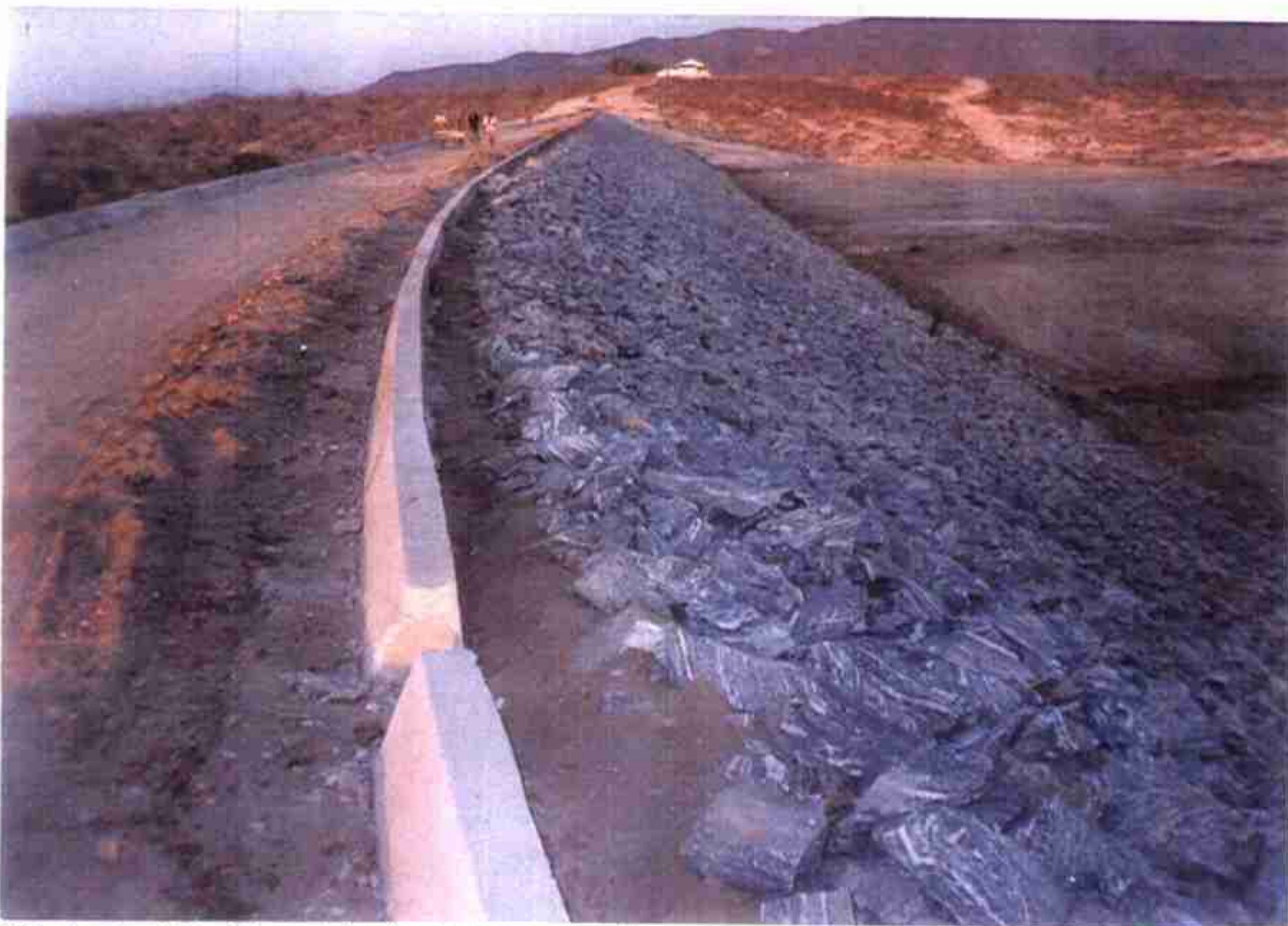
Vista do Rip-Rap talude Montante com meio-fio já concluído.
