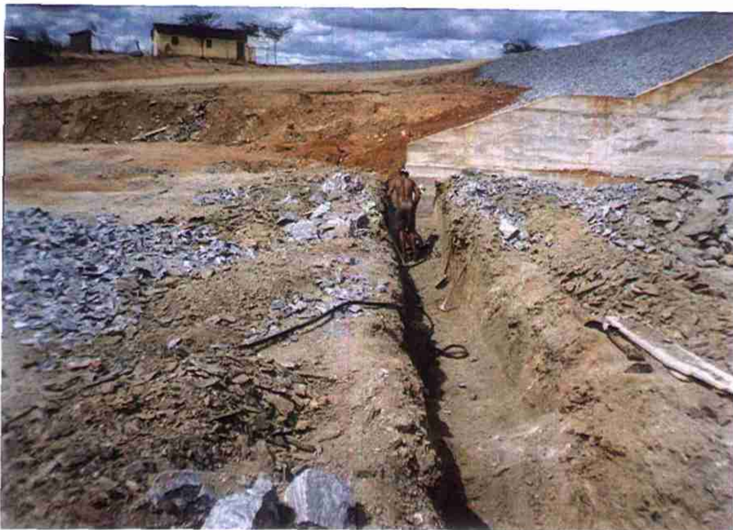
Vista de fase da escavação do Cordão de Fixação ligando as extremidades dos Muros Direito e Esquerdo do Sangradouro.
