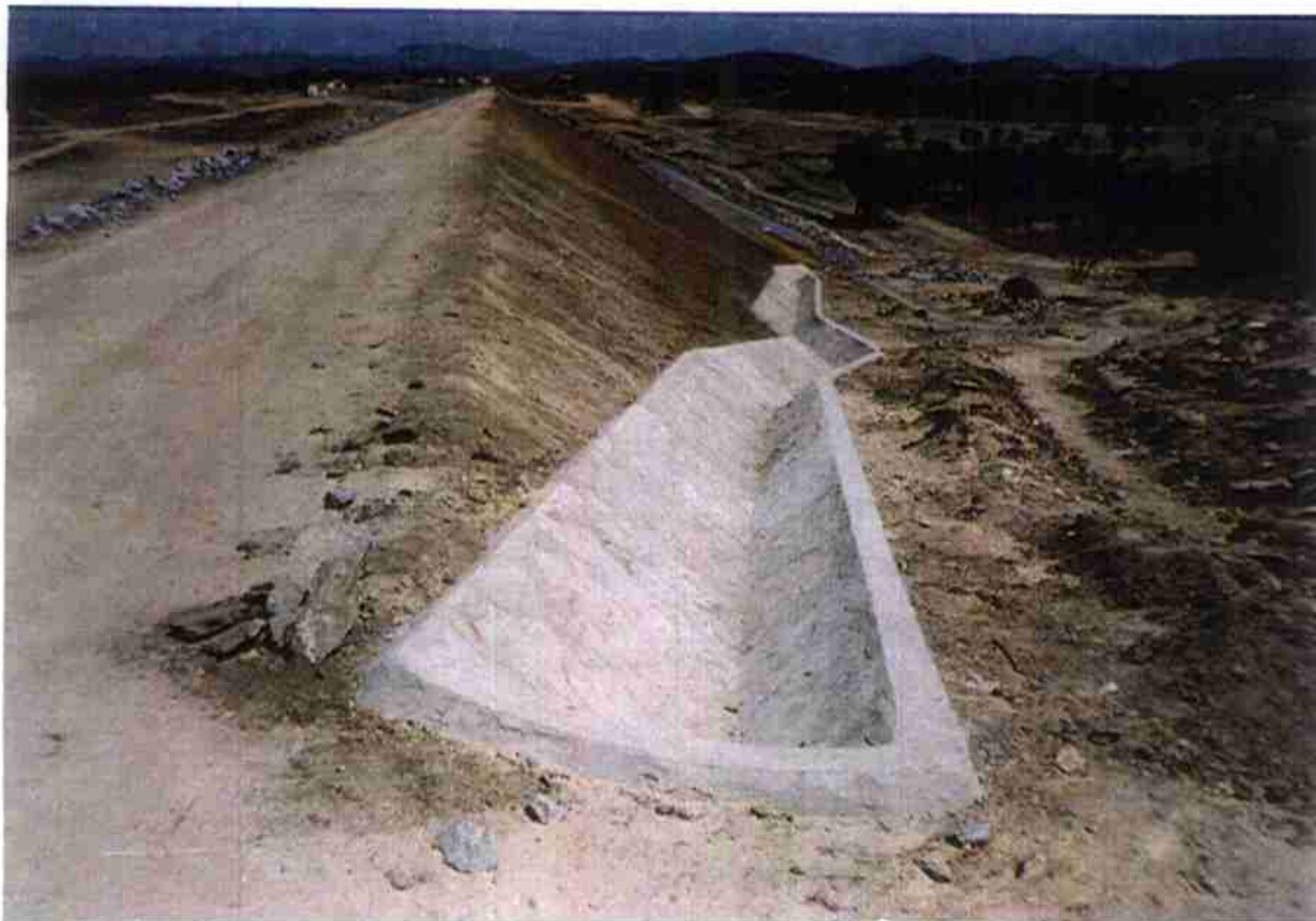
Vista de Sarjeta Coletora Ombreira Direita.
