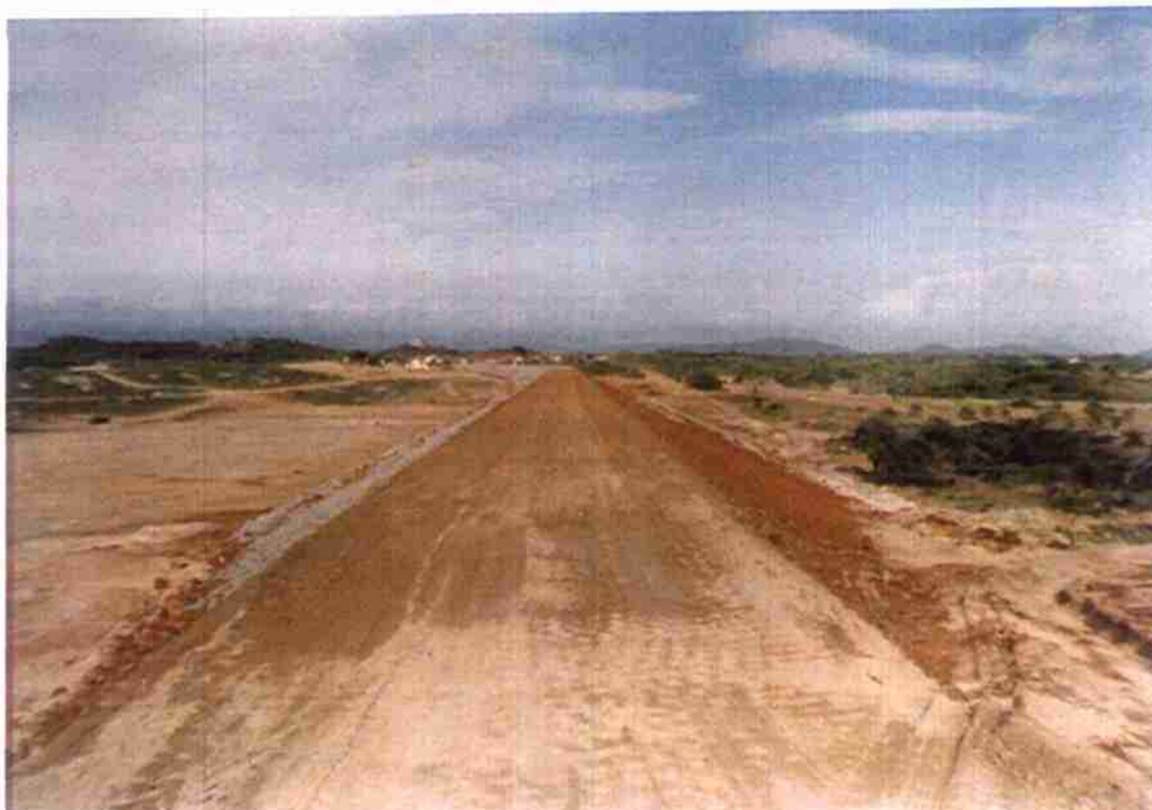
Vista geral do coroamento do maciço sílico argiloso com camada de revestimento.
