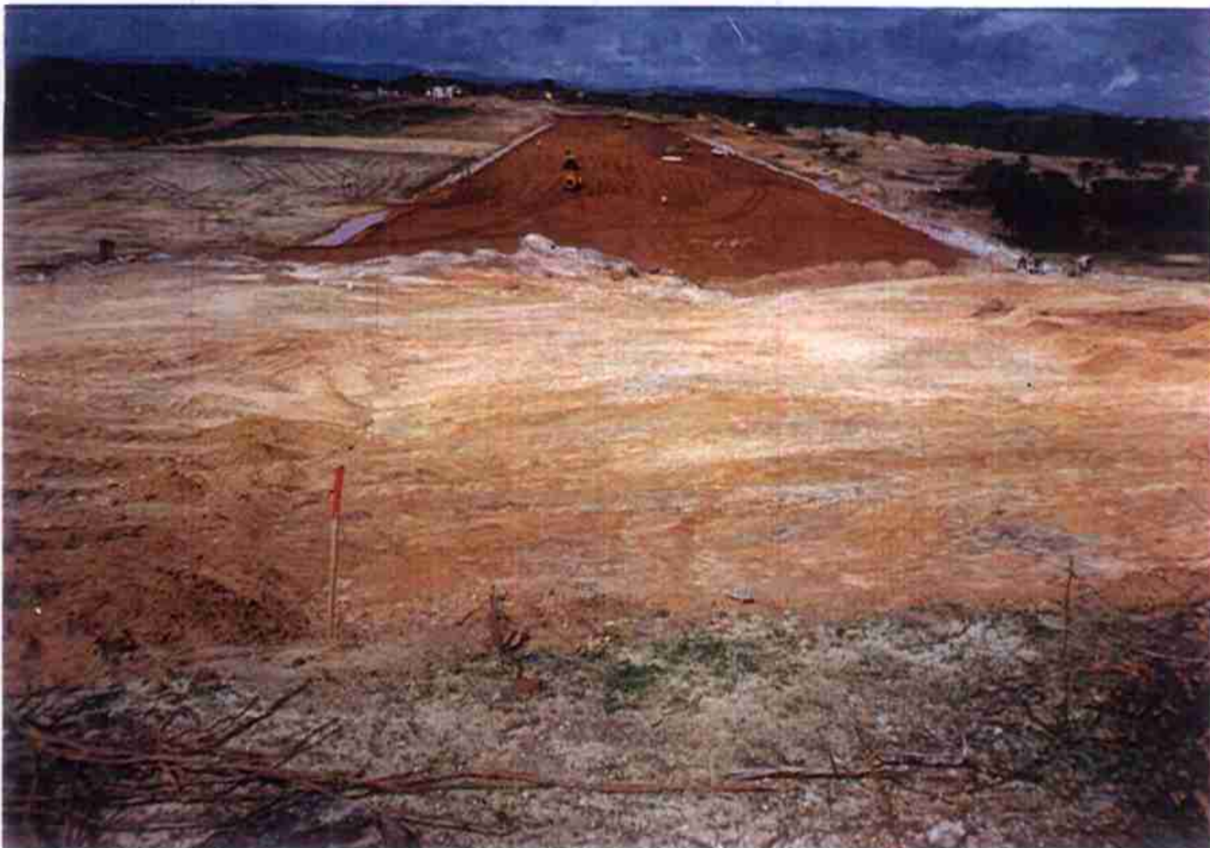
Vista geral do maciço sílico argiloso a partir da estaca "0".
