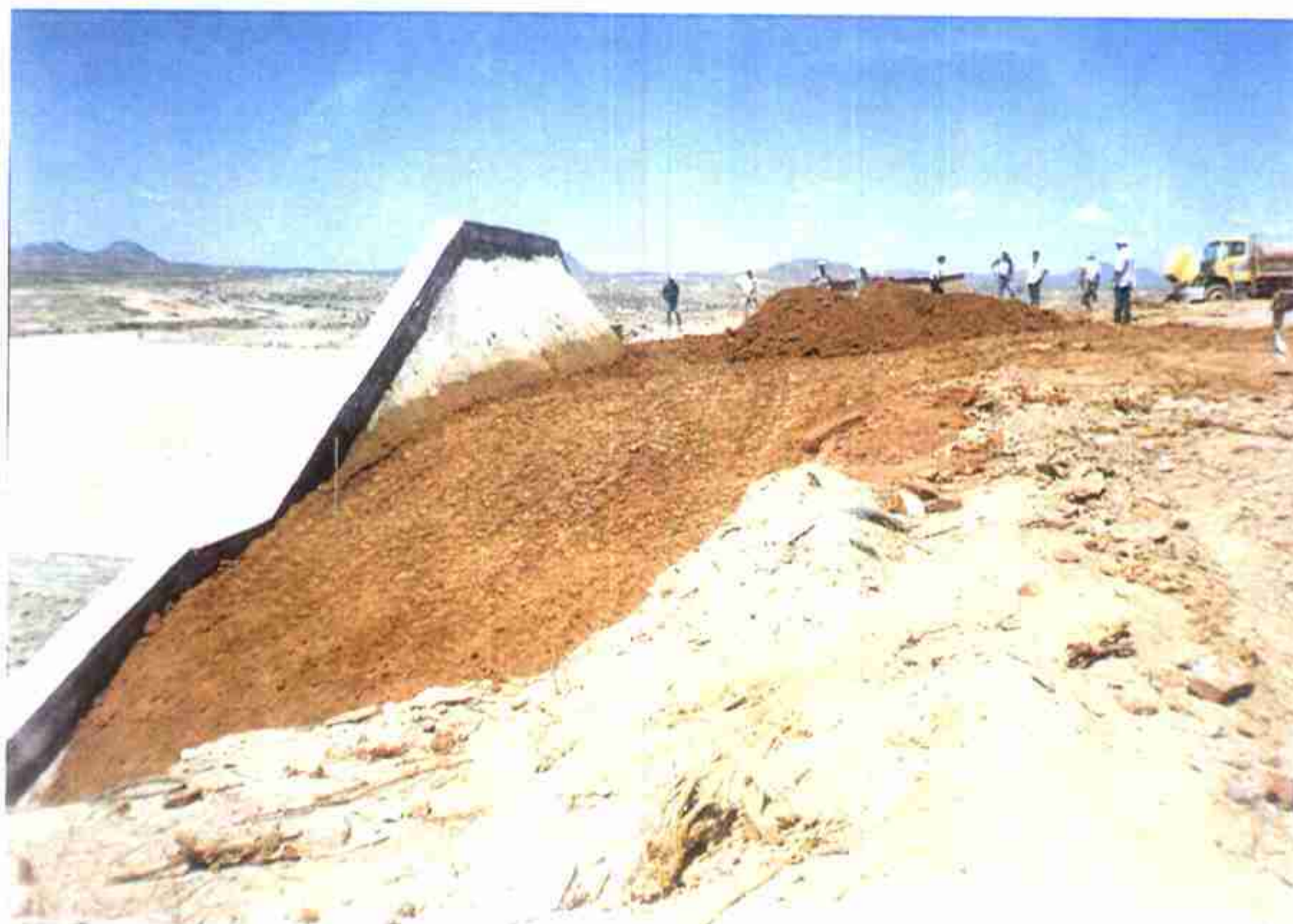
Vista do reaterro no pé do Muro Esquerdo estaca 38+0,50m.
