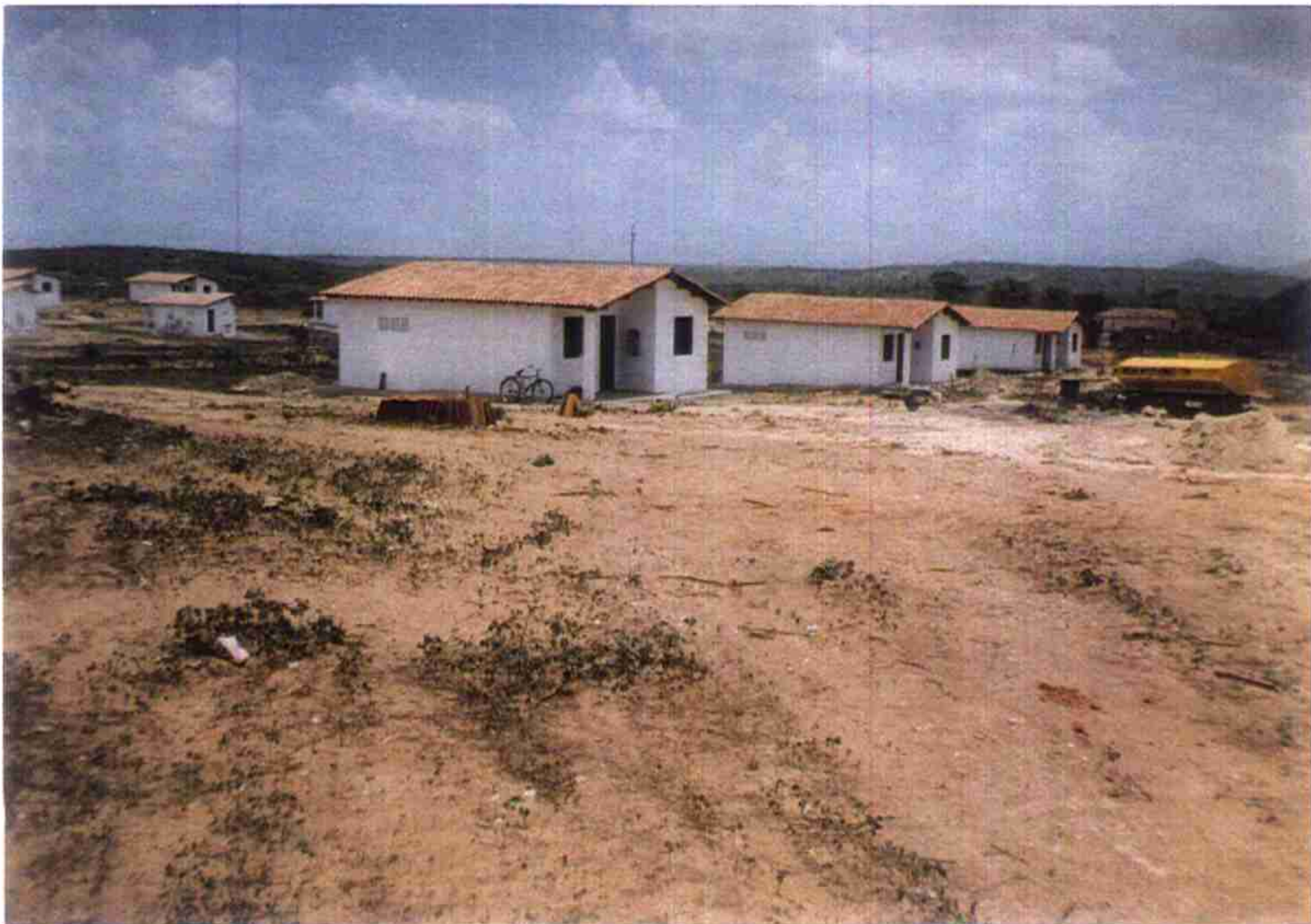
Vista geral da Vila de Reassentados atingidos pela Barragem Souza.
