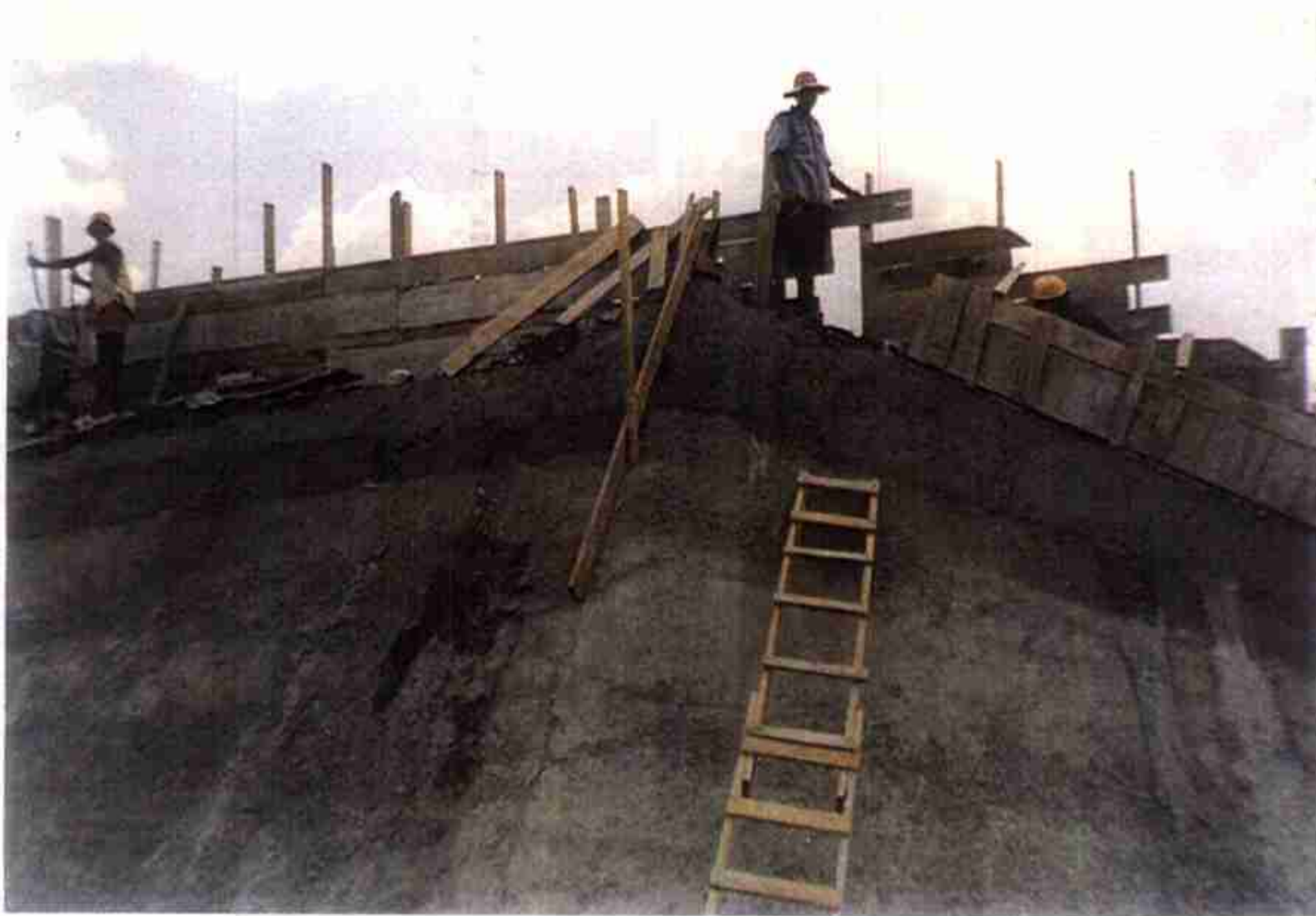
Vista do muro direito do Sangradouro em fase final de Concretagem.
