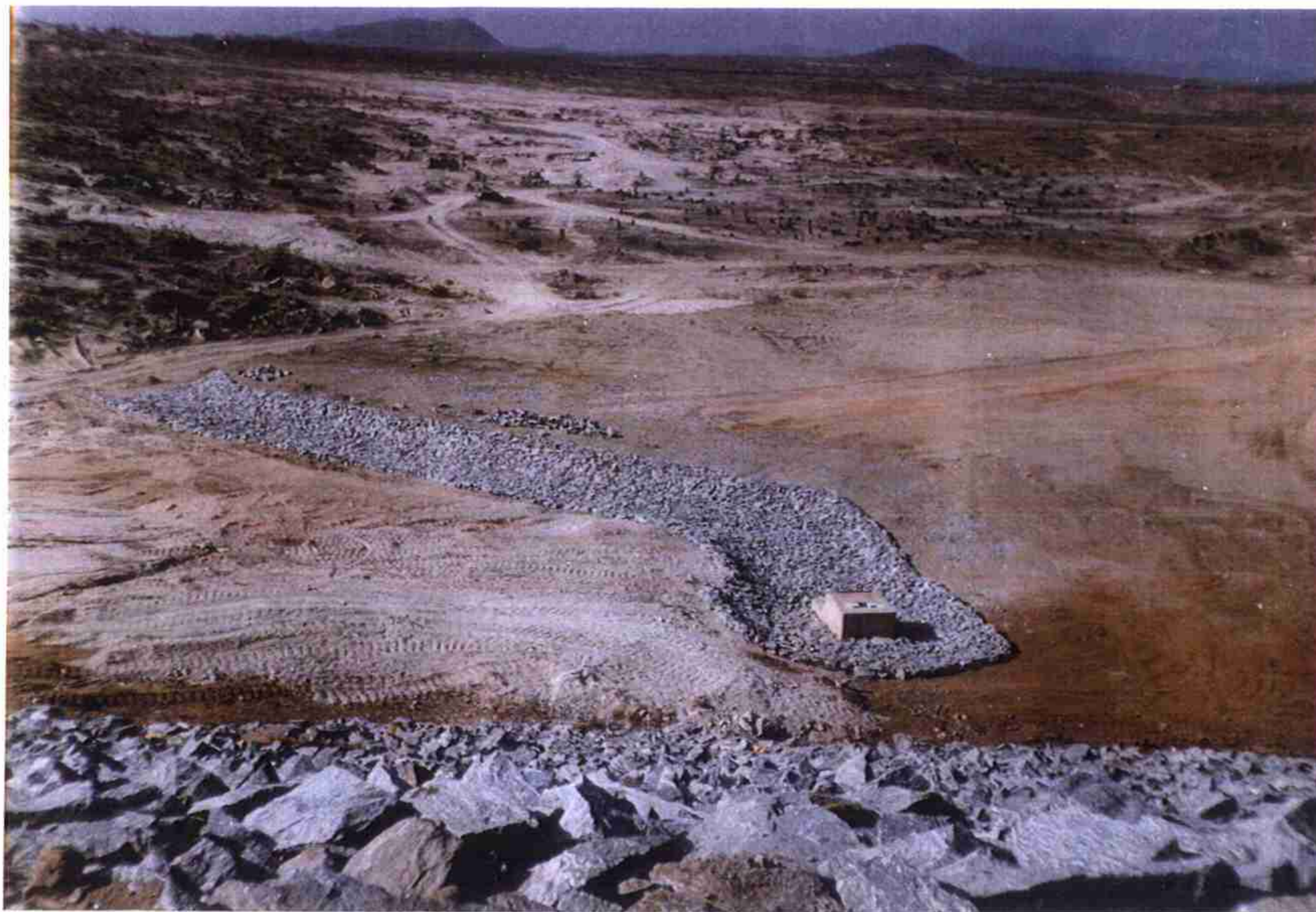
Vista do Canal de Aproximação e Tomada D'água.
