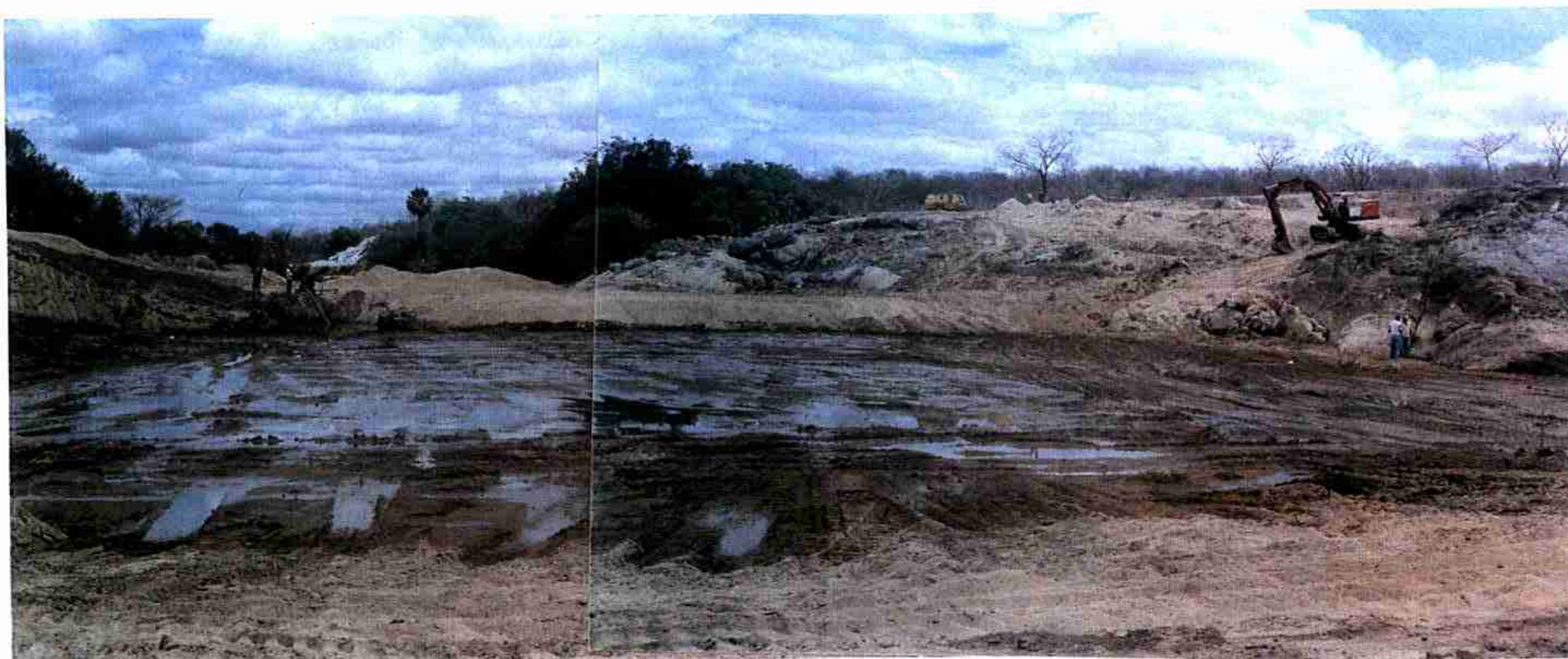
Vista da ombreira direita, com os trabalhos iniciais de escavação em rocha para as obras da galeria e preparações iniciais do tapete drenante à jusante.
