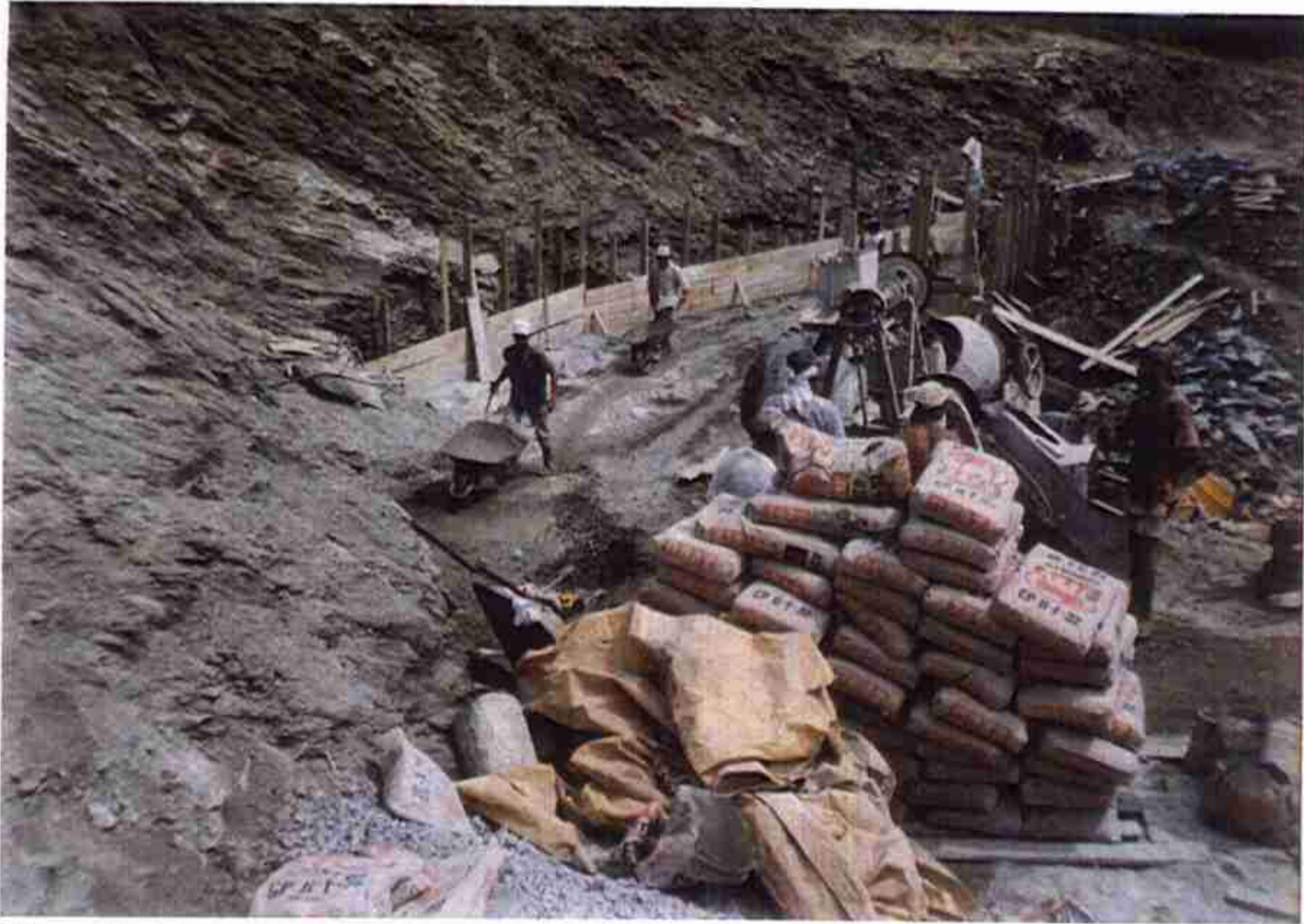
Vista do Muro Esquerdo do Sangradouro em fase de concretagem.
