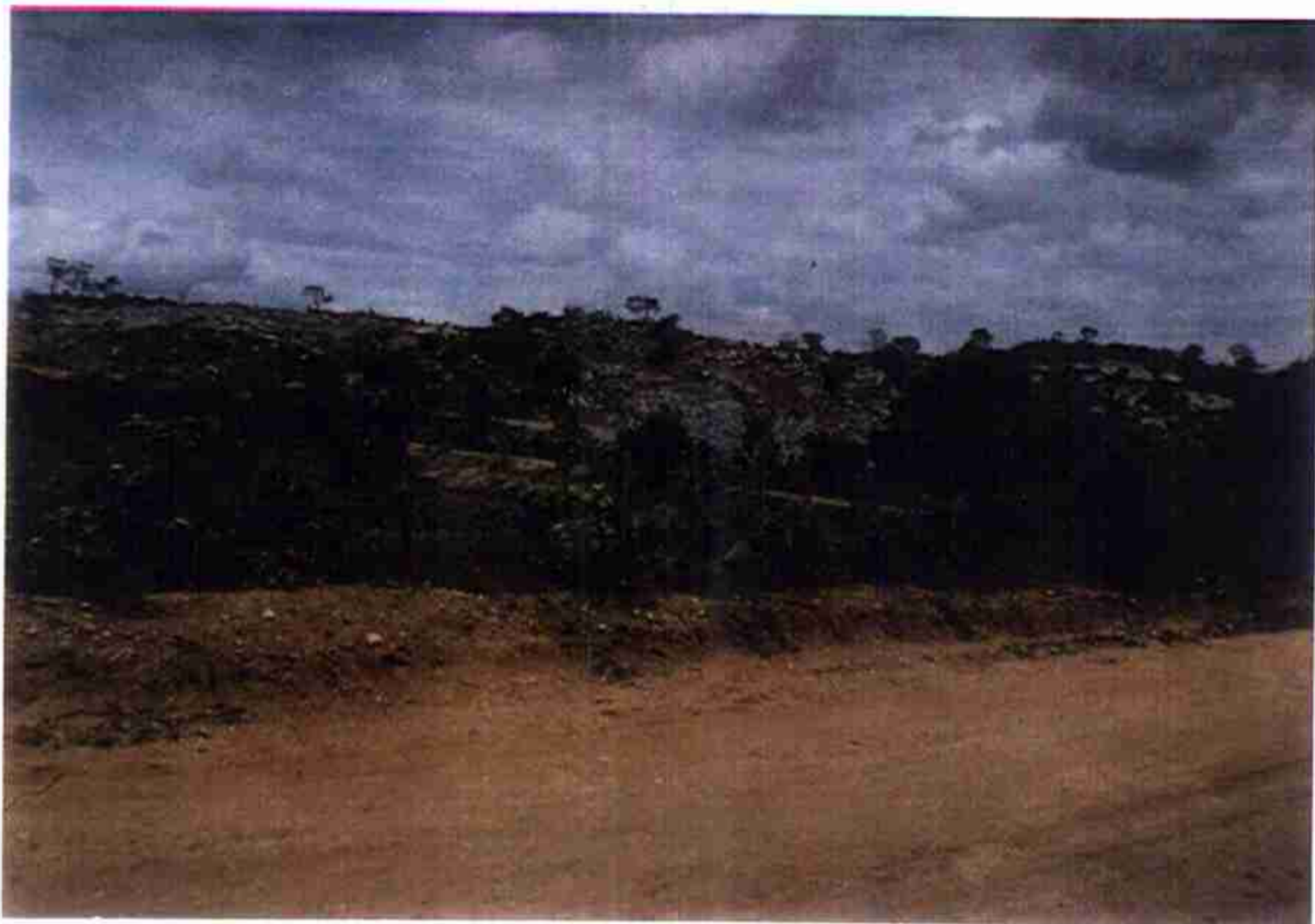
Vista da Pedreira P-4.
