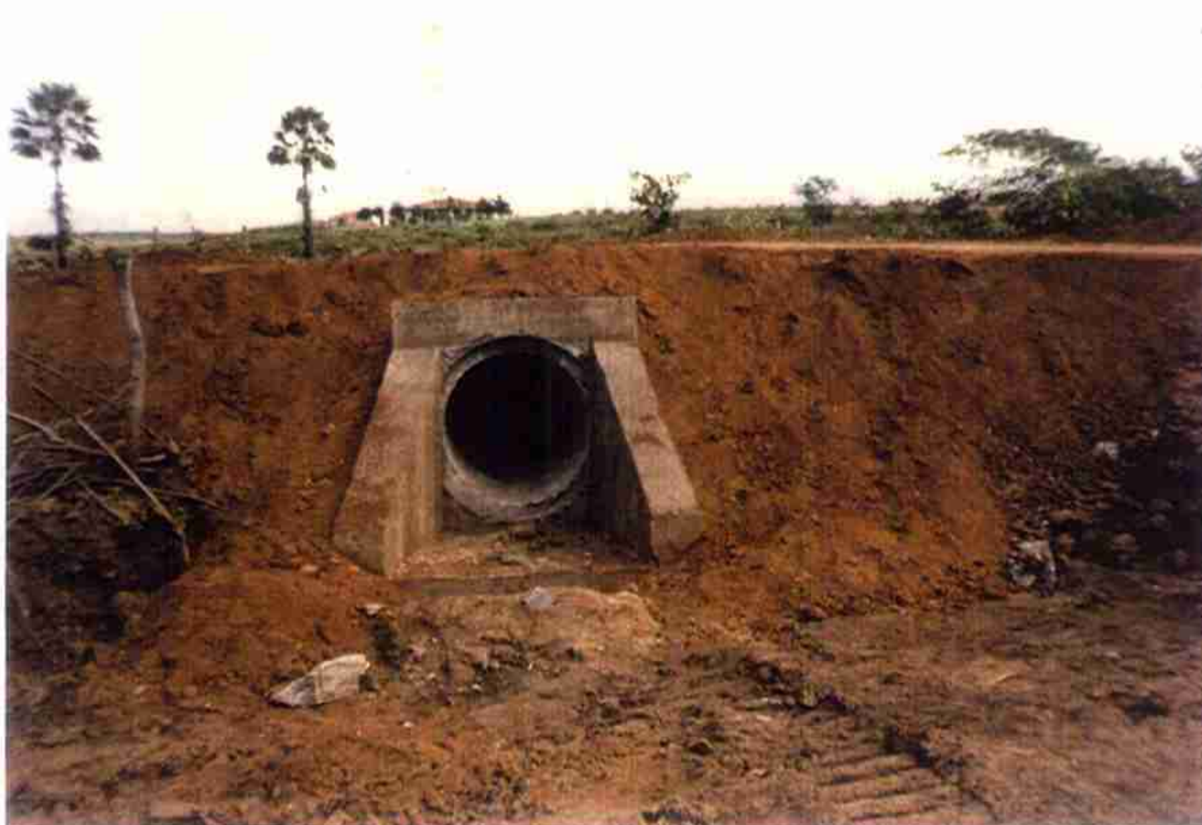
Vista da boca de BSTC Ø 0,80m, estaca 117 da Estrada de Acesso à Barragem.
