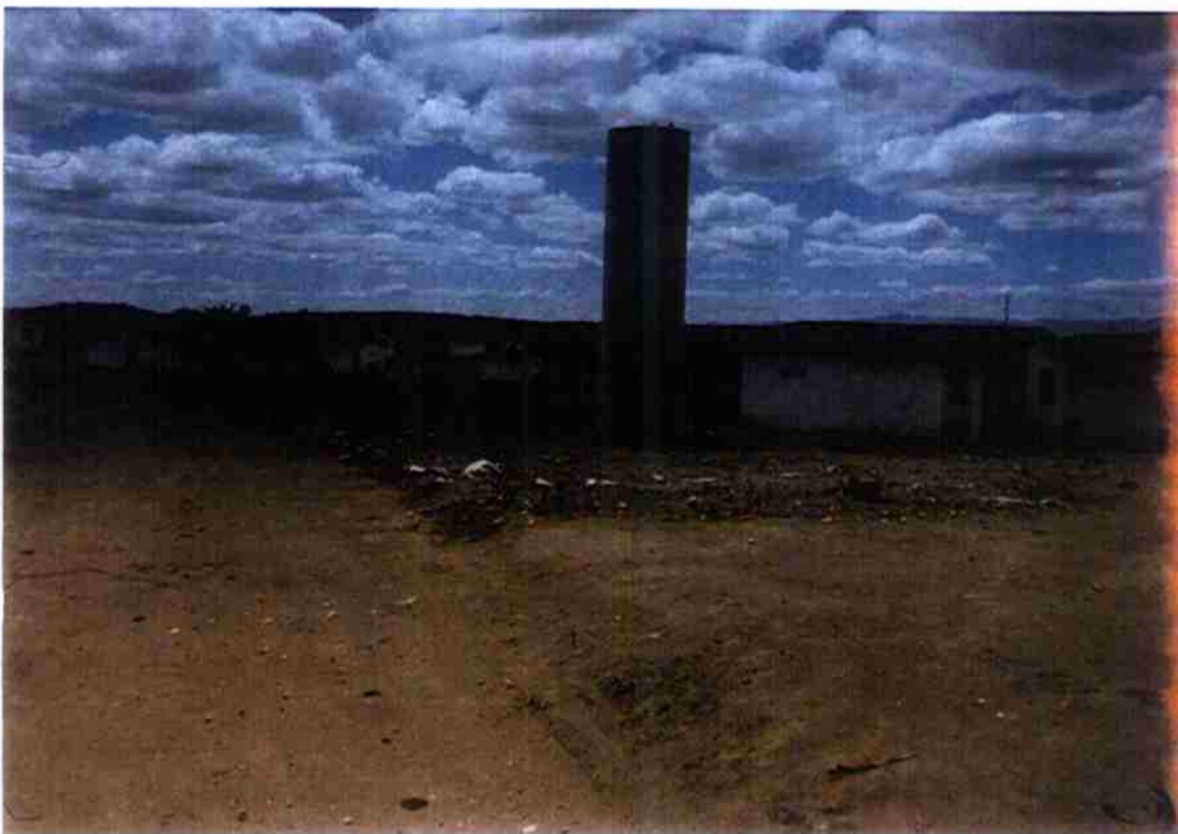
Vista de Castelo D'água tipo Chafariz na Agrovila de Reassentados da Barragem Souza.
