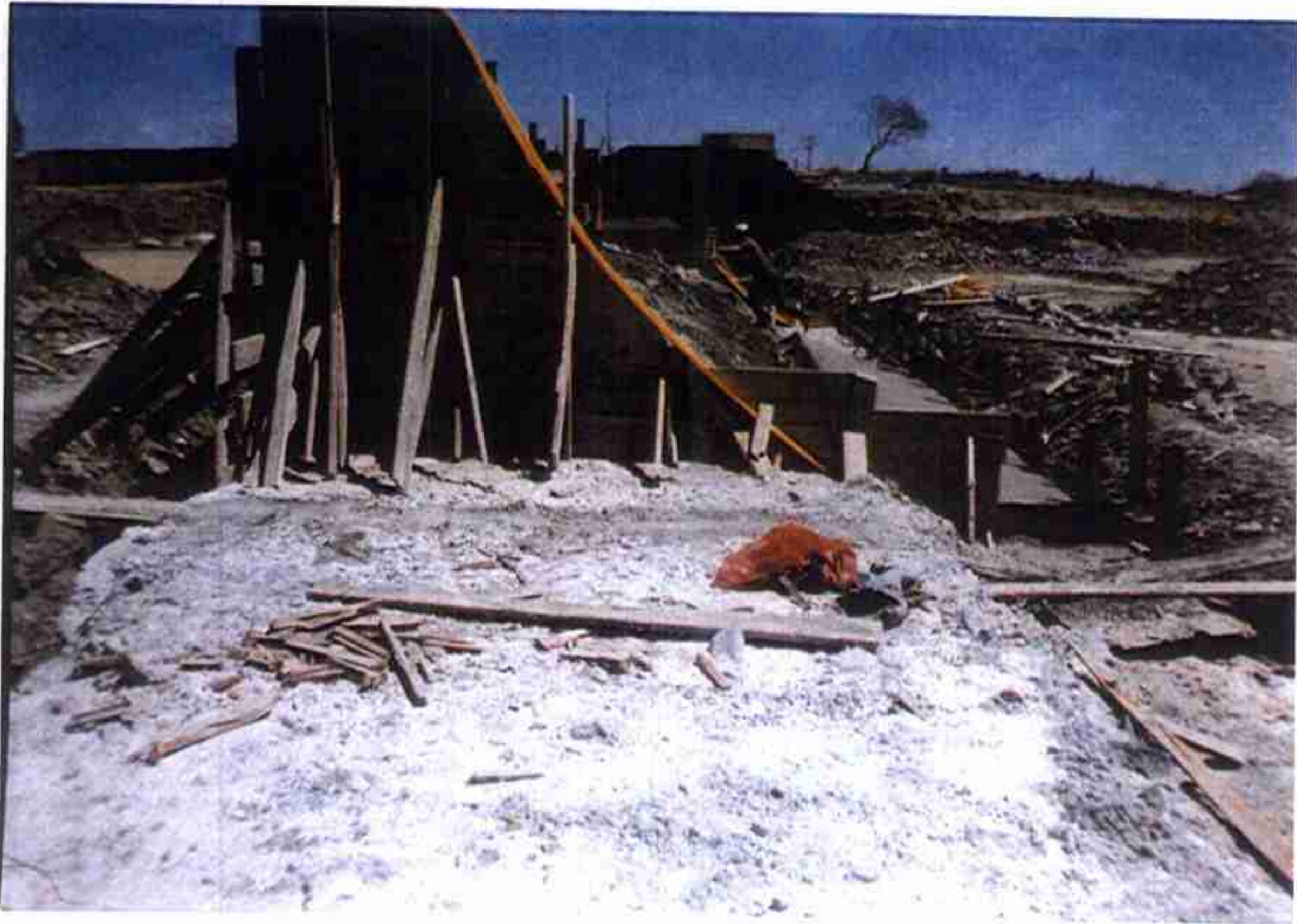
Vista do Bloco 2 do PERFIL CREAGER do Sangradouro em fase de Concretagem – cota acima da 159.
