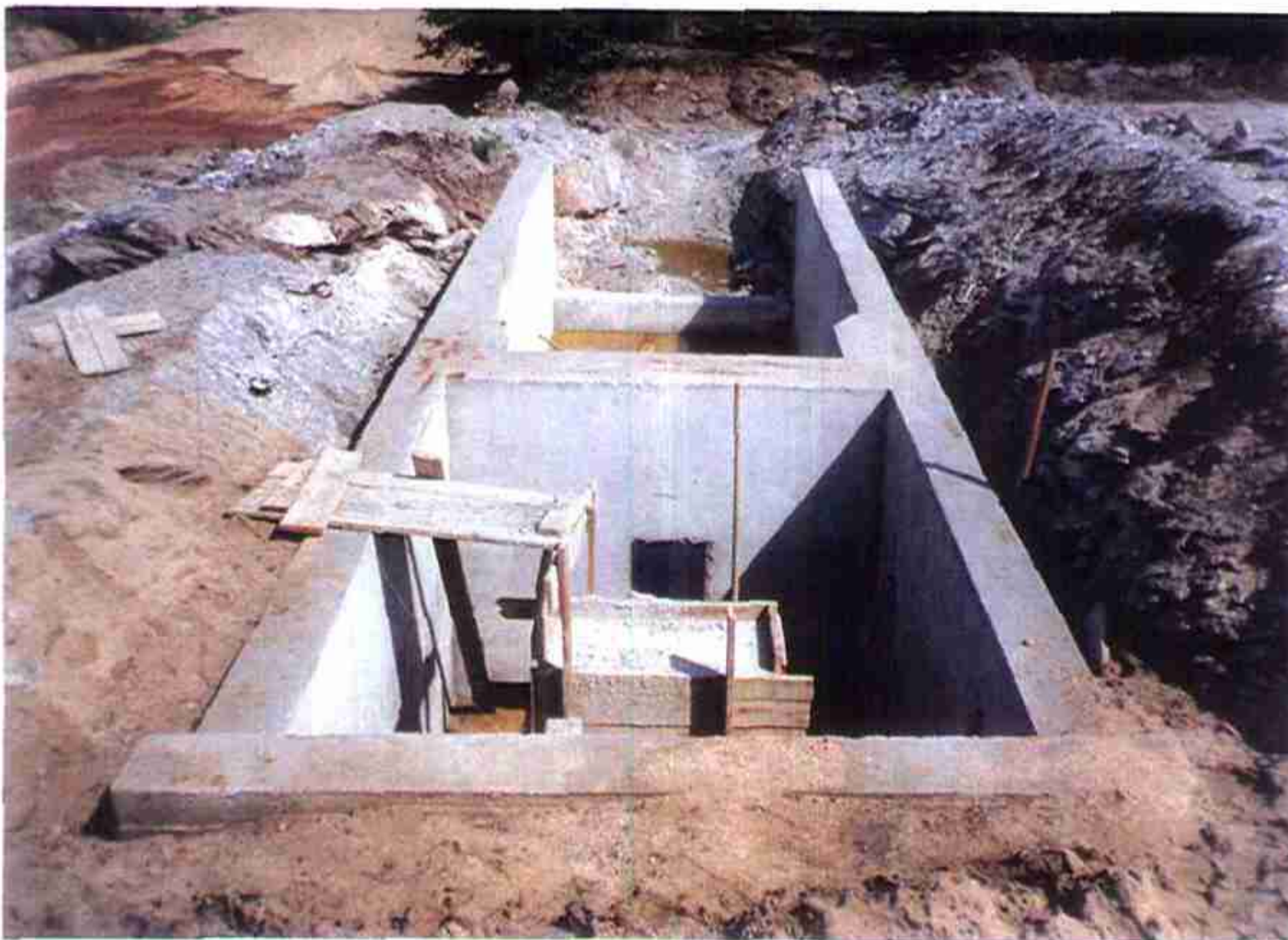
Vista caixa jusante da Tomada D'água.
