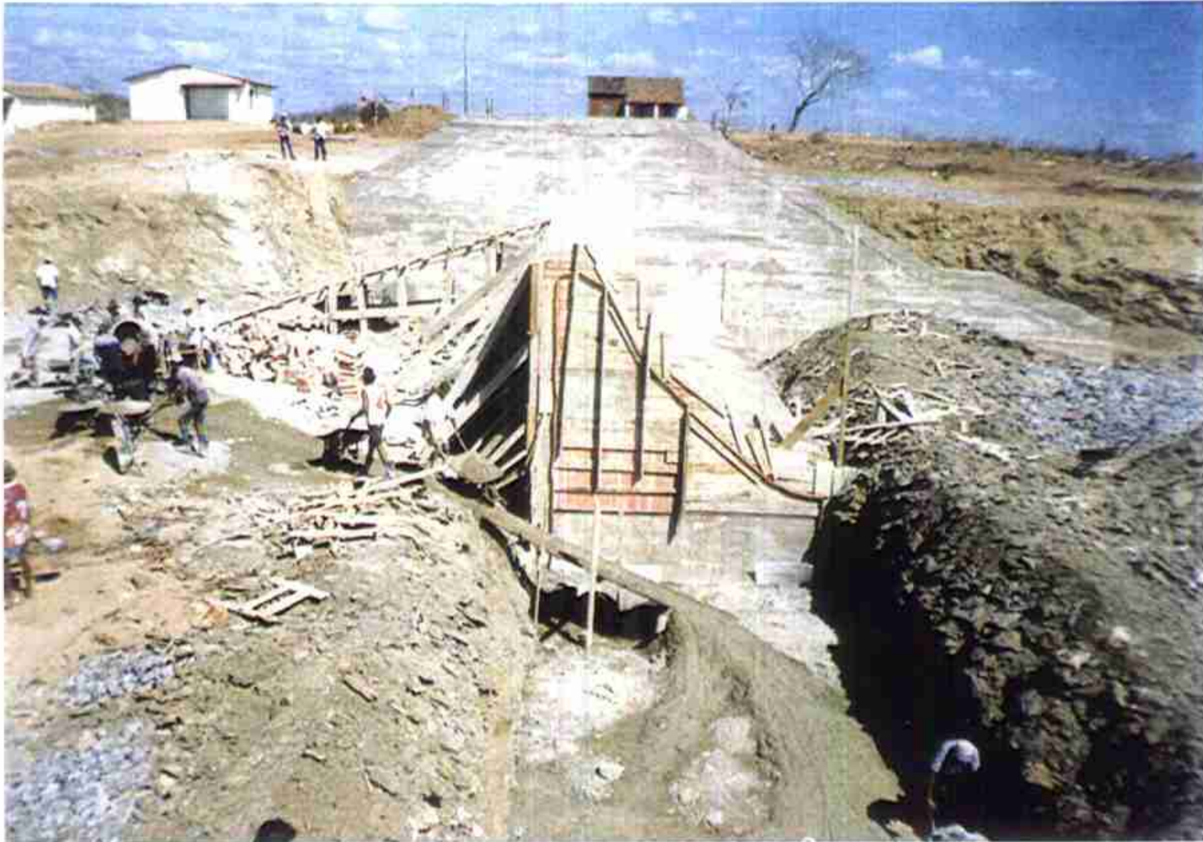
Vista de fase da concretagem do Bloco "4" do PERFIL CREAGER abaixo da cota 159.
