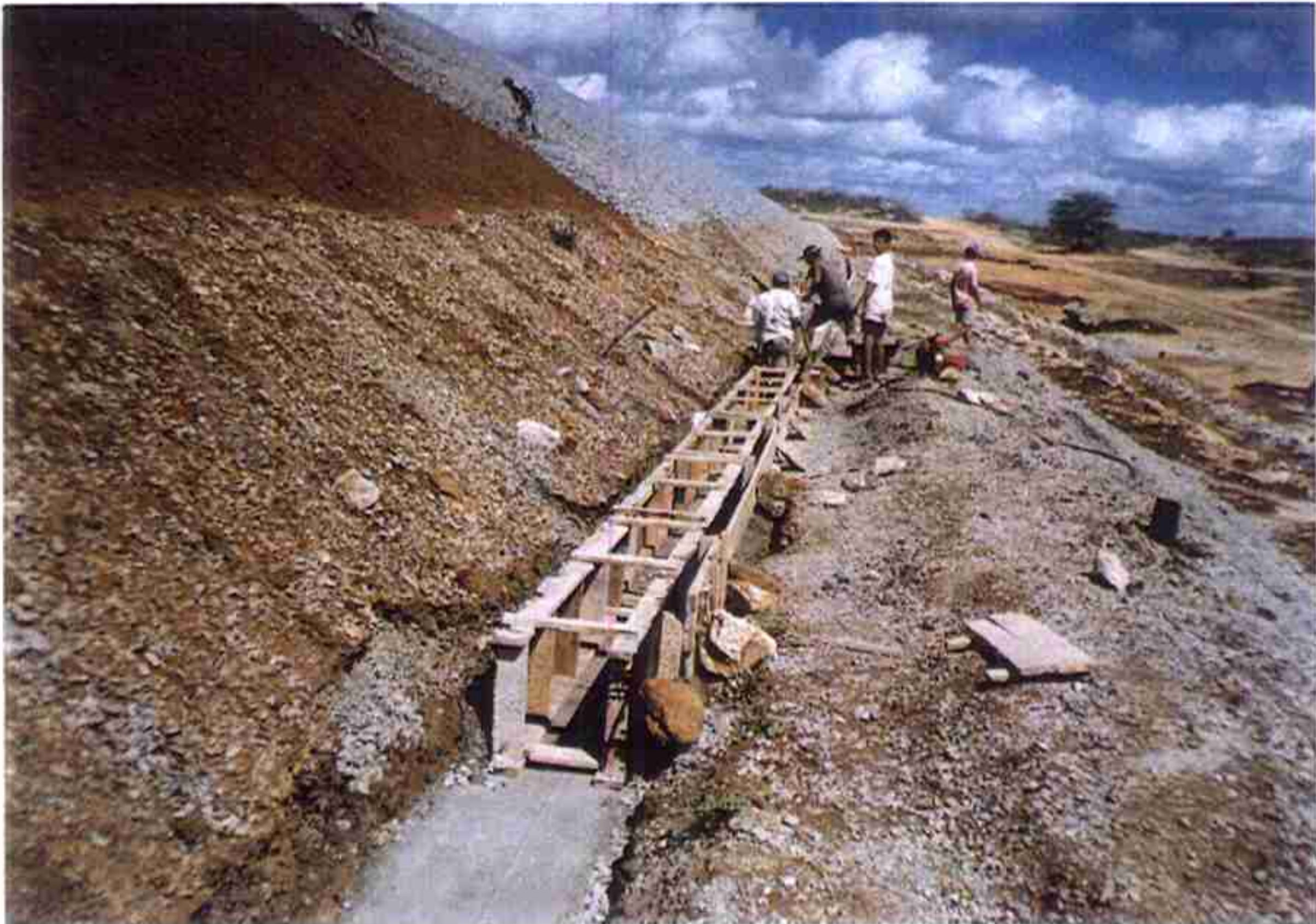
Vista do talude Jusante em fase de Revestimento e no pé, detalhe de execução de Calha Coletora da Berma.
