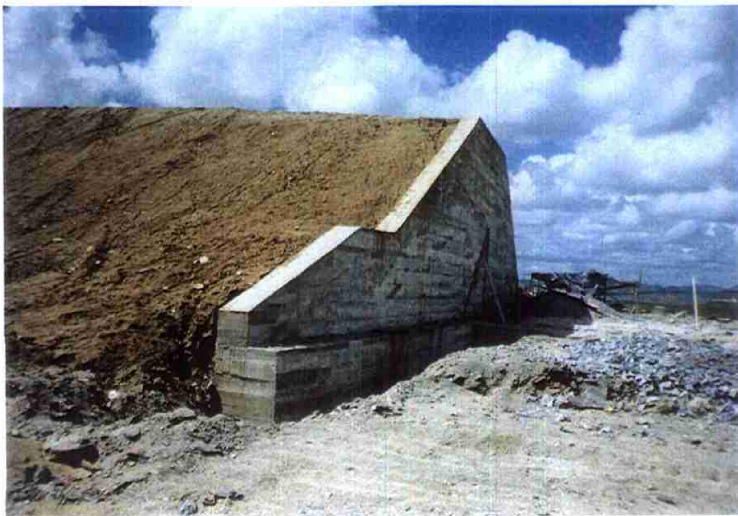
Vista do Maciço já encostado ao Muro Direito do Sangradouro – Estaca 33.
