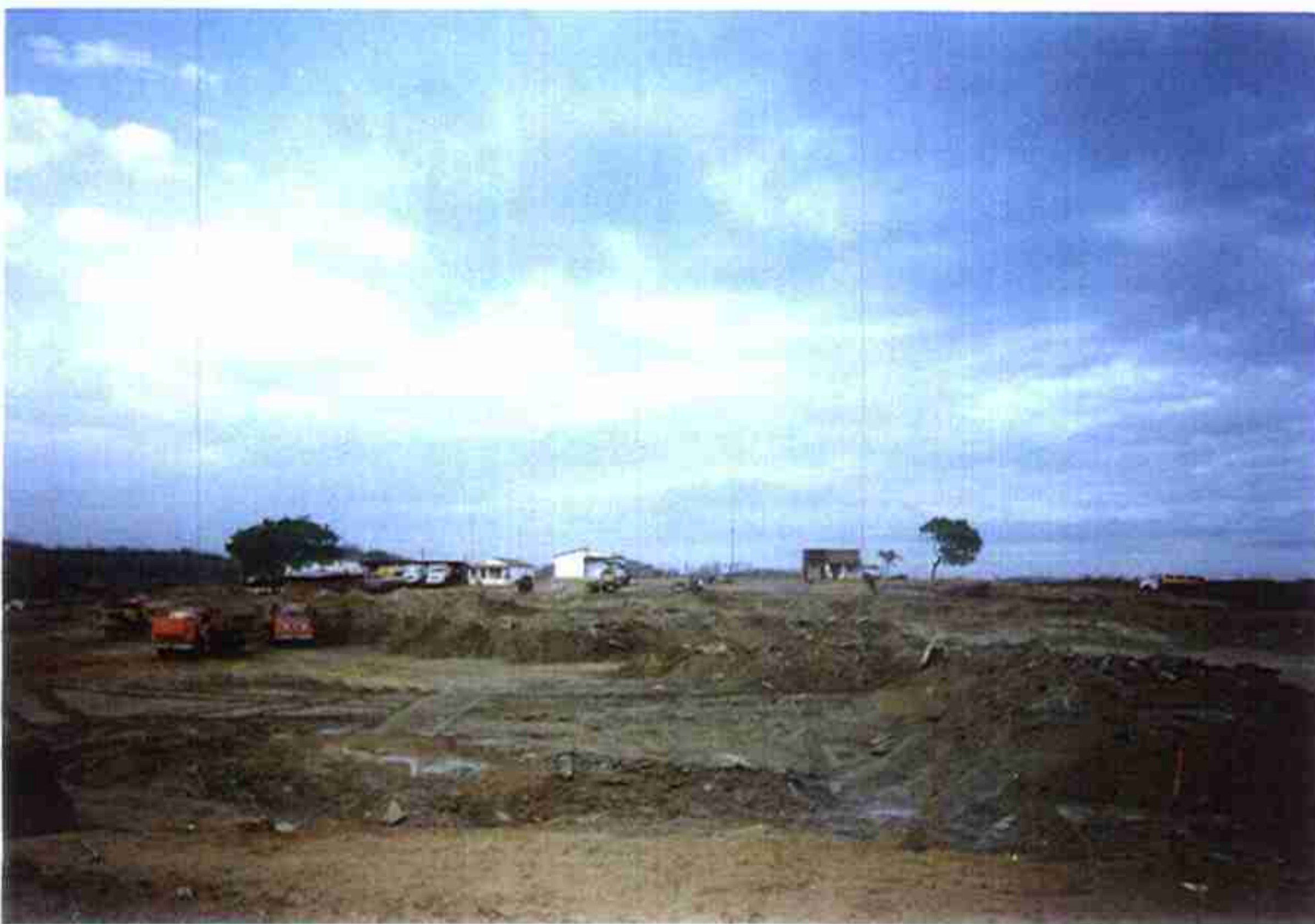
Vista da escavação do sangradouro.
