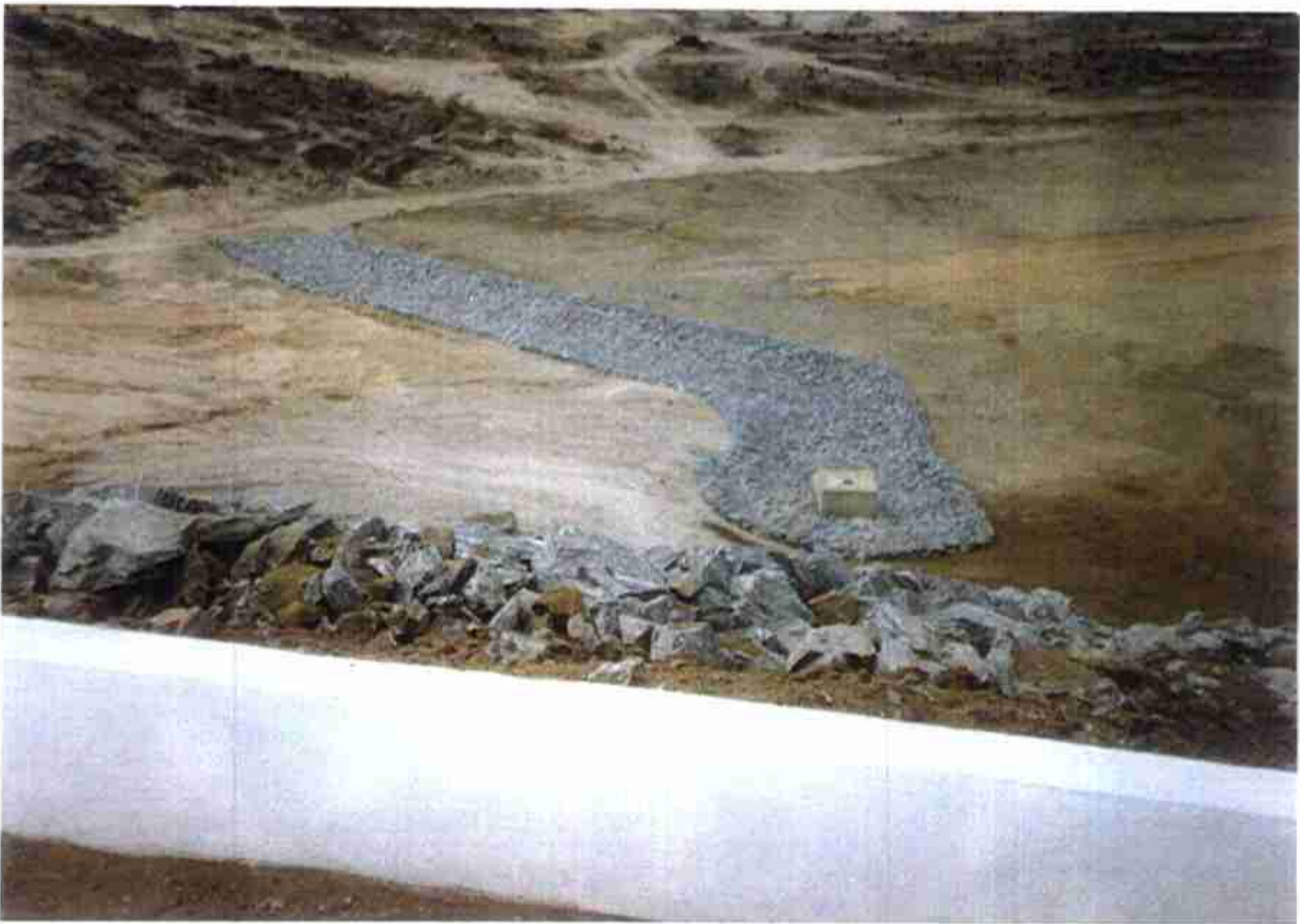
Vista do Canal de Aproximação da Tomada D'água.
