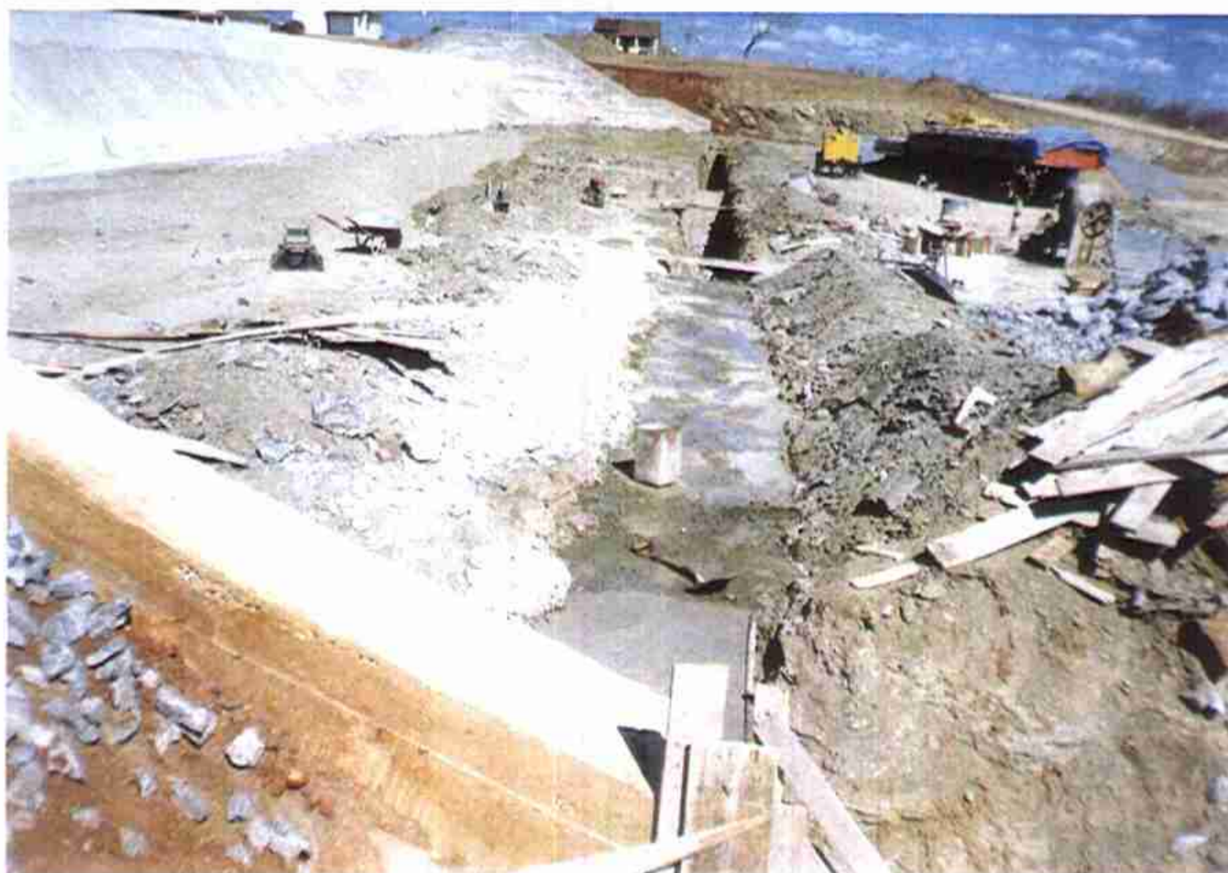
Vista de fase da concretagem do Cordão de Fixação na cota final 158,70.
