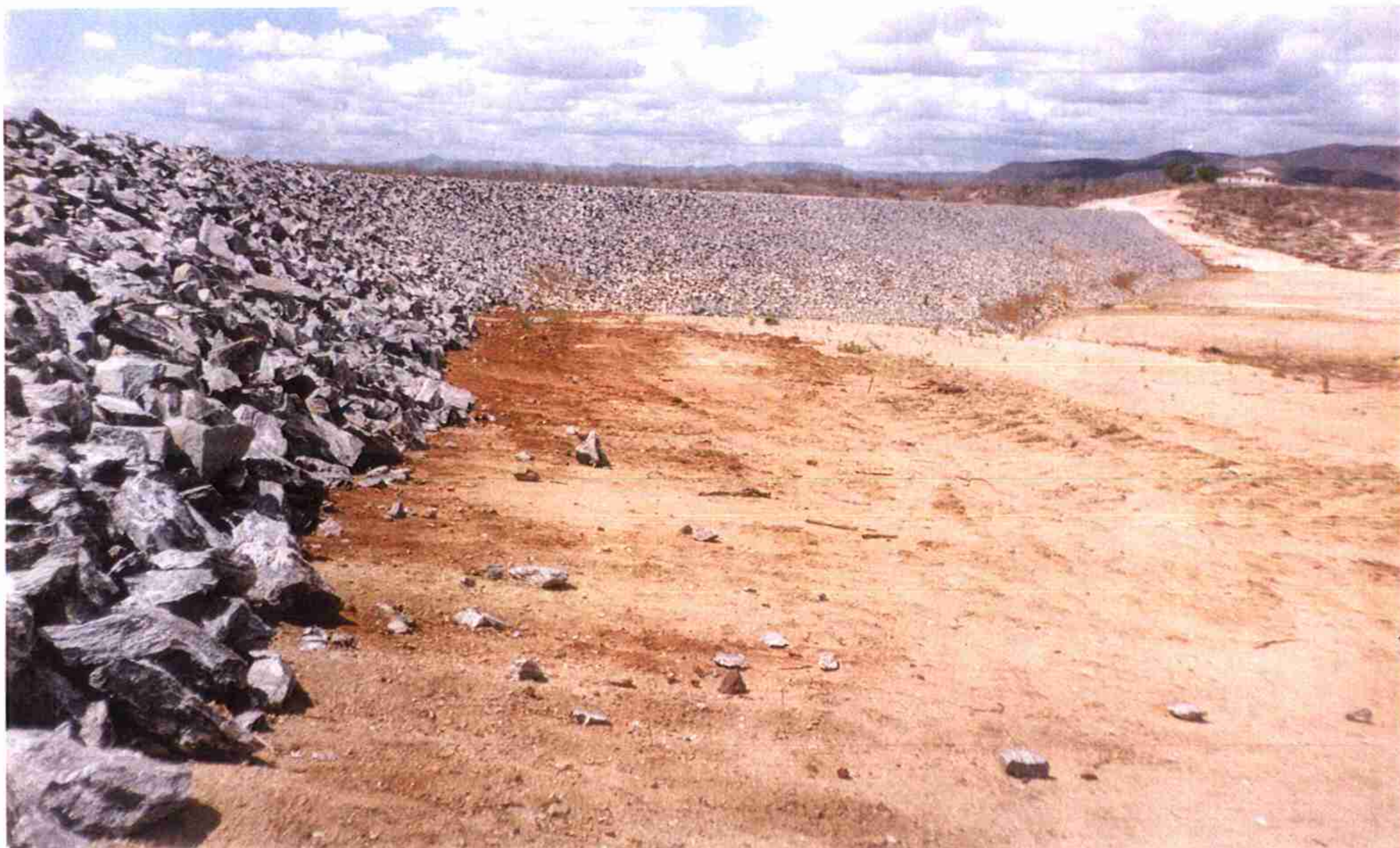
Vista Geral do RIP-RAP Talude Montante da Estaca 0+00 a 28+00.
