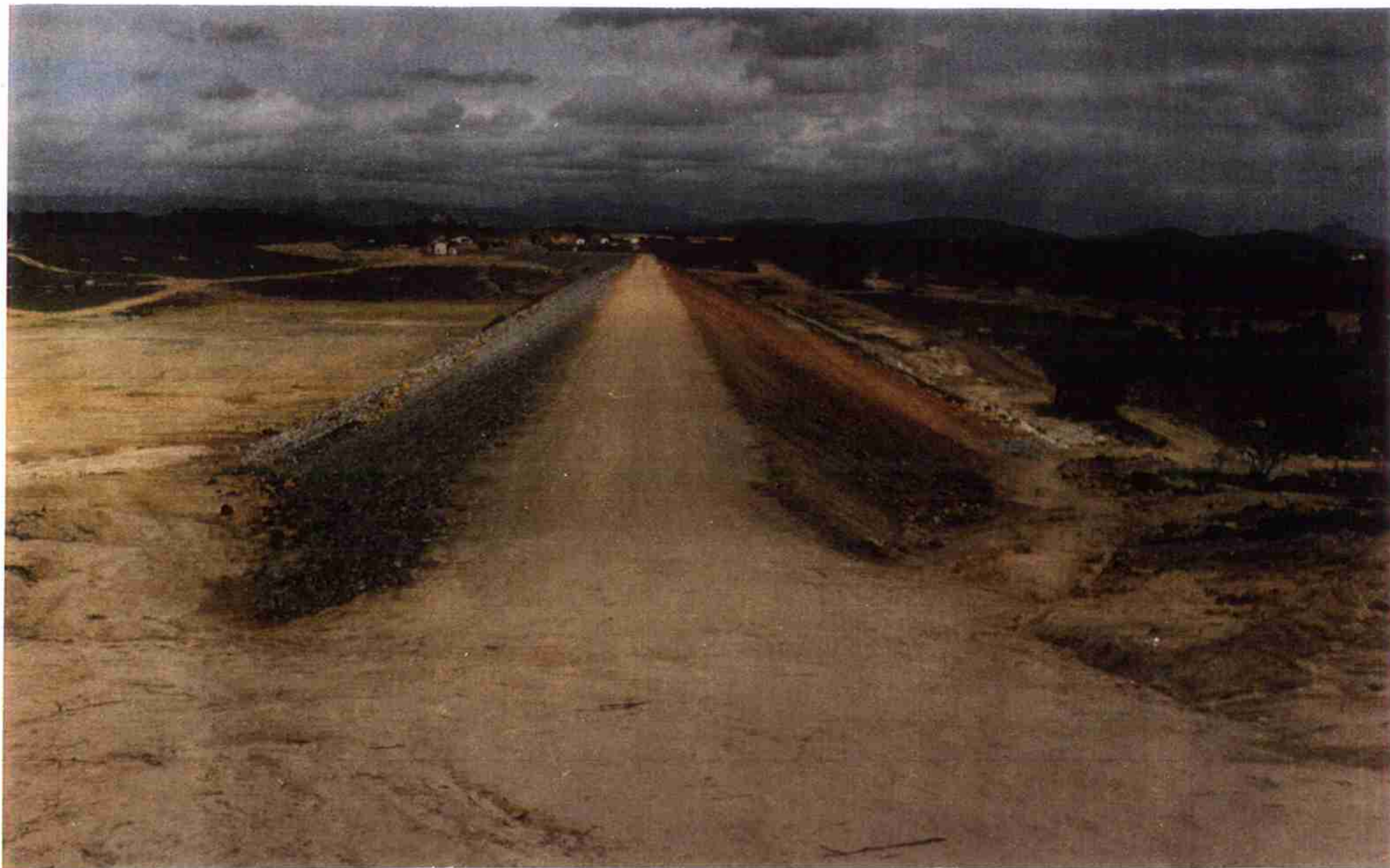
Vista geral da Barragem na cota de coroamento 165,100m com Revestimento – Estaca "0" a Estaca "33".
