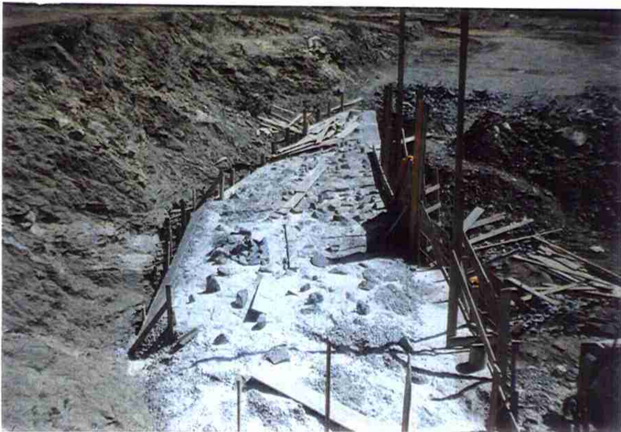
Vista do Muro Esquerdo do Sangradouro com concretagem concluída até a cota 159,000m.
