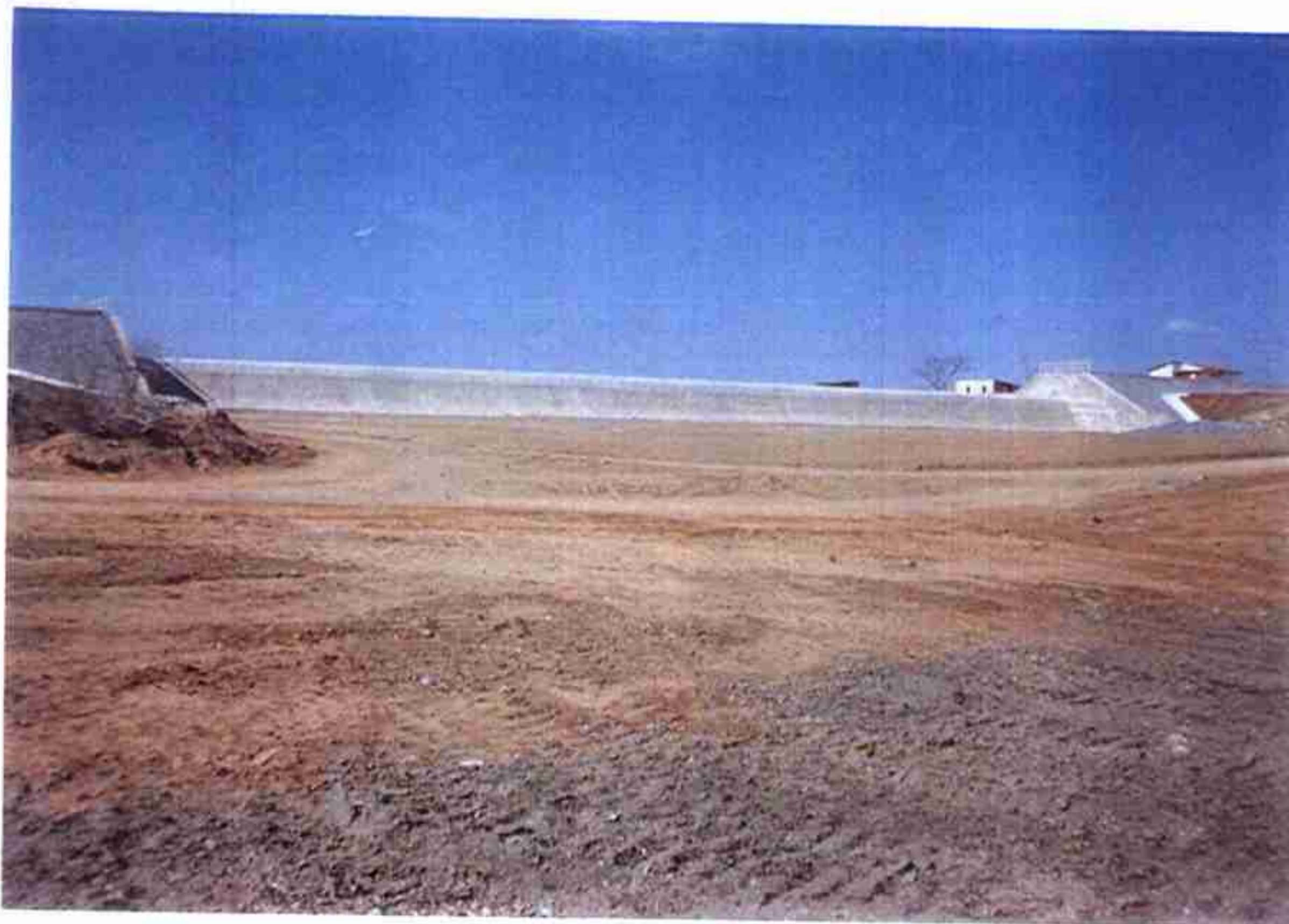
Vista geral do "PERFIL CREAGER" do Sangradouro.
