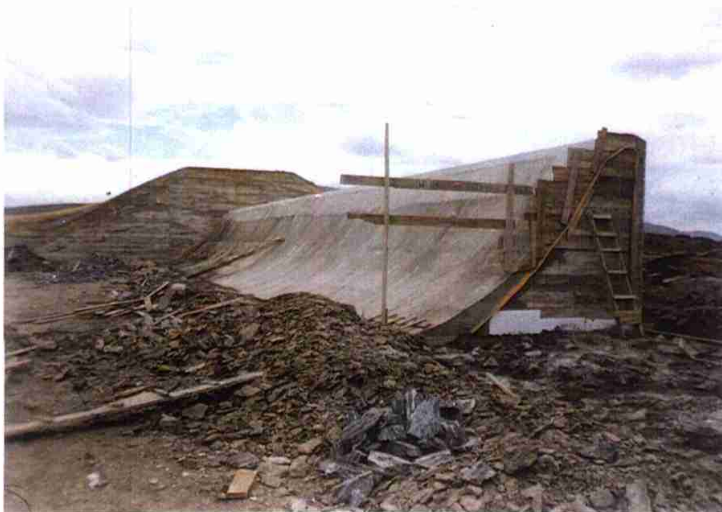
Vista do PERFIL CREAGER do Sangradouro – Bloco 1 e 2 concluídos.
