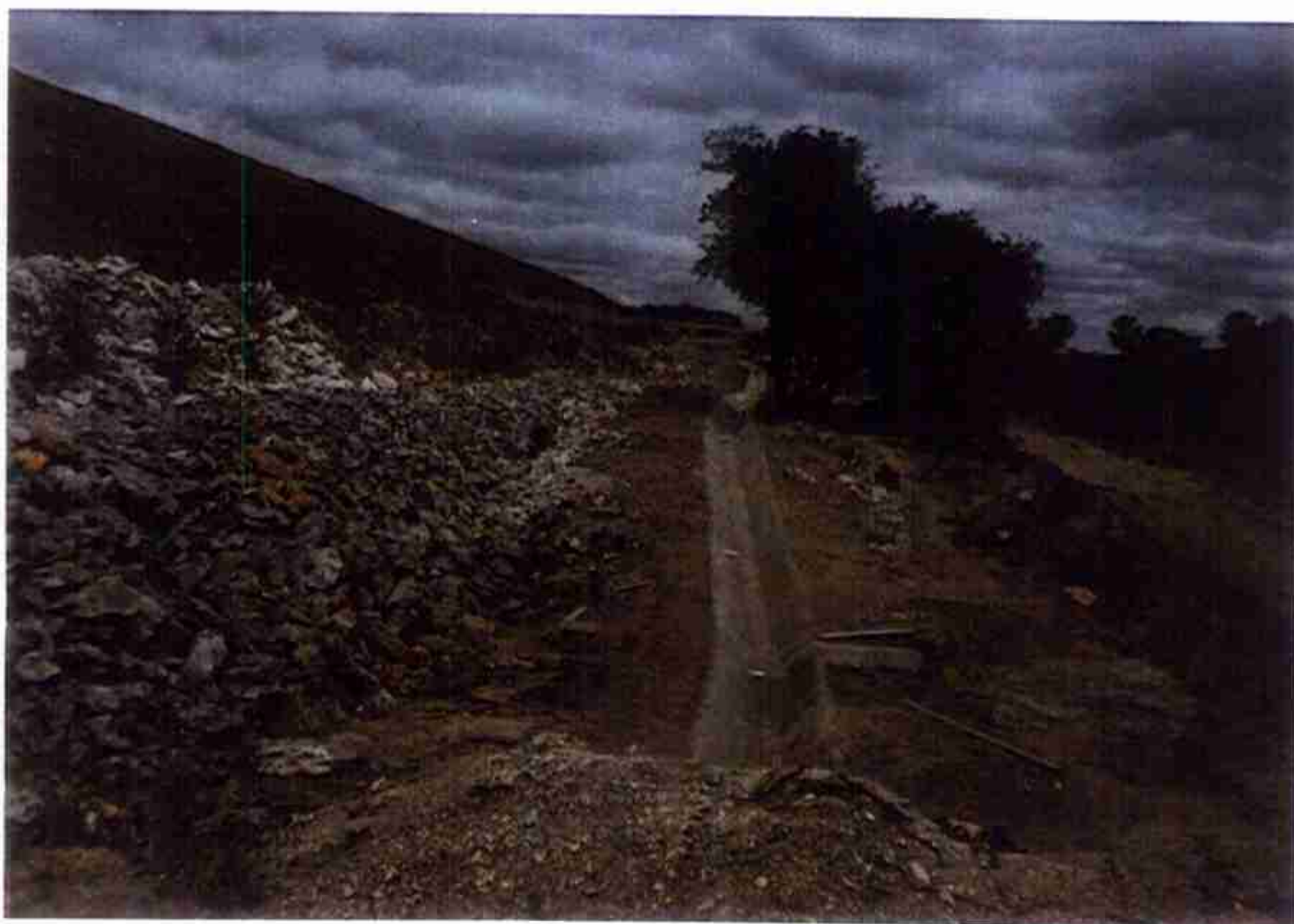
Vista de Sarjeta Coletora dos Poços de Alívio.
