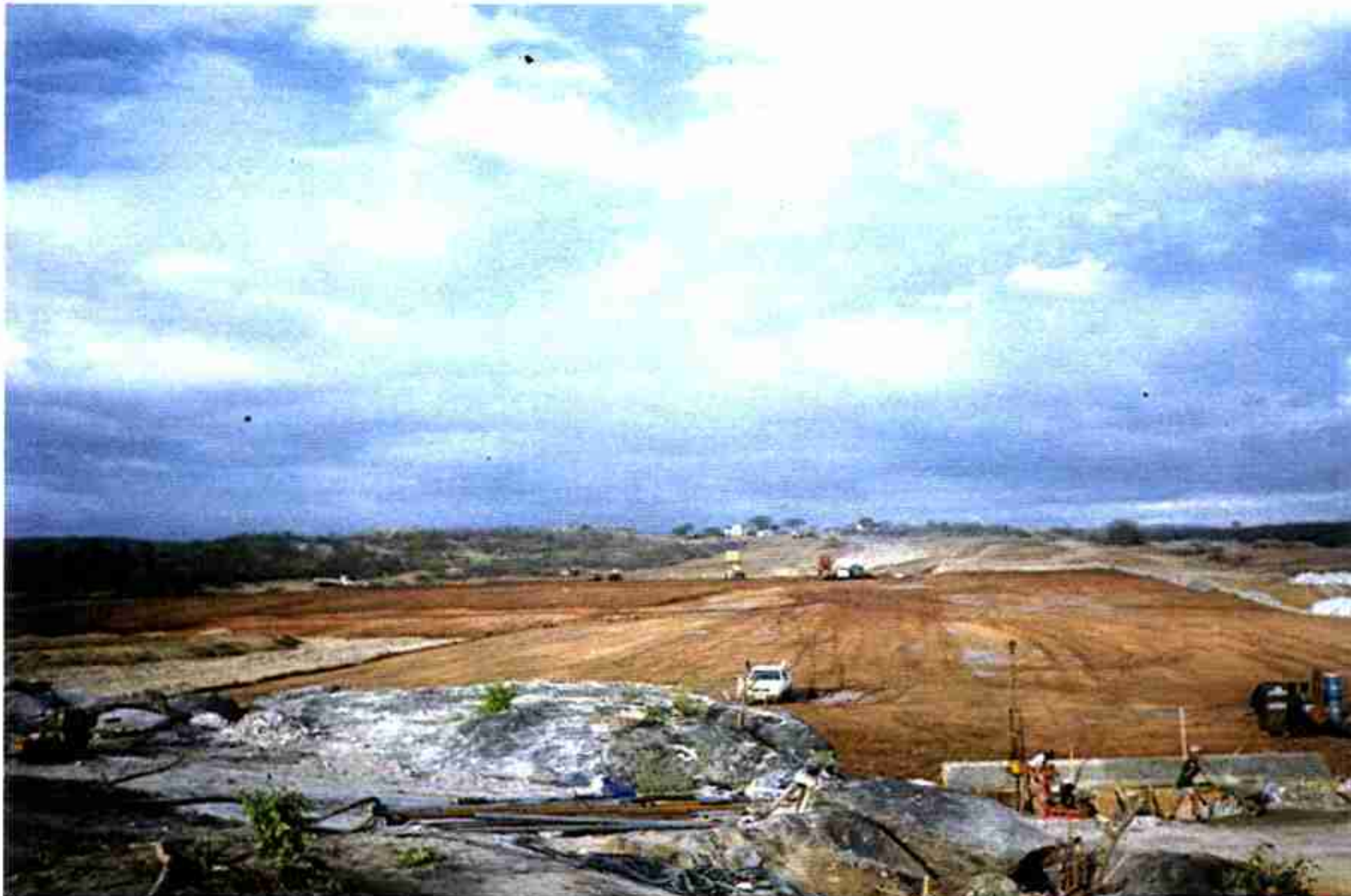
Vista geral da Barragem: Ombreira direita, contato do maciço com ombreira direita, maciço sílico-argiloso, tapete impermeável à esquerda e ombreira esquerda ao final.
