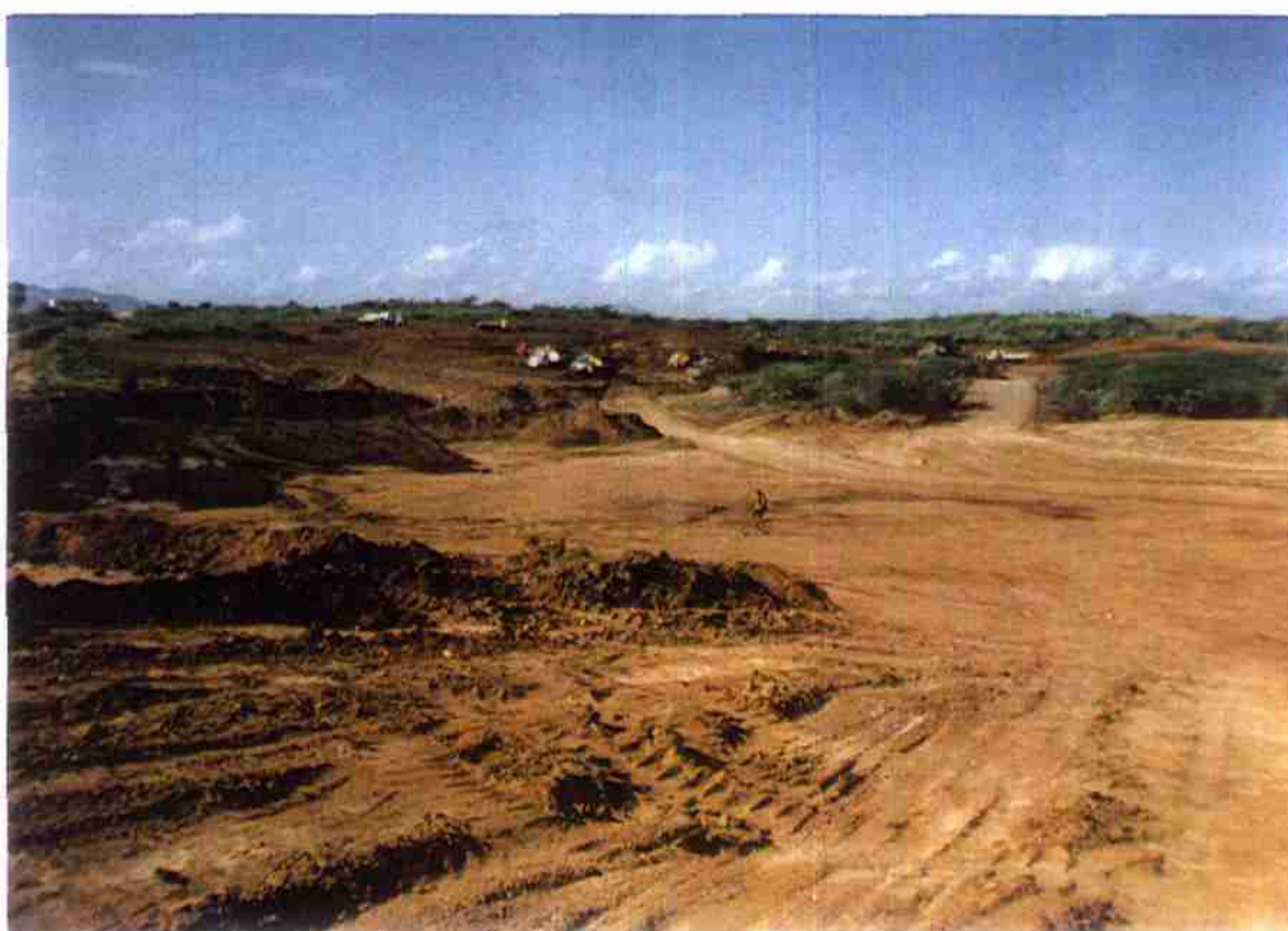
Vista da área de empréstimo terroso – Jazida J-6.
