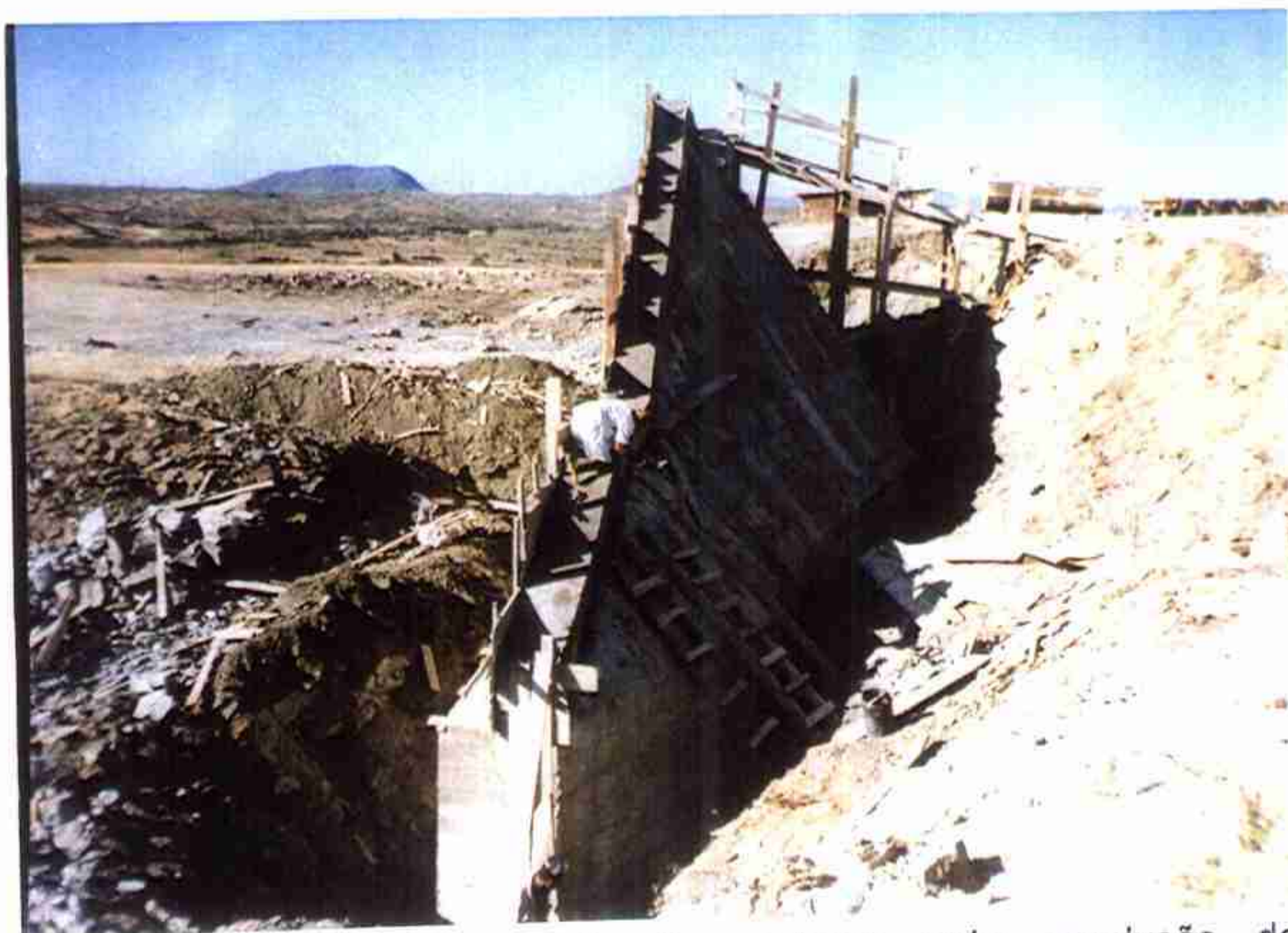
Vista do início da tomada da concretagem do Muro Esquerdo do Sangradouro a partir da cota 159,000.
