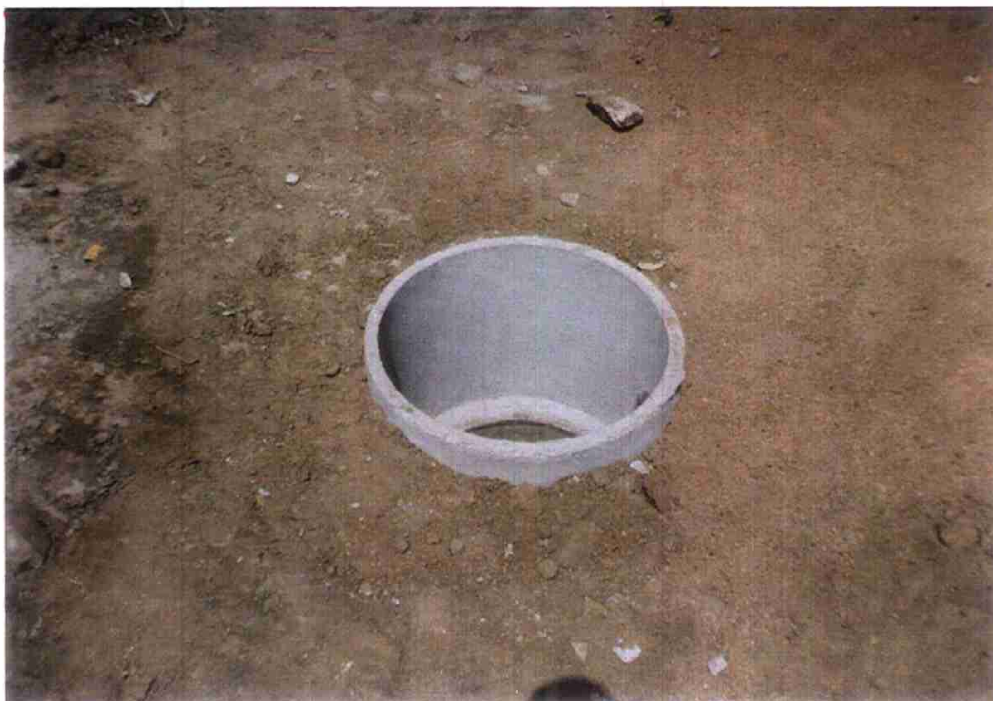
Vista de Poço de Alívio já concluído esta 9+4,00m a jusante.
