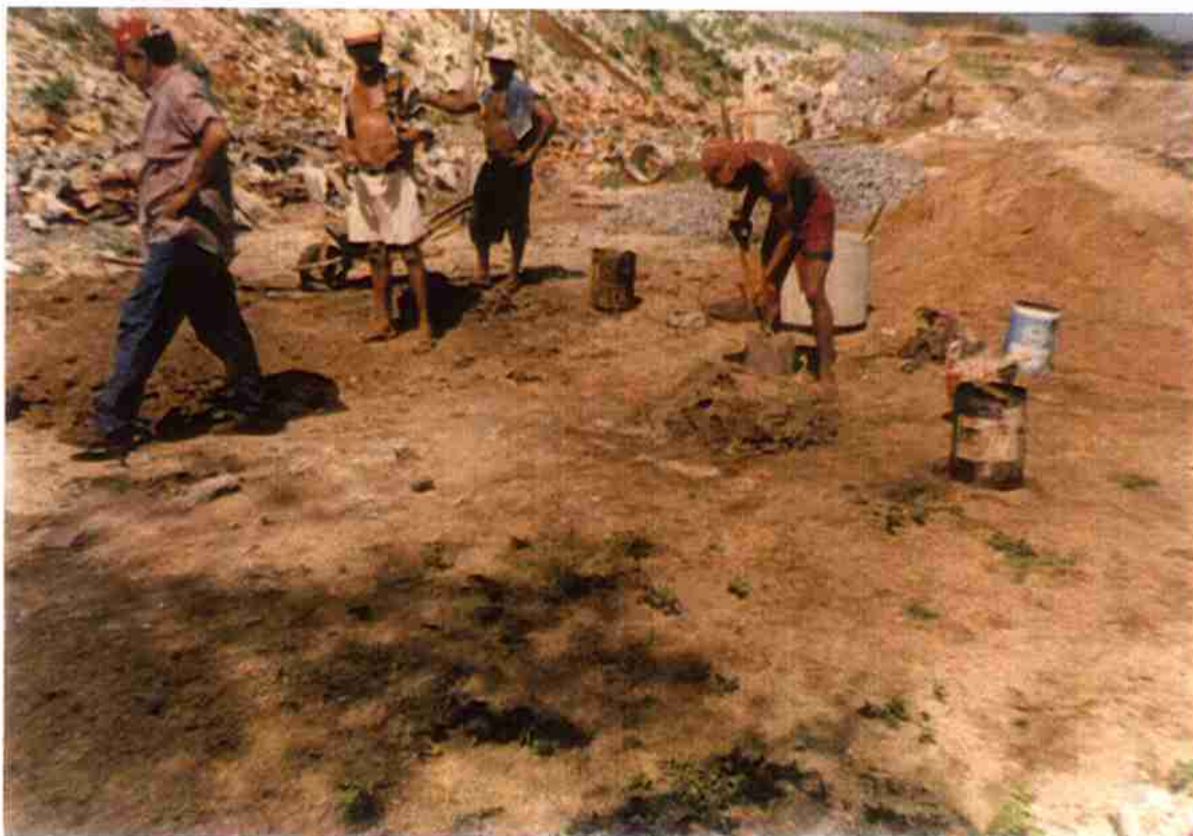
Vista de poço de alívio em fase de execução.
