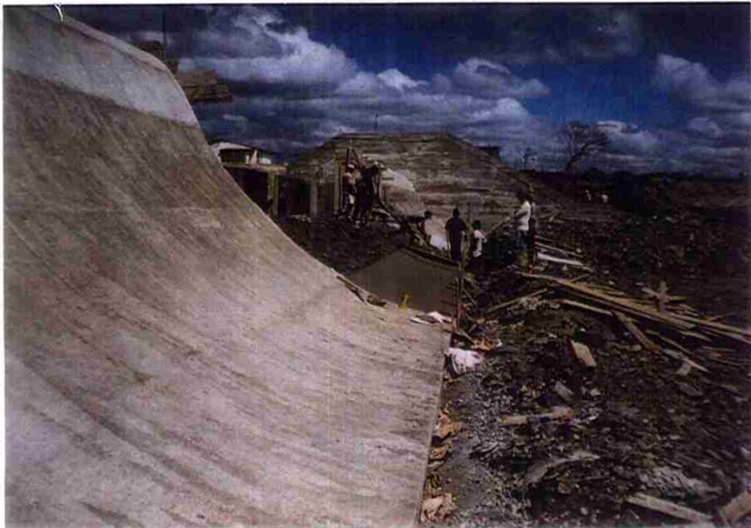
Vista de fase da concretagem do Bloco "4" do PERFIL CREAGER acima da cota 159.
