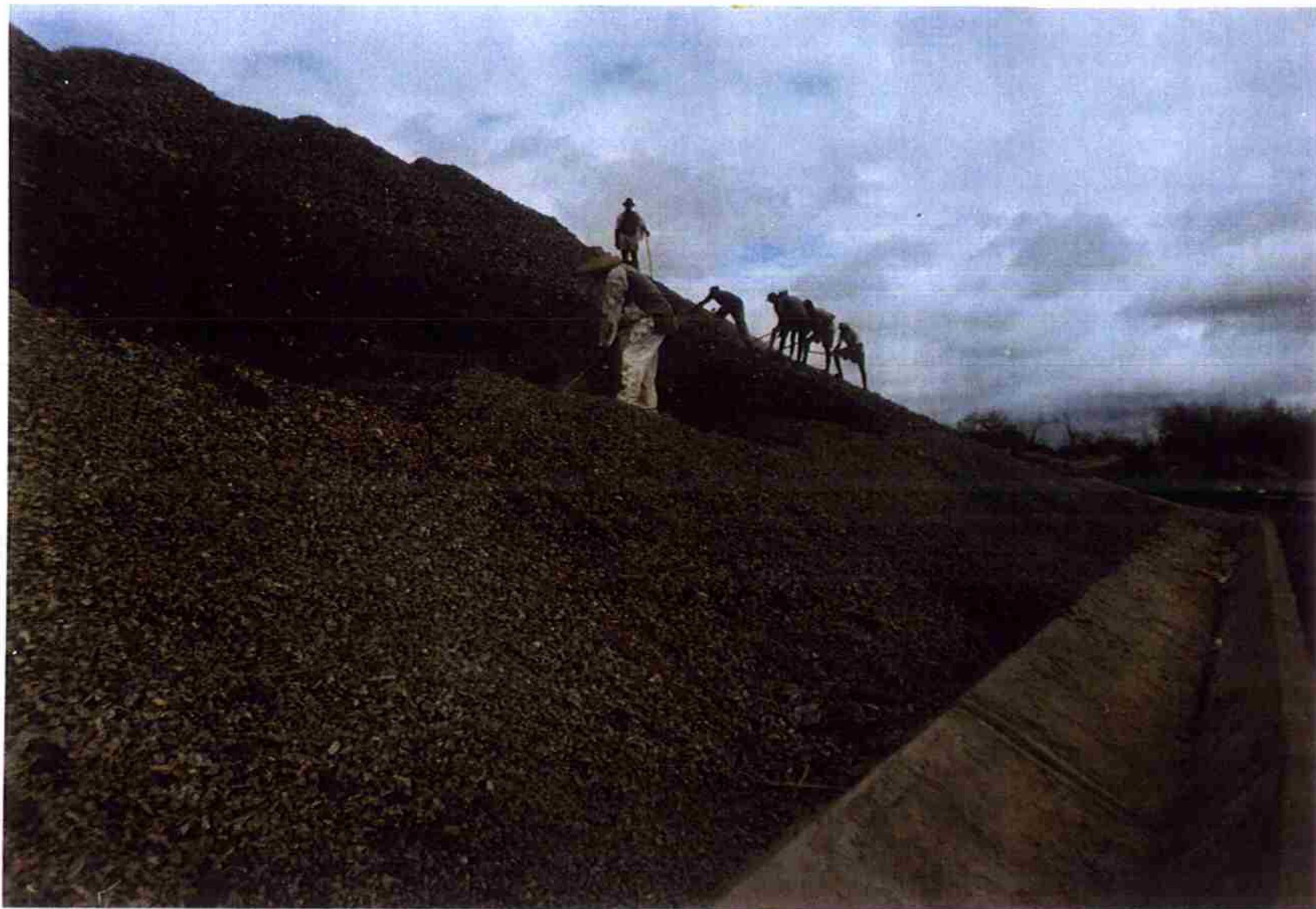
Vista do Talude Jusante em fase de revestimento com Brita e detalhe de Sarjeta Coletora Ombreira Esquerda.
