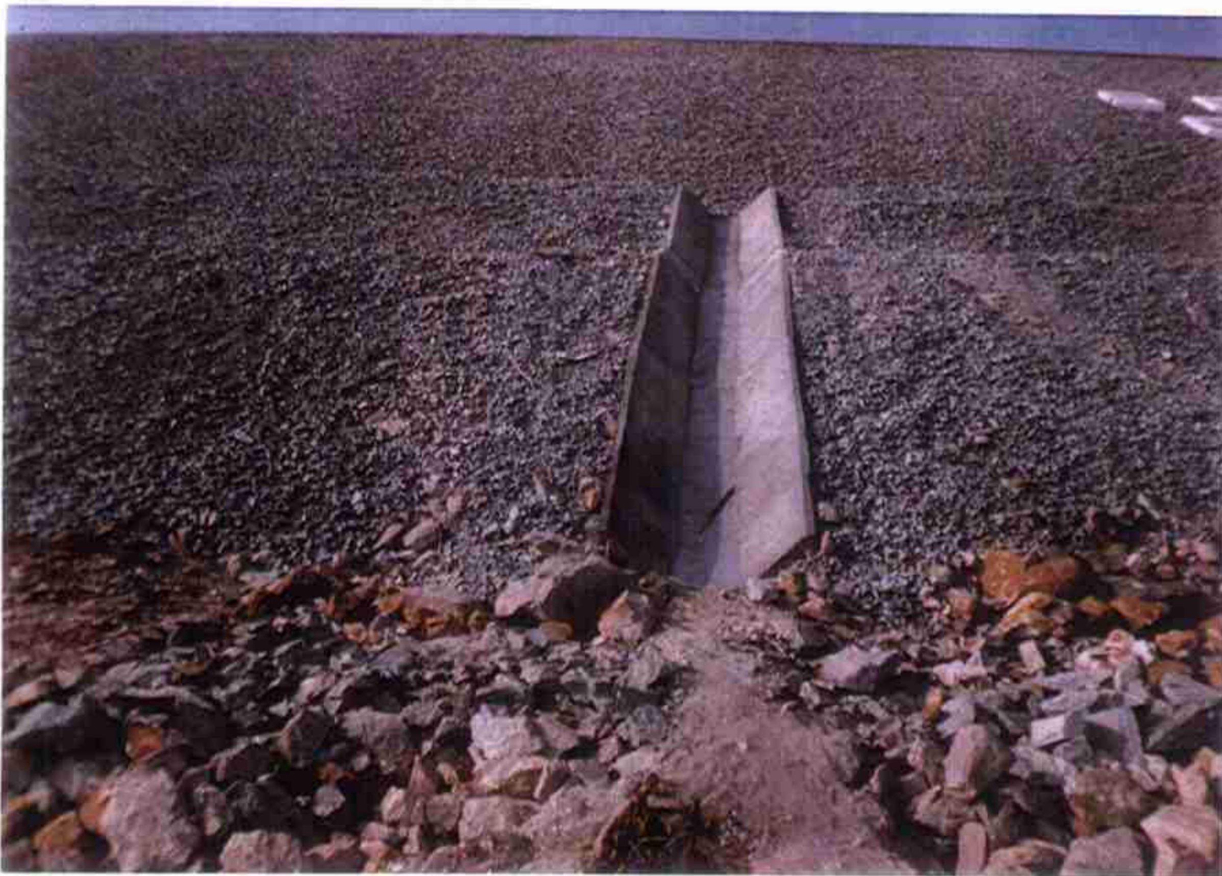
Vista da Descida D'água estaca 11.
