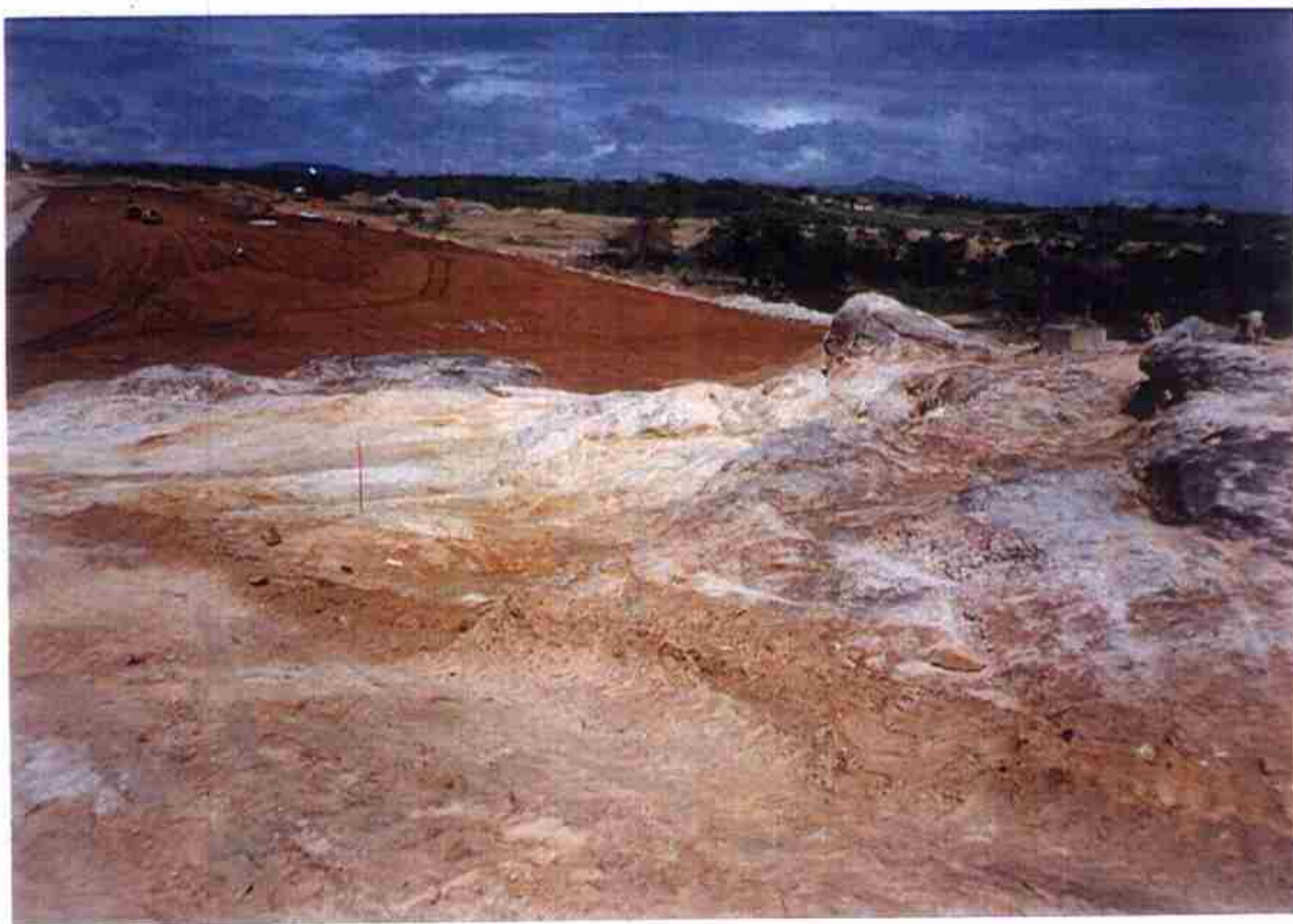
Vista geral do maciço sílico argiloso onde se vê a rocha da ombreira direita após limpeza da fundação.
