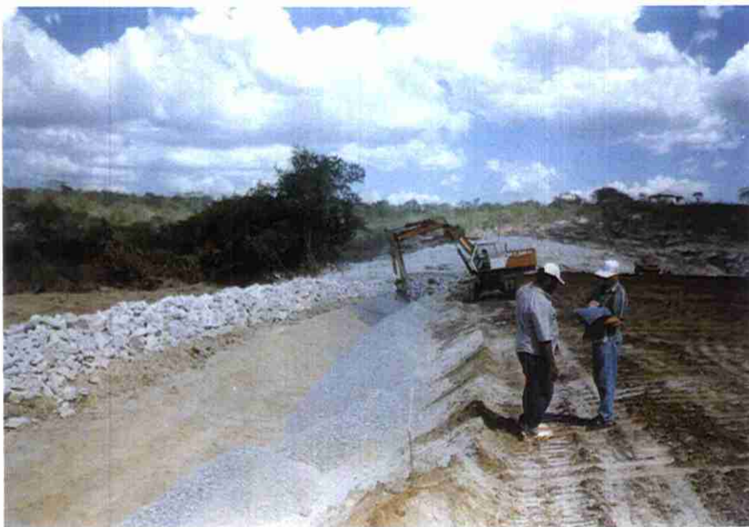
Detalhe da execução do "Rock-Fill" à jusante onde mostra detalhe da transição fina e grossa.
