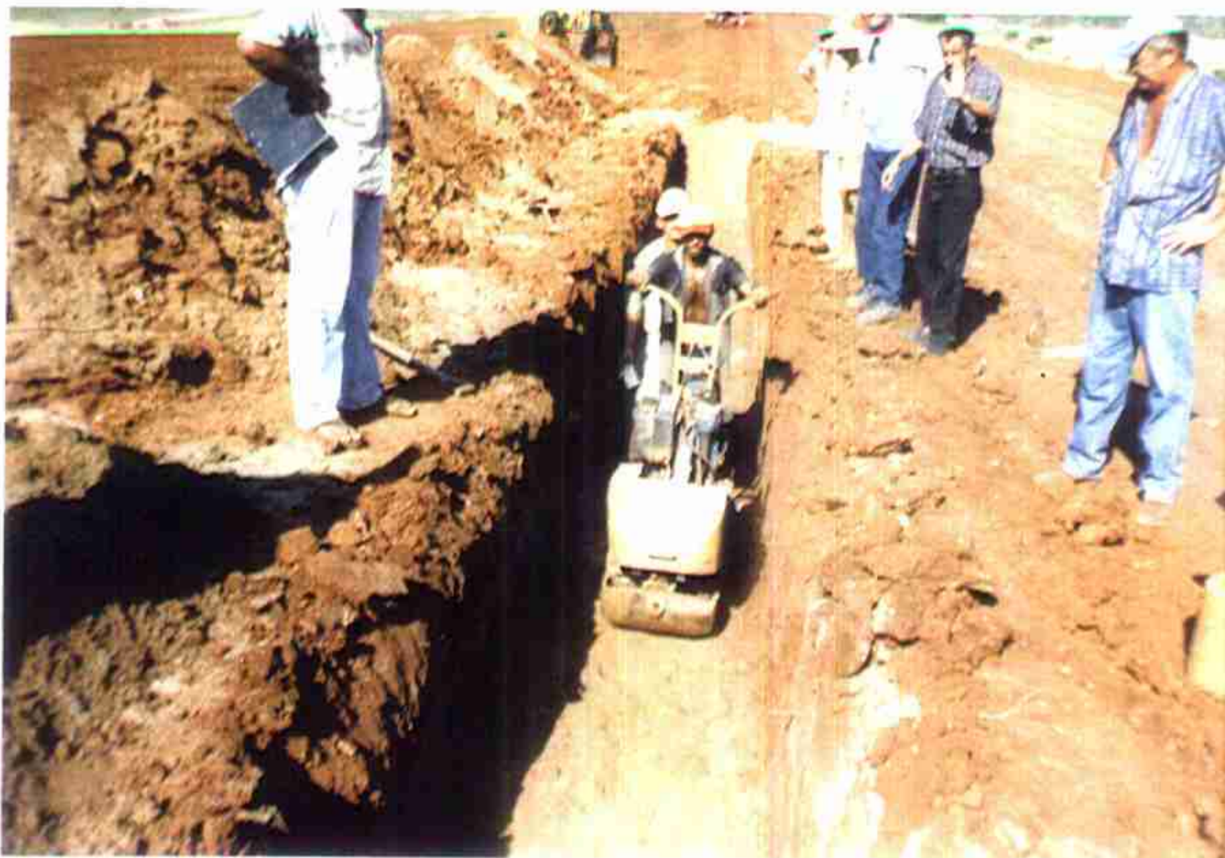
Vista de fase da execução do Dreno Vertical com compactação da areia com placa vibratória após encharcamento.
