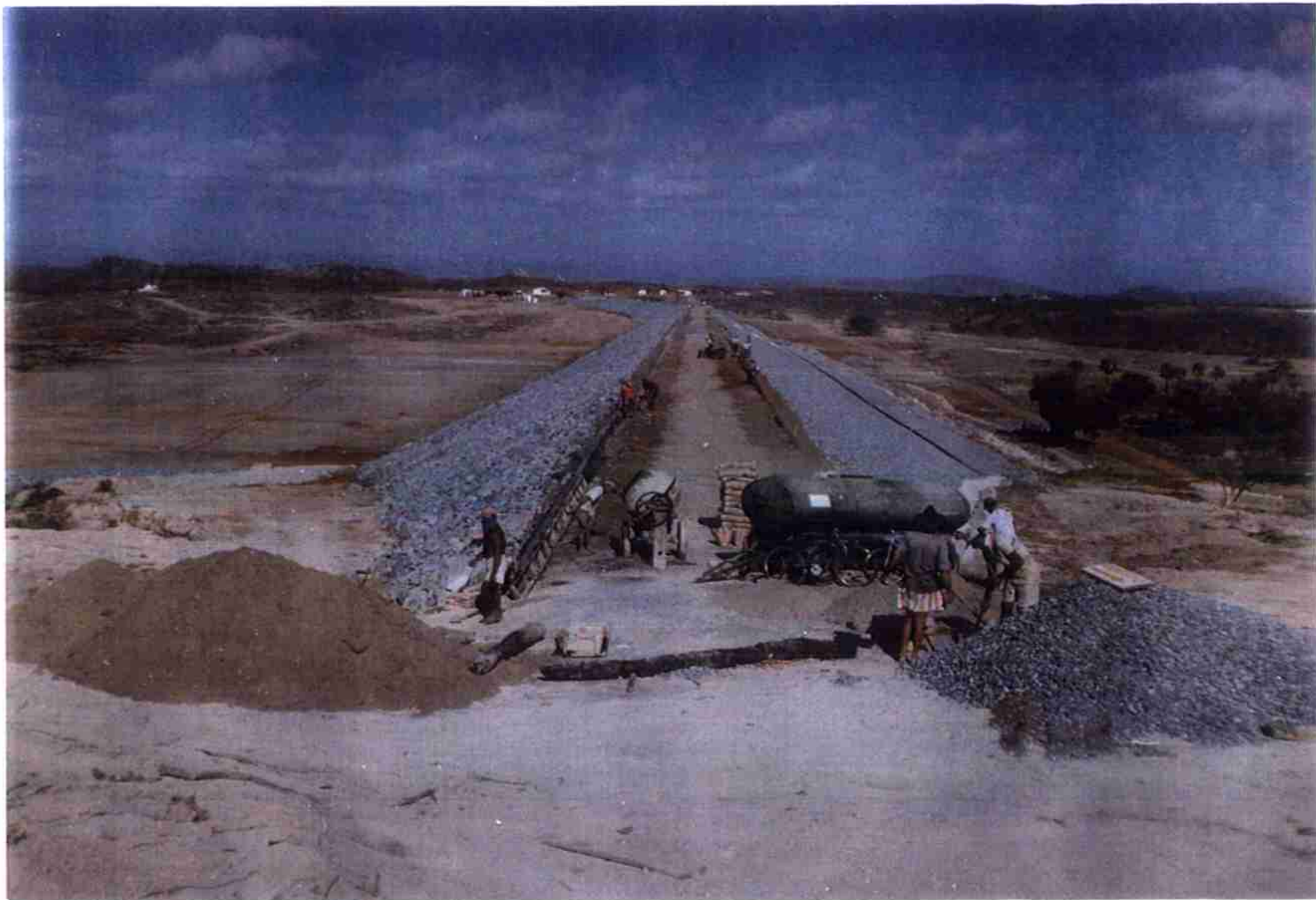
Vista geral da Barragem com meio-fio em execução.
