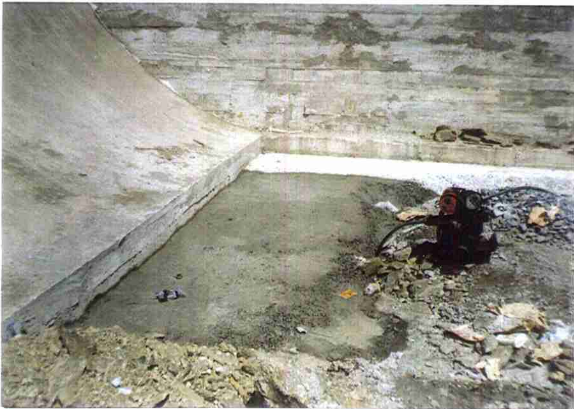
Vista da concretagem no sopé Jusante do PERFIL CREAGER cota 157,700.
