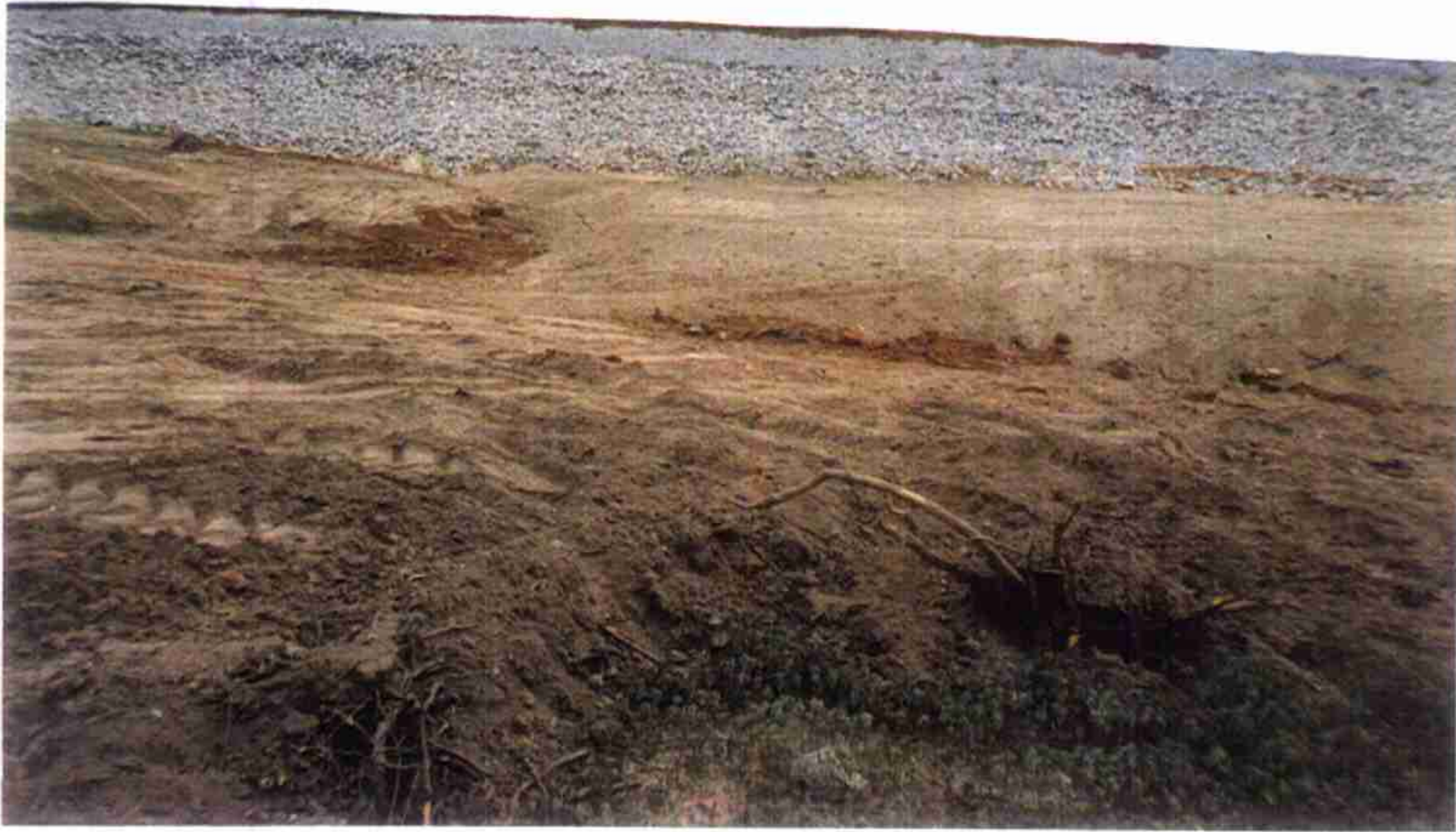
Vista do complemento do Tapete Impermeável estaca 19+6,00m a 20+6,00m e no fundo o Rip-Rap do talude montante.
