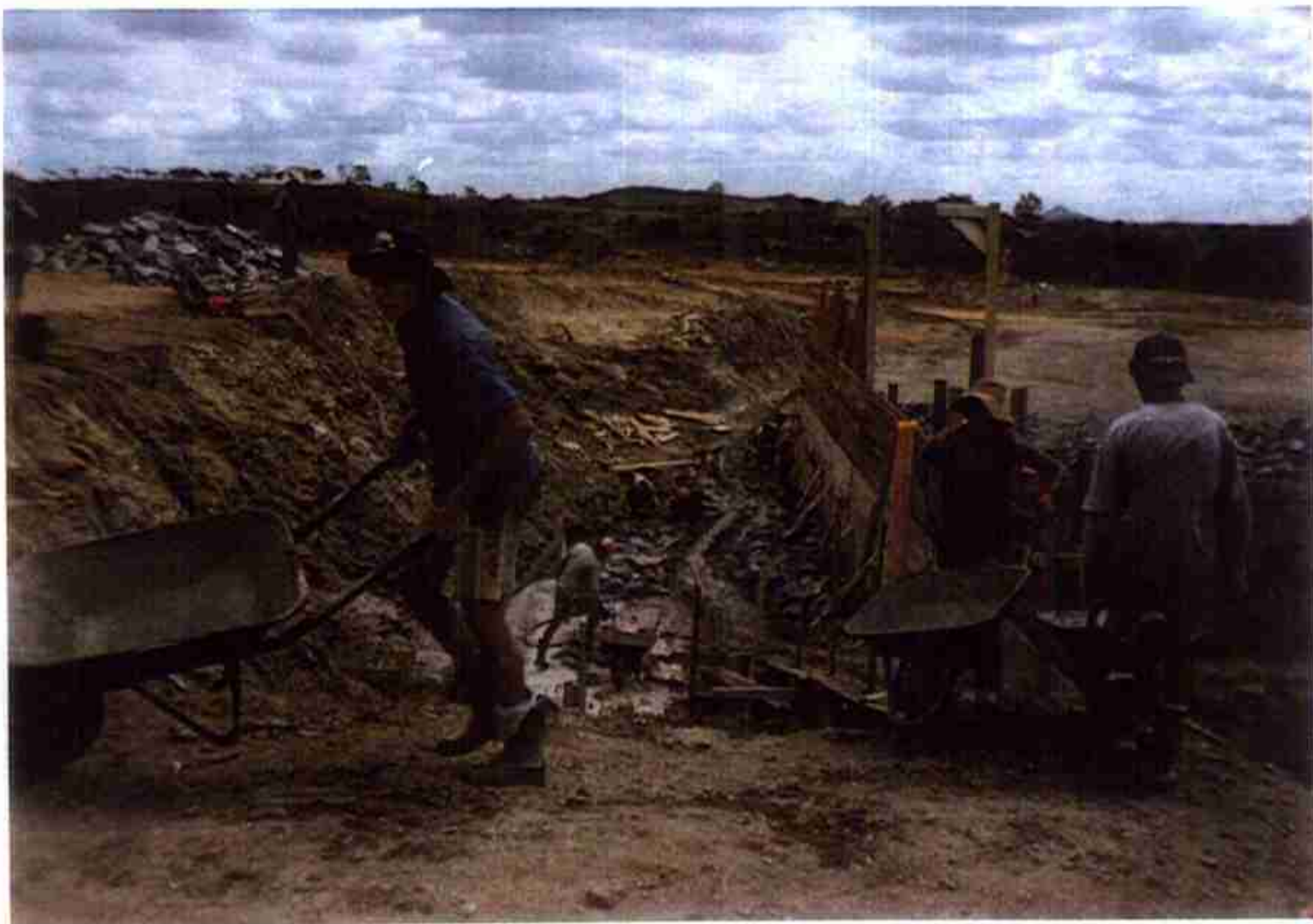
Vista do início da tomada da concretagem do Muro Esquerdo do Sangradouro a partir da cota 159,000.
