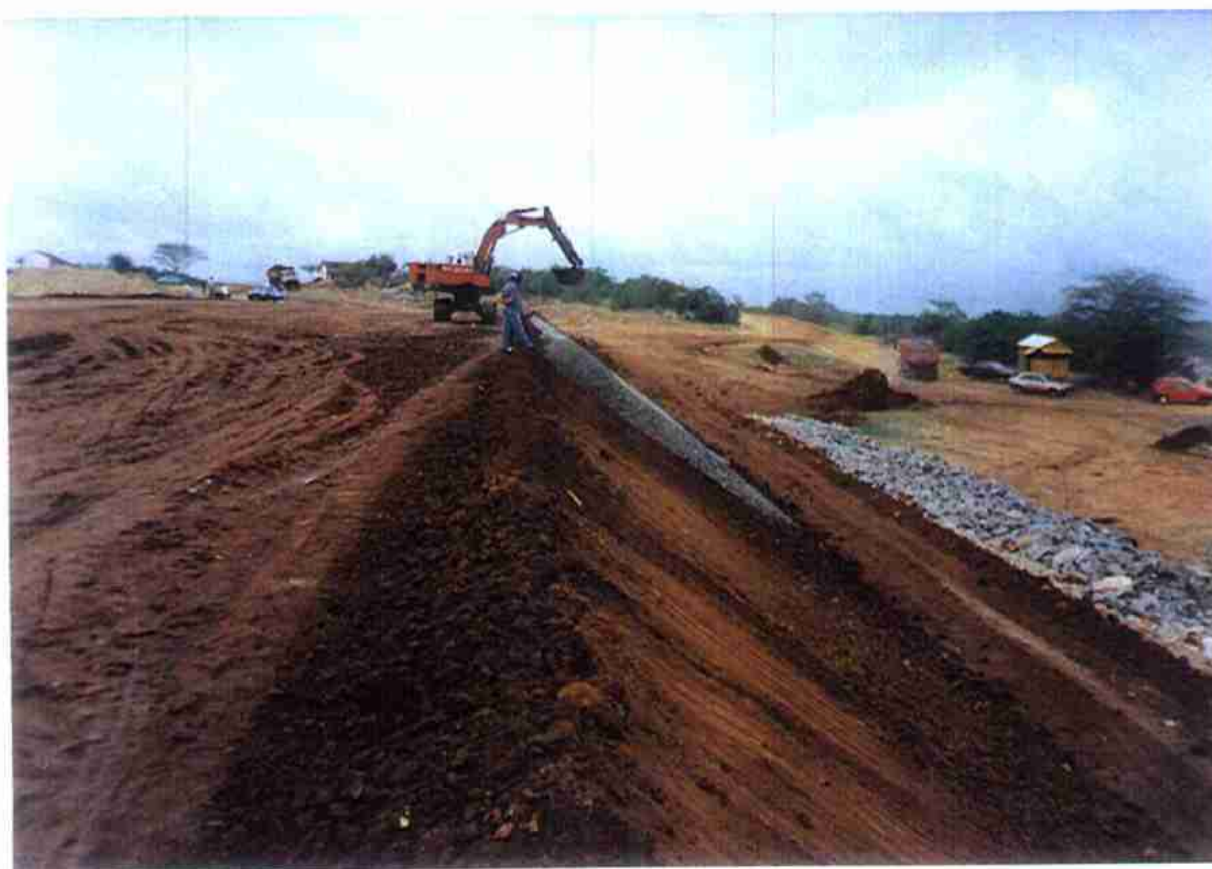
Vista do talude jusante com início da operação de proteção com camada de brita.
