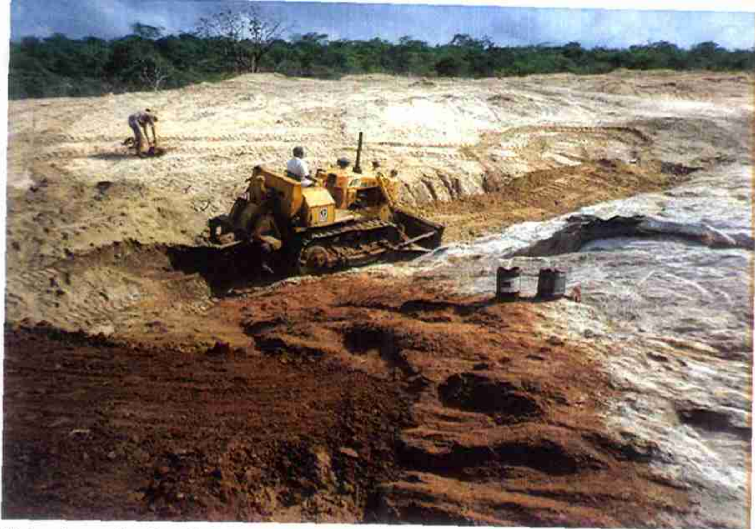
Vista da ombreira direita com aprofundamento do Cut-Off com trator D-6.
