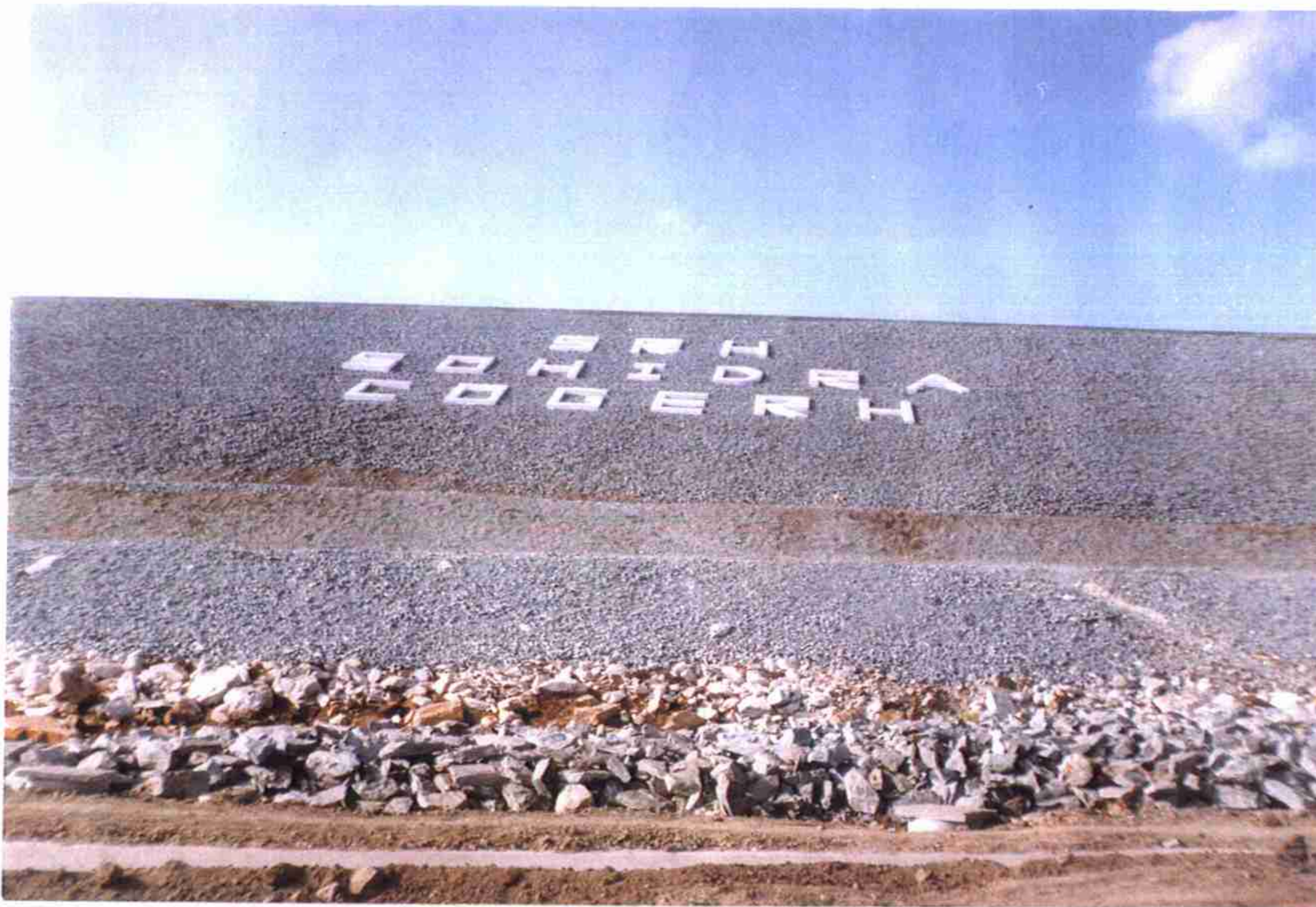
Vista do Talude Jusante revestido com brita de 1 a 3" e detalhes das siglas "SRH, SOHIDRA e COGERH".
