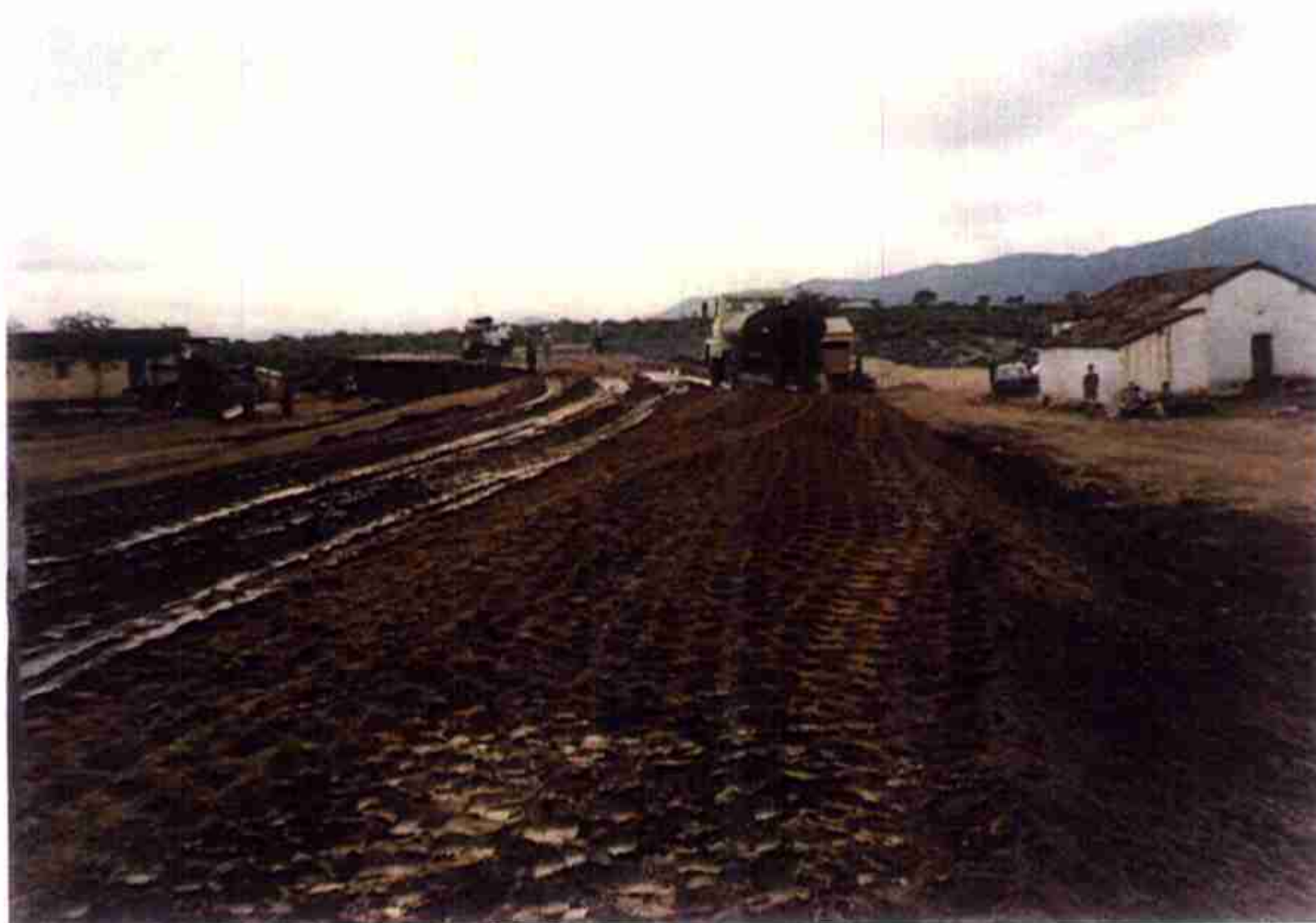
Vista do maciço sílico argiloso em fase de compactação da camada final esta 29 a 33.
