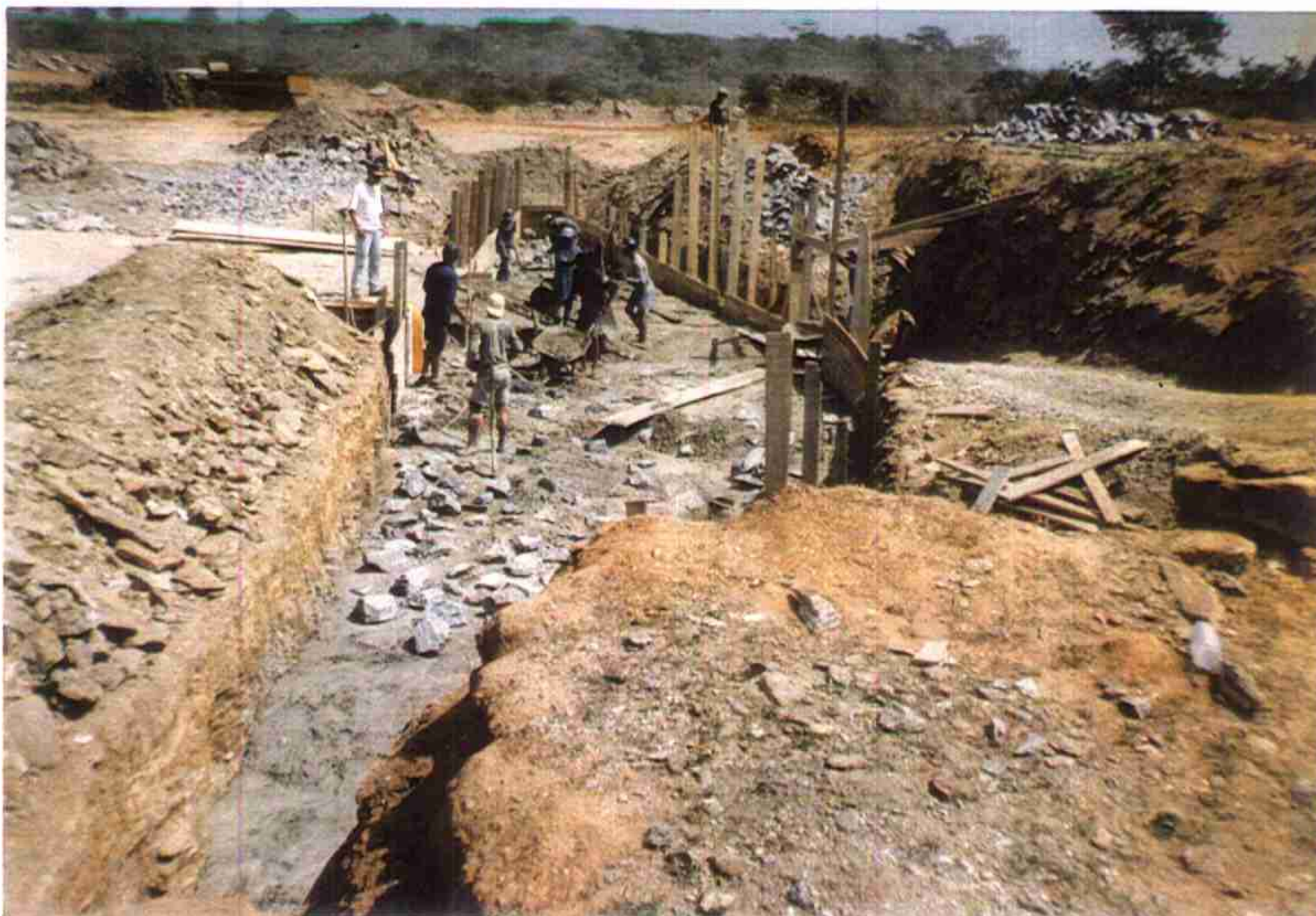
Vista do muro direito do Sangradouro em fase de concretagem com concreto ciclópico (250kg de cimento/m 3 ) 12% de pedra de mão.
