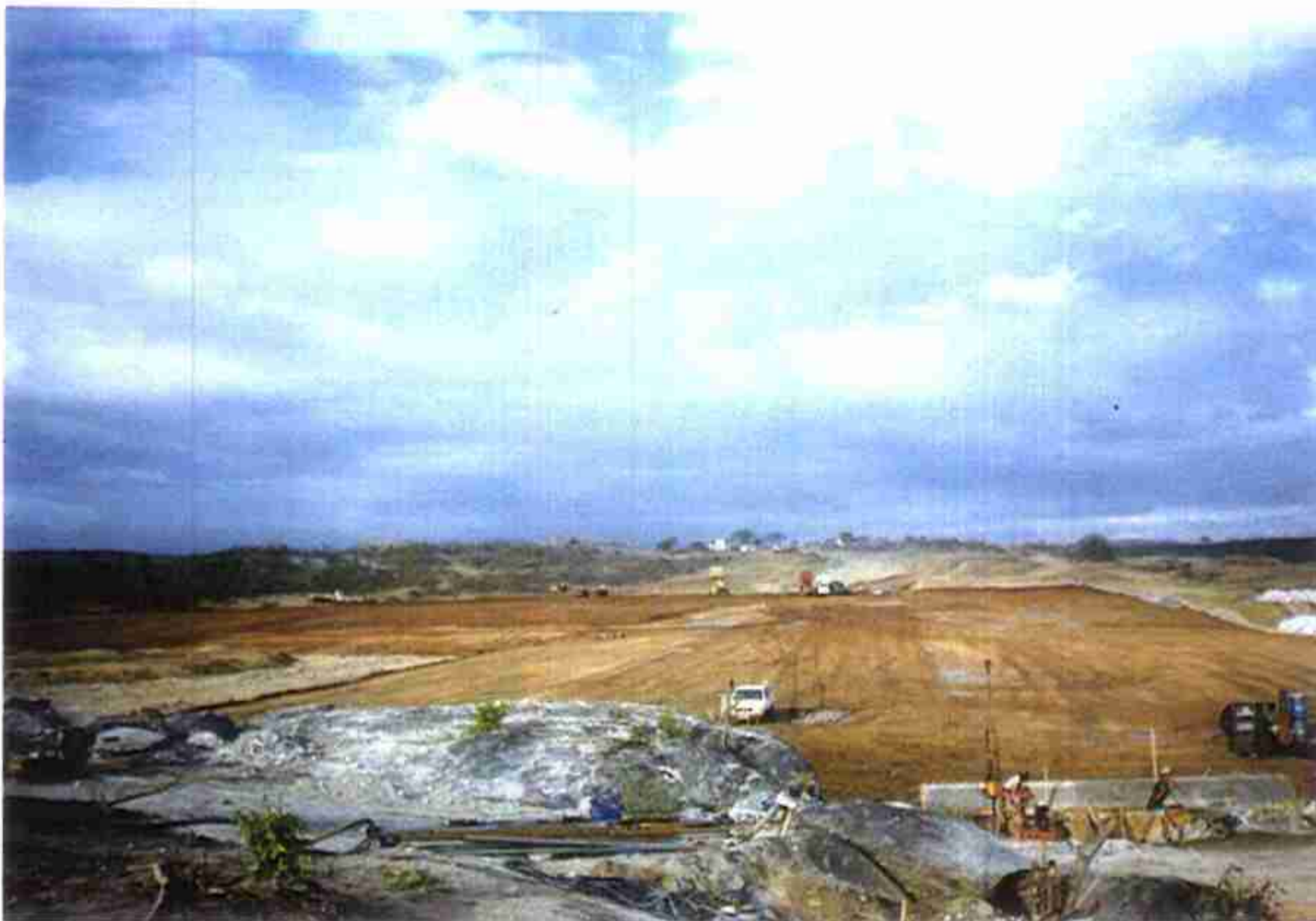
Vista geral da Barragem: Ombreira direita, contato do maciço com ombreira direita, maciço sílico-argiloso, tapete impermeável à esquerda e ombreira esquerda ao final.
