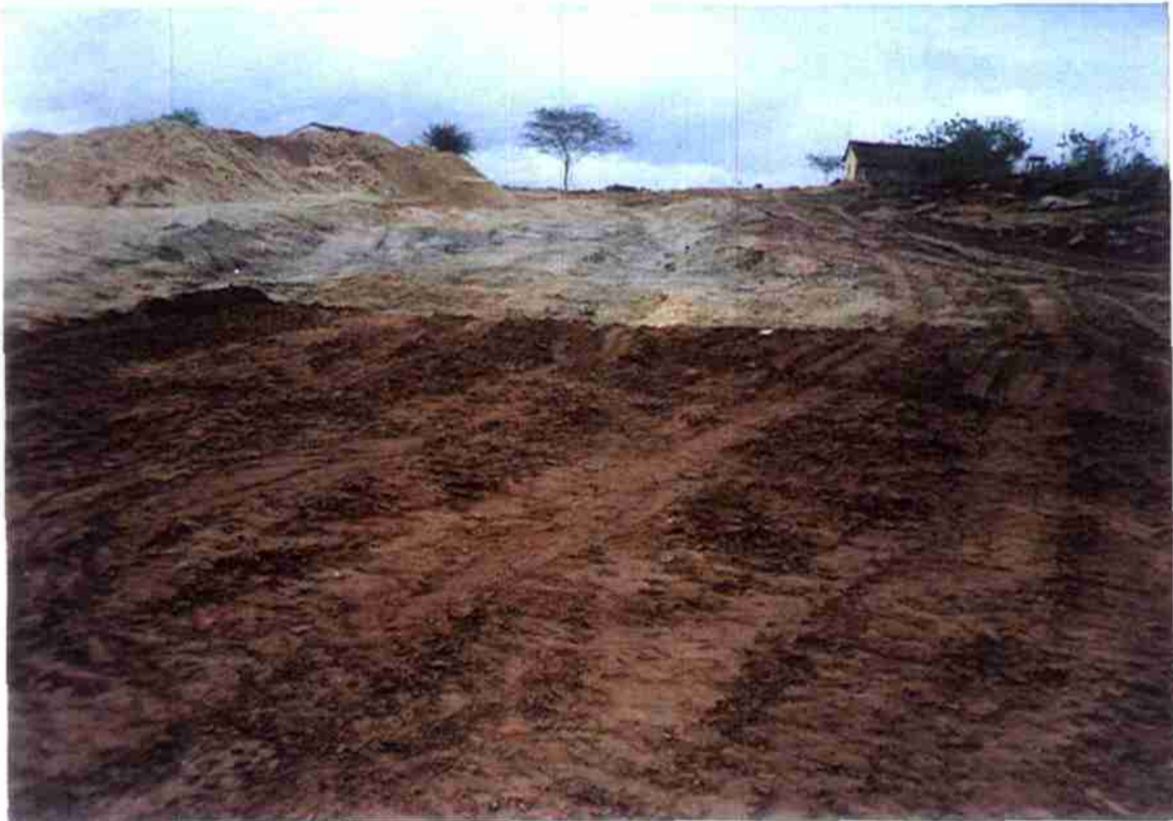
Vista do maciço sílico argiloso avançando na ombreira esquerda.
