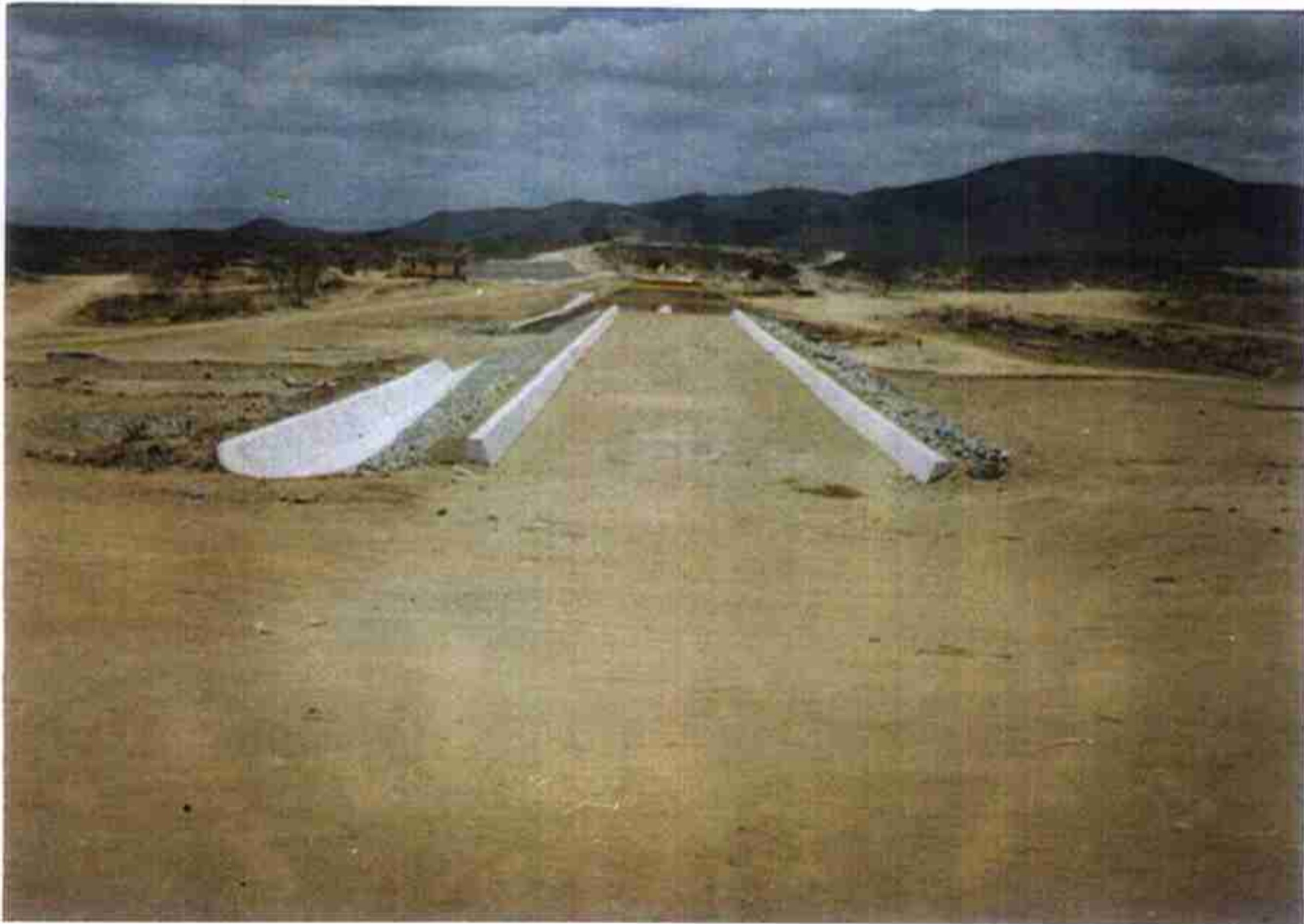
Vista da Barragem a partir da estaca 40+13,00m.
