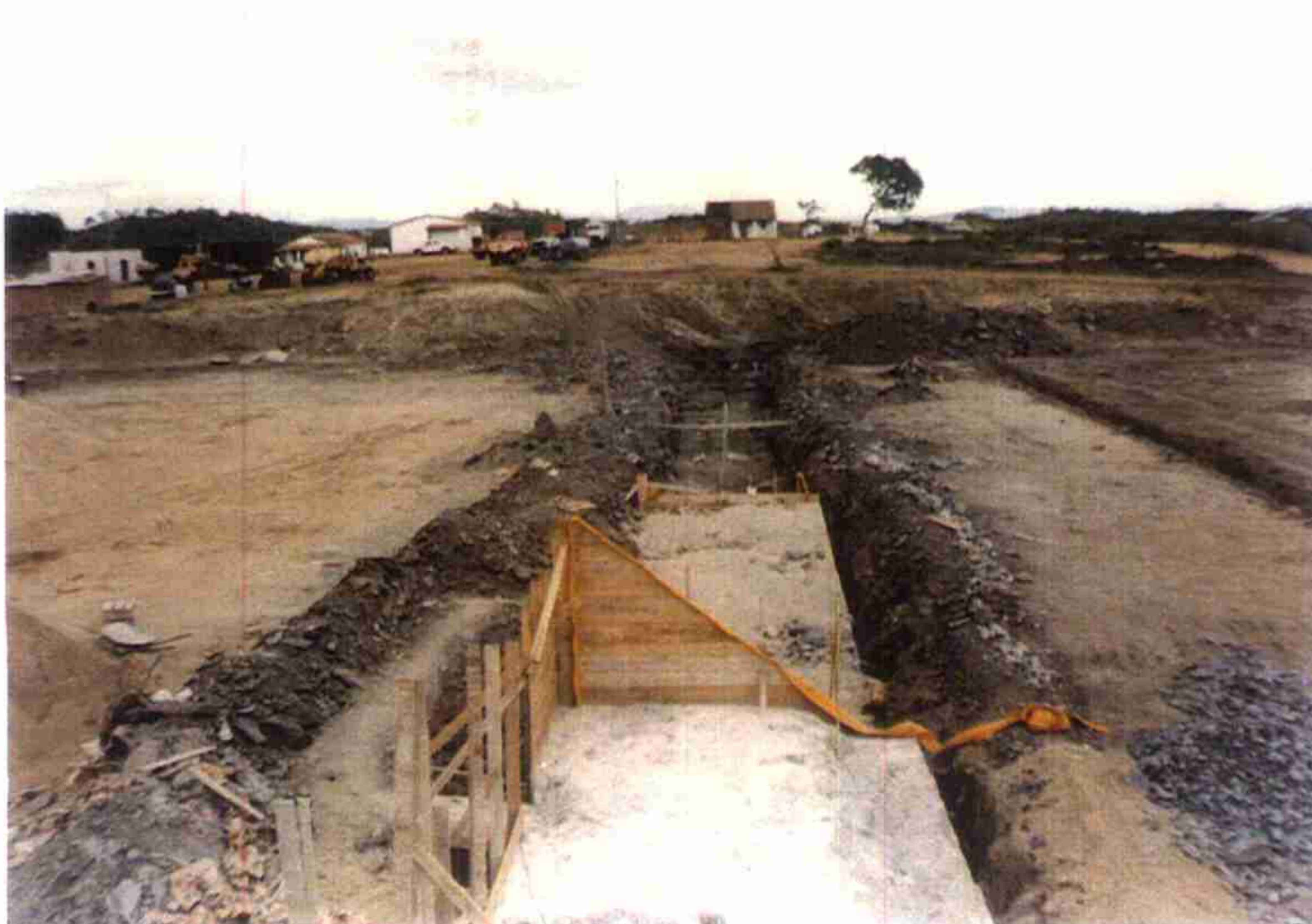
Vista de blocos de concreto da fundação do Perfil Creager do Sangradouro.
