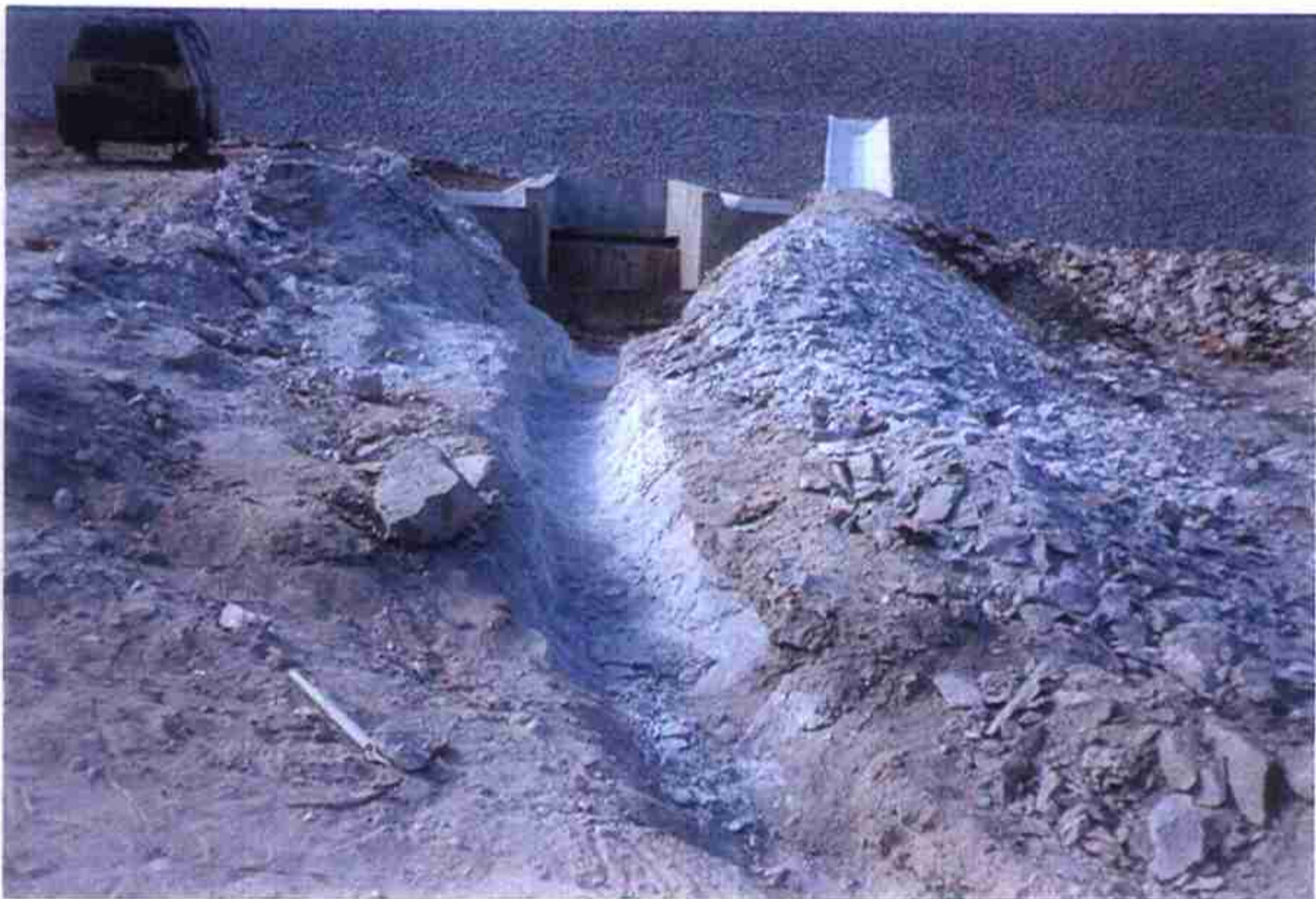
Vista do Canal de Escoamento da Caixa de Saída da Tomada D'água.
