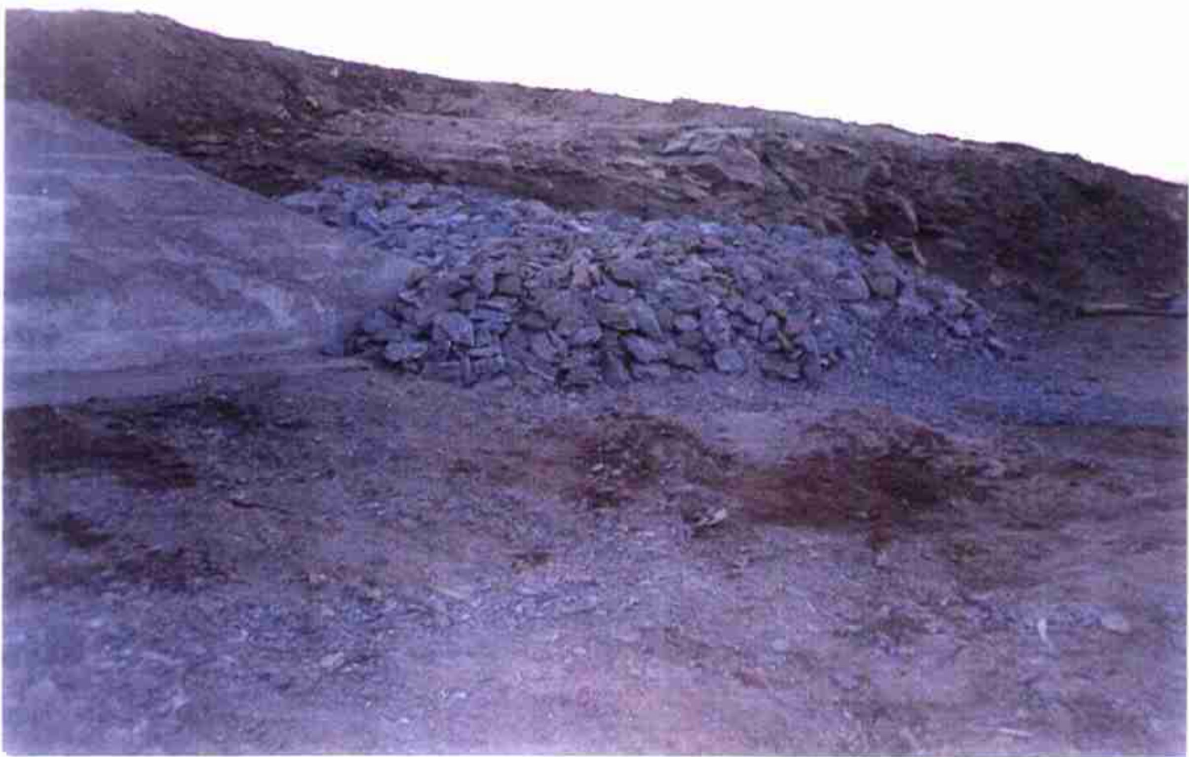
Vista do enrocamento na extremidade do Muro Esquerdo.
