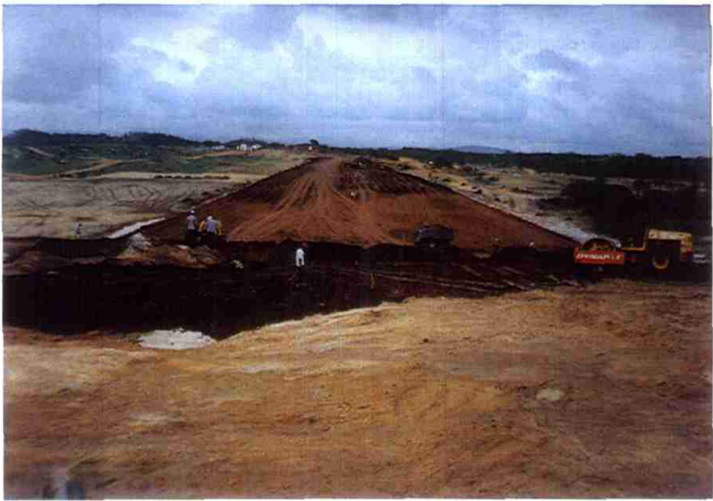
Vista geral do maciço sílico argiloso avançando na ombreira direita.
