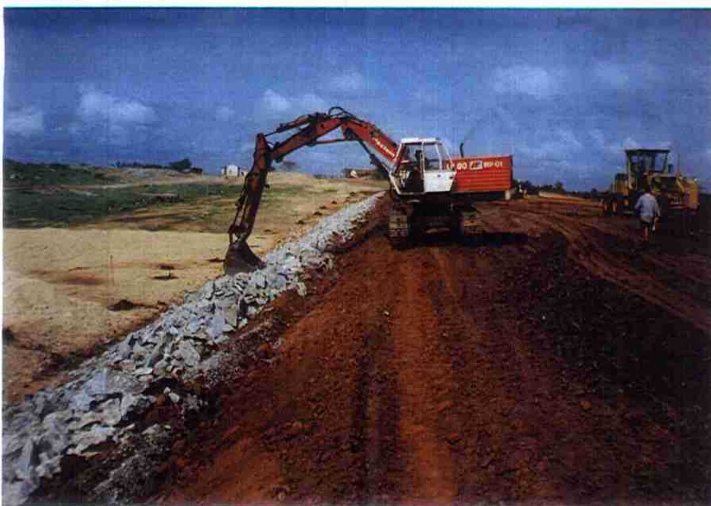
Vista do talude montante com operação de execução do RIP-RAP.
