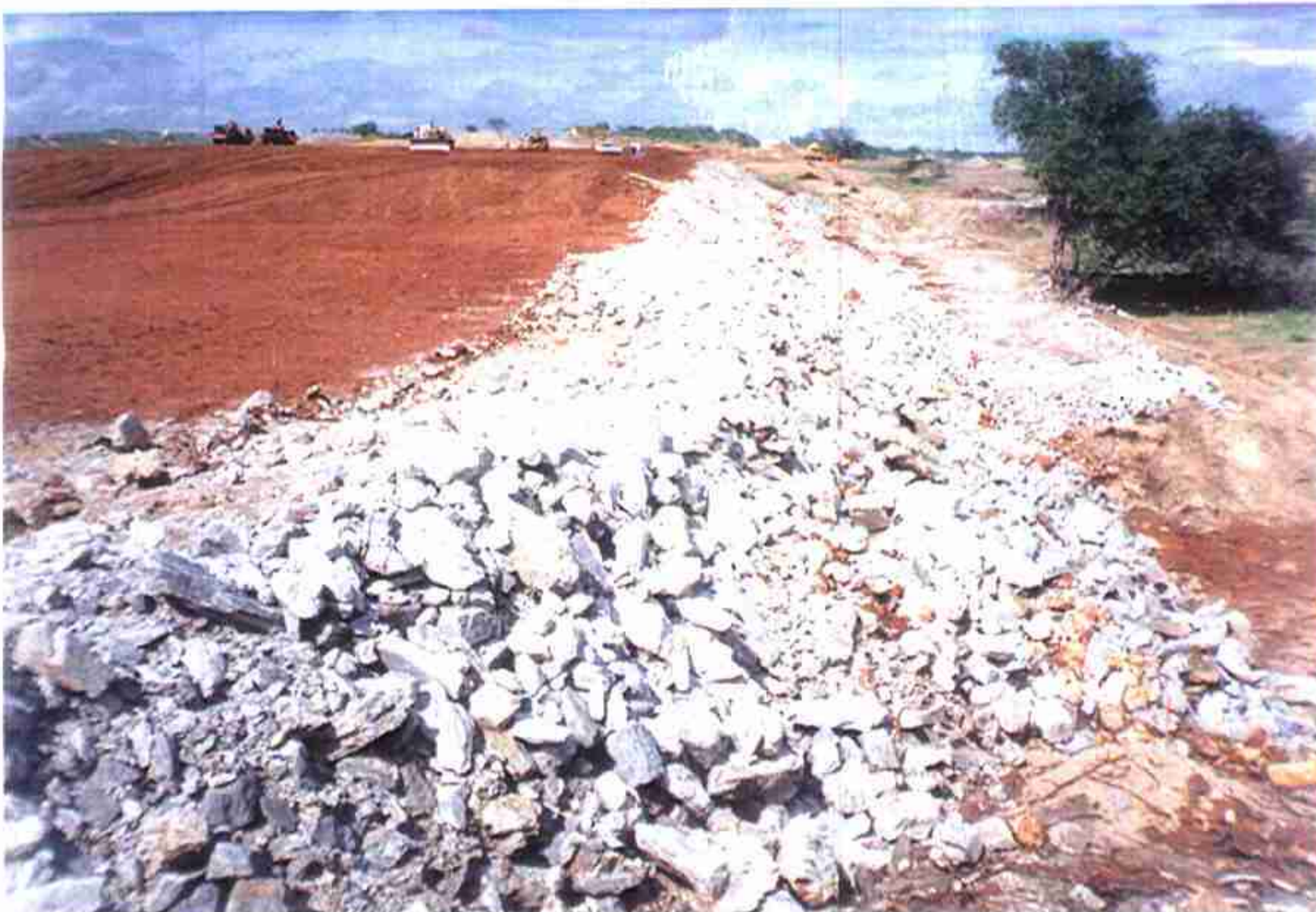
Vista da proteção com rocha alterada no talude jusante onde se vê enrocamento de proteção na calha do rio.
