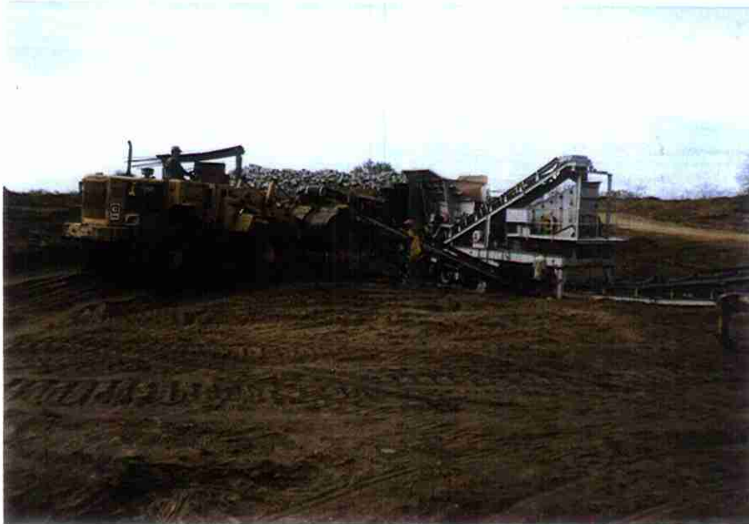
Vista da Unidade de Britagem em fase de montagem em área da Pedreira P-4.
