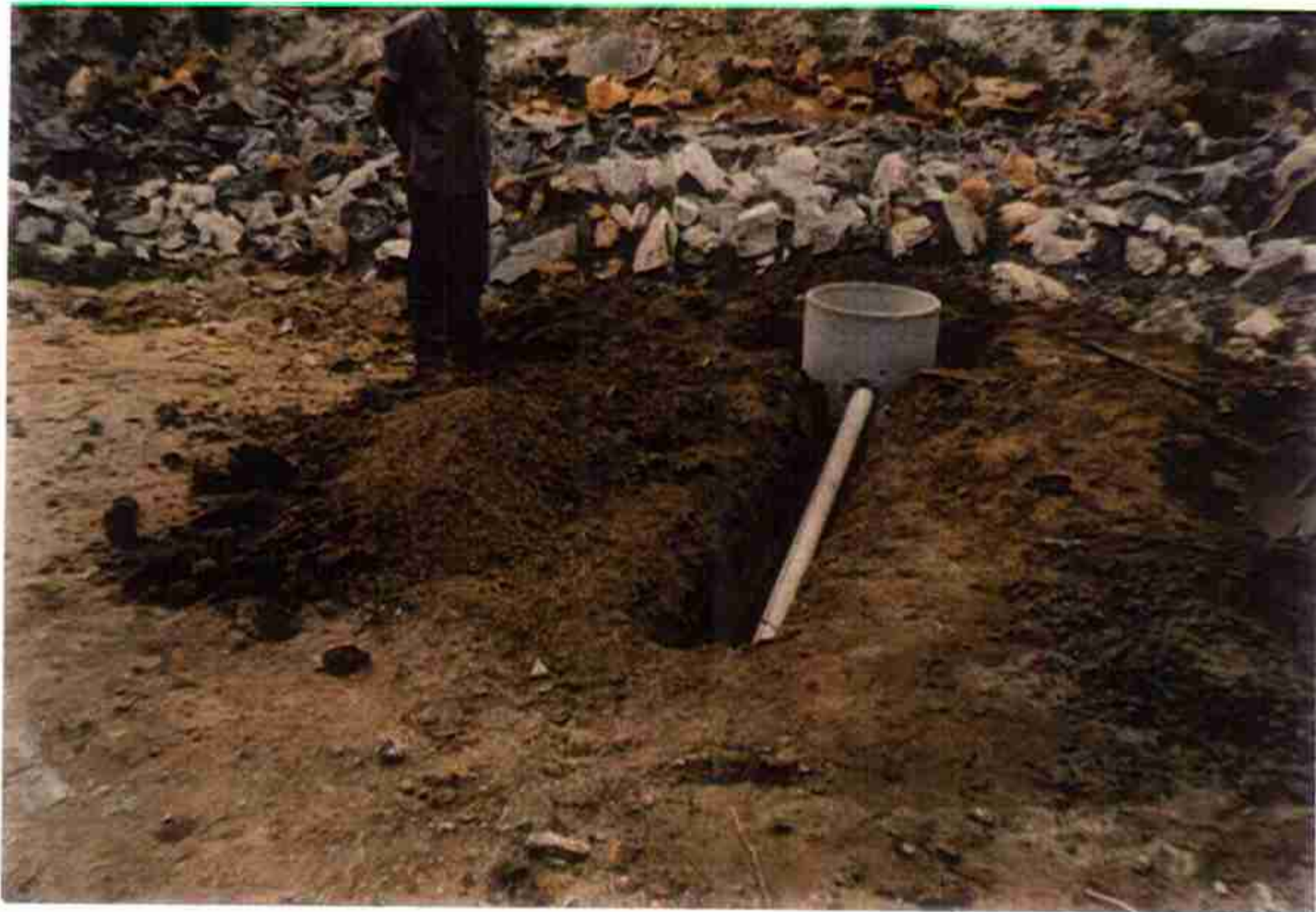
Vista de poço de alívio em fase de conclusão.
