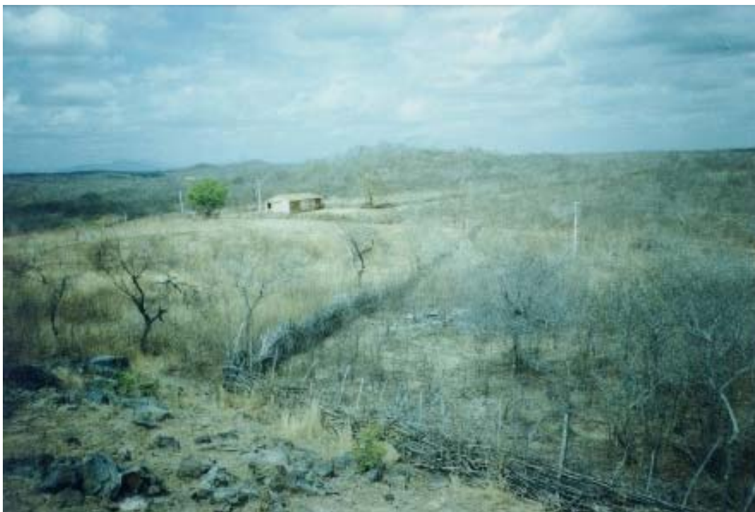
FOTO 03 – Vista da área do sangradouro a partir da ombreira esquerda do barramento.
