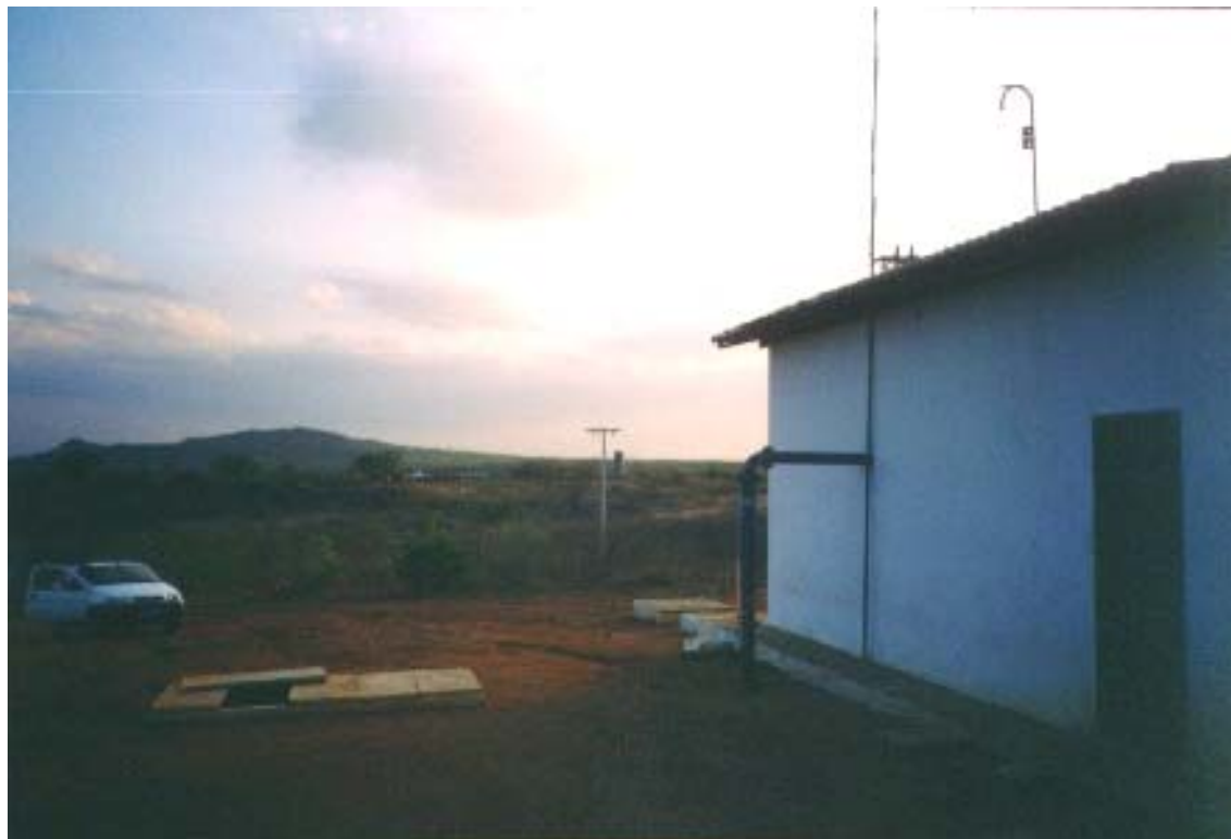
FOTO 20 – Vista do reservatório elevado de São Domingos, a partir da ETA de Caridade
