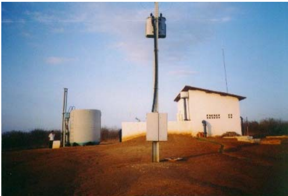
FOTO 19 – ETA de Caridade
