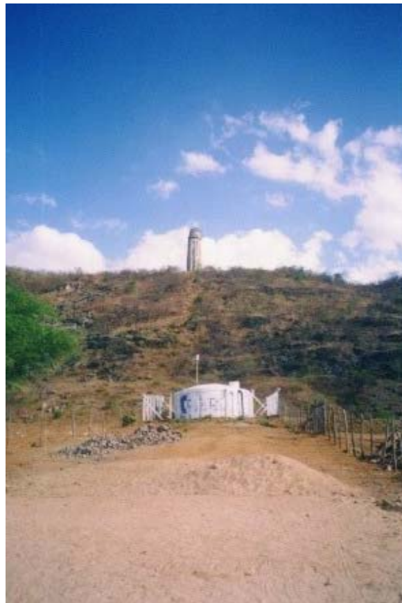
FOTO 16 – Reservatório Apoiado de Caridade
