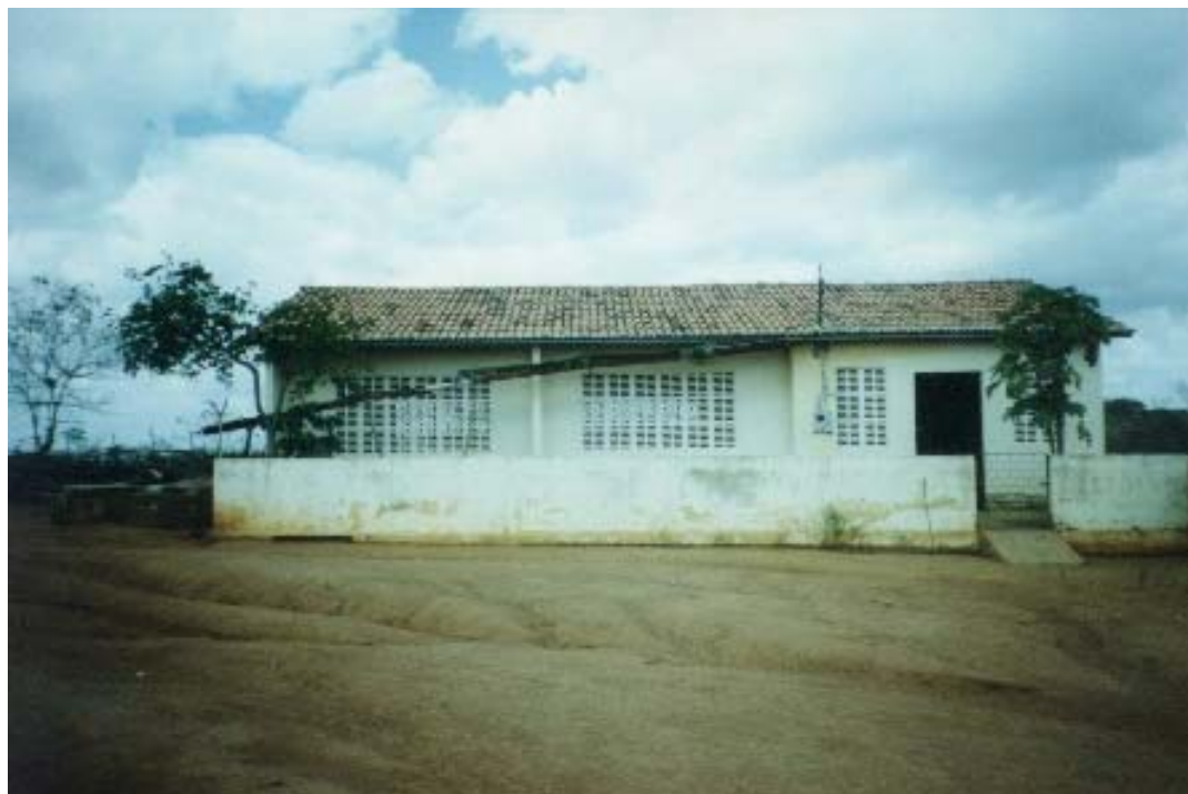
FOTO 14 – Escola Municipal José de Sales localizada na ombreira esquerda, a qual encontra-se desativada.
