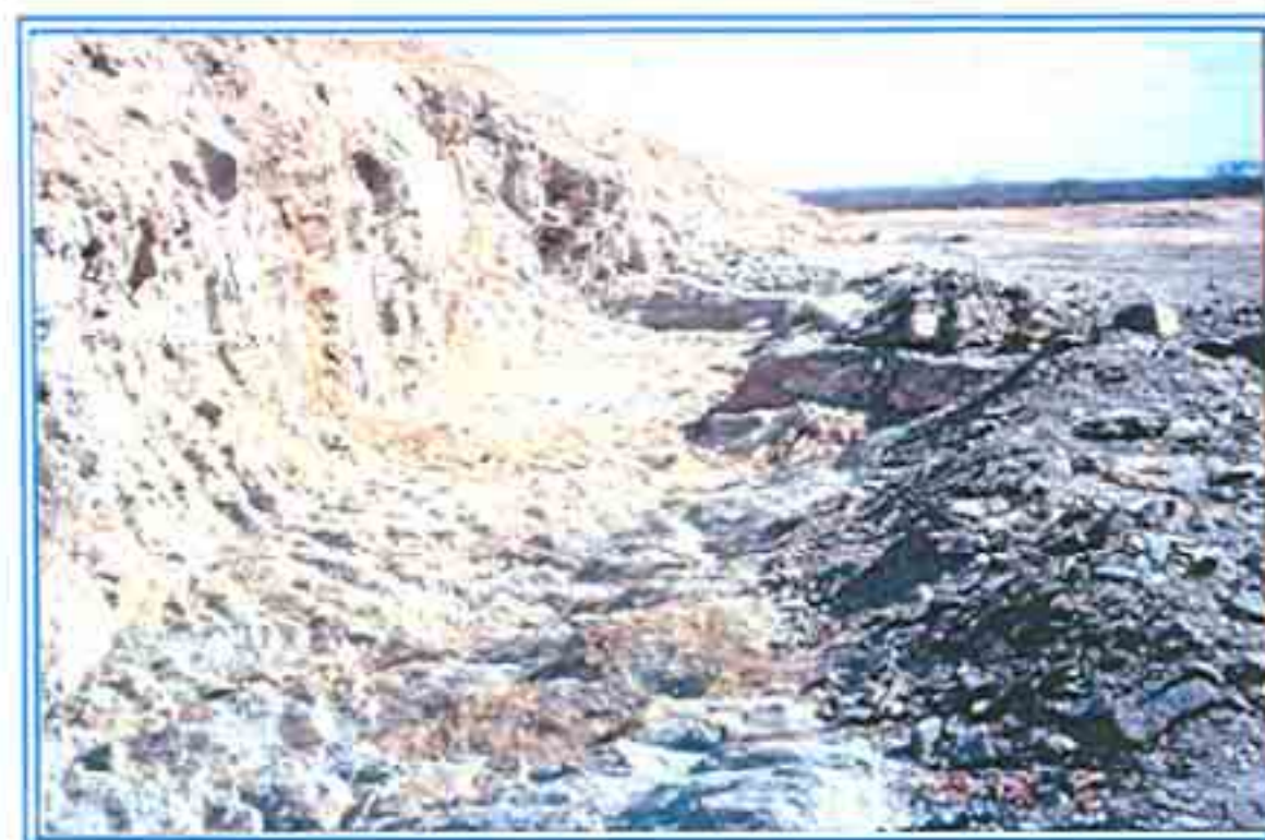
FOTO 03 | MOSTRA PARCIALMENTE A ESCAVAÇÃO DO MURO DE PROTEÇÃO DO VEÍCULO 002
