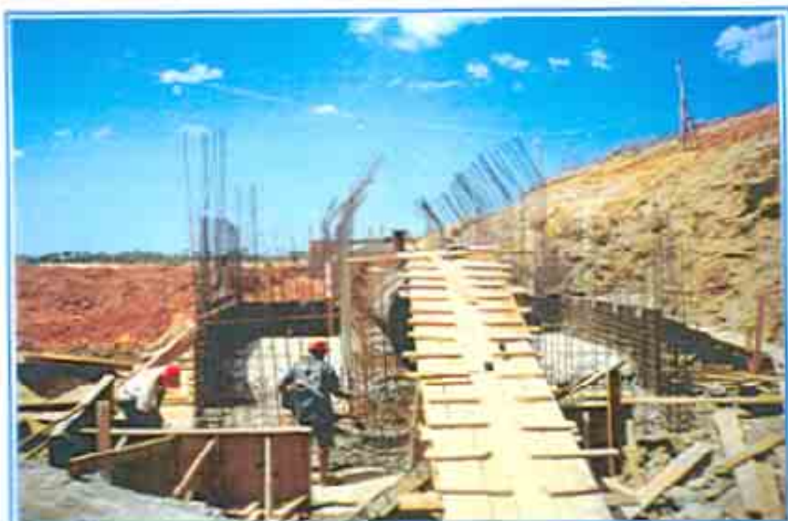
FOTO 09 - VISUAL DA OPERAÇÃO DE MONTAGEM DA ESTRUTURA E FUNDIÇÃO DA BASE DO TUBO.
