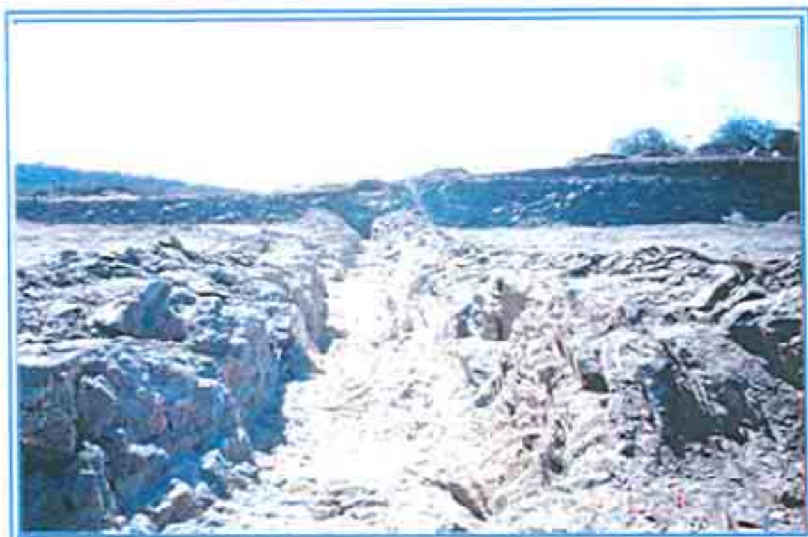
FOTO 02 | MOSTRA A ESCAVAÇÃO DO CORDÃO DE EDIFICAÇÃO
