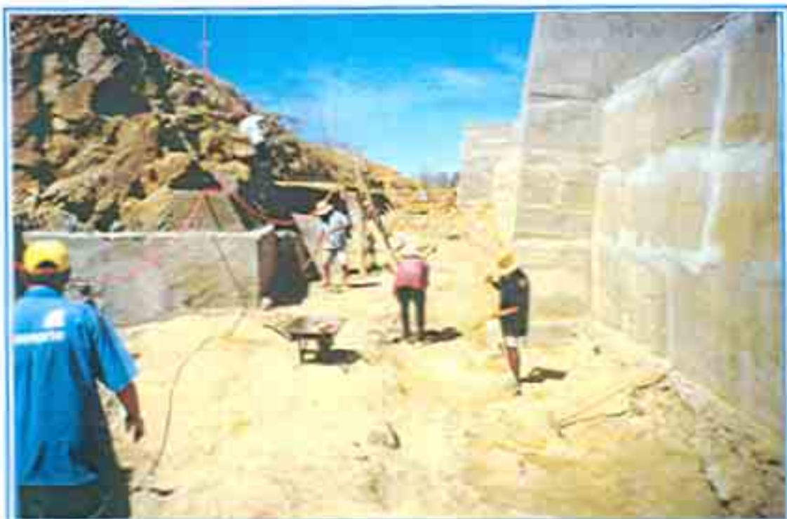
FOTO 07 | MOSTRA A LINDAÇA EM BLOCOS ENTRE A TOMADA D'ÁGUA E A OMBREIRA DIREITA.
