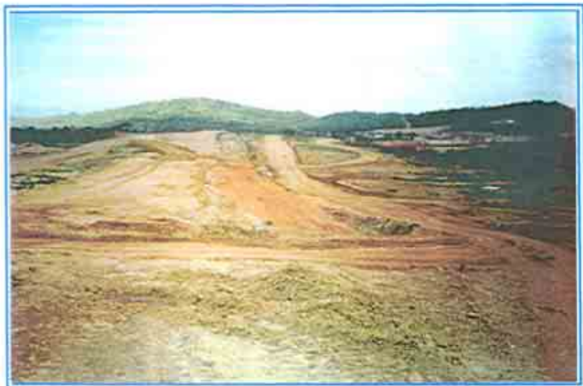
FOTO 01 | ÁREA DESMATADA DA BARRAGEM PRINCIPAL (OMBREIRA ESQUERDA) - (07/12/2017)
