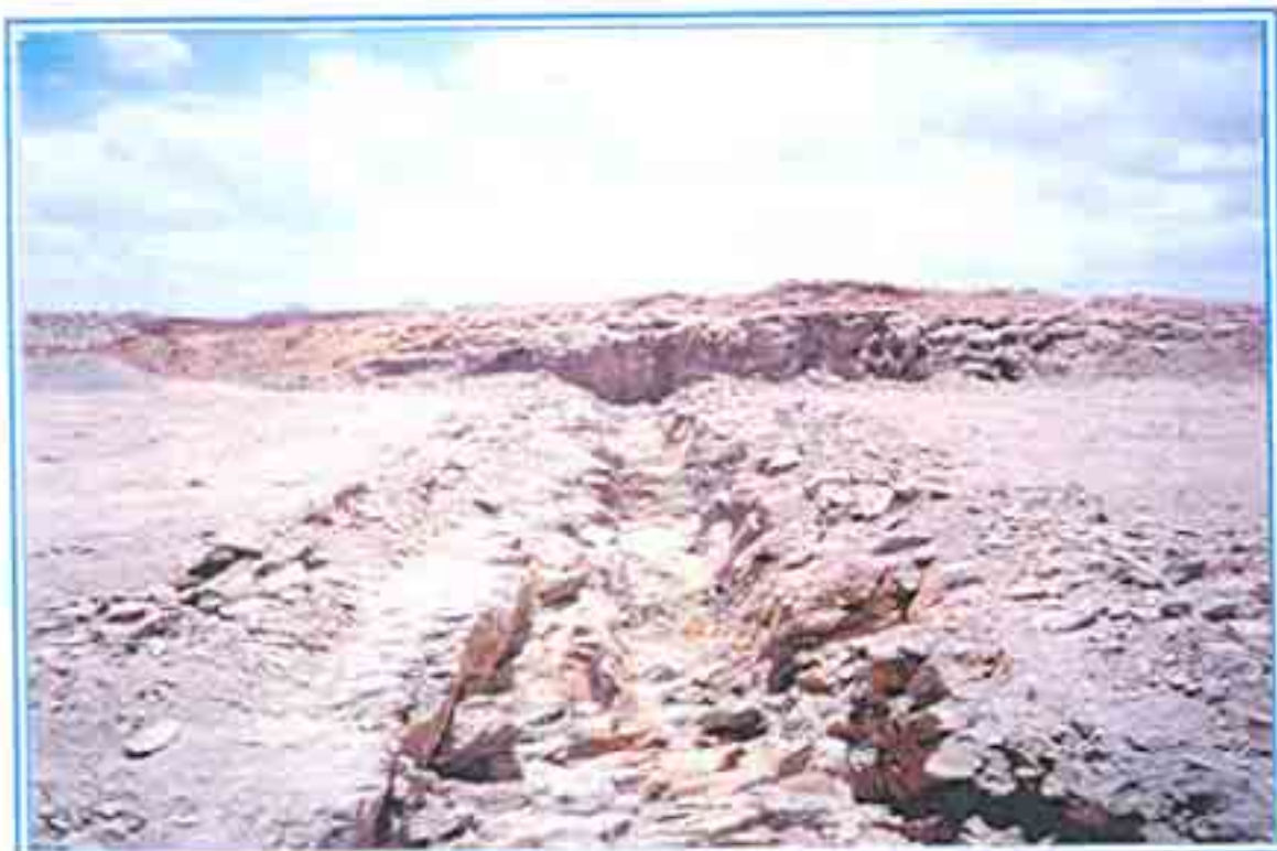
FOTO 04 | VISTA PARCIAL DO CORTAÇO DE FIXAÇÃO E NÍVEL VERTEICAL DO CORTAÇO.
