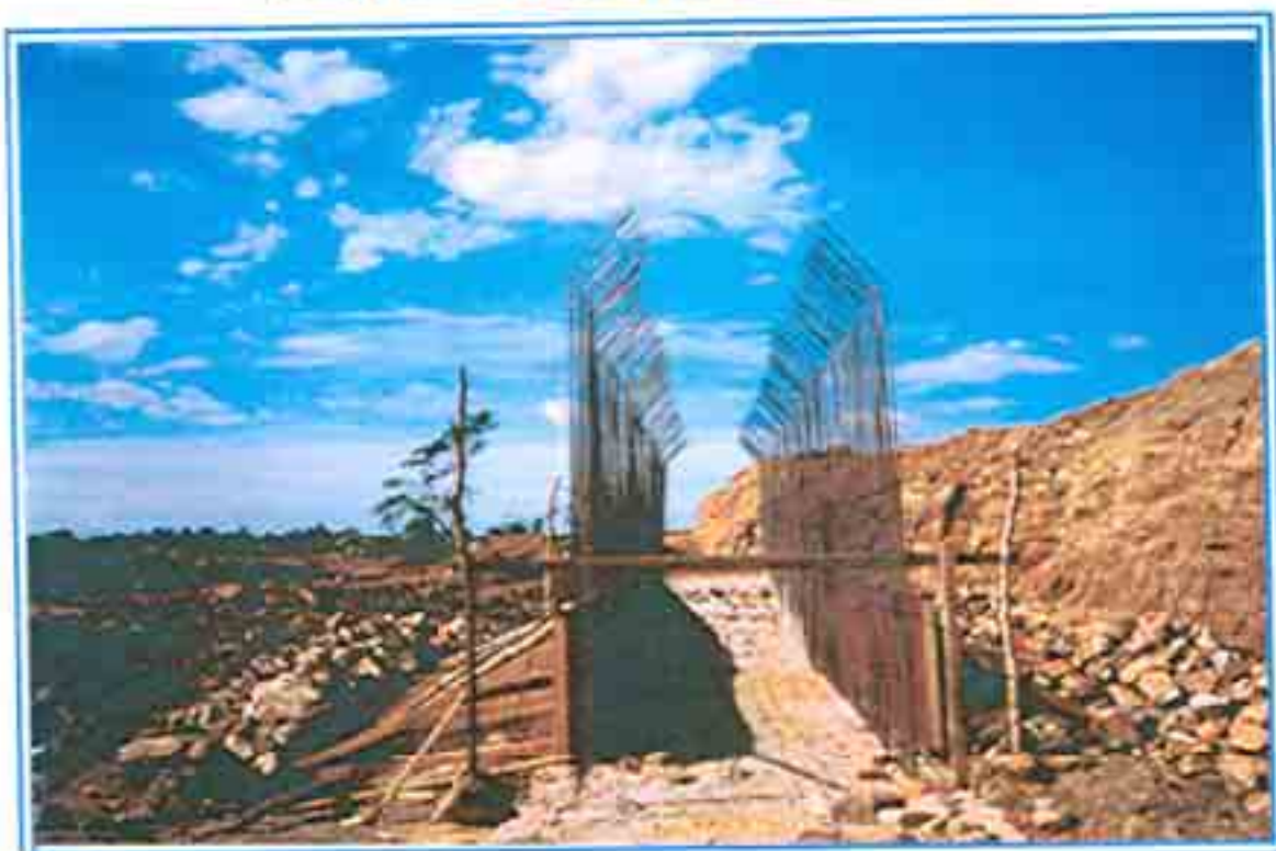
FOTO 03 | VISTA PARCIAL DA TERRAGEM, ESCORAMENTO E FÓRMA DA TOMADA D'ÁGUA
