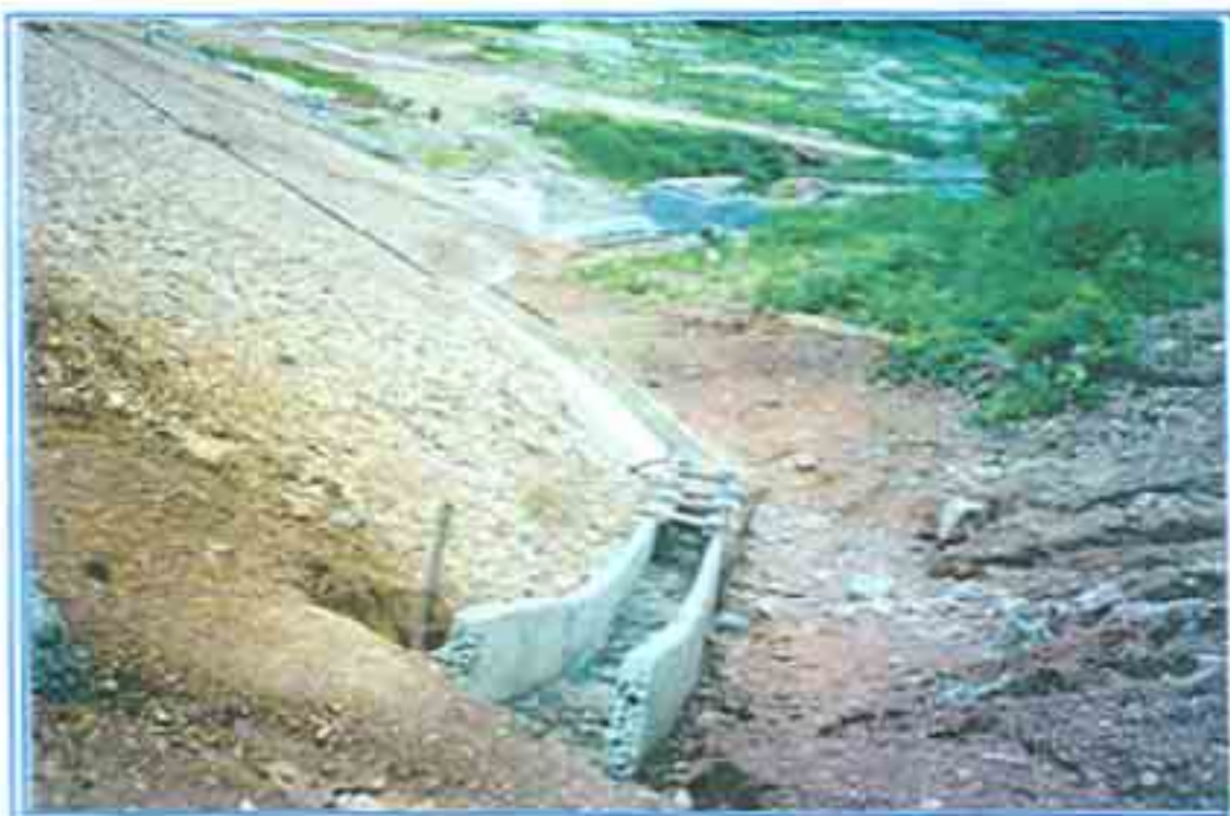
FOTO 19 VISTA PONTUAL DA TUBAGEM DE DRENAGEM INSTALADA EM FRENTE ÀS CALHEIAS DE DRENAGEM NA CARRIÇA DO CERRADO.
