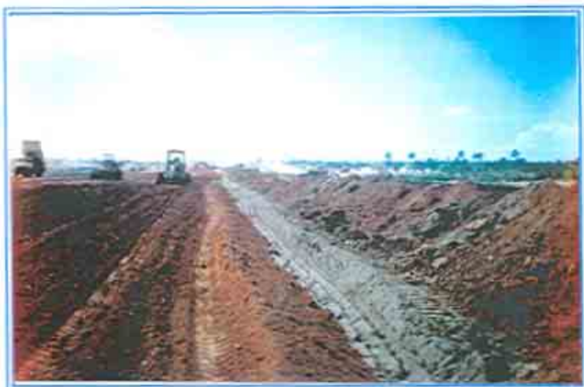
FOTO 09 | OPERAÇÃO DE ALCANTARALAMENTO COM LAMPADEIRA DE 3000 LITROS SOBRE FUJILHO VERTICAL APÓS SUA CONCLUSÃO.
