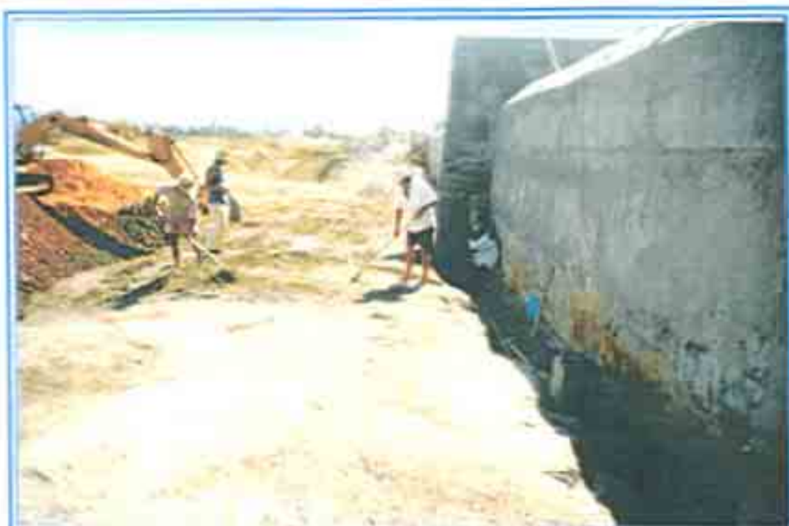
FOTO 05 VISTA PARCIAL DA TOMADA D'ÁGUA E LIMPEZA DO ENCONTRO COM O NÚCLEO SENDO REALIZADA.
