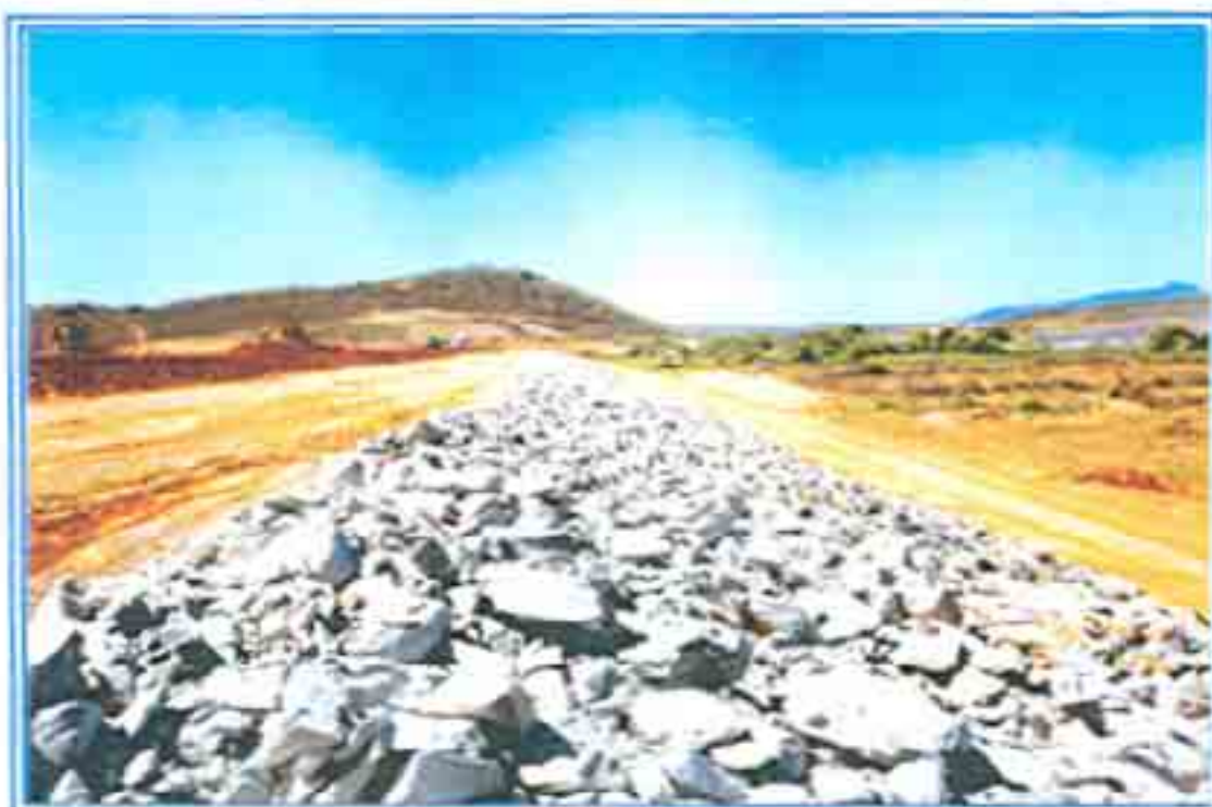
FOTO 11 | VISTA DO RIP-RAJ EM EXECUÇÃO DO ESPALDAR DE MONTANTE
