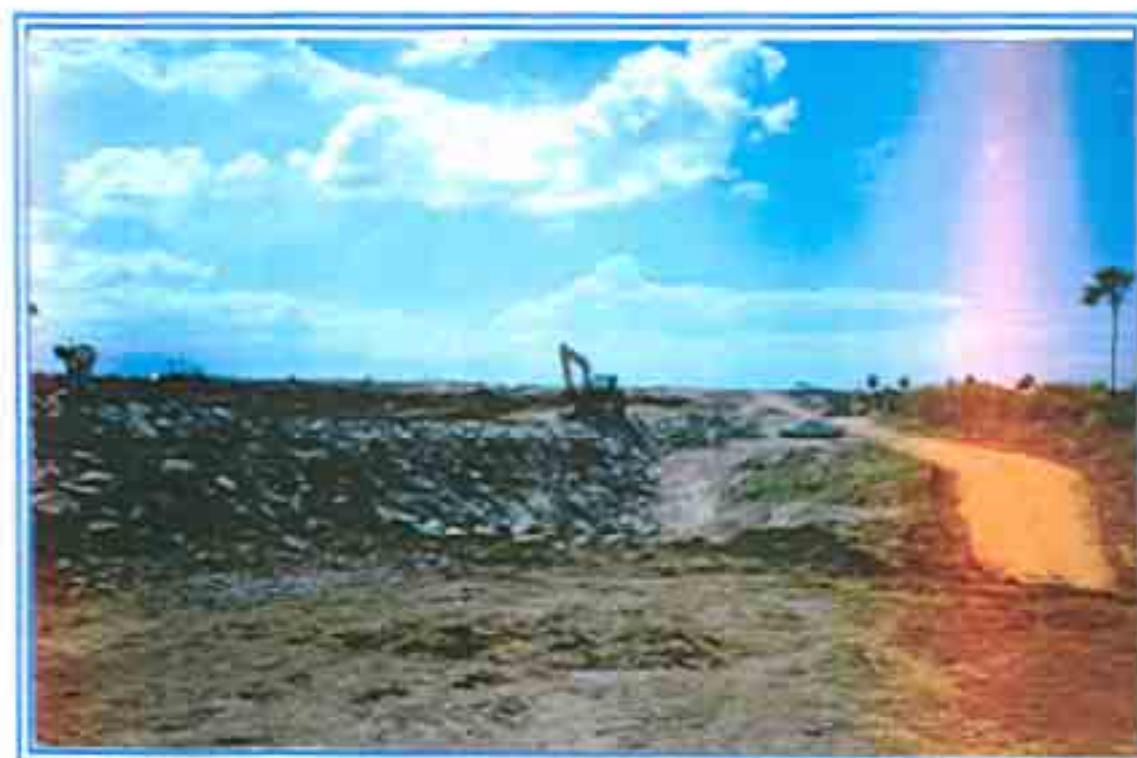
FOTO 10 | EXECUÇÃO DE SERVIÇO DE PREENCHIMENTO COM REJEITOS DA VAZÃO DE REJEITOS DE AGUARDANTES.
