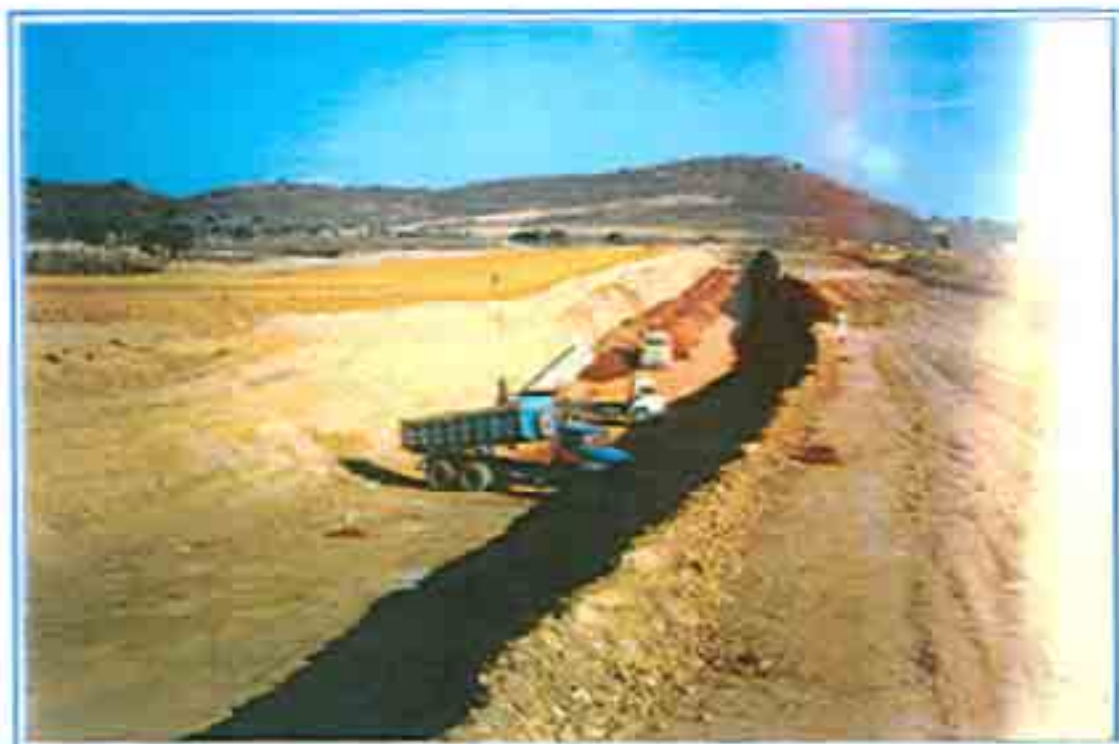
FOTO 06 | VISTA DA OPERAÇÃO DE ENCAMBAMENTO DE MÓDULO EM ÁGUA DO RIO INTERIORE DO CANTÃO DA ENTE 42 A 30.
