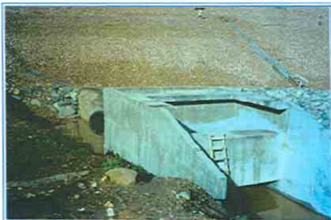
FOTO 12 VISTA PARCIAL DA CAIXA DISTRIBUIDORA DE JUBANTE JÁ EXECUTADA, NA TOMADA D'ÁGUA
