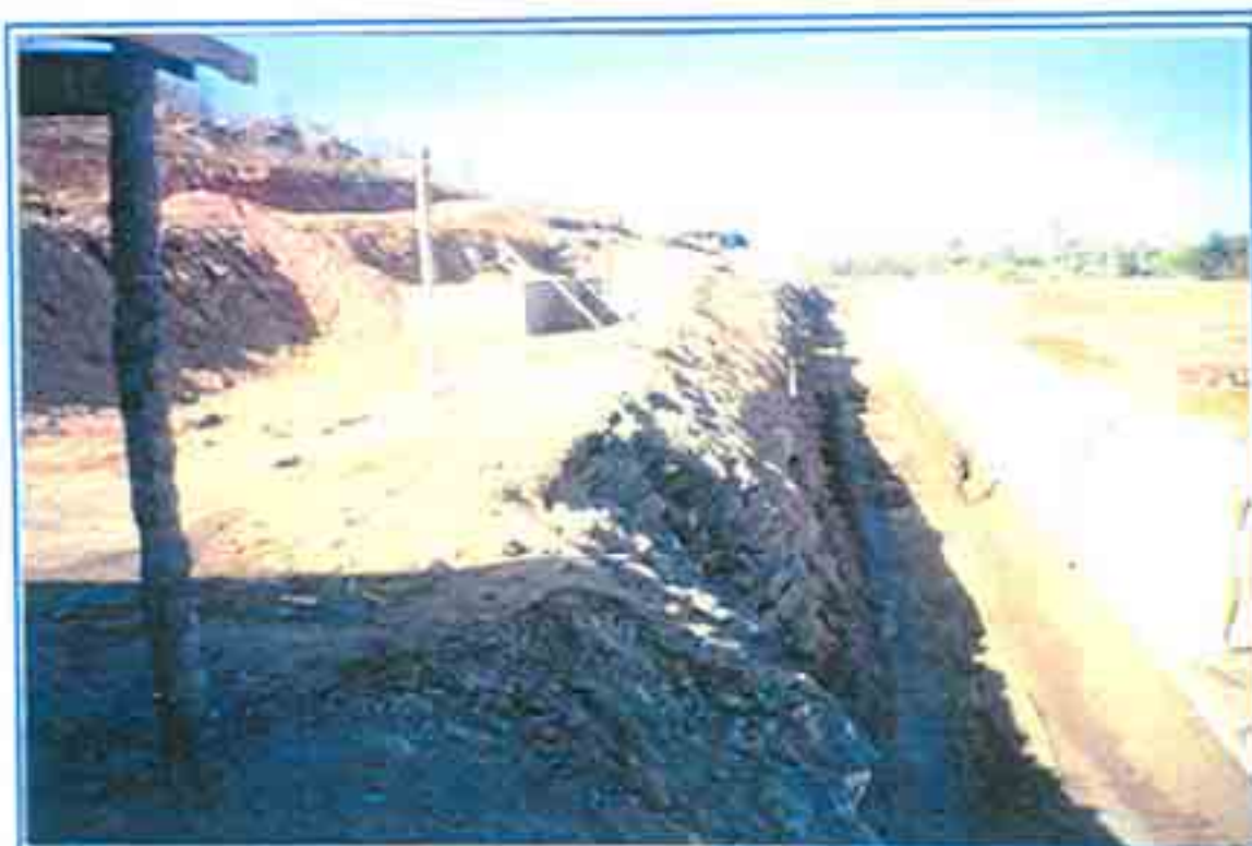
FOTO 04 | VISTA GERAL DA TOMADA D'ÁGUA E LIMIÇA DO ENCONTRO COM A OMBREIRA DIREITA SENDO EXECUTADOS
