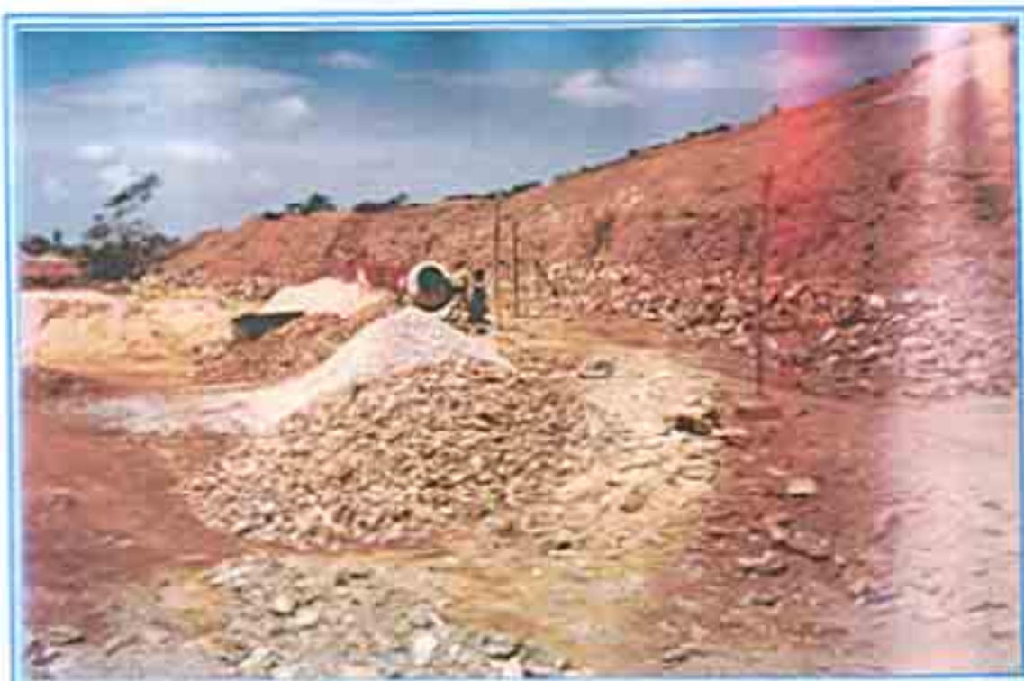
FOTO 01 | VISTA GERAL INTERIOR DA TOMBEIRA DE ÁGUA
