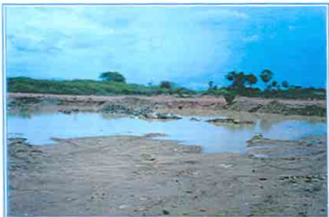
FOTO 08 | CANAL DO VERTEDEIRO (PARTE) ATÉ A ESTAÇÃO 13+1000 ENCONTRANDO-SE NA COTA 810,0m
