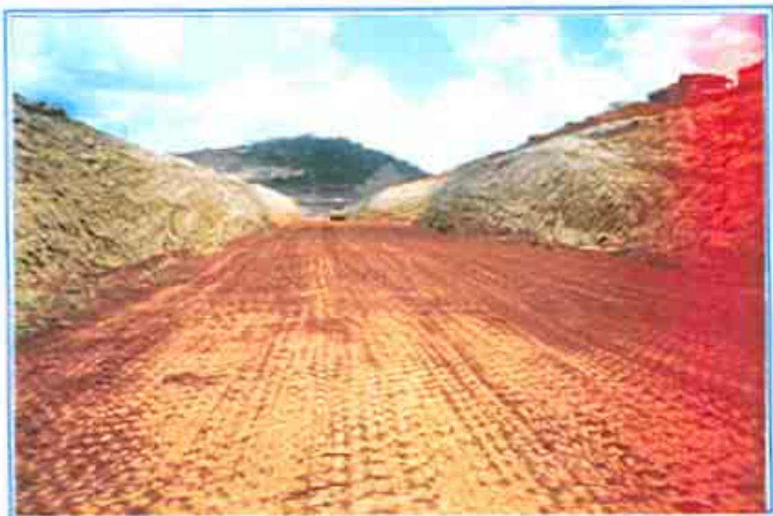
FOTO 49 - OPERAÇÃO DE COMPACTAÇÃO DO CUCOBI DA 121 - 42 A 50
