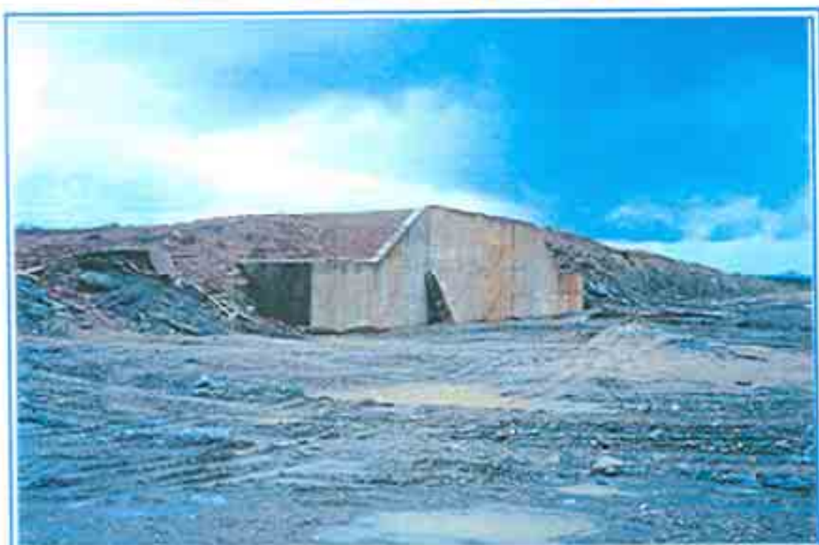
FOTO 06 | VISTA GERAL DO MURO DO VERTELGOURO CONCLUÍDO
