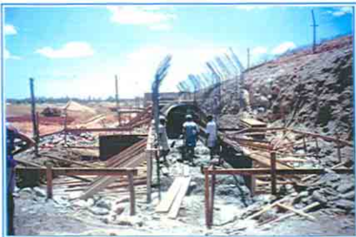
FOTO 06 VISTA PARCIAL DA TOMADA D'ÁGUA, NO LOCAL ONDE SERÁ EXECUTADA A TORRE.
