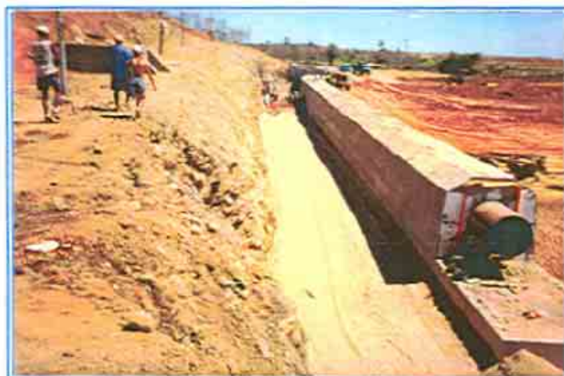
FOTO 08 | MOSTRA A AREIA LANCADA ENTRE A TOMADA D'ÁGUA E A OMBREIRA DIREITA.
