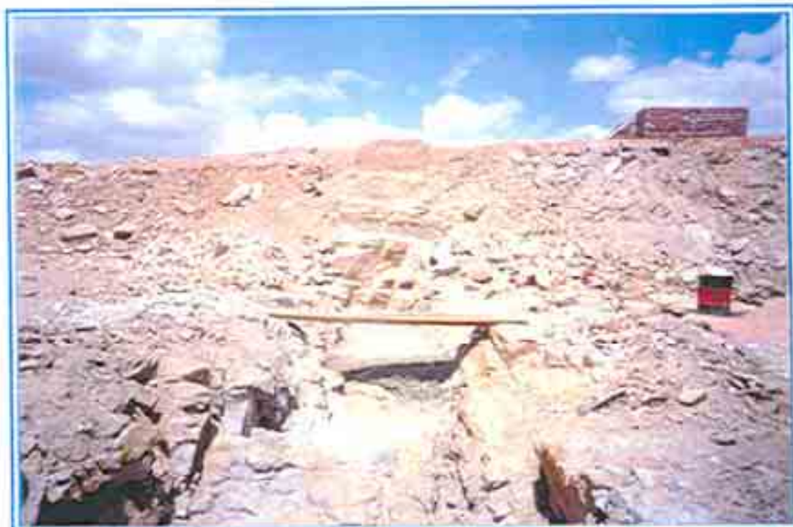
FOTO 05 | SERVIÇOS DE ESCAVAÇÃO E LIMPEZA COM INÍCIO DA CUNHA E ABERTURA DO CORTAÇO DE ESCAVAÇÃO DO NORTE DO CORTAÇO.
