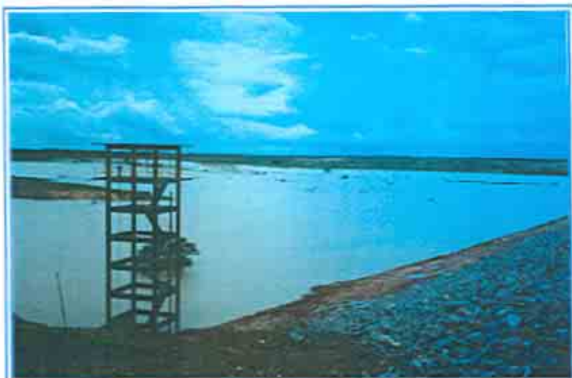
FOTO 11 VISTA MONTANDO TORRE DA TORREÇÃO DE ÁGUA COM PROMITORES ATIVOS DA ENCHREZADA COM ÁGUA (AUS/2019)
