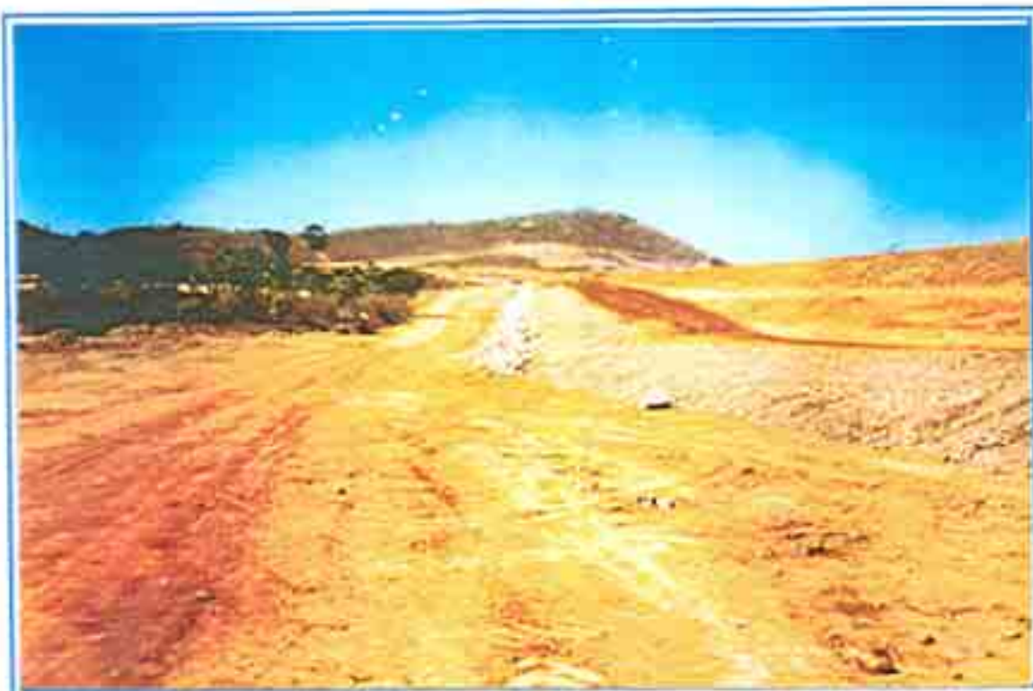
FOTO 13 VISTA ONDE SE PODE VER O ROCKETEL E O INÍCIO DA EXECUÇÃO DA PROTEÇÃO DO TALUDE DO BARRAGEM.
