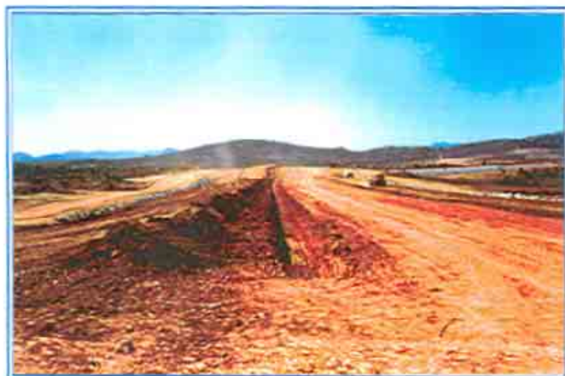
FOTO 12 | VISTA DO SACO DE LAMAS EM EXECUÇÃO DO TUBO DE TUBO VERTICAL
