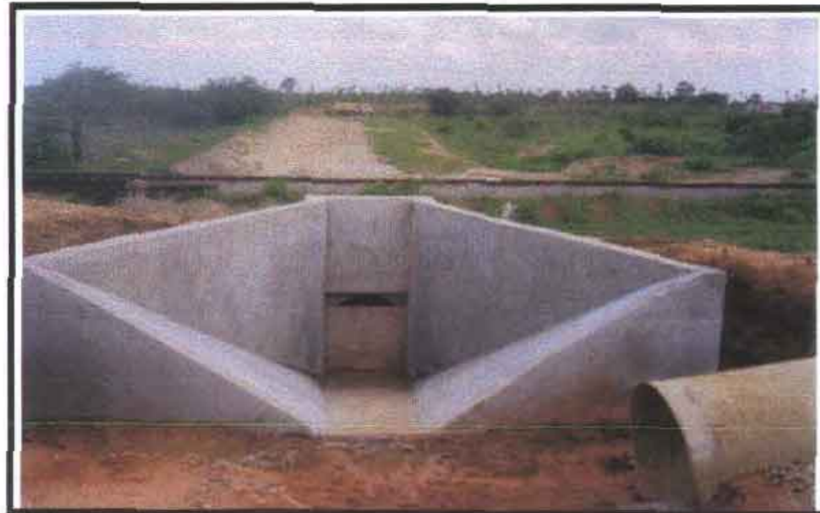
Foto 7 – Detalhe da concordância de montante do sifão 04.
