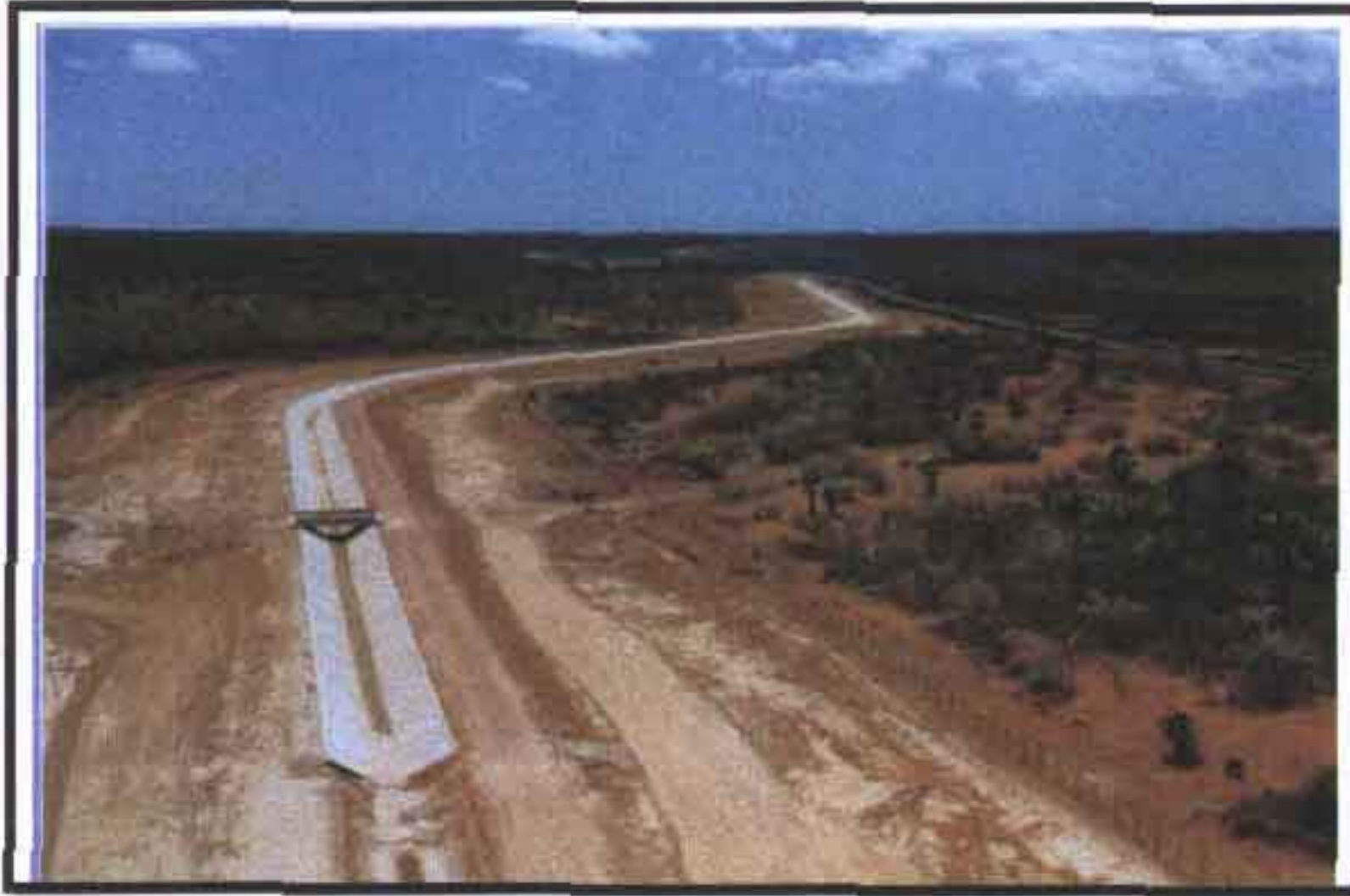
Foto 5 – Panorâmica do canal adutor. Detalhe para passarela.
