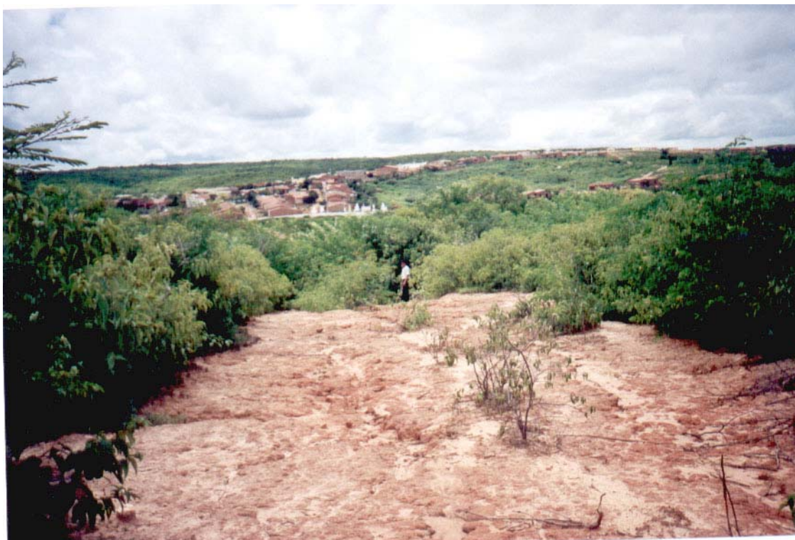
FOTO 11 - Exposição de solo residual de gnaiss no topo da ombreira esquerda do barramento (vista do topo para o vale).
