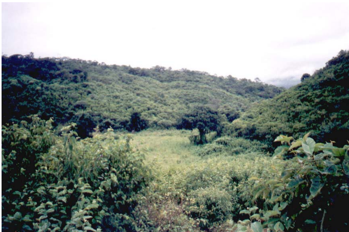
FOTO 17 - Detalhe da foto anterior, mostrando o talvegue do vertedouro.
