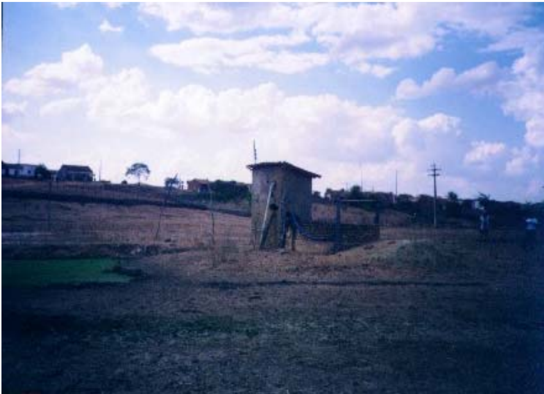
FOTO 05 – Poço amazonas (comunitário) de Baixo
