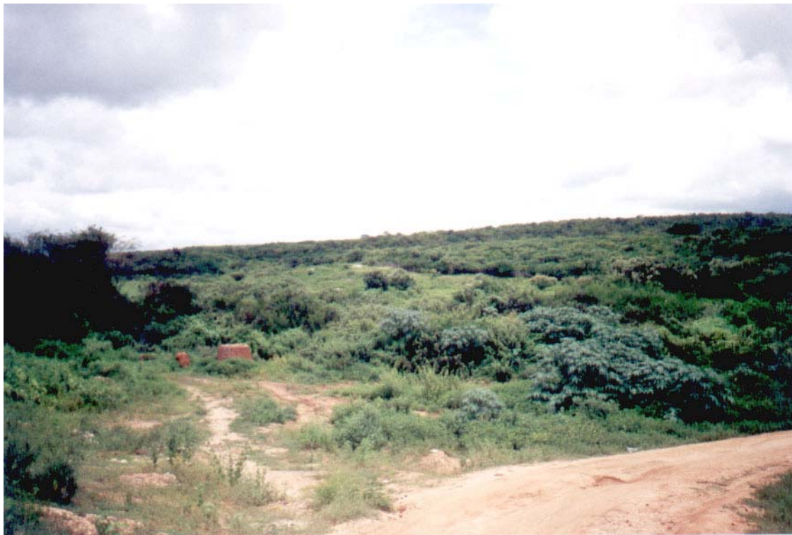
FOTO 10 - Vista da ombreira esquerda do barramento.
