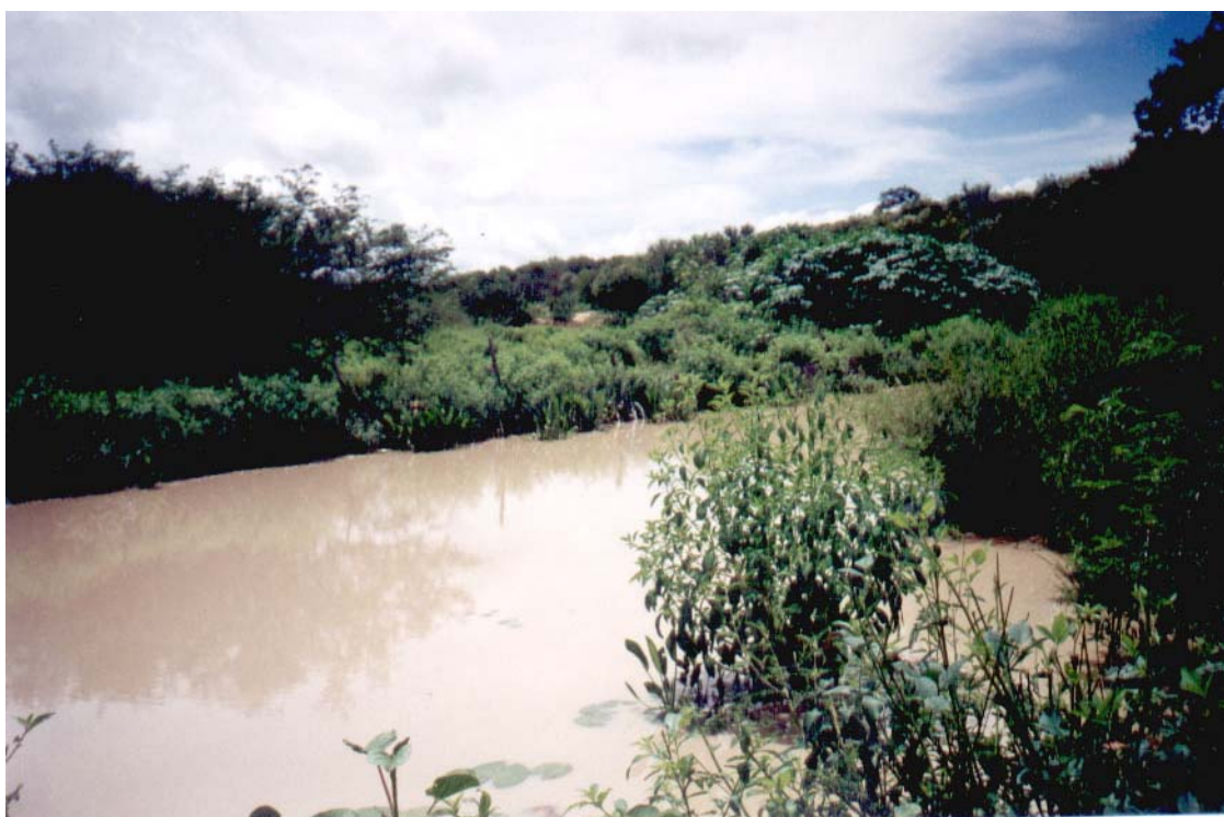
FOTO 18 - Vista do trecho de jusante do talvegue para implantação do vertedouro, o qual já foi parcialmente escavado pelo DNOCS, há cerca de 16 anos, para esta obra.
