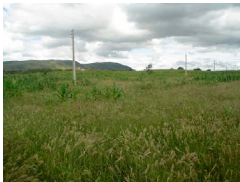
Foto 08/15 – Trecho de rede elétrica de baixa tensão que será submersa requerendo a sua relocação.
