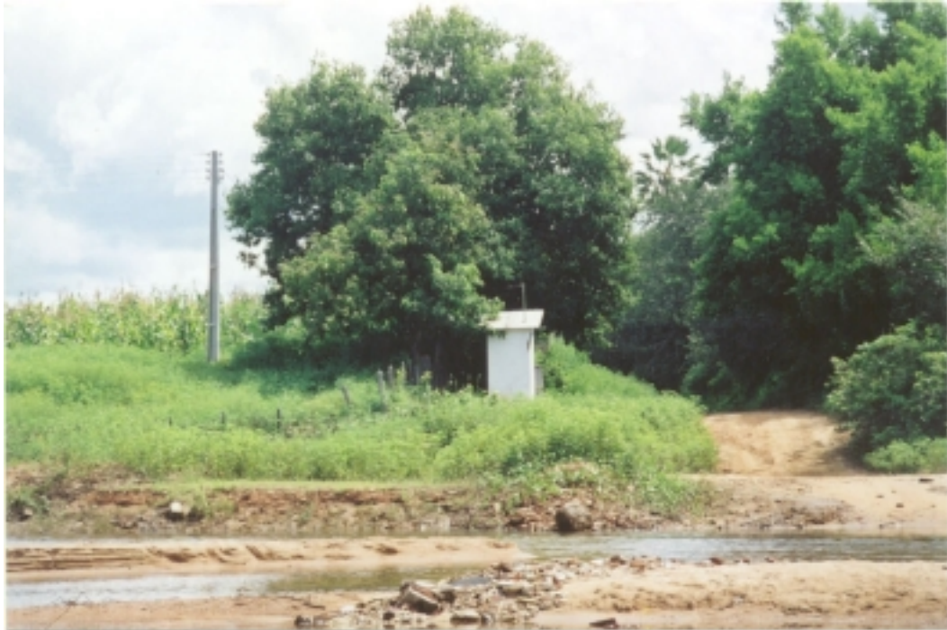
FOTO 1 - Detalhe de um dos poços que abastece a cidade.
