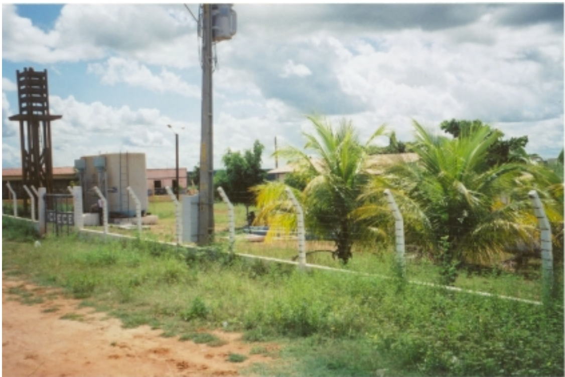
FOTO 2 - Visão geral da área da ETA mostrando filtros e aerador
