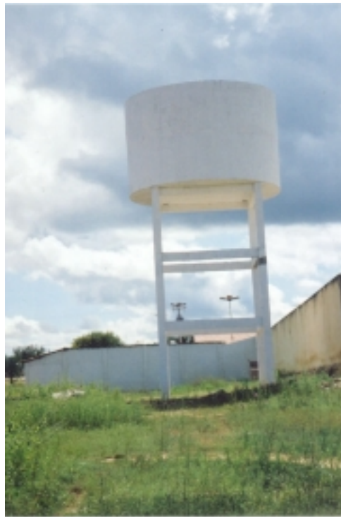
FOTO 7 – Detalhe do Reservatório elevado construído pela prefeitura para abastecimento do bairro Pão de Açúcar (ainda sem operação).
