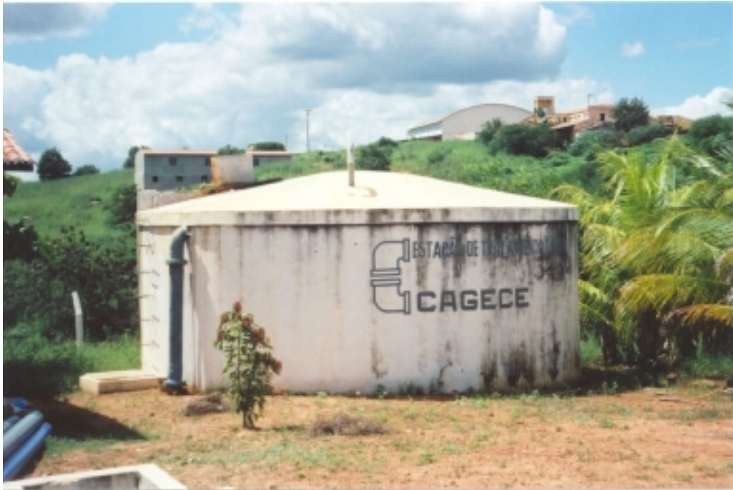
FOTO 5 - Detalhe do reservatório apoiado de 150 m 3
