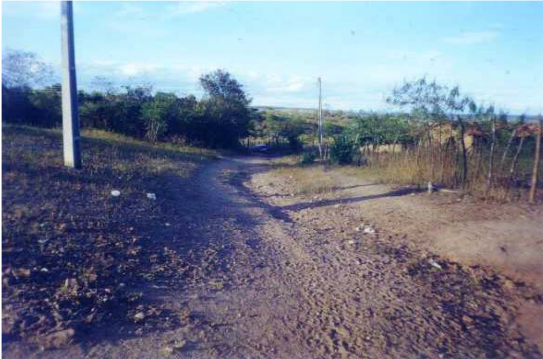
FOTO 05 – Outro ângulo do local previsto para o sangradouro (vista de montante para jusante).
