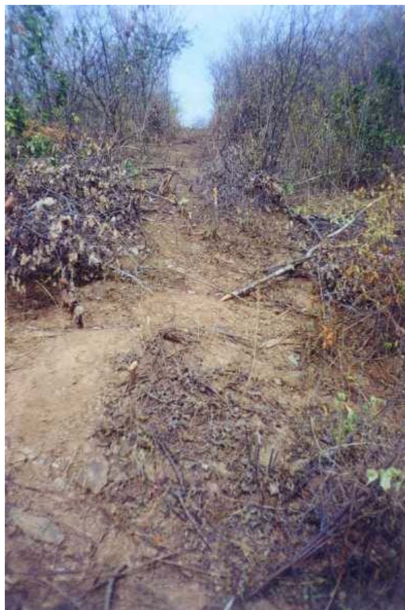
FOTO 02 – Vista da ombreira direita do barramento.
