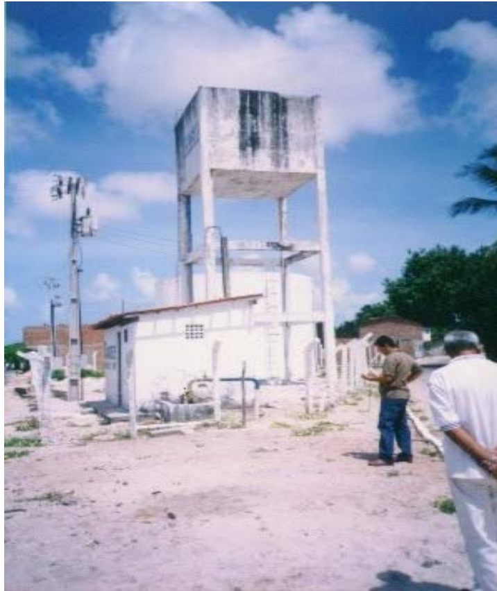
FOTO 17 - Poço P2 (ao fundo reservatório apoiado de 400m 3 e res. elevado a ser demolido)
