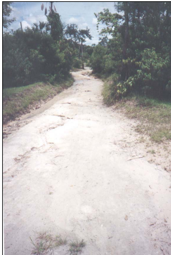
FOTO 13 - Ombreira esquerda da barragem, vista da margem do rio Aracati-Mirim. Sedimentos arenosos da Formação Barreiras (13/04/02).
