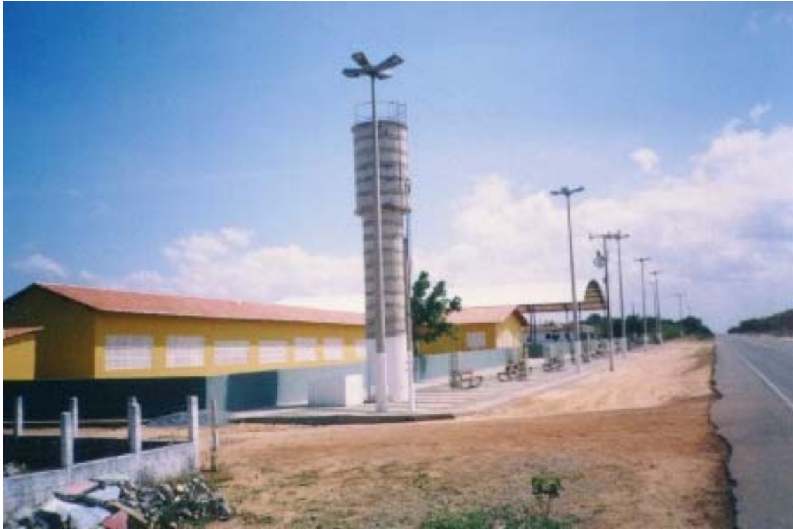
FOTO 21 - Vista do poço c/ reservatório elevado/chafariz. Ao fundo ginásio)
