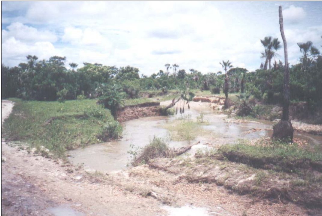
FOTO 15 - Jusante do eixo barrável. Bancos de sedimentos aluviais recentes, de natureza argilo-arenosa, moles, em espessuras da ordem de 1 a 2 metros, sobre os sedimentos concrecionados na Formação Barreiras (13/04/02).
