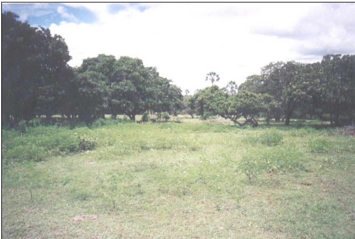
FOTO 12 - Ombreira esquerda da barragem (13/04/02)
