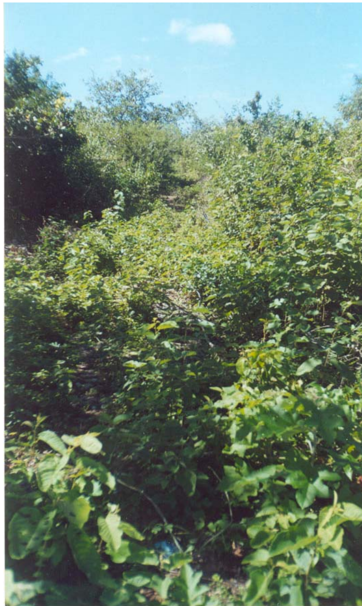
Foto 02 - Vista geral da região da ombreira esquerda do barramento.
