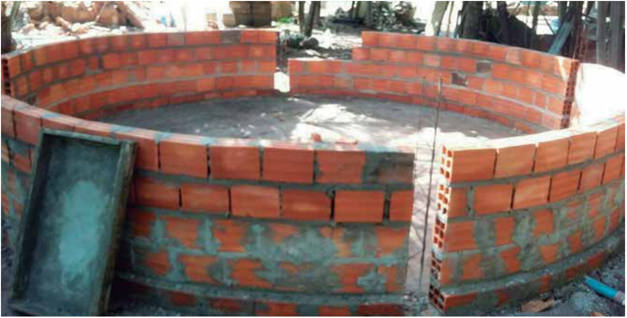
Tanque feito com alvenaria: detalhes da parede de tijolos e posição das treliças de ferro.
