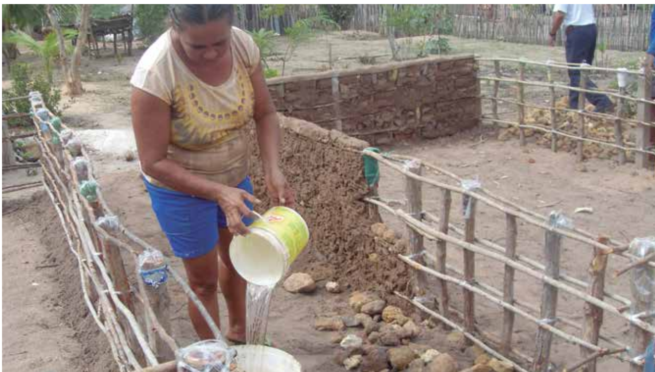
Construção do tanque retangular de taipa.
