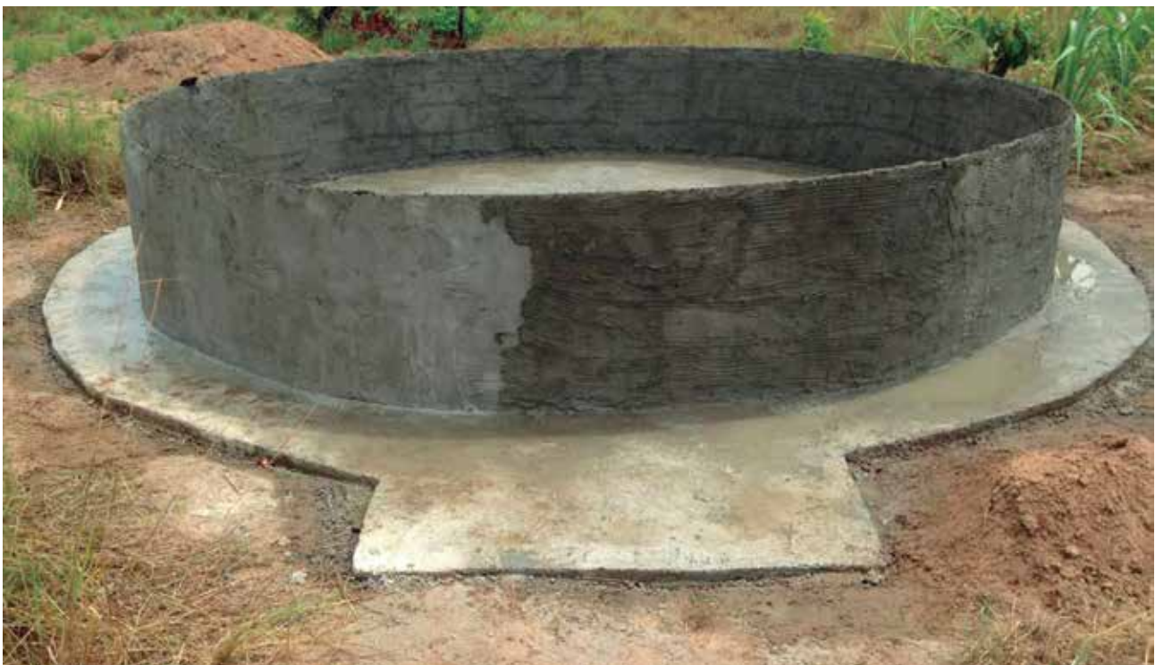
Tanque feito com ferrocimento.
