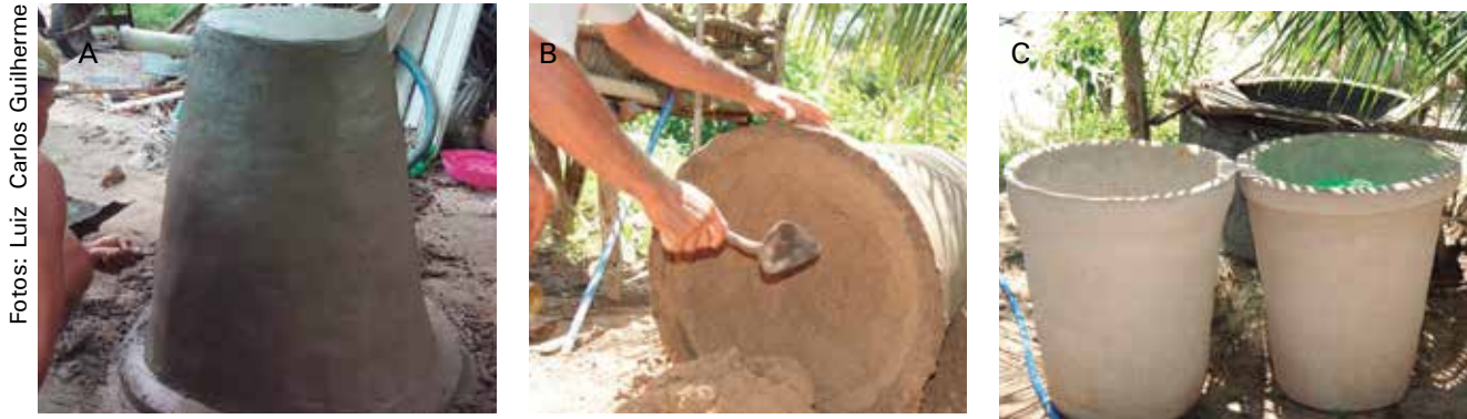
Montagem da forma de areia para a confecção do balde (A). Balde de cimento tombado para retirada da areia utilizada como forma (B). Baldes de cimento prontos (C).
