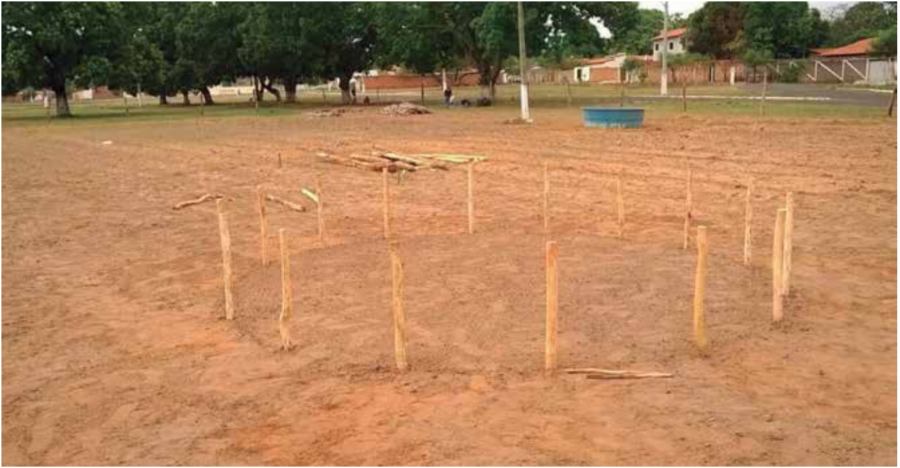
Instalação do tanque redondo: estrutura de estacas para sustentação.
