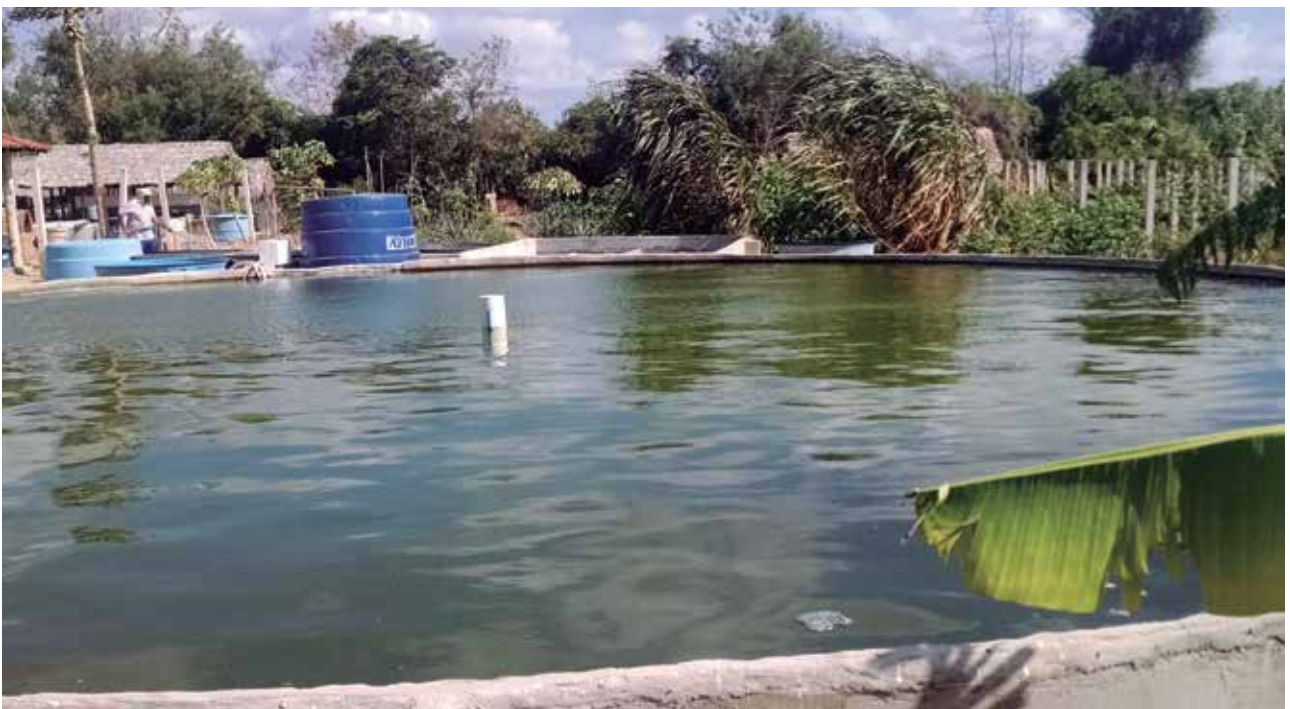
“Tancão” - construído com ferrocimento, capacidade de 100 mil litros. Modelo do Sisteminha para produção comercial em teste na Embrapa Meio-Norte - UEP/Parnaíba, PI.
