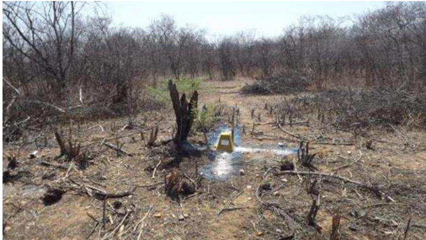
Figura 3.13 - Marco na ombreira direta, estaca 190, início do eixo.
