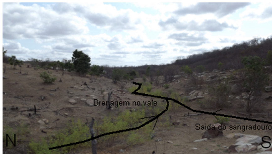
Figura 3.22 - Vale natural a montante do eixo (corte N-S), saída do vertedouro e drenagem natural na direção W-E. Todo o substrato é composto de rocha granítica sã.
