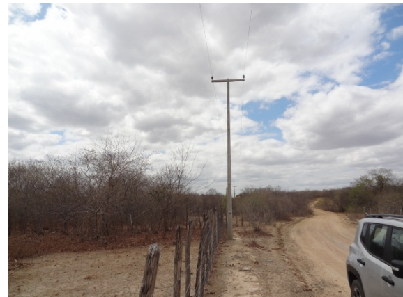
Foto 3.3 - Ao lado da Estrada vicinal existe uma linha bifásica com comprimento de 6km
