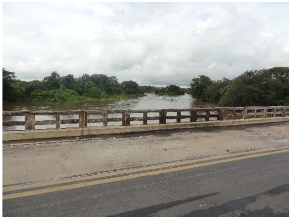
Foto 07: Vista do rio Macacos próximo ao eixo 3.
