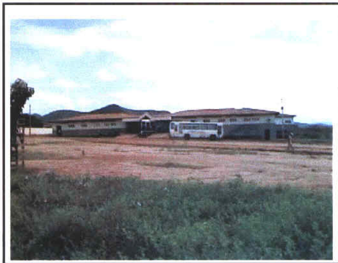
Foto 12 – Vista do Hospital Municipal de Capistrano
