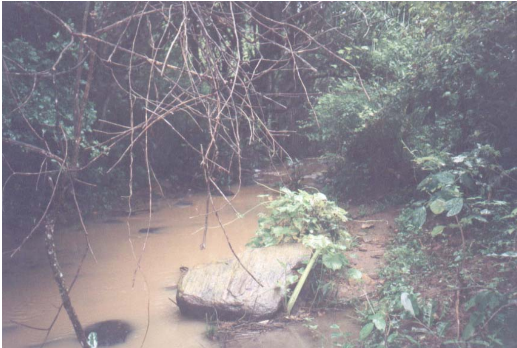
FOTO 01: Riacho Patos, no interior do futuro reservatório (12/04/02).
