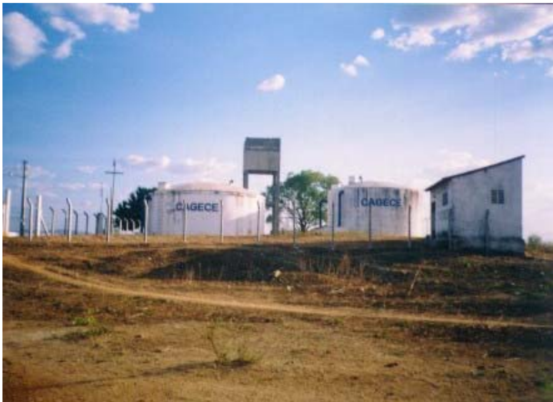
FOTO 07 – Área de reservação (Hidrolândia)
