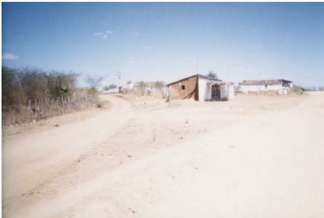
FOTO 03 – Vista parcial de habitações e de infra-estruturas de uso público (trechos de rede elétrica de baixa tensão e de estradas vicinais) localizadas na ombreira esquerda, devendo as primeiras serem alvo do processo desapropriatório, enquanto que para as últimas deverá ser analisada a necessidade de relocação.
